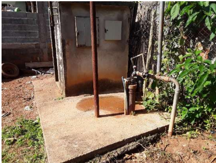
Figura 43 - Área da captação subterrânea – Sol Nascente
