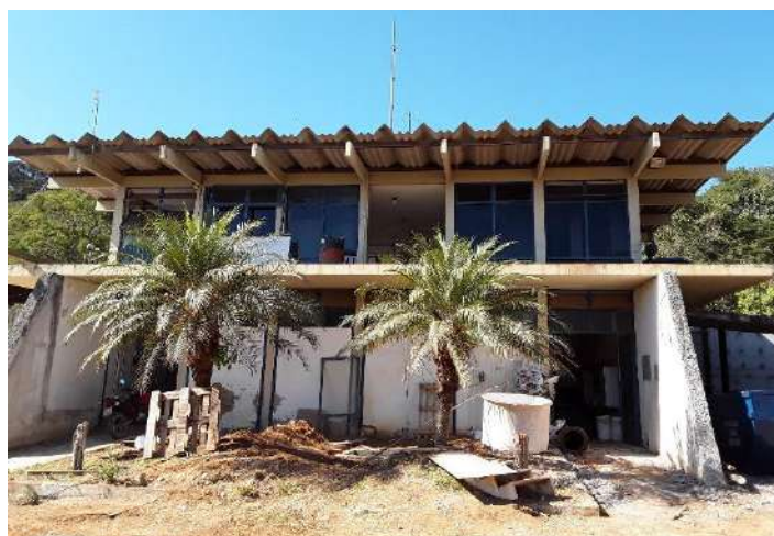
Figura 72 – Vista da fachada – ETA II
