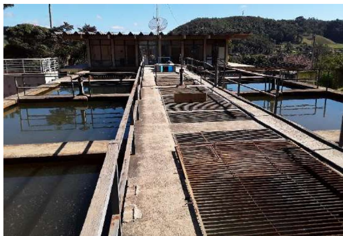
Figura 64 – Decantadores – ETA II
