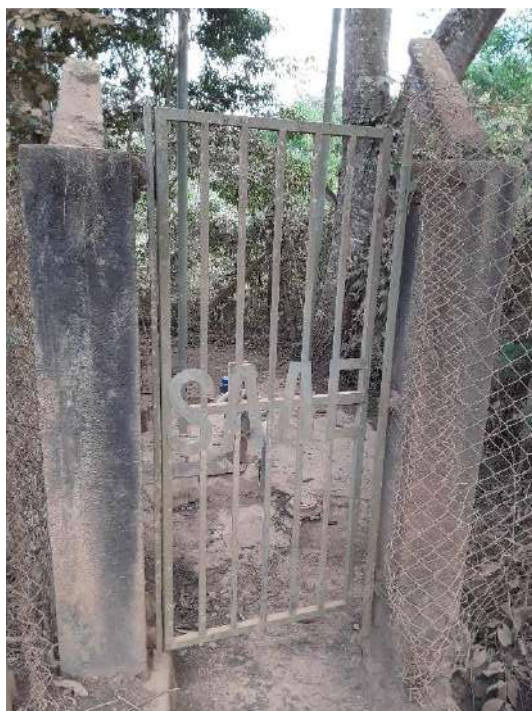
Figura 38 – Área da captação subterrânea – Novo Paraíso
