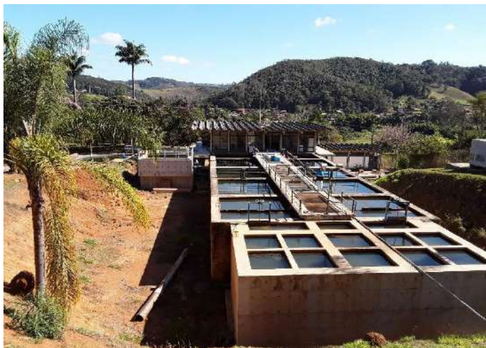
Figura 67 – Vista da ETA II
