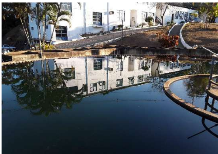
Figura 61 – Decantador – ETA I
