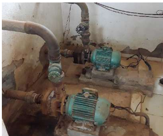
Figura 19 – Casa de Bombas – Cachoeira de Santa Cruz
