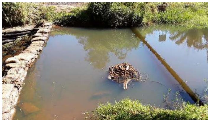
Figura 6 – Barragem de Captação – Rio Turvo Sujo
