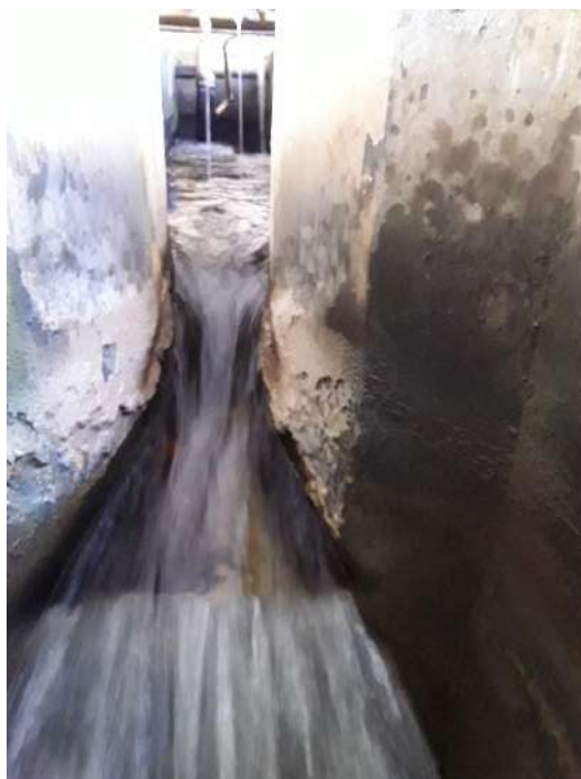
Figura 50 – Calha Parshall – ETA I
