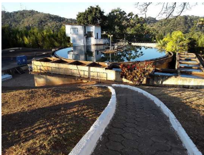
Figura 62 – Estação de Tratamento de água – ETA I
