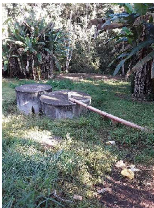
Figura 75 – Área da ETE Paraíso
