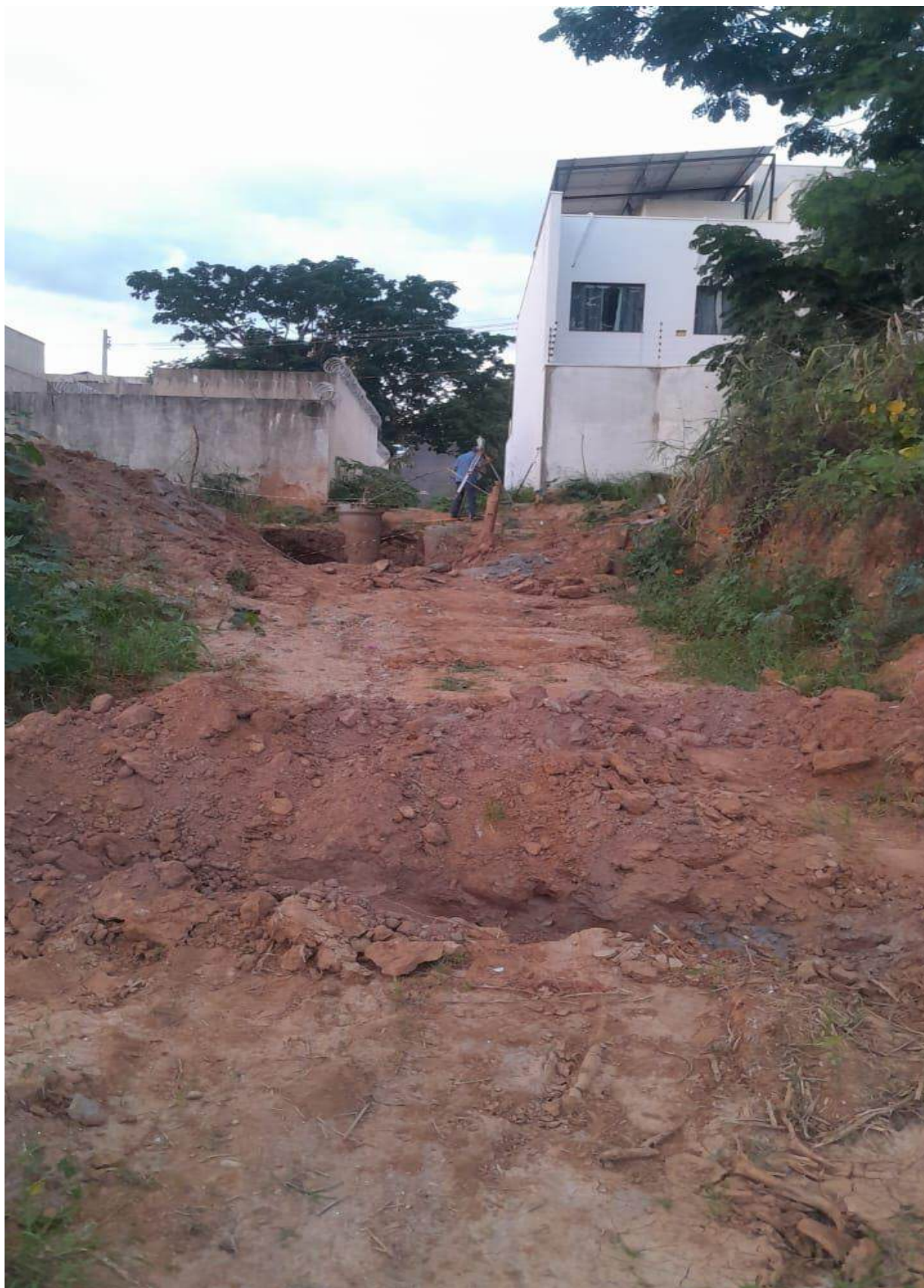
PVs – FINAL DA SERVIDÃO – VISTA DE DENTRO DO LOTE 26 – P O IV
