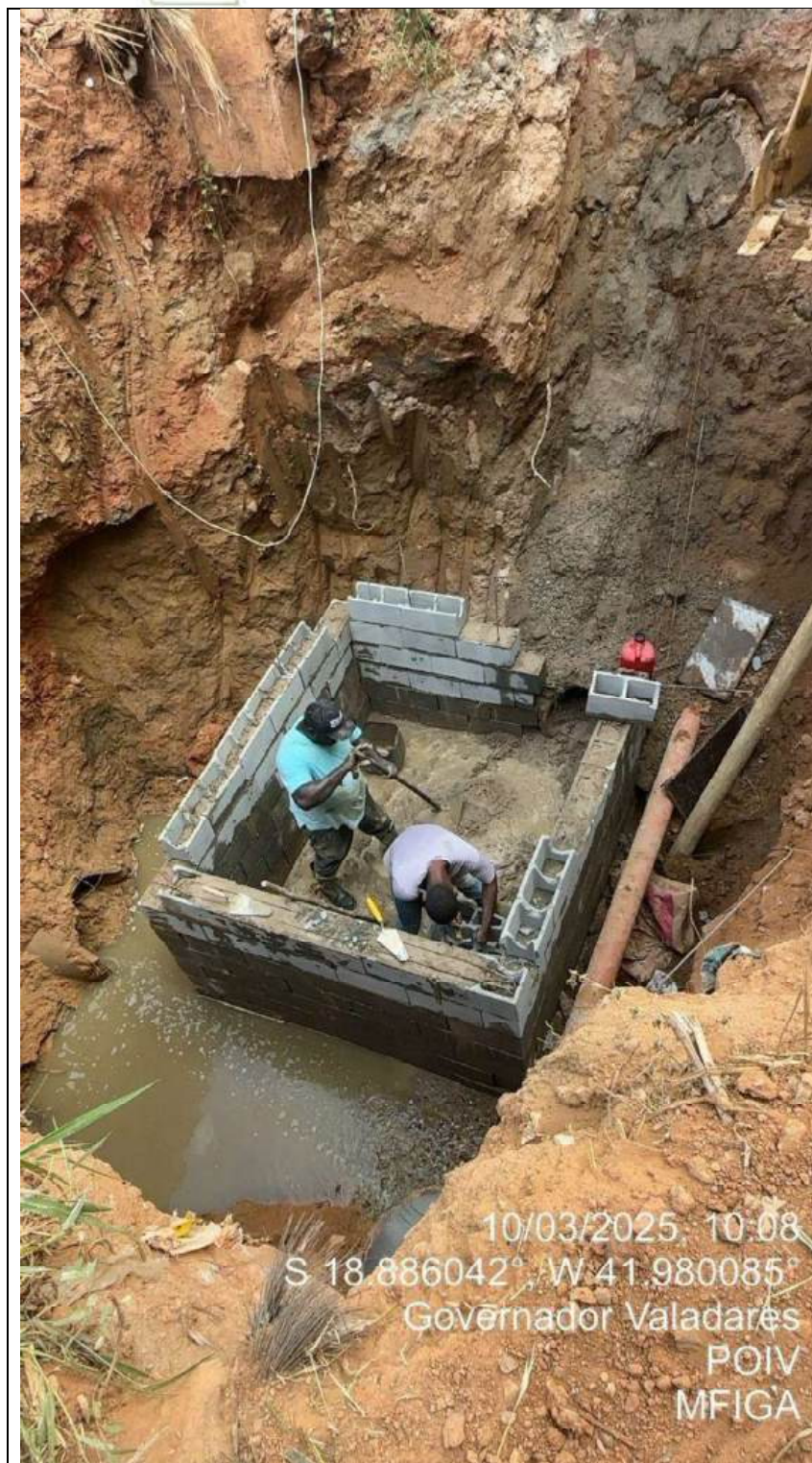
Foto 1 – Serviço de Drenagem sendo executados pelo Grupo Landaeta
