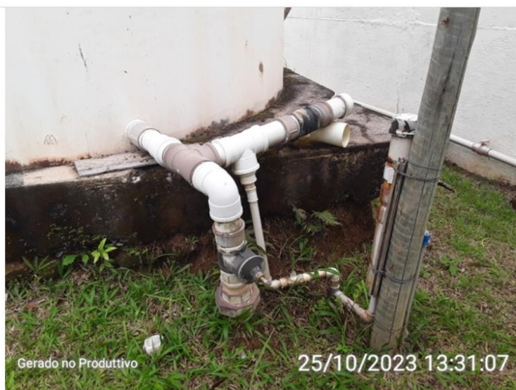
Tubo de descarga de fundo
