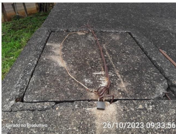
Tampa de inspeção
