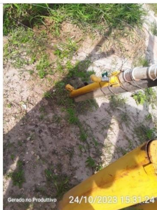
Ausência de laje sanitário
