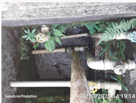
Caixa de descarga
