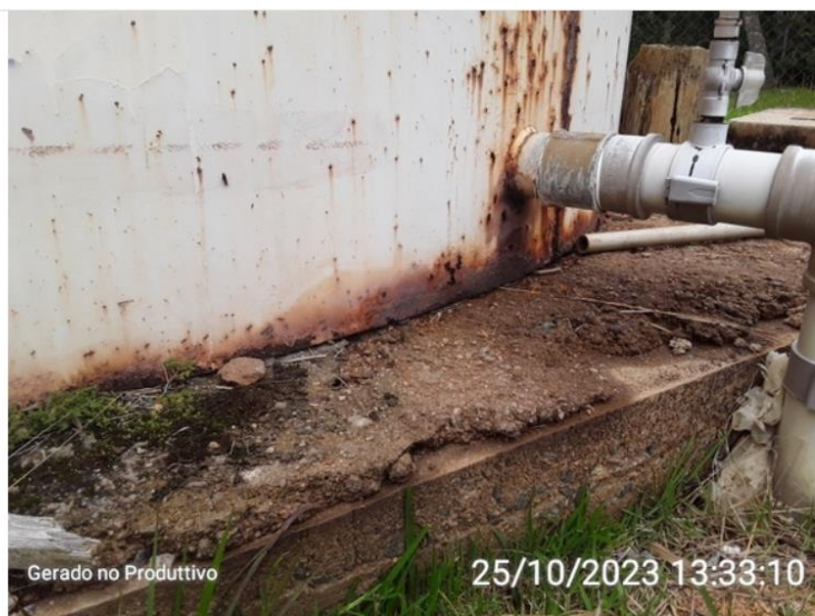
Corrosão na estrutura metálica
