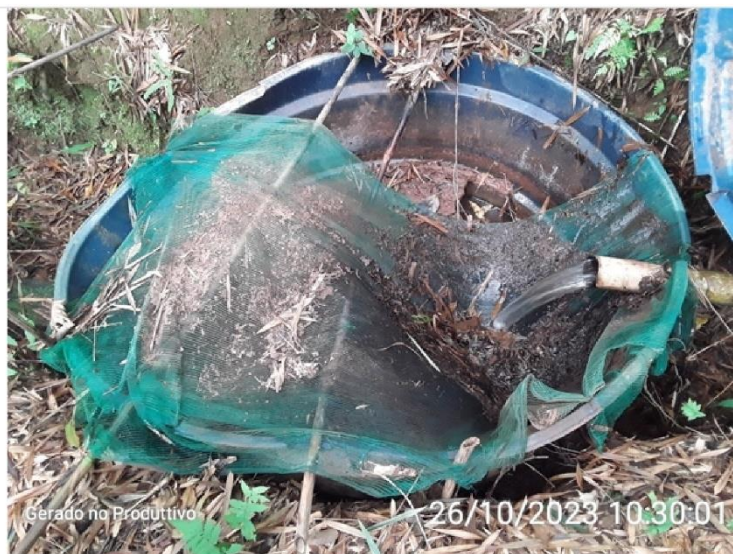
Caixa de passagem - Acúmulo de matéria orgânica
