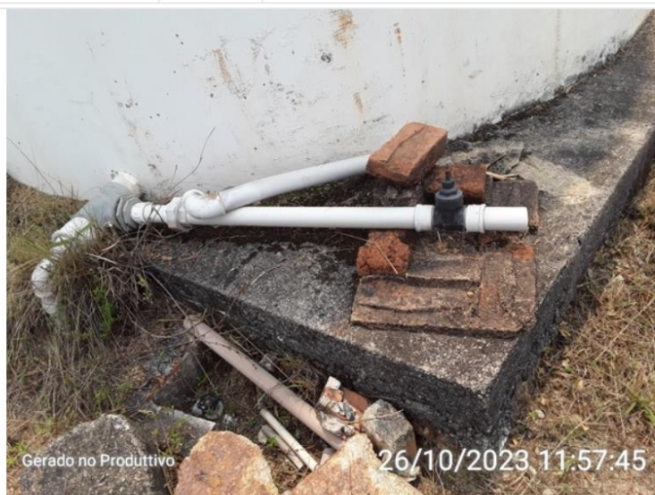
Tubo de descarga de fundo
