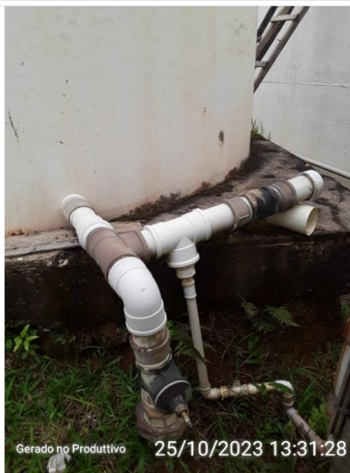
Tubo de descarga de fundo
