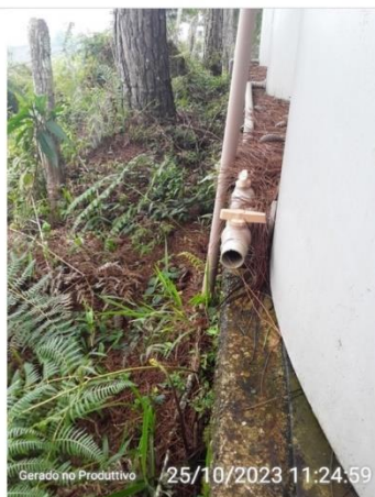
Tubo de descarga de fundo
