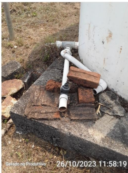
Tubo de descarga de fundo
