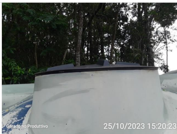
Tampa de inspeção
