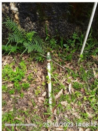
Válvula de fechamento - Reservatório II
