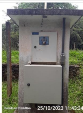
Chave elétrica e painel de Telemetria
