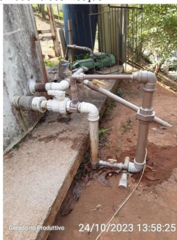
Sistema de Clorador (alternativo quando não há operador na ETA)
