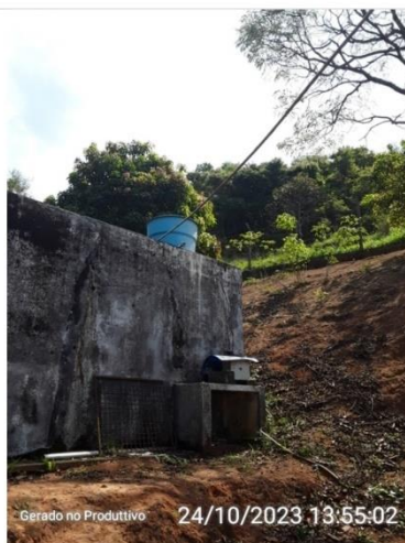
Tanque de contato ( reservatório)
