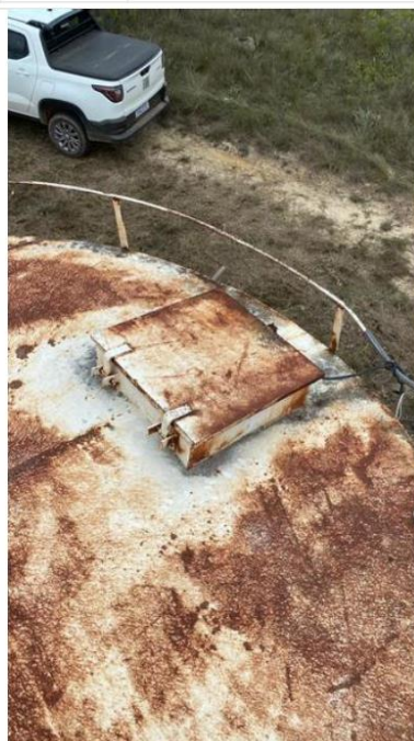
Tampa de inspeção
