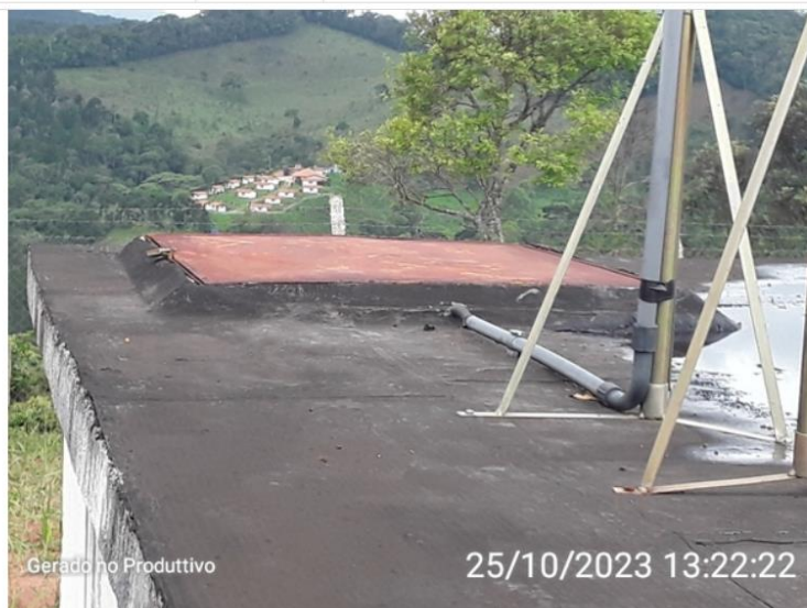
Tampa de inspeção
