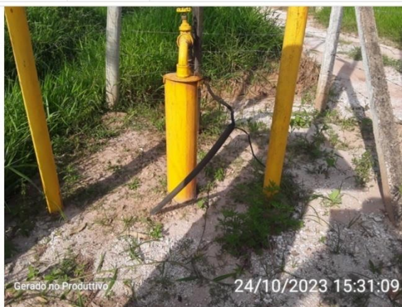
Ausência de laje sanitária
