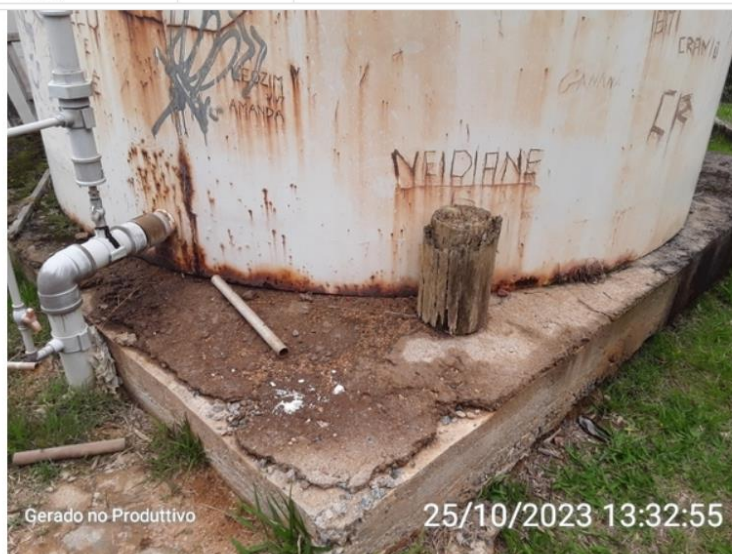
Corrosão na estrutura metálica
