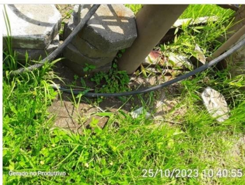
Ausência de laje sanitária
