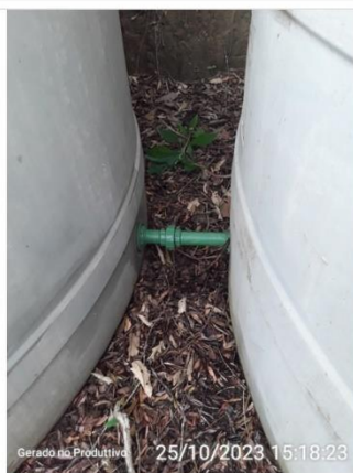
Interligação dos reservatórios
