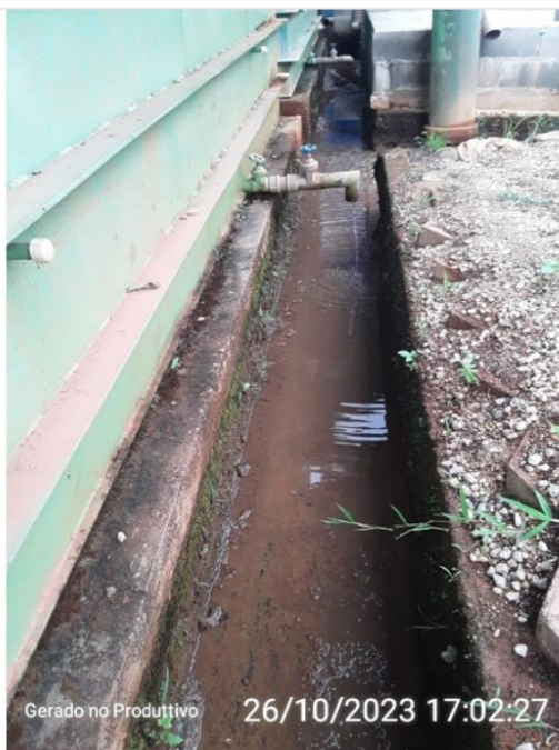
Vazamentos - Descarga dos Filtros
