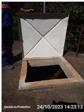
Tampa de inspeção
