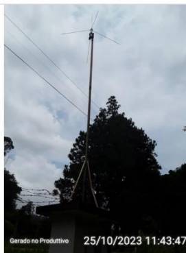
Antena de telemetria
