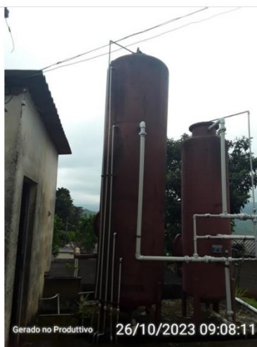
Floccodecantador - à esquerda
