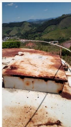
Tampa de inspeção
