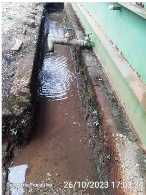
Vazamentos - Descarga dos Filtros
