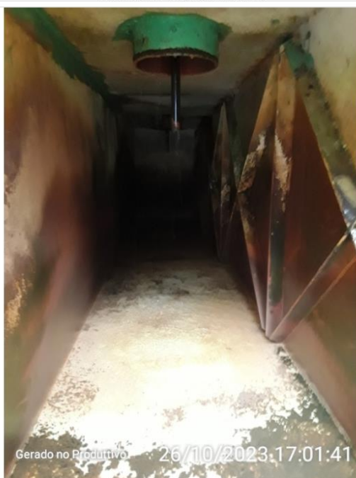
Vazamentos - Registros dos filtros
