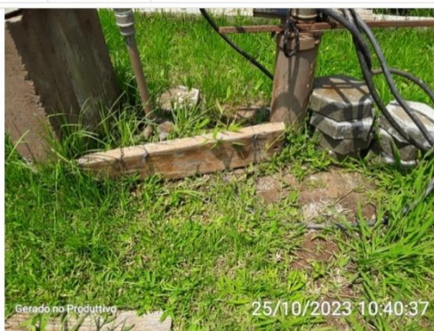
Ausência de laje sanitária
