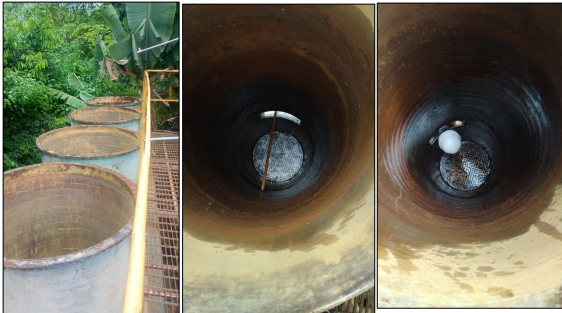
Figura 2. Troca do Material Filtrante Chonin de Cima
