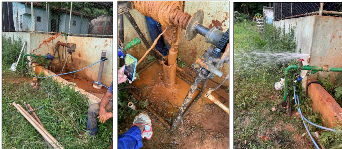
Figura 3. Limpeza poço Córrego dos Prazeres
