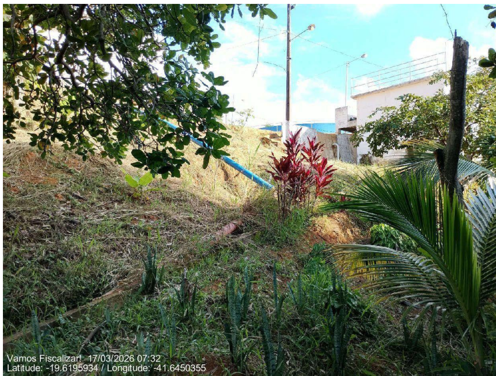
Caminhamento da tubulação de sobra da água bruta
