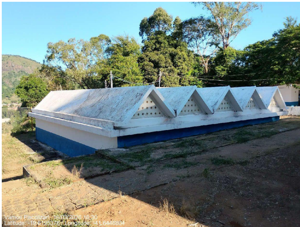
Reservatório semienterrado.
