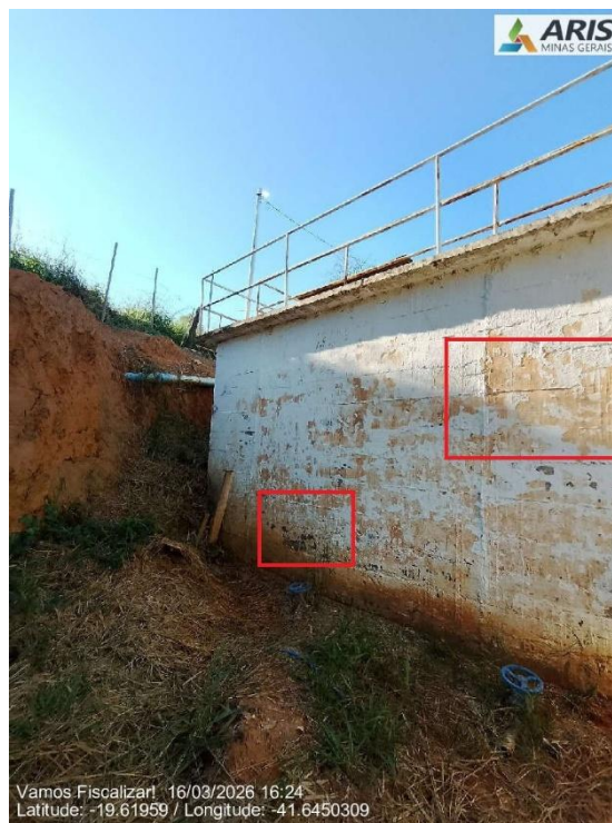
Vista lateral do flocladores (Retangular)
