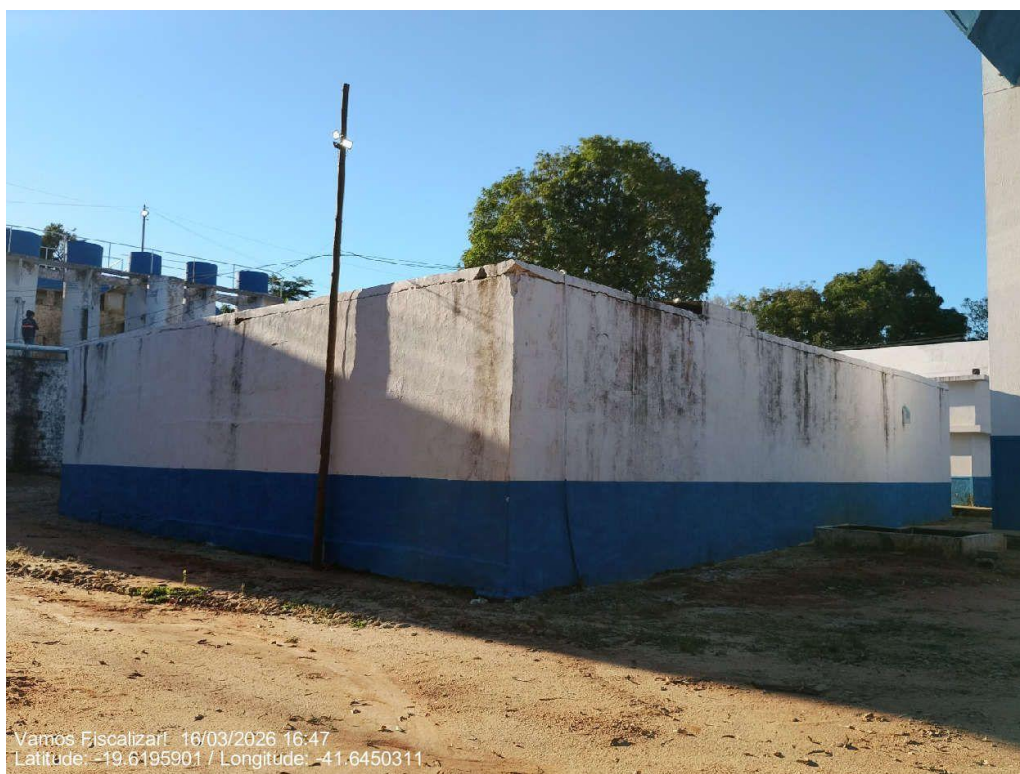
Reservatório 120m 3 da ETA Sede (DESATIVADO).
