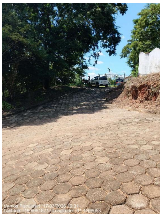
Acessos adequados à ETA
