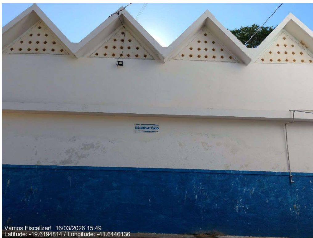
Identificação da estrutura de reservação I.
