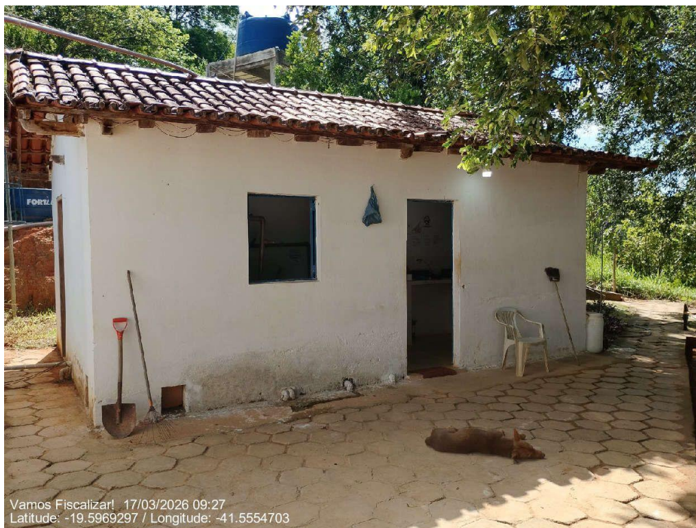
Laboratório físico-químico e área dos filtros pressurizados
