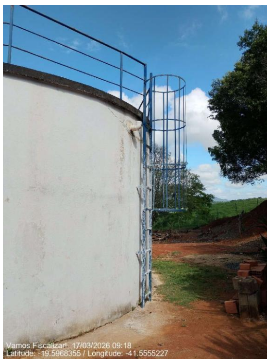
Escada em boas condições no tanque de contato
