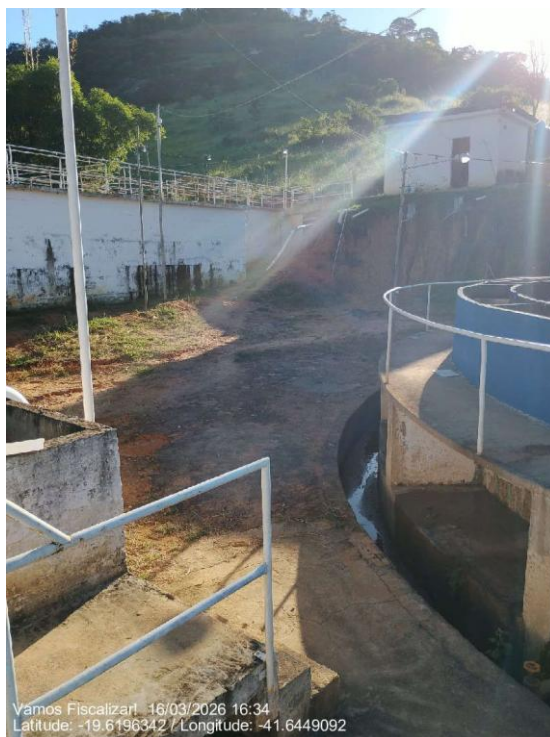
Manutenção da área no entorno da ETA
