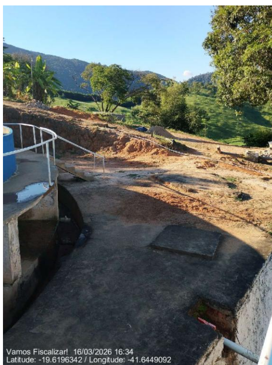
Manutenção da área no entorno da ETA
