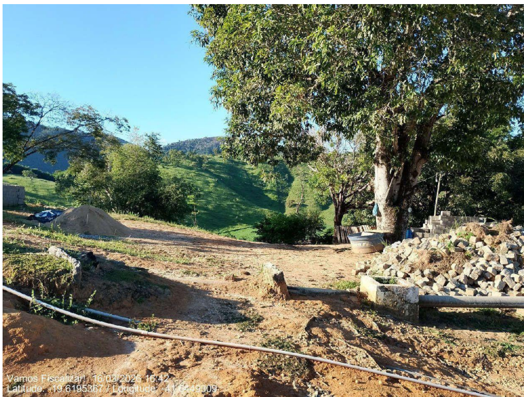
Acesso geral à ETA
