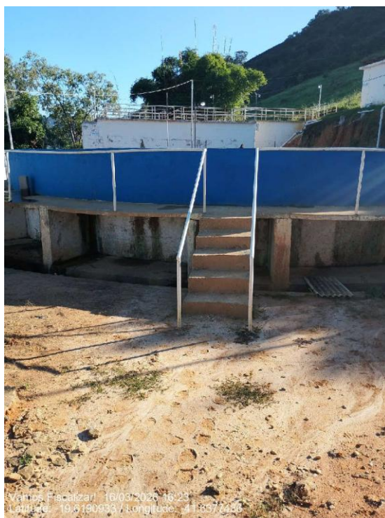
Um dos guarda-corpos do decantador encontrava-se frouxo (retangular)
