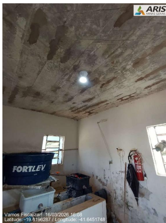
Iluminação noturna na casa de química
