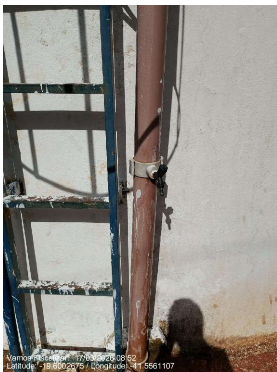
Torneira de coleta de água para análise
