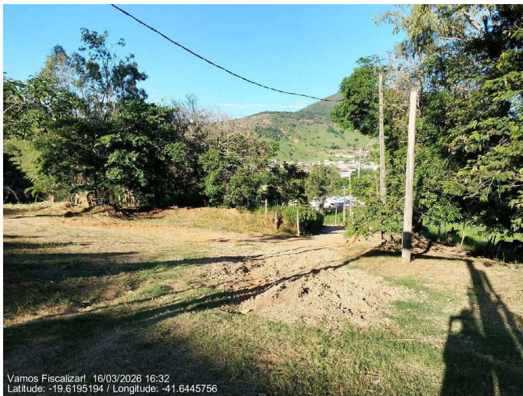
Acesso à ETA.
