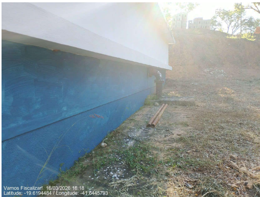
Extravasar da estrutura de reservação I.
