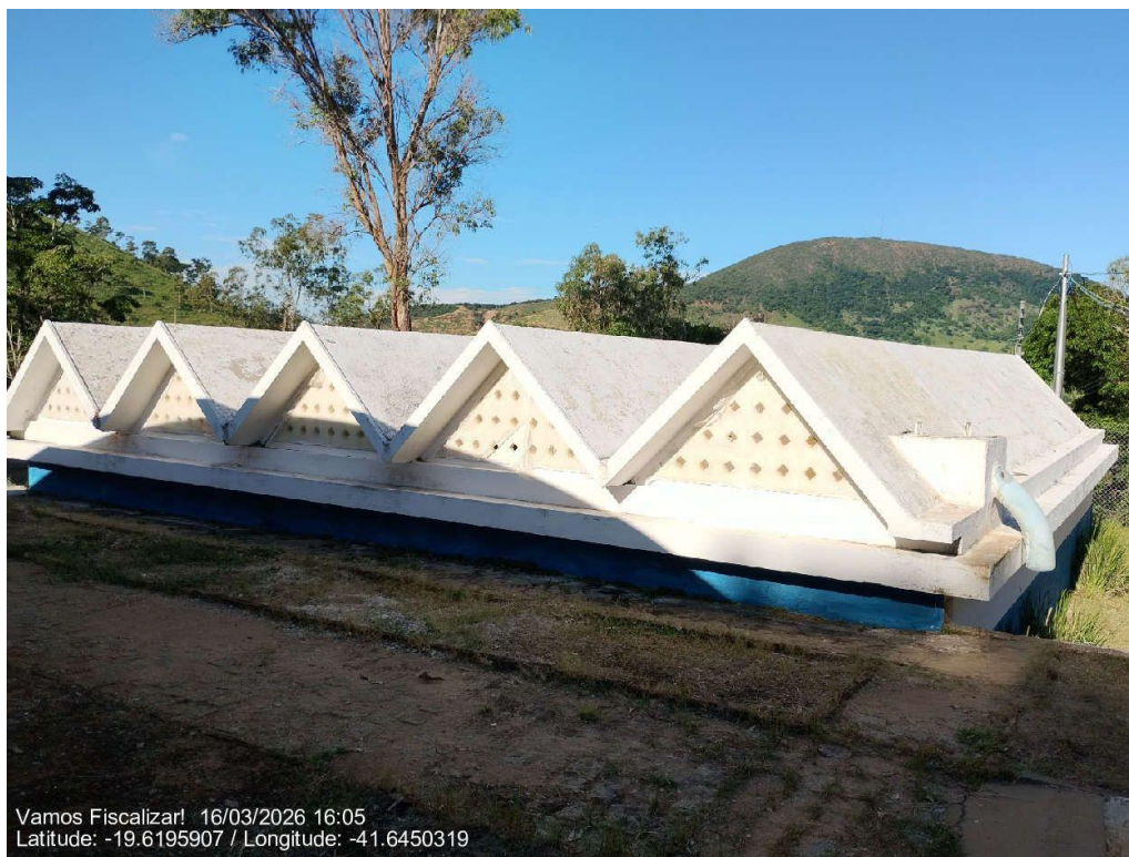
Cobertura em laje inclinada.
