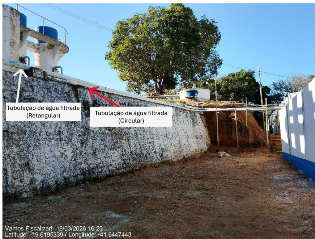
Tubulação de água filtrada que abastece o tanque de contato (Circular)
