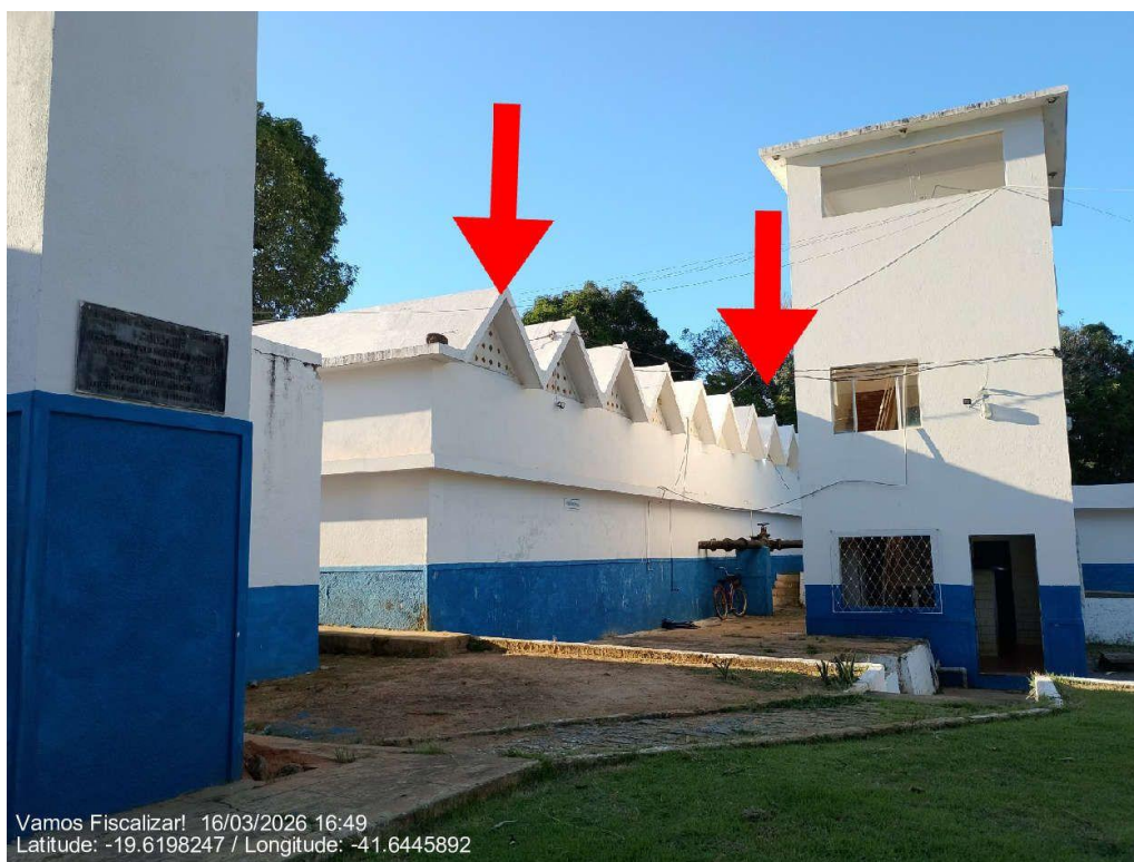
Estrutura de reservatório 1, câmara 1 (tanque de contato) e 2 (reservatório de distribuição), respectivamente.
