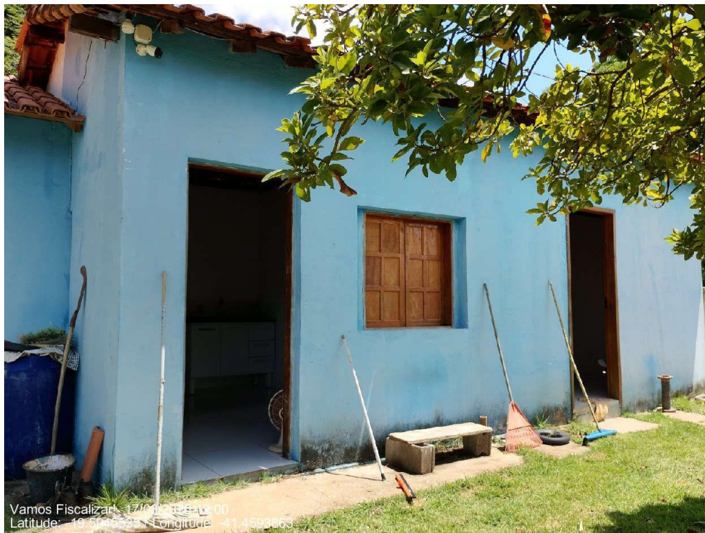
Ausência de normas disponíveis na área externa da ETA
