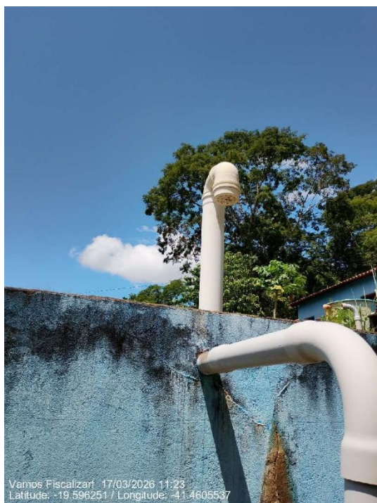
Primeira tubulação para ventilação
