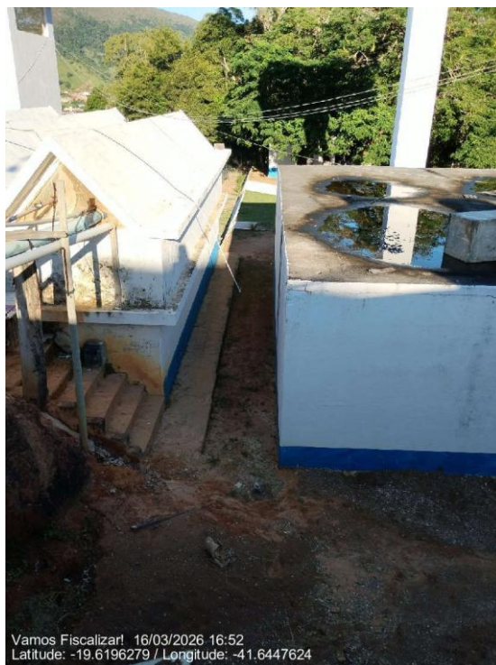
Manutenção da área no entorno da ETA
