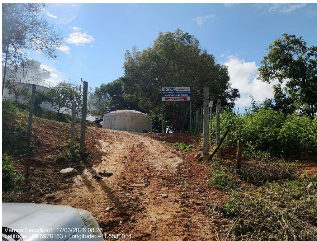
Acesso em terra até a ETA
