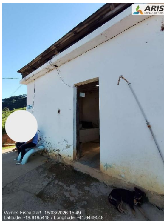
Casa de Química
