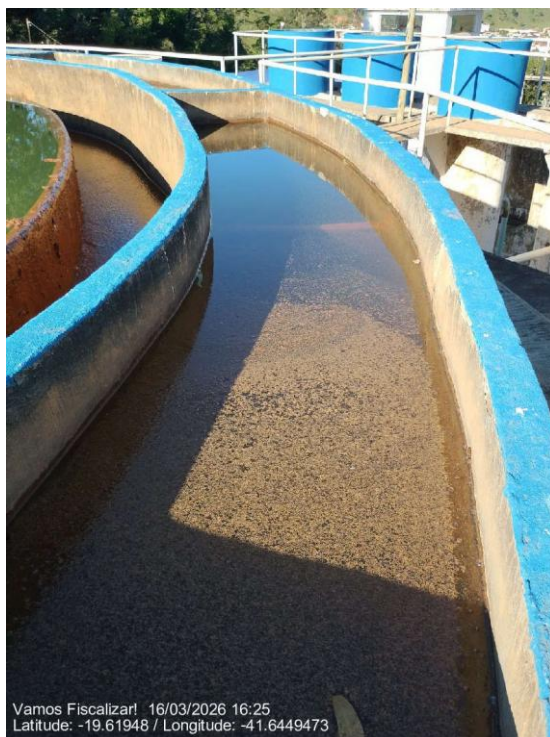
Formação de flocos nos flocladores (Circular)
