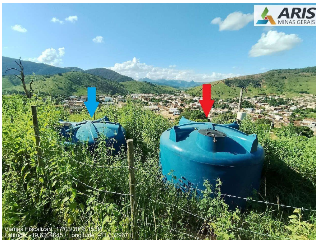
Compartimentação com capacidade de 10 m 3 (seta azul) e com capacidade de 15 m 3 (seta vermelha)
