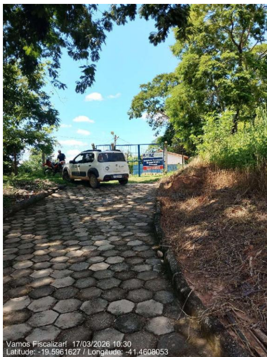
Acessos adequados à ETA
