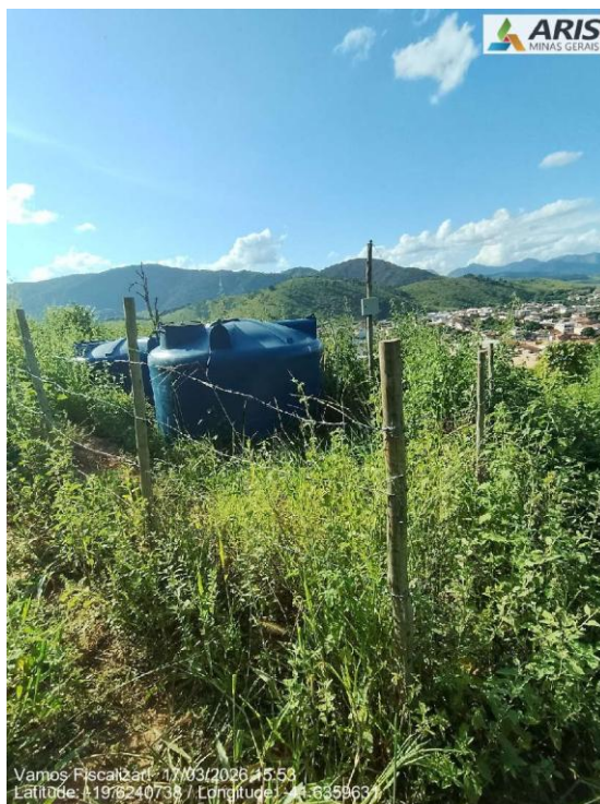
Reservatório São Matheus.
