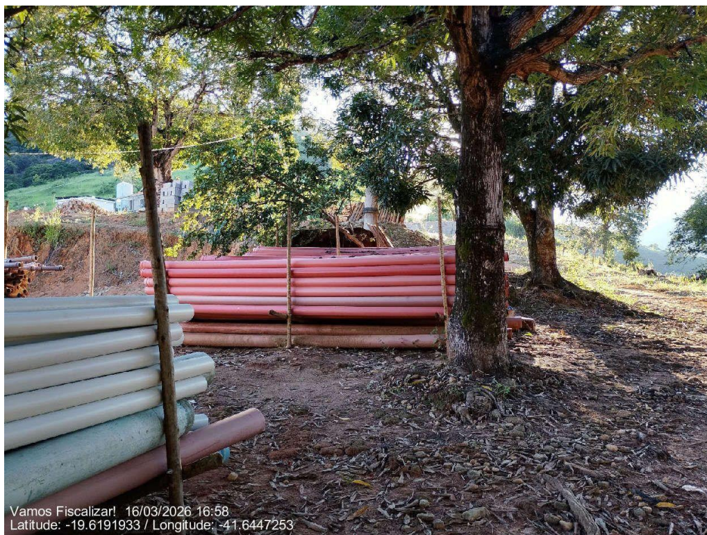
Tubulações armazenamento na área da ETA Sede
