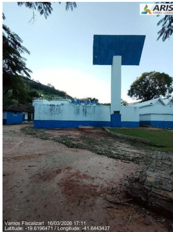
Área da ETA
