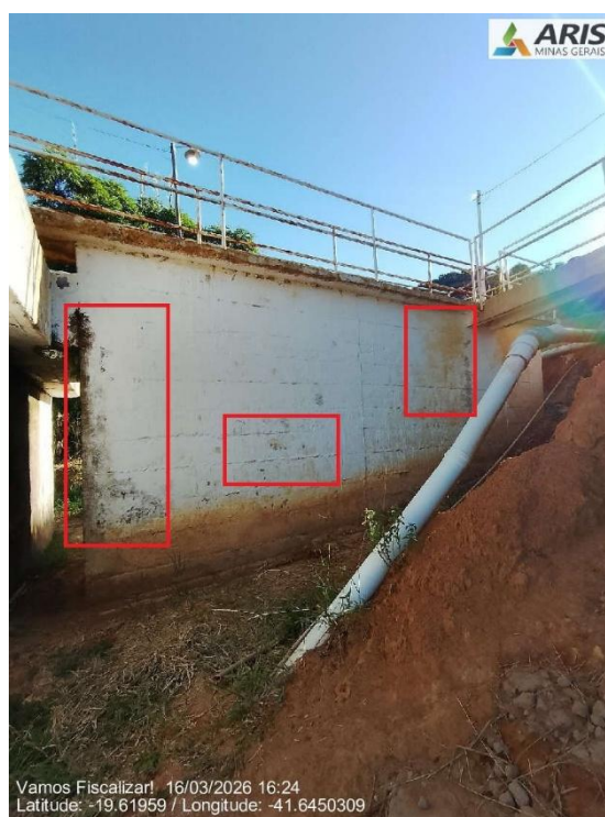
Vista lateral do flocladores (Retangular)
