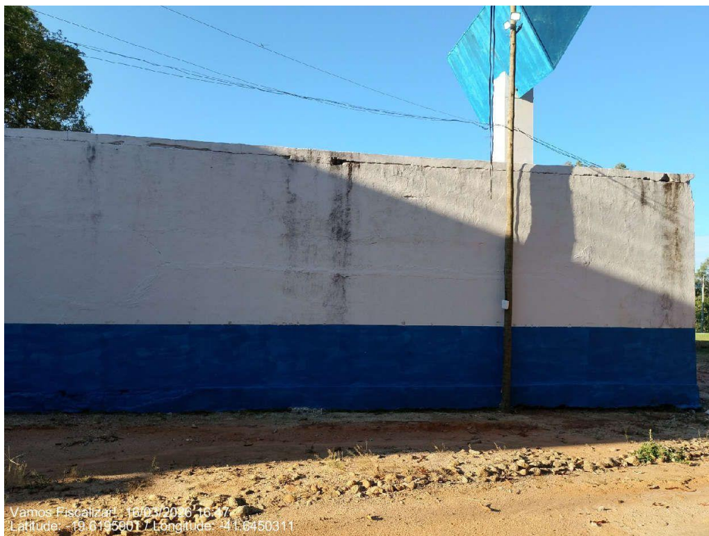
Reservatório 120m 3 da ETA Sede (DESATIVADO).
