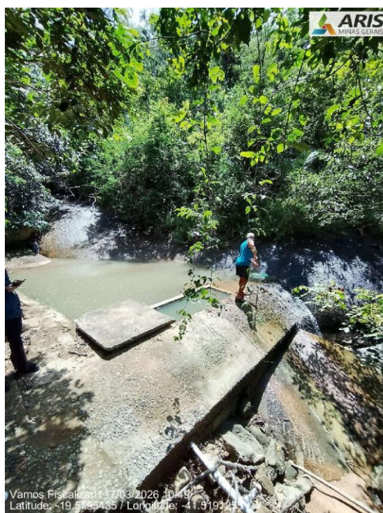
Ponto de captação
