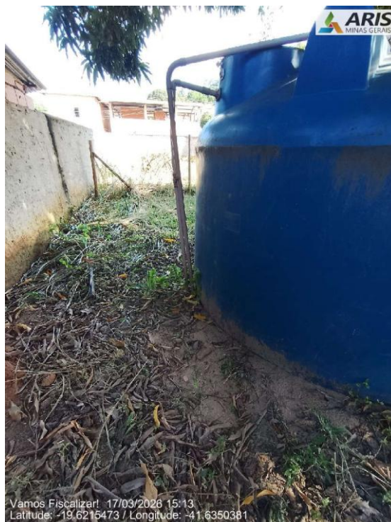
As caixas d'água estão apoiadas diretamente no solo
