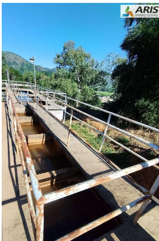
Floclador com 7 câmaras em operação (Retangular)
