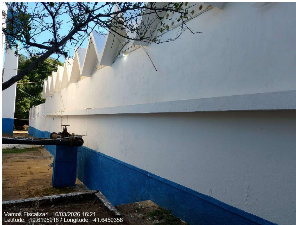
Estrutura do reservatório.
