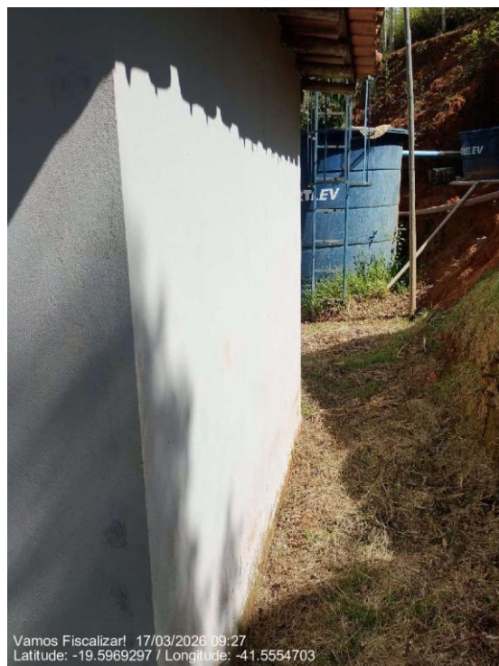
Estruturas em bom estado de conservação
