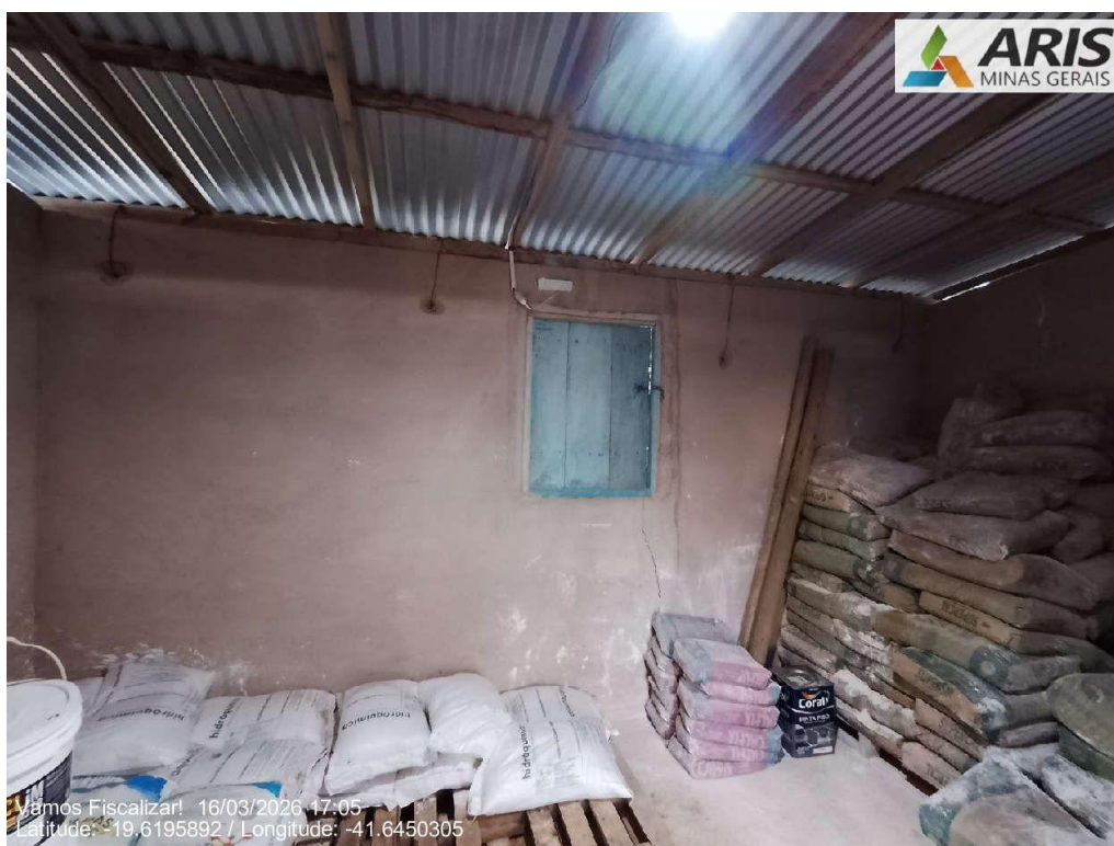
Abertura próximo à cobertura do almoxarifado. Uma única janela para ventilação.
