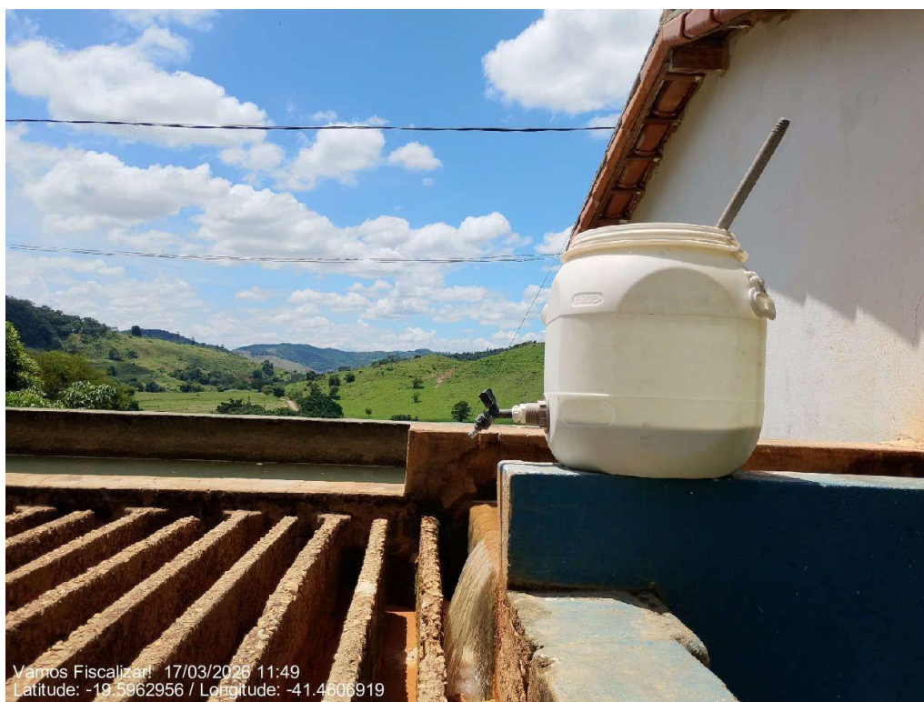
Preparo e dosagem da cal para correção do pH
