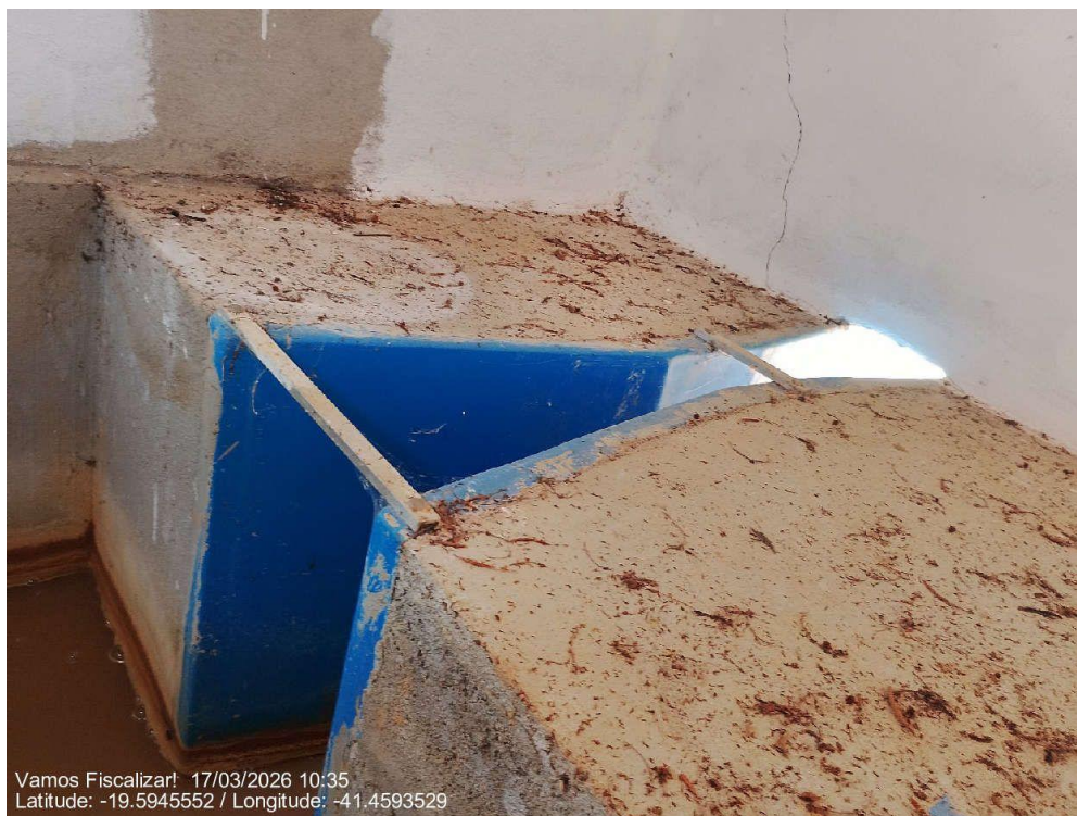
Calha Parshall na entrada do tratamento
