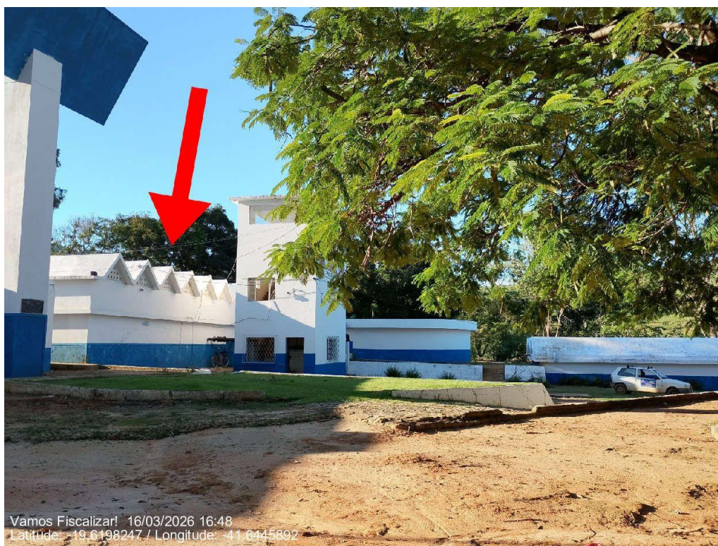
Estrutura de reservação I.
