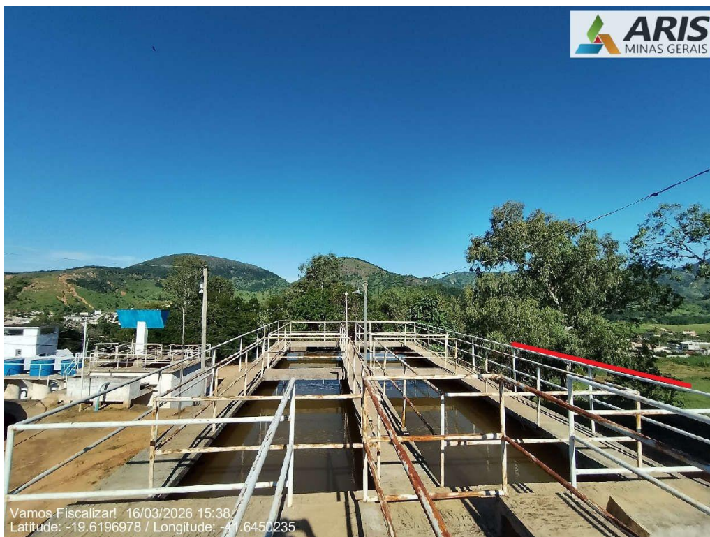
Um dos guarda-corpos do decantador encontrava-se frouxo (retangular)
