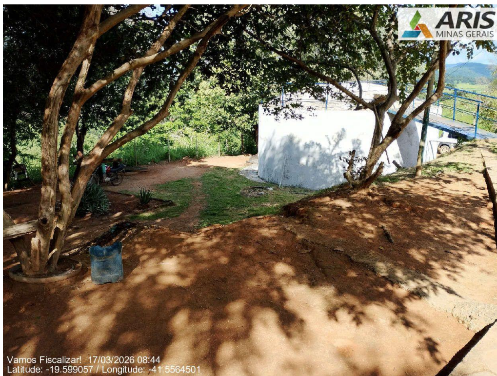
Área que permite o acesso do tanque de contato para o reservatório
