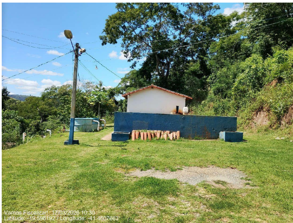
Vista geral da ETA
