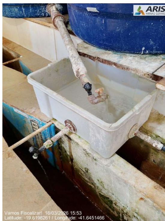
Recipiente de distribuição/aplicação da solução de cal
