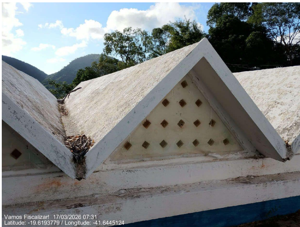
Calhas obstruídas.
