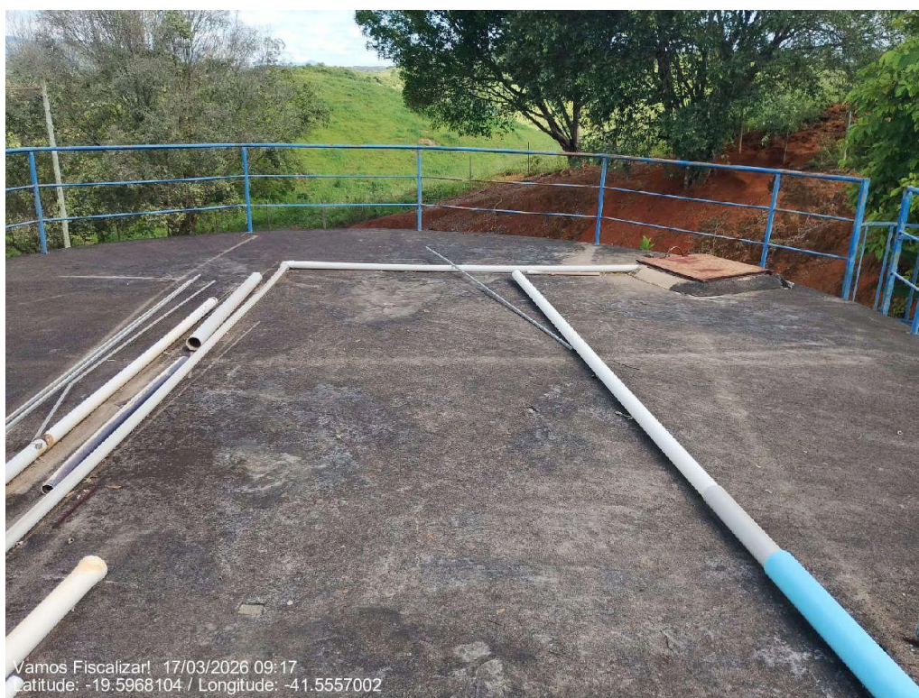
Cobertura do tanque de contato
