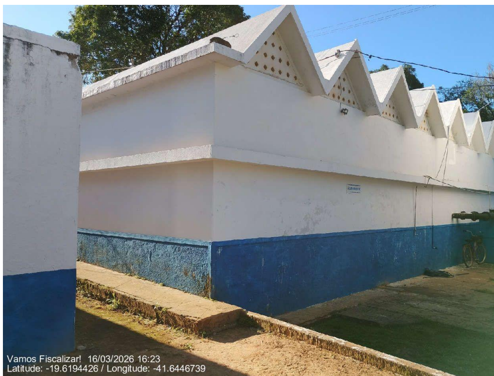
Estrutura do reservatório.
