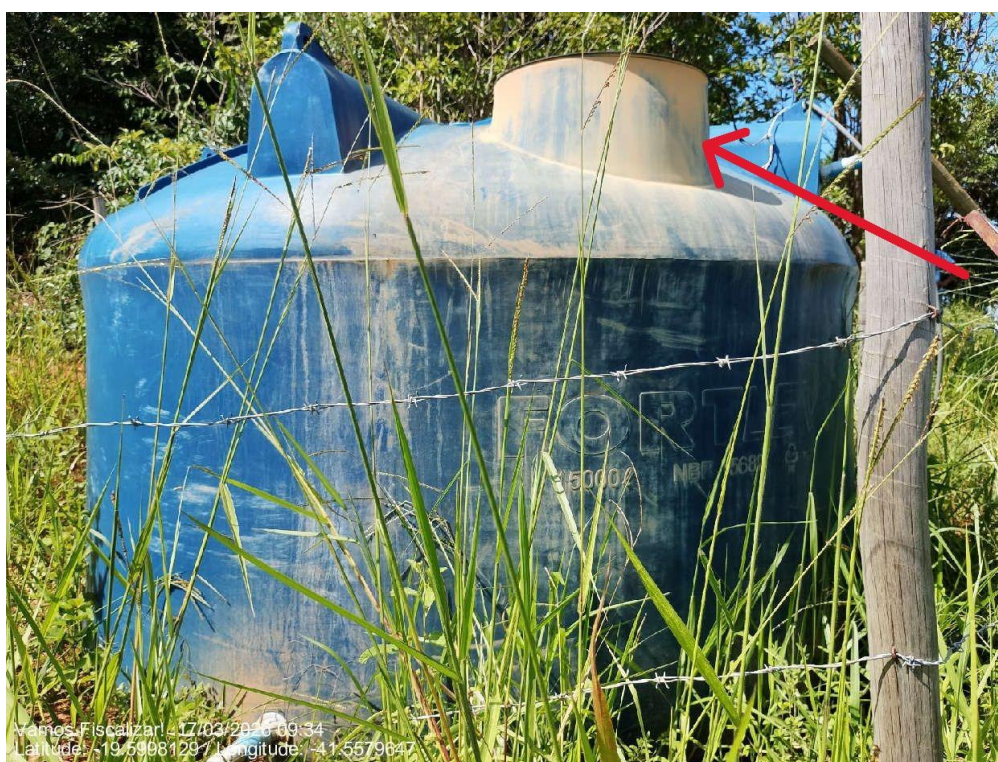
Marcas de transbordamento.
