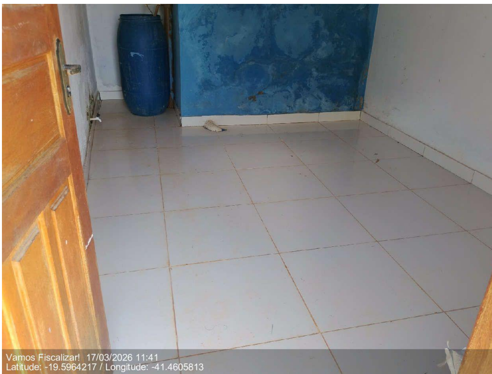
Interior da ETA
