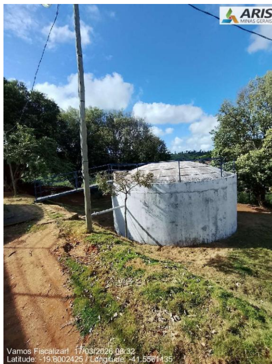
Reservatório com capacidade de 140 m³.
