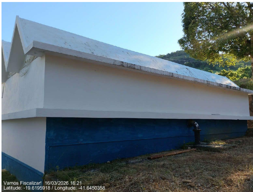
Estrutura do reservatório.
