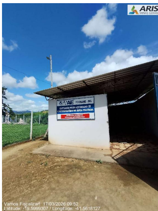
EEAT Barra da Figueira Campo – exterior
