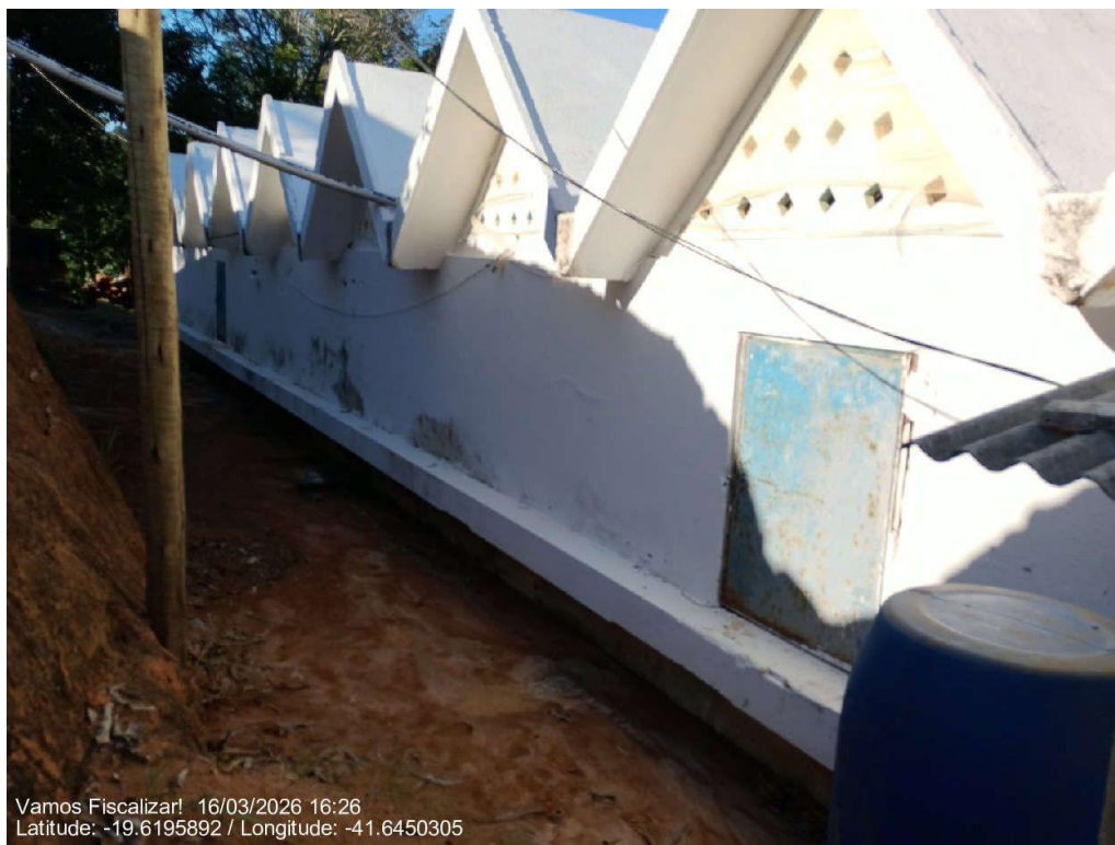
Portas de inspeção da estrutura de reservação I.
