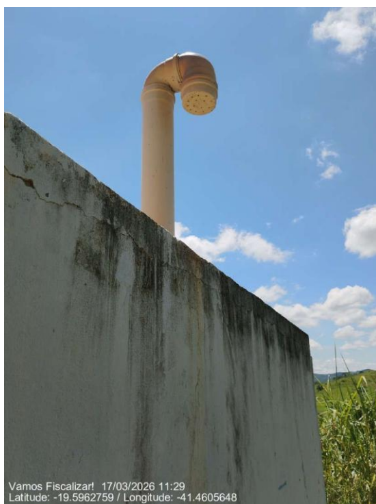
Segunda tubulação para ventilação
