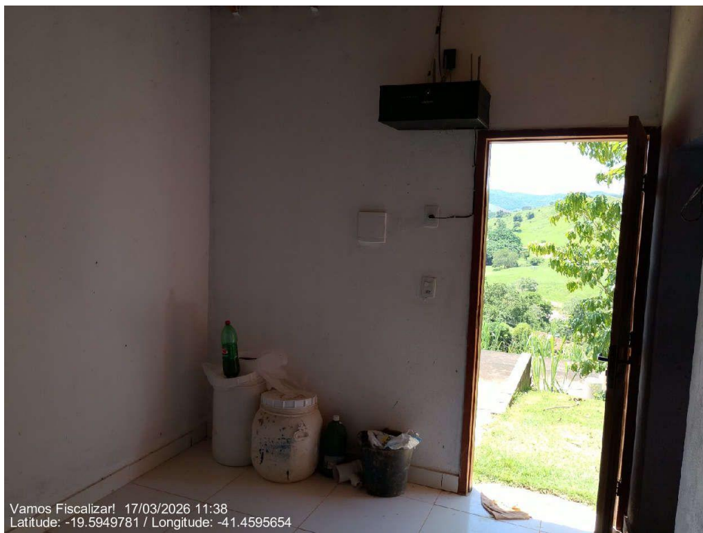
Ausência de normas disponíveis no interior da ETA
