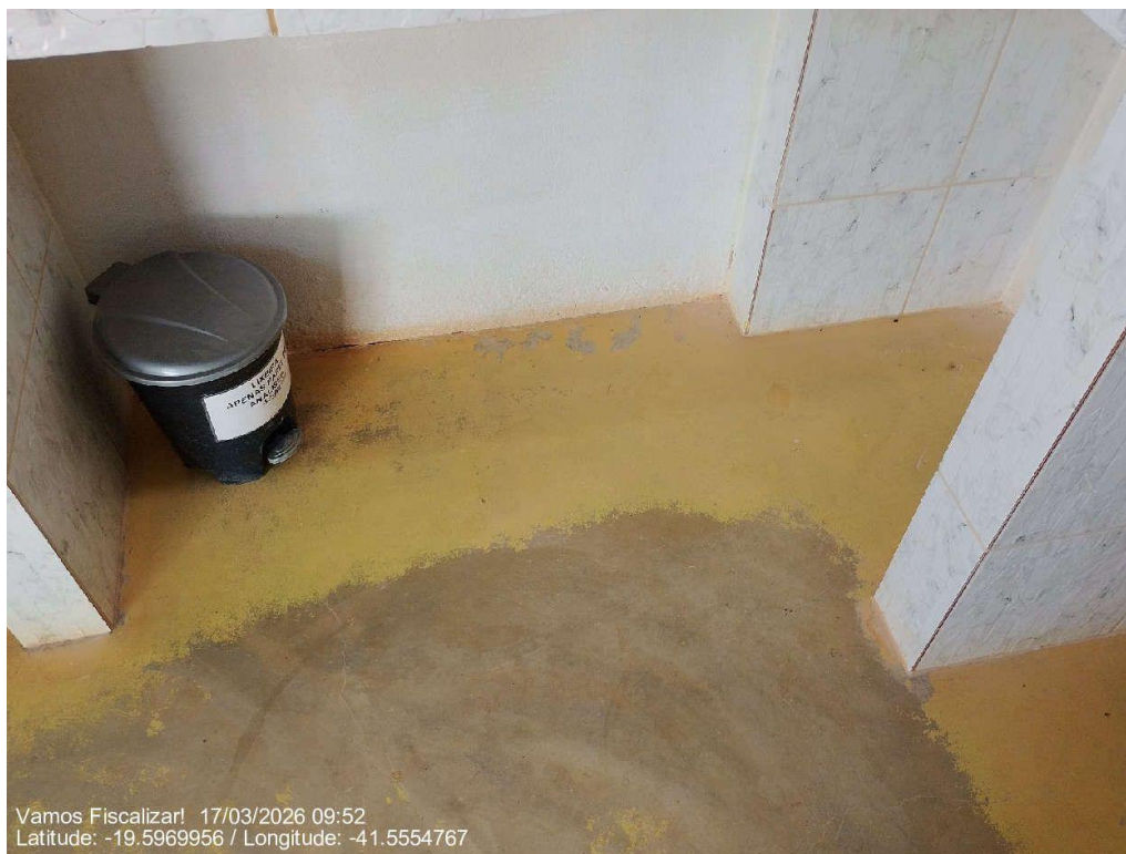
Área embaixo da bancada com lixeira para descarte de papéis utilizados nas análises. Área limpa.
