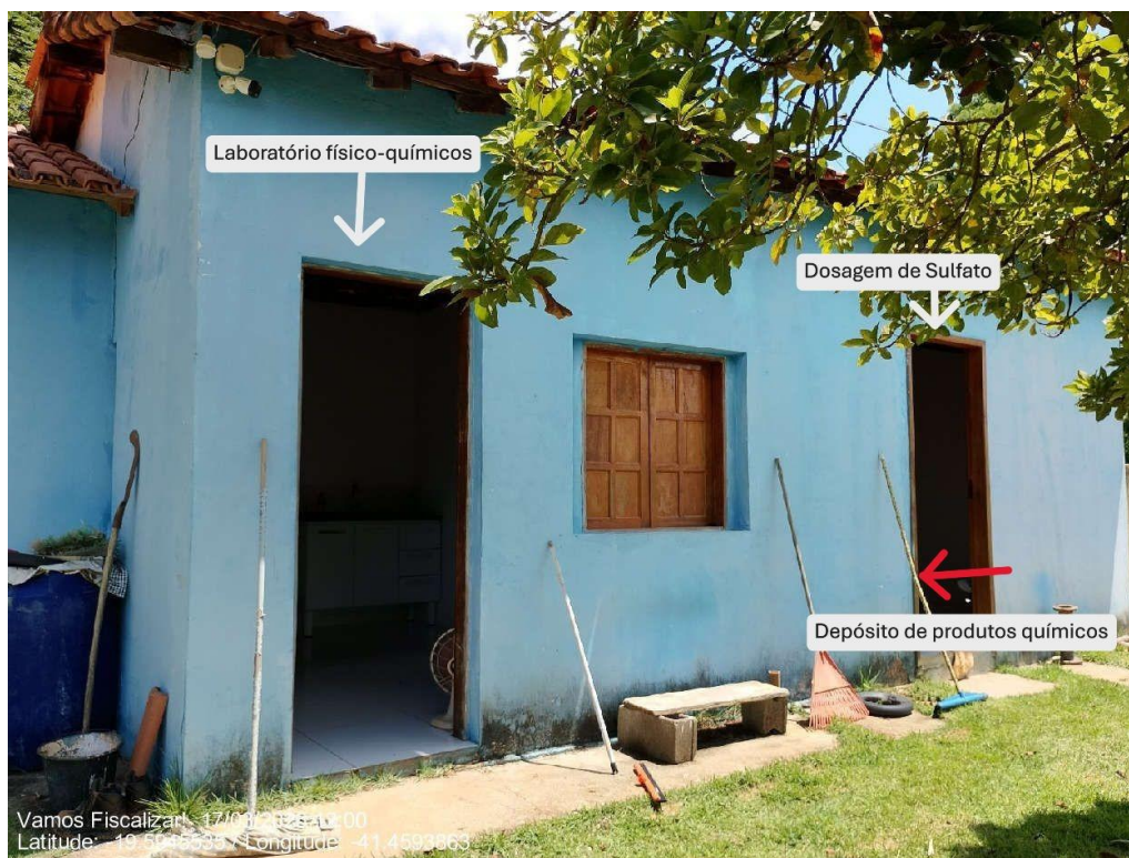
Estruturas da ETA Assaraí, com indicação do acesso ao depósito de produtos químicos
