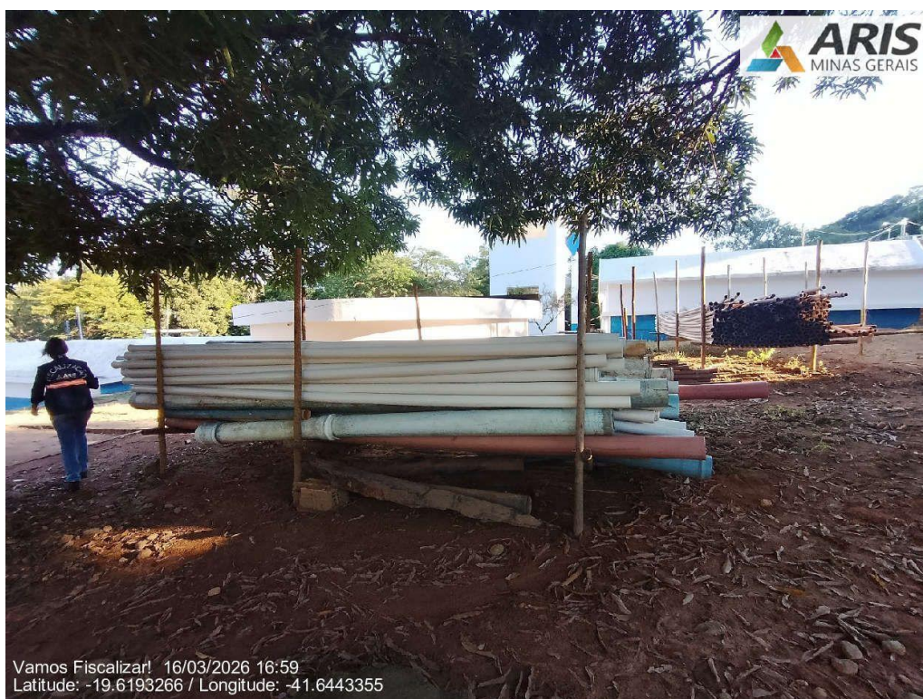
Armazenamento de tubulação em área externa da ETA
