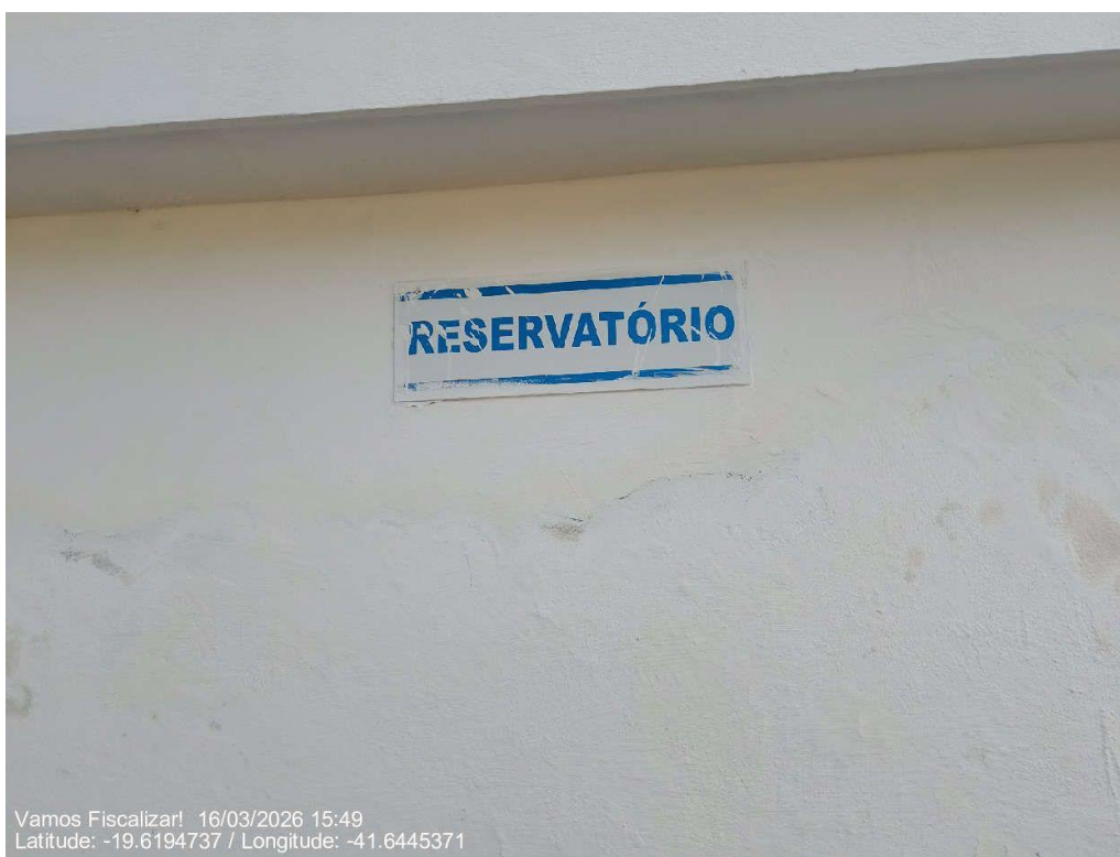
Identificação da Estrutura de Reservação I.
