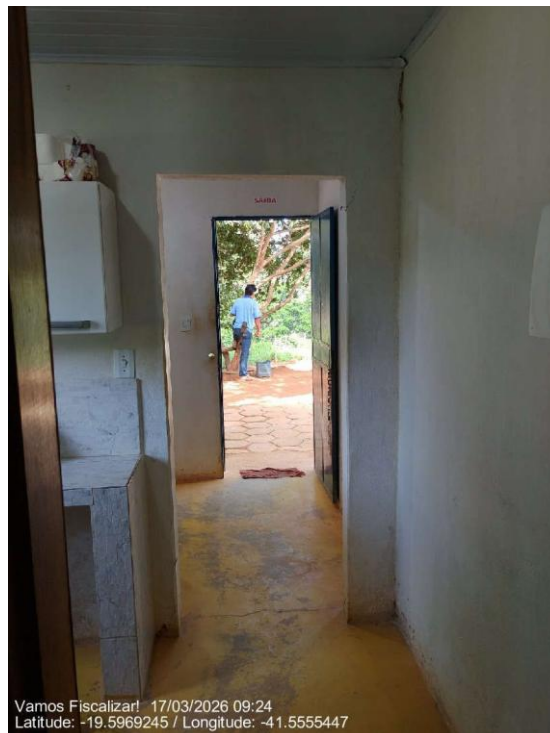
Ausência de chuveiros de emergência e/ou lava olhos
