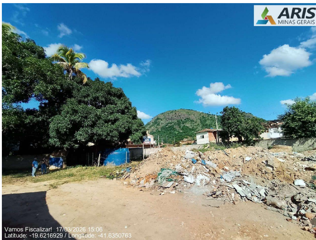
Presença de resíduos sólidos da construção civil
