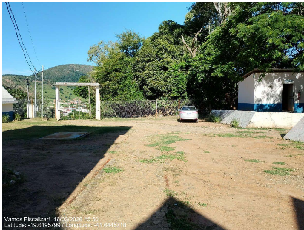
Entrada da ETA.
