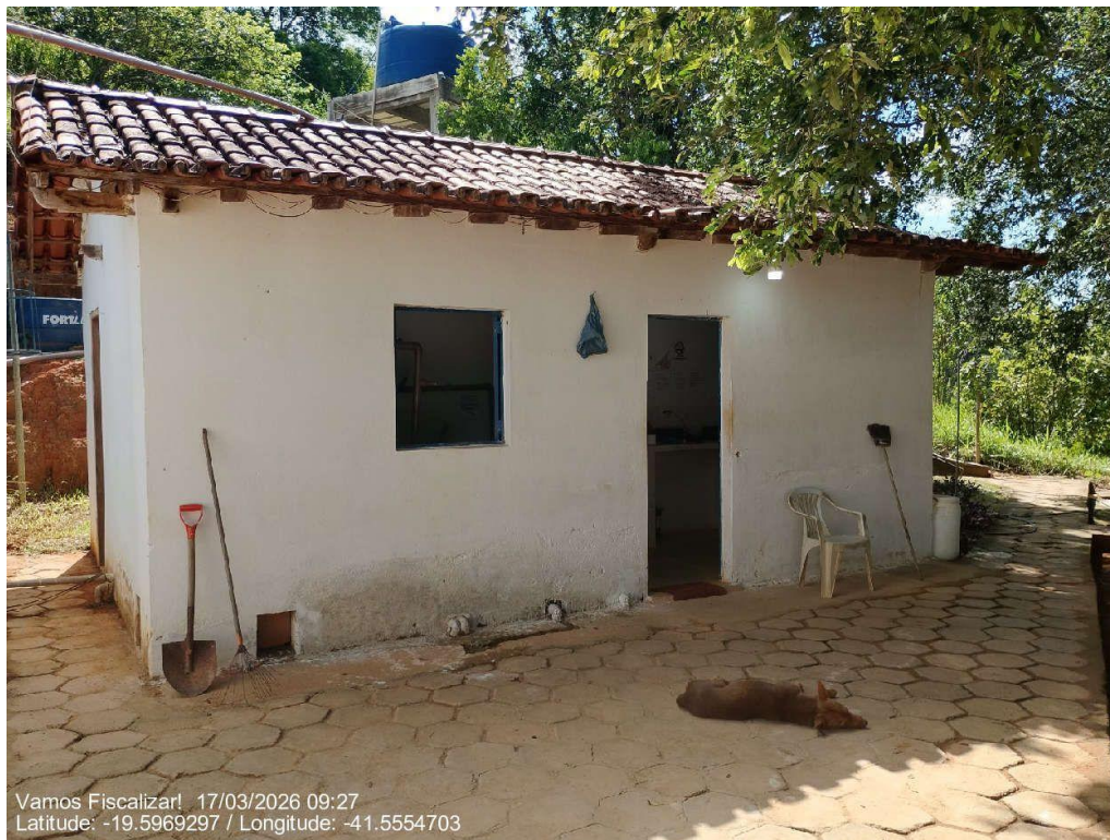
Laboratório físico-químico e área dos filtros pressurizados
