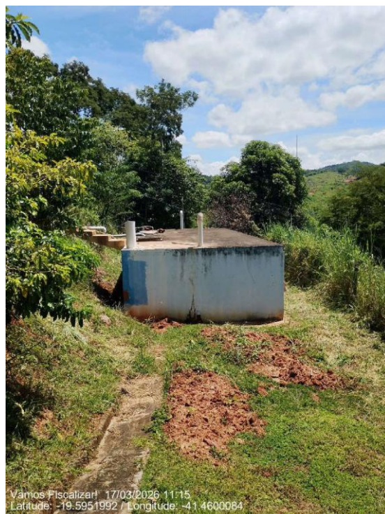
Reservatório ETA Assaraí
