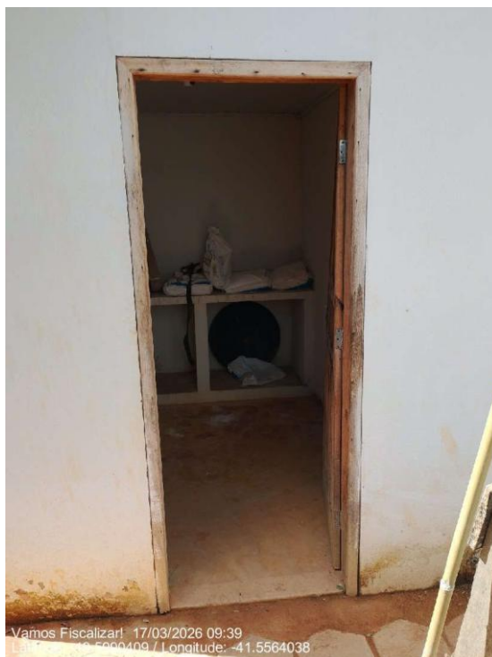
Entrada do depósito de produtos químicos
