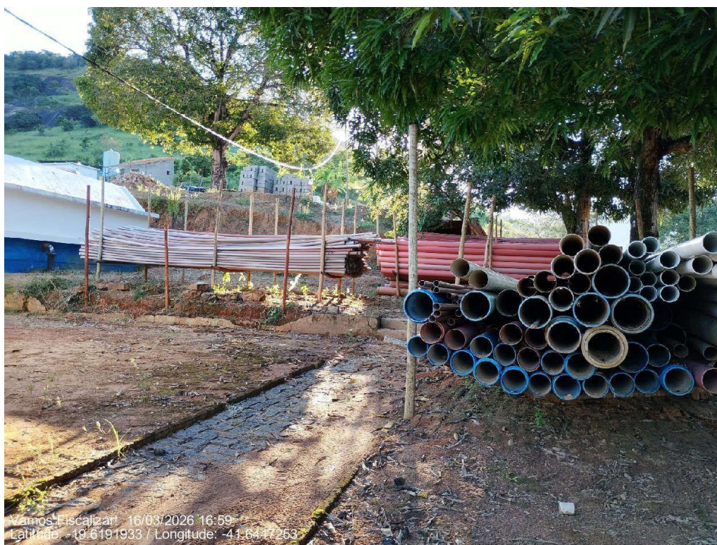
Tubulações armazenamento na área da ETA Sede
