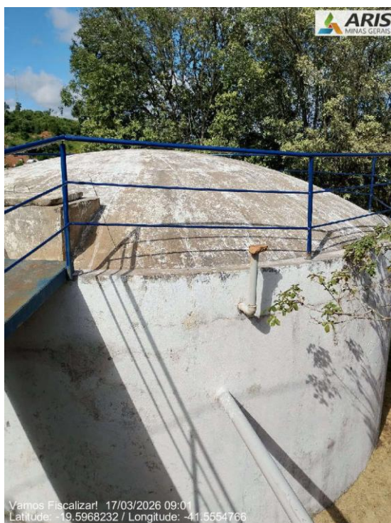
Guarda-corpo no entorno do reservatório
