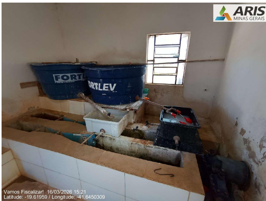
Calhas parshall e adição de Cao e coagulantes químicos.
