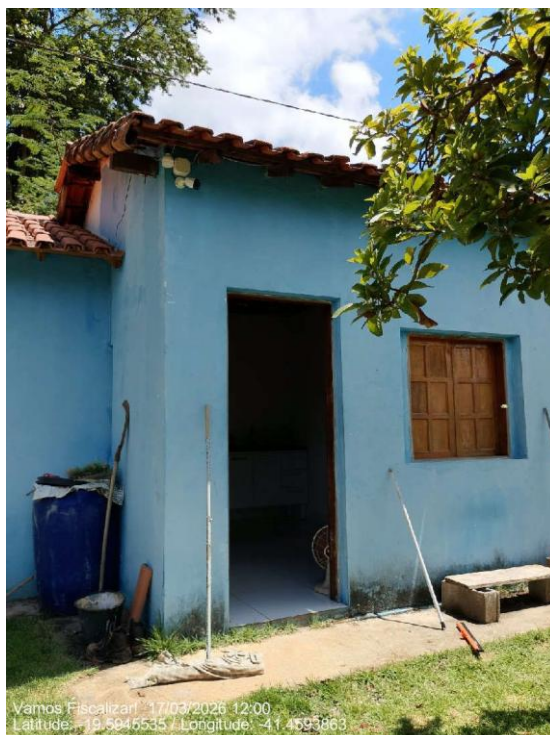
Laboratório físico-químico da ETA Assaraí
