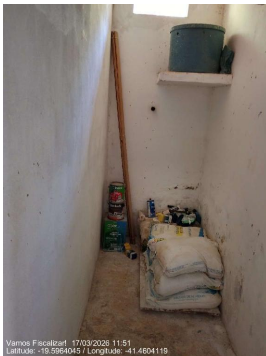
Depósito dos produtos químicos, em área adjacente ao preparo e dosagem do sulfato
