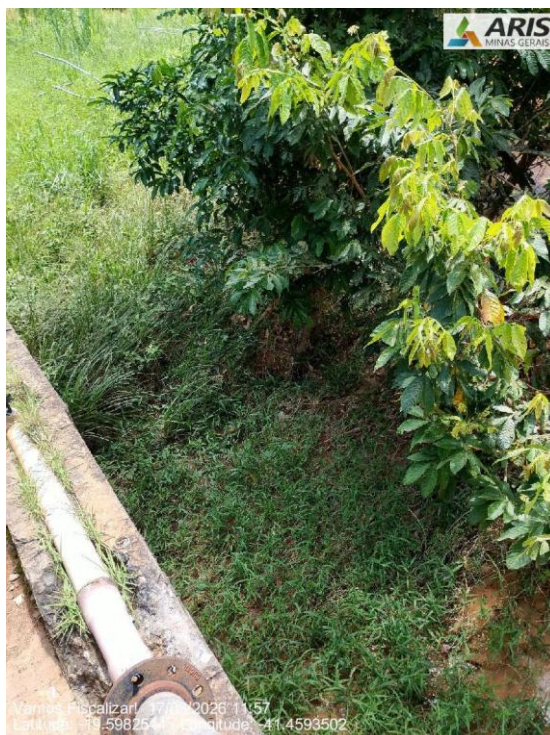
Ausência de mata ciliar
