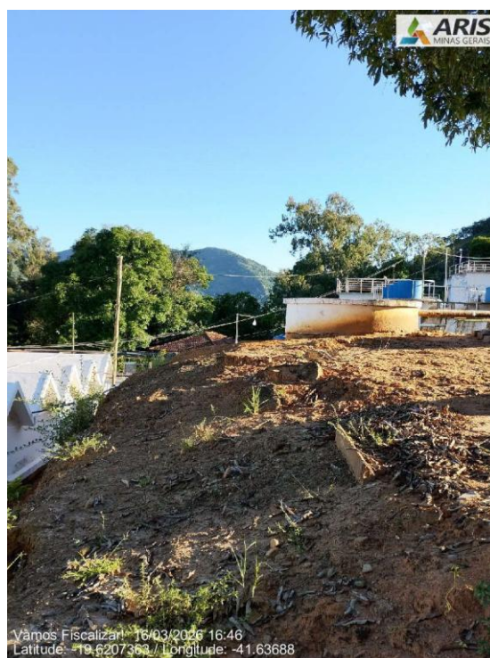
Área com grande desnível, sendo necessária a implantação de guarda corpo
