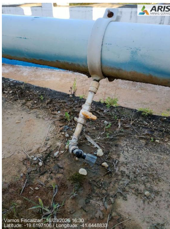
Dispositivo de coleta de água (Retangular)
