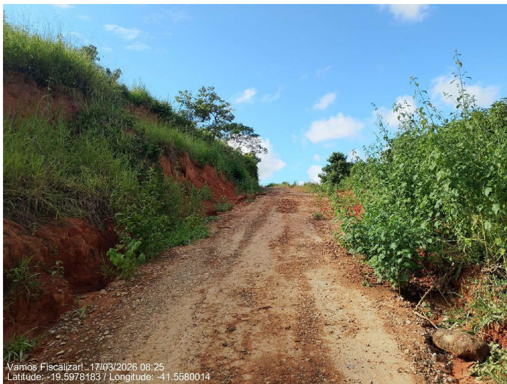
Trecho de estrada até chegar as unidades
