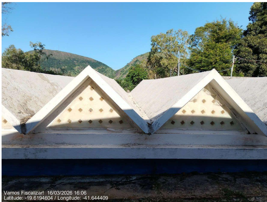
Cobertura em laje inclinada.
