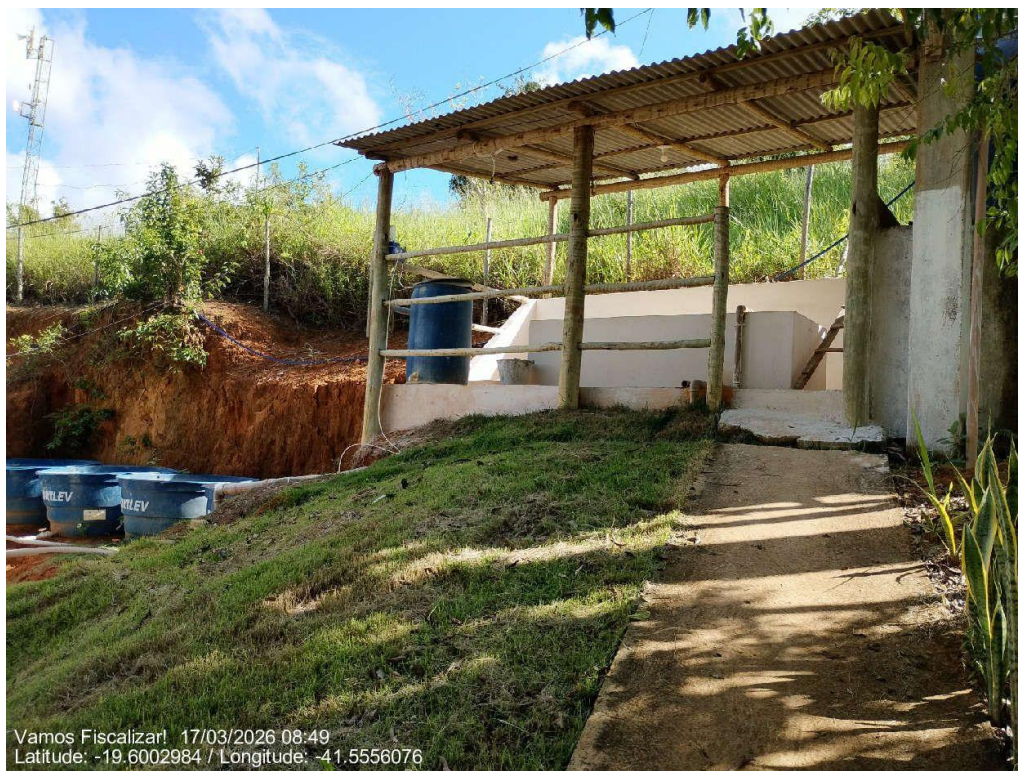
Vista Geral da ETA Barra da Figueira
