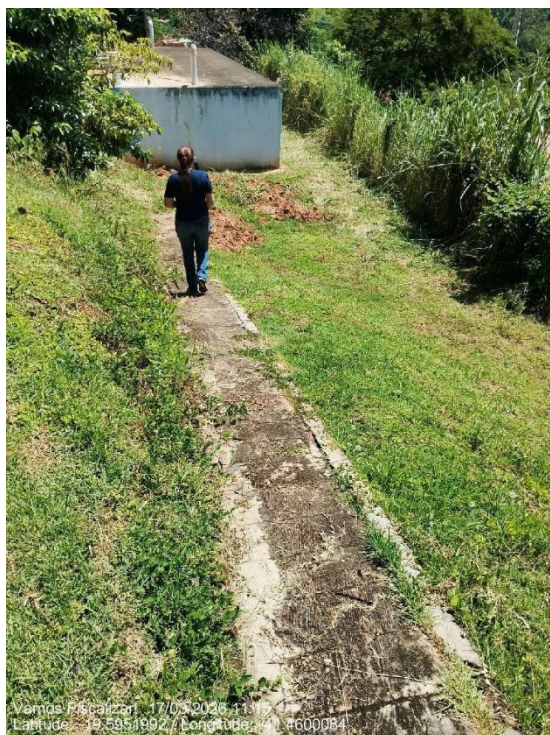
Acesso ao reservatório por rampa
