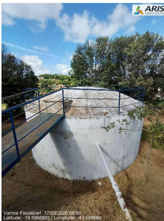
Reservatório em bom estado de conservação
