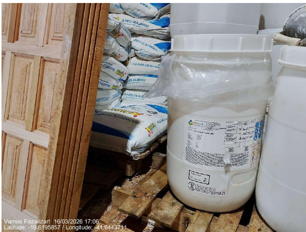
Produtos estocados em paletes, mas com vazamento de produto
