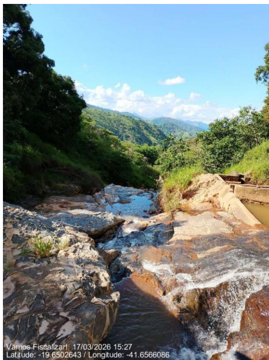
Captação Superficial Cachoeira da Geenita.
