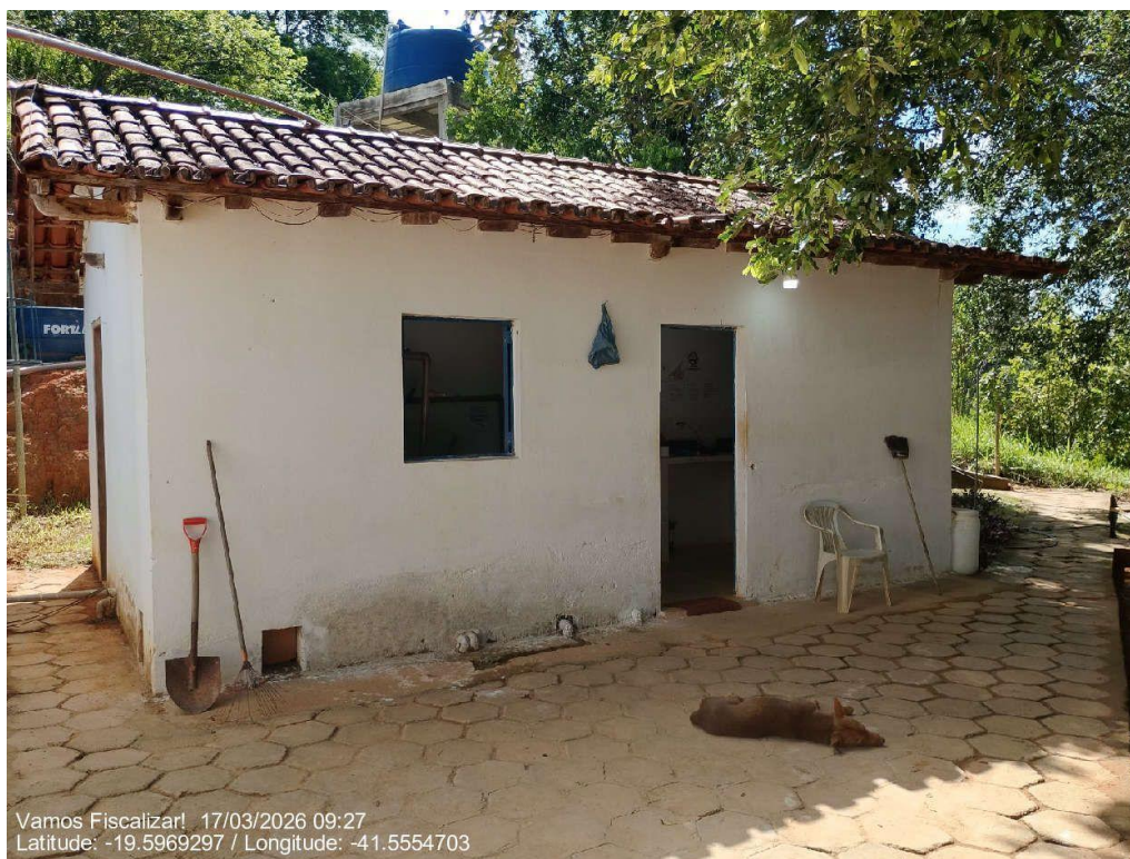
Vista geral da casa de química (laboratório, área dos filtros, depósito dos produtos químicos)
