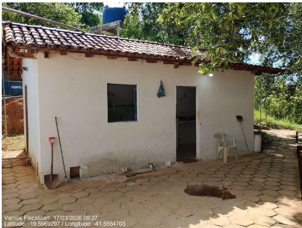
Estruturas em bom estado de conservação
