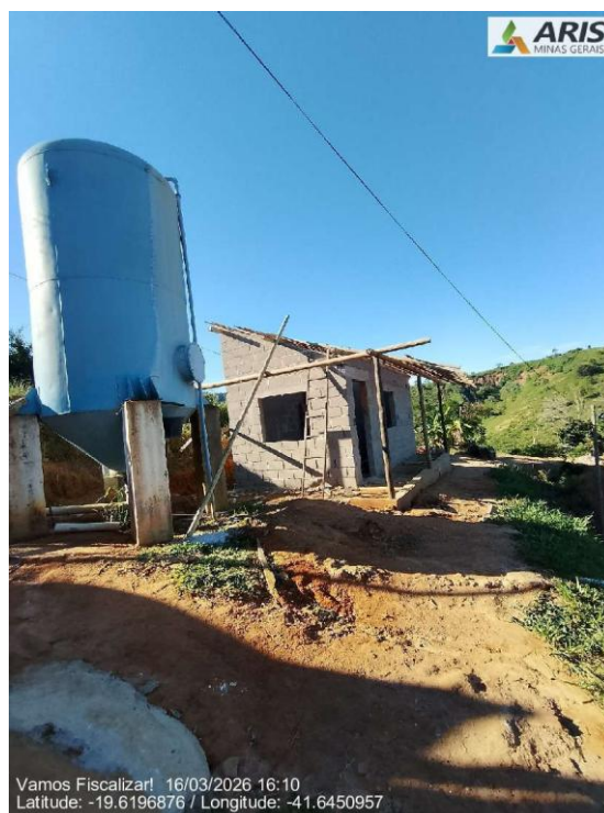
Novo laboratório físico-químico em construção
