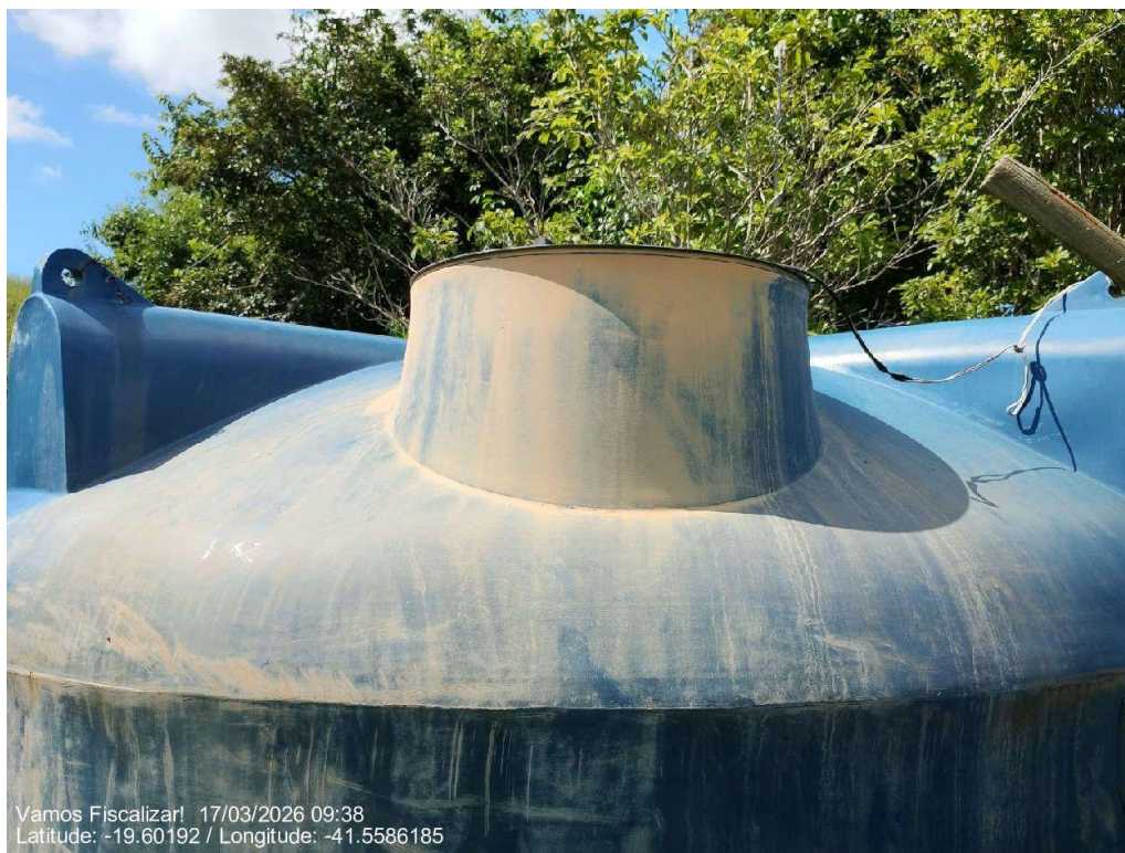
Reservatório Barra da Figueira.
