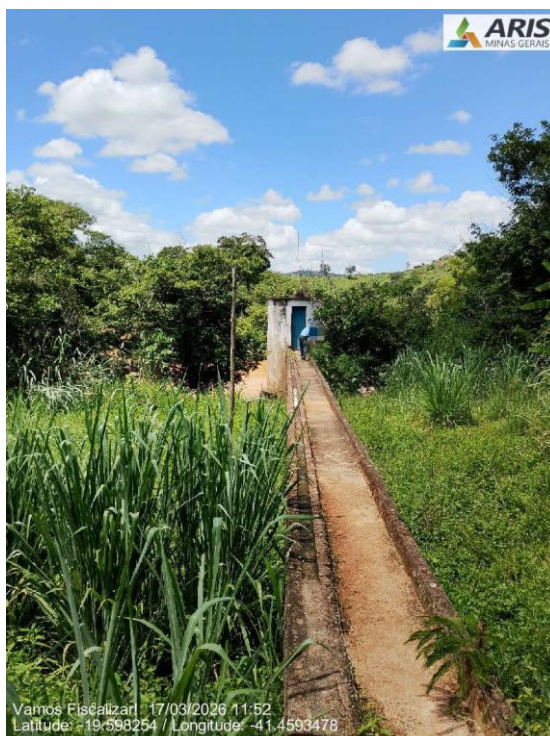
Captação Superficial Rio São José – acesso
