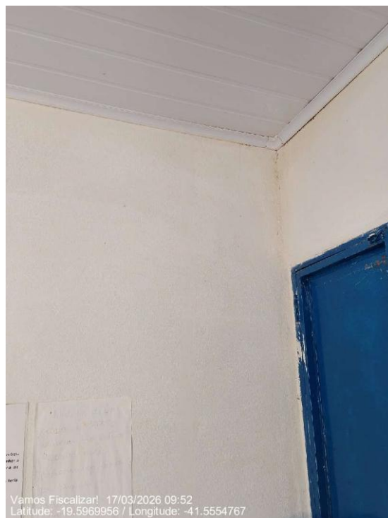
Forro de PVC
