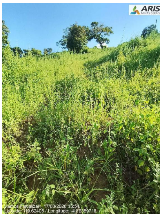
Presença de muita vegetação no acesso ao reservatório.
