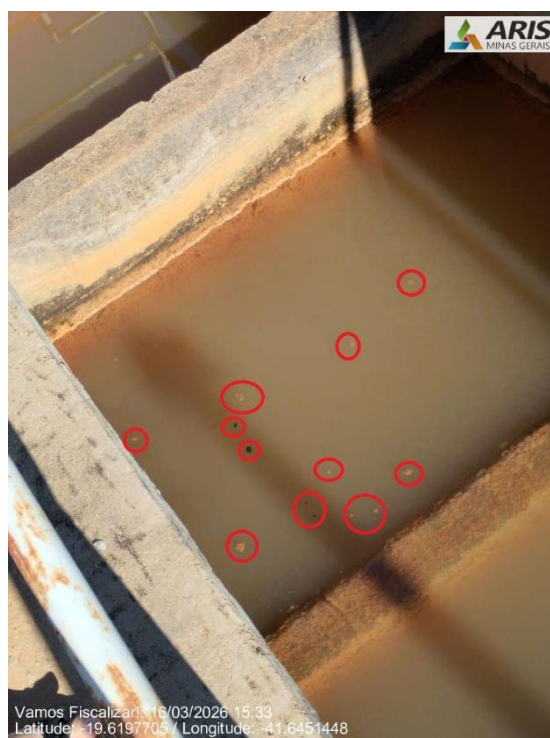
Flocos aparentes no tratamento físico retangular (em vermelho)
