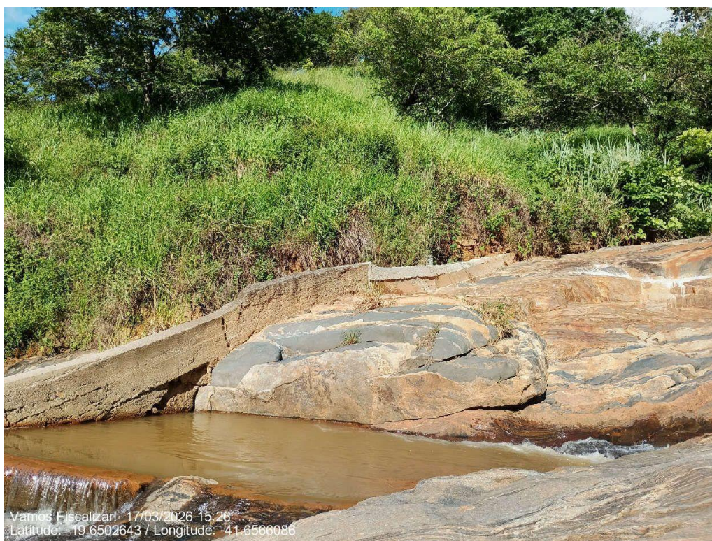
Captação Superficial Cachoeira da Geenita.
