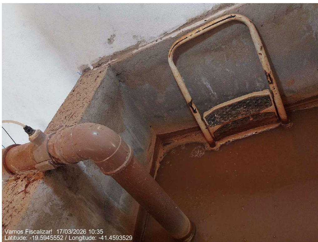
Dosagem de sulfato de alumínio na entrada do tratamento
