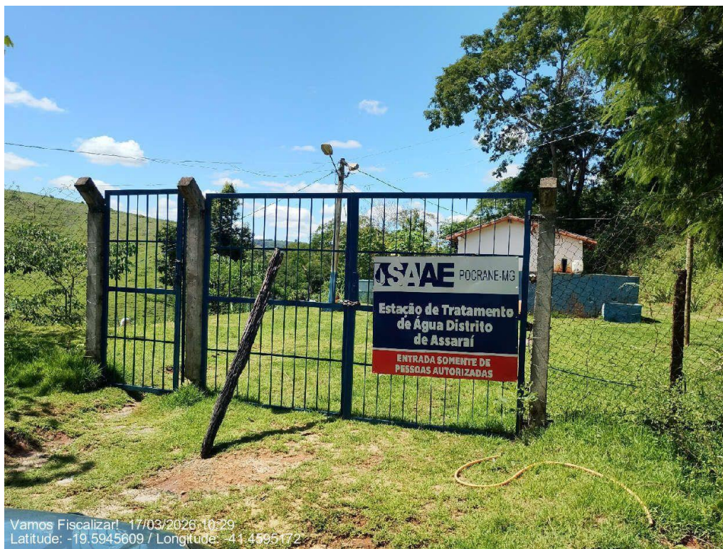
Entrada da ETA Assaraí, local onde se encontra o reservatório
