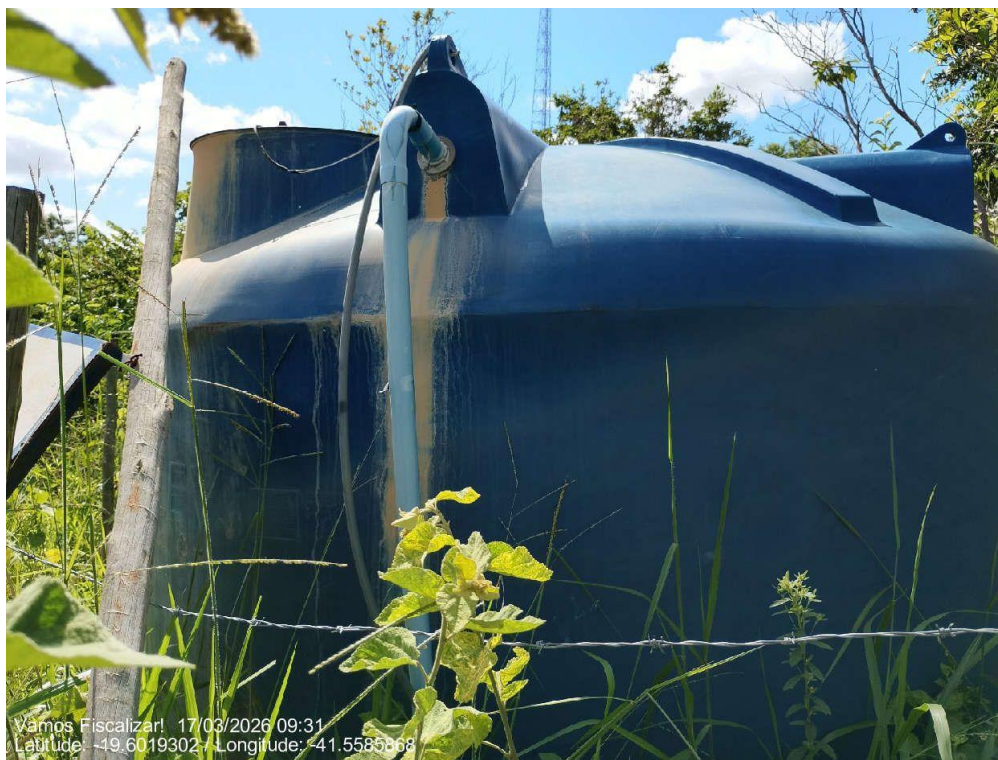
Estrutura do reservatório em boas condições.
