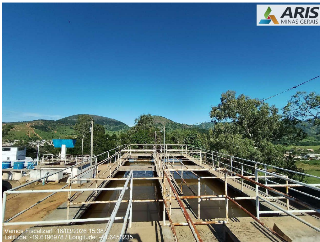
Decantador composto por 2 câmaras em operação (Retangular)
