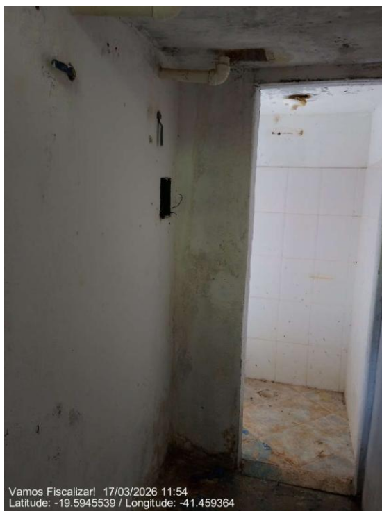
Porta de acesso ao depósito
