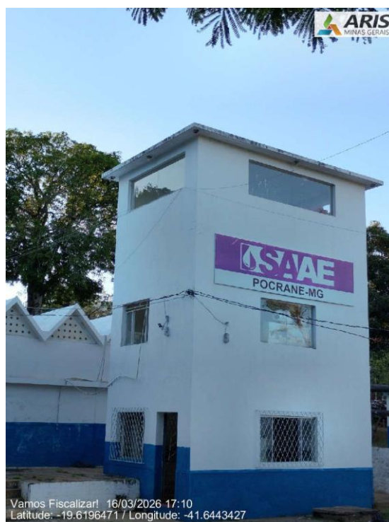
Antiga estrutura do SAAE desativada
