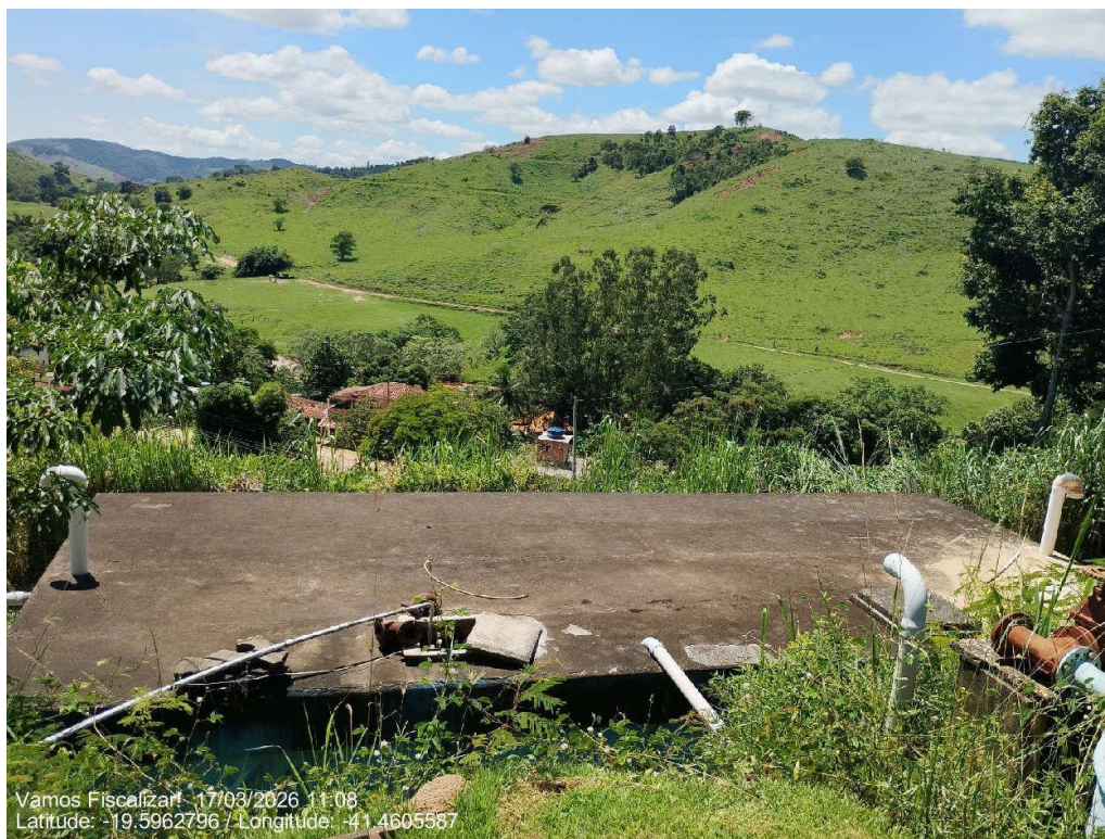
Reservatório ETA Assaraí
