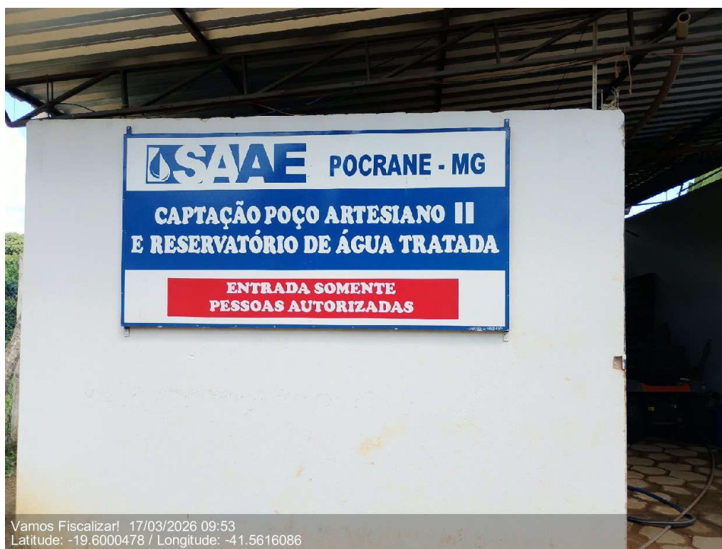
Placa da Captação.
