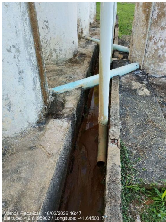
Canal de lançamento das águas da retrolavagem (Circular)
