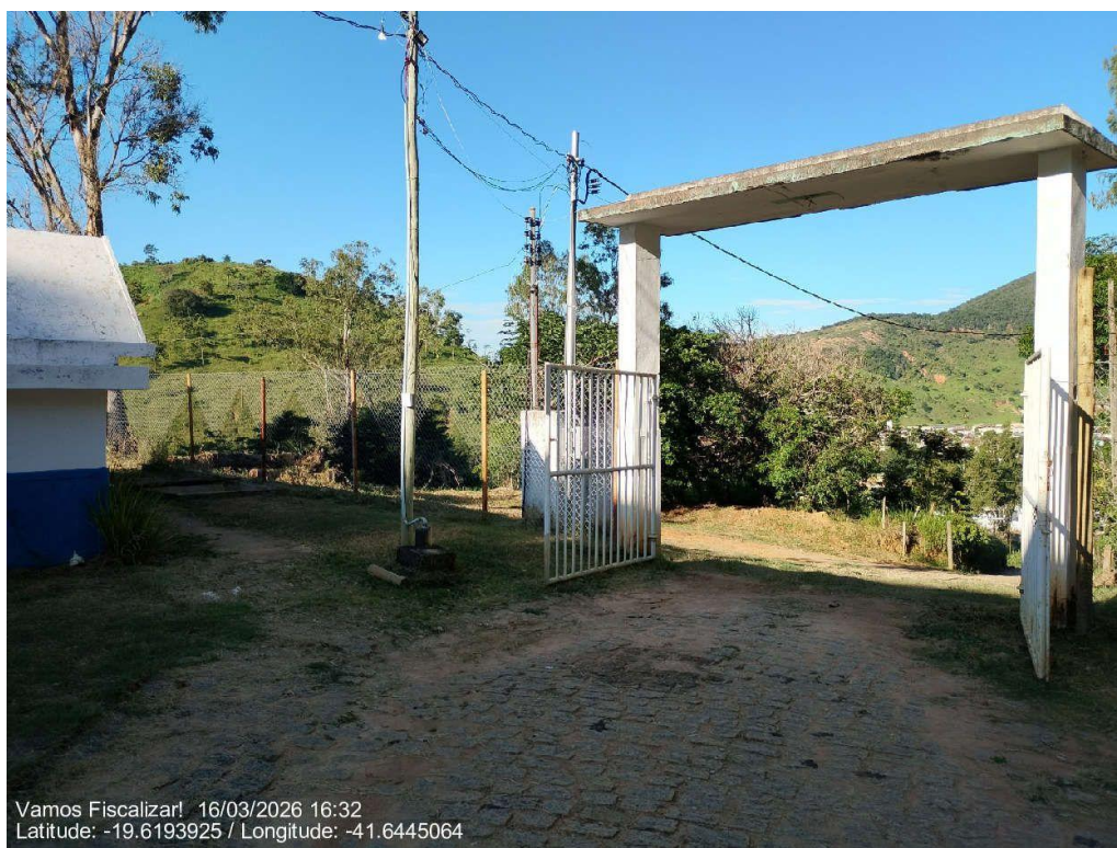
Entrada principal da ETA
