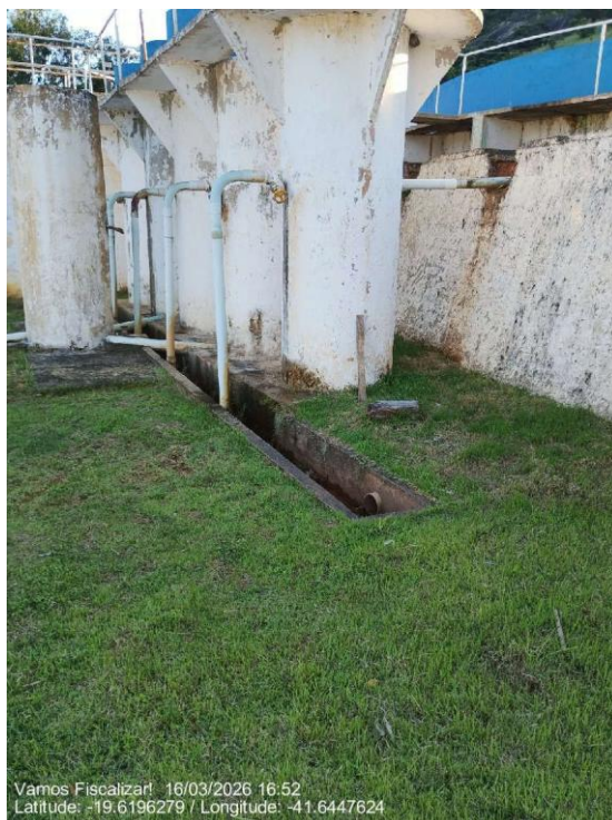
Manutenção da área no entorno da ETA
