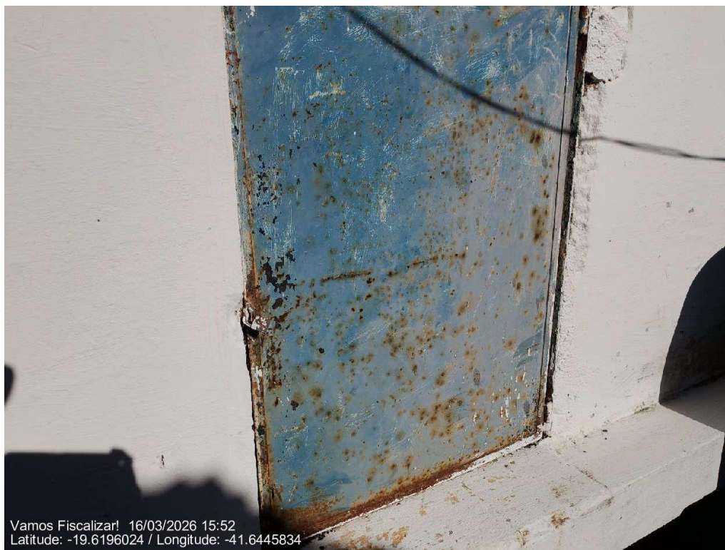
Tampa de inspeção da estrutura de reservação I, câmara 1 (tanque de contato).
