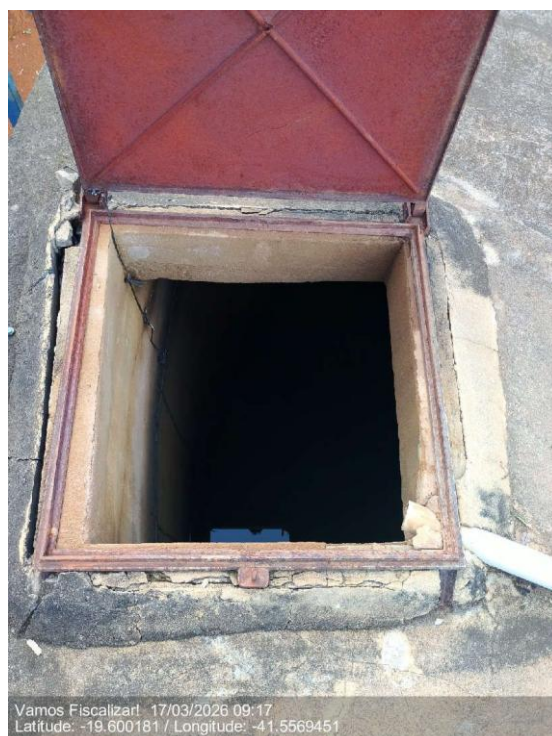
Sem dispositivo de medição de nível
