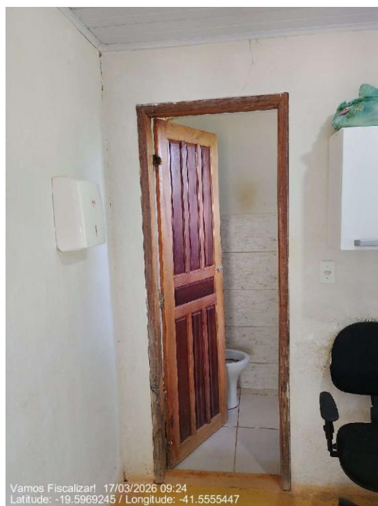
Entrada do banheiro
