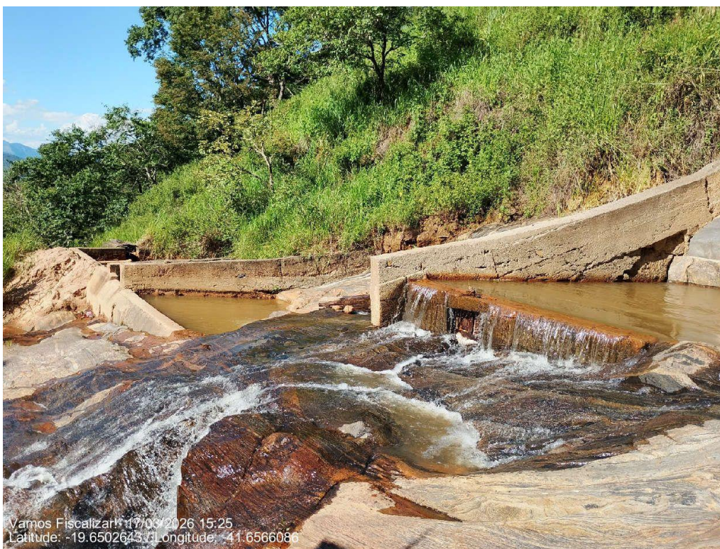
Captação Superficial Cachoeira da Geenita.
