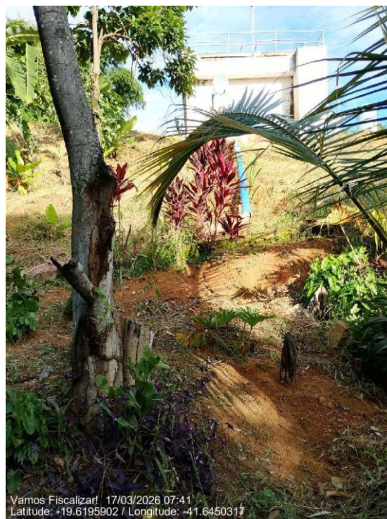
Caminhamento da tubulação de sobra da água bruta
