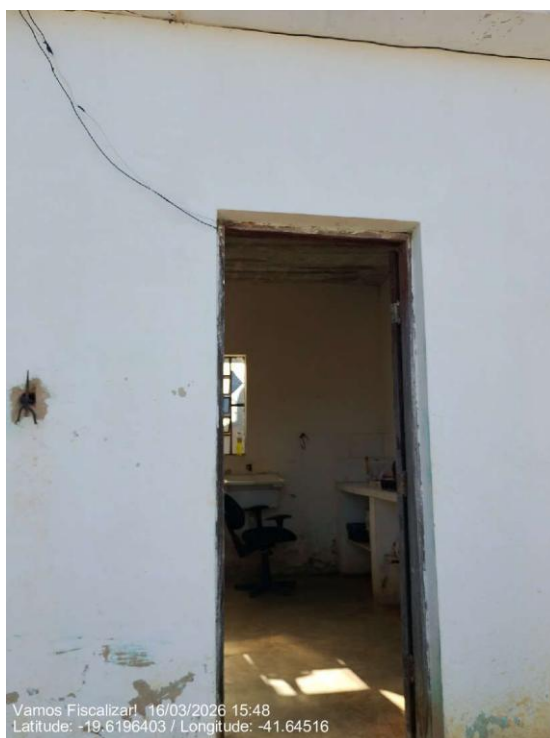
Acesso à Casa de Química
