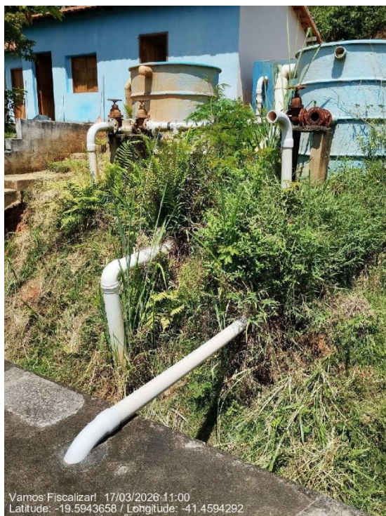
Sem proteção no entorno dos filtros
