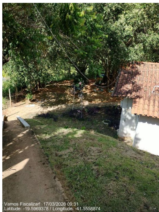
Entorno da ETA
