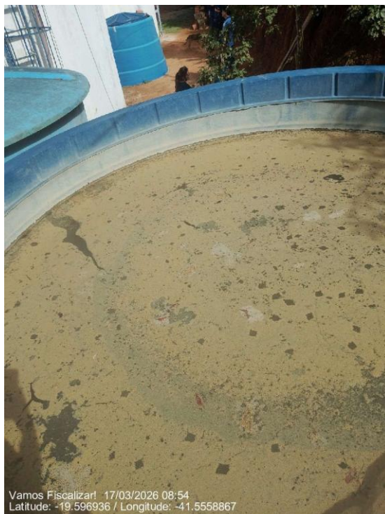
Flocos visíveis no primeiro decantador
