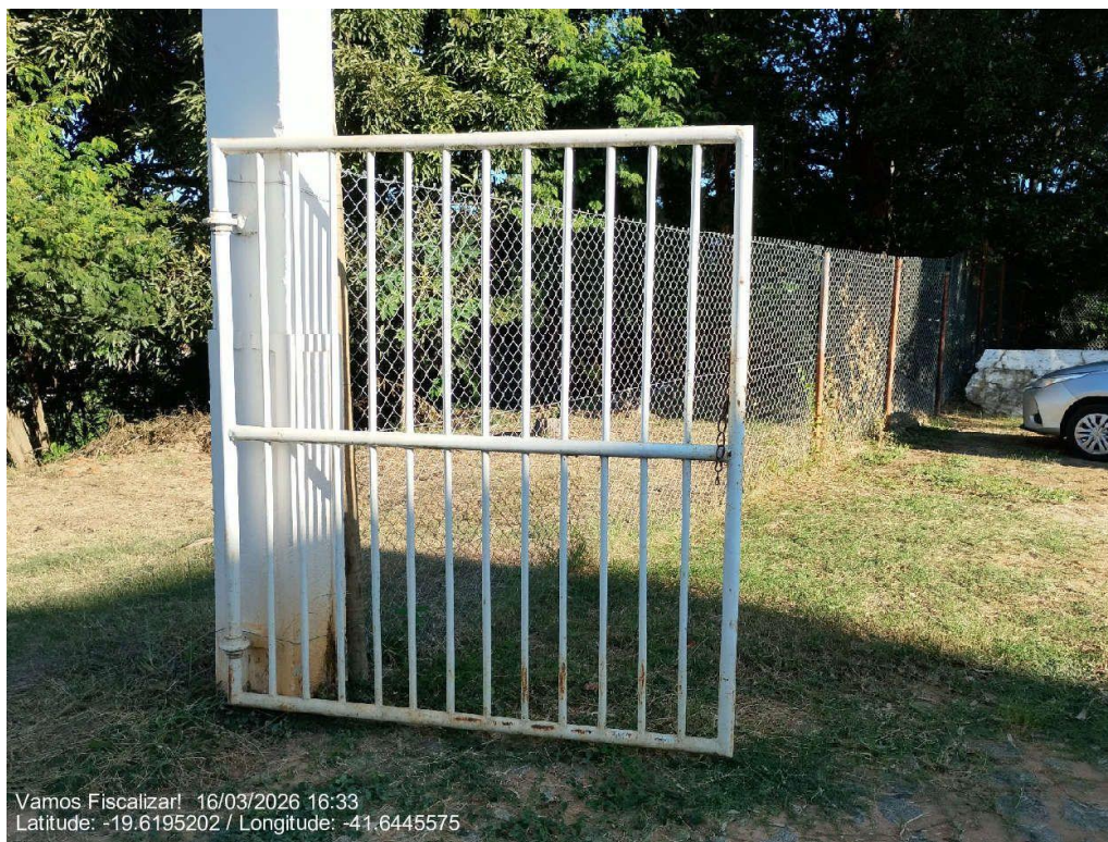
Portão da ETA com cadeado.
