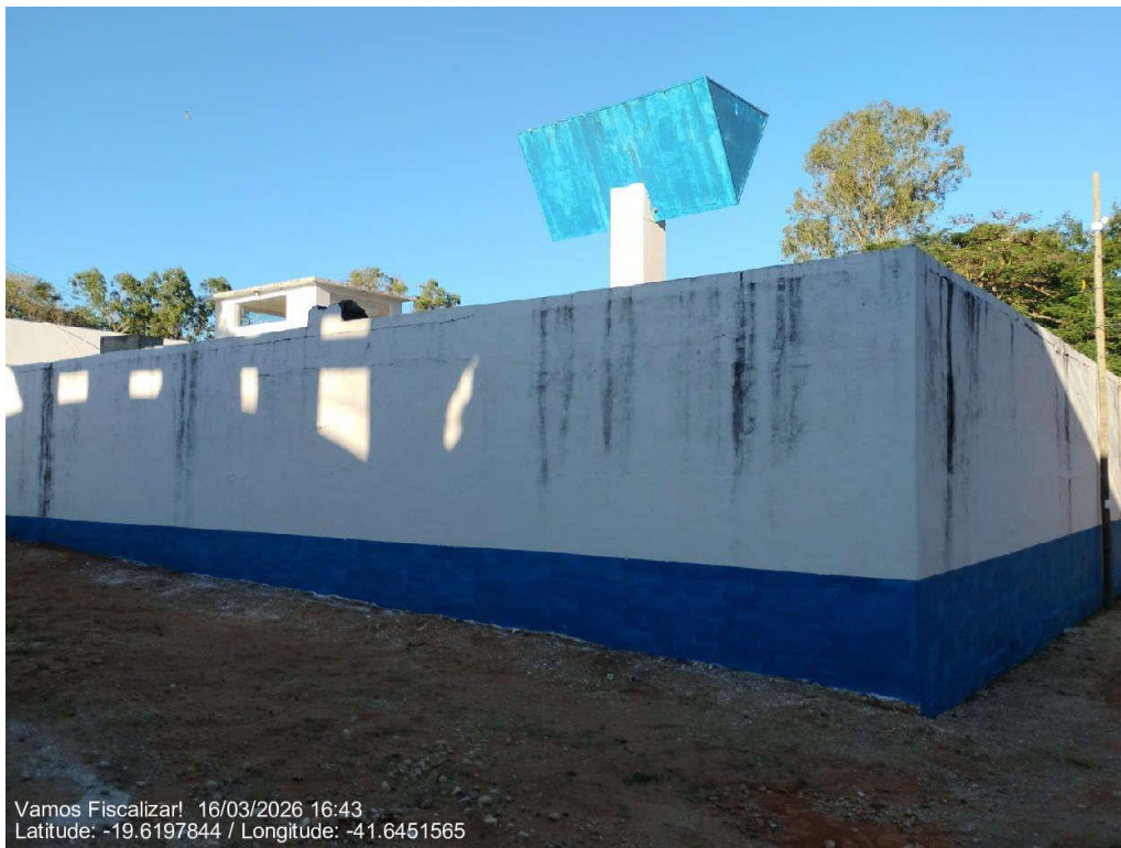
Reservatório 120m 3 da ETA Sede (DESATIVADO).
