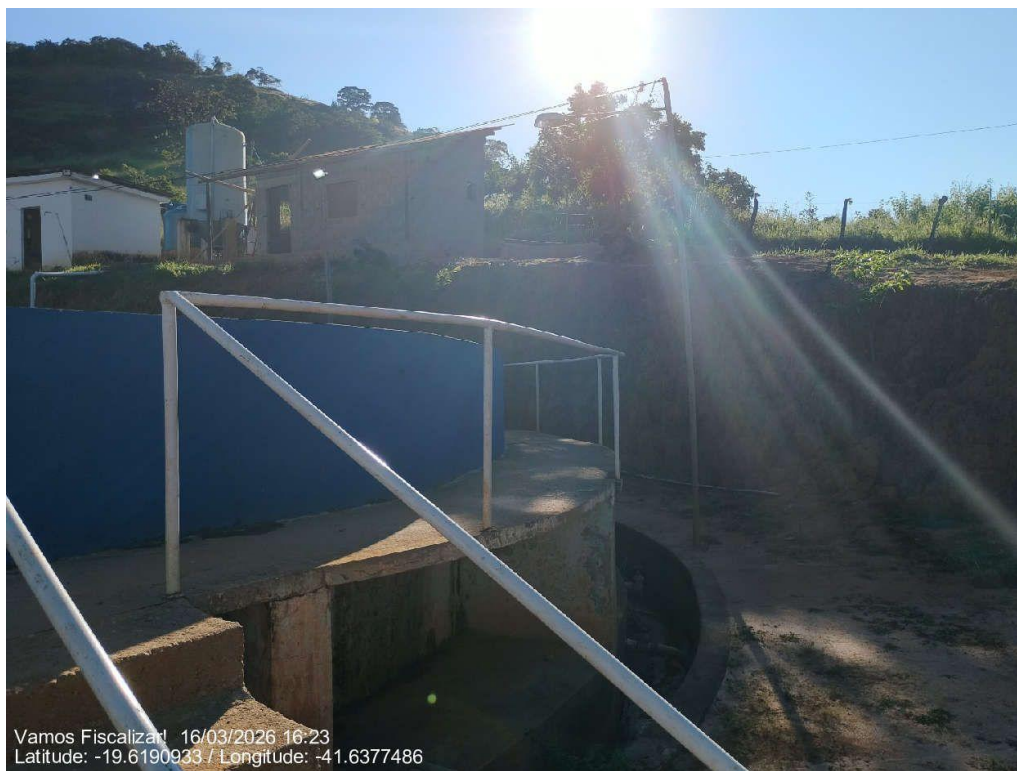
Guarda-corpo no floculador/decantador (circular)
