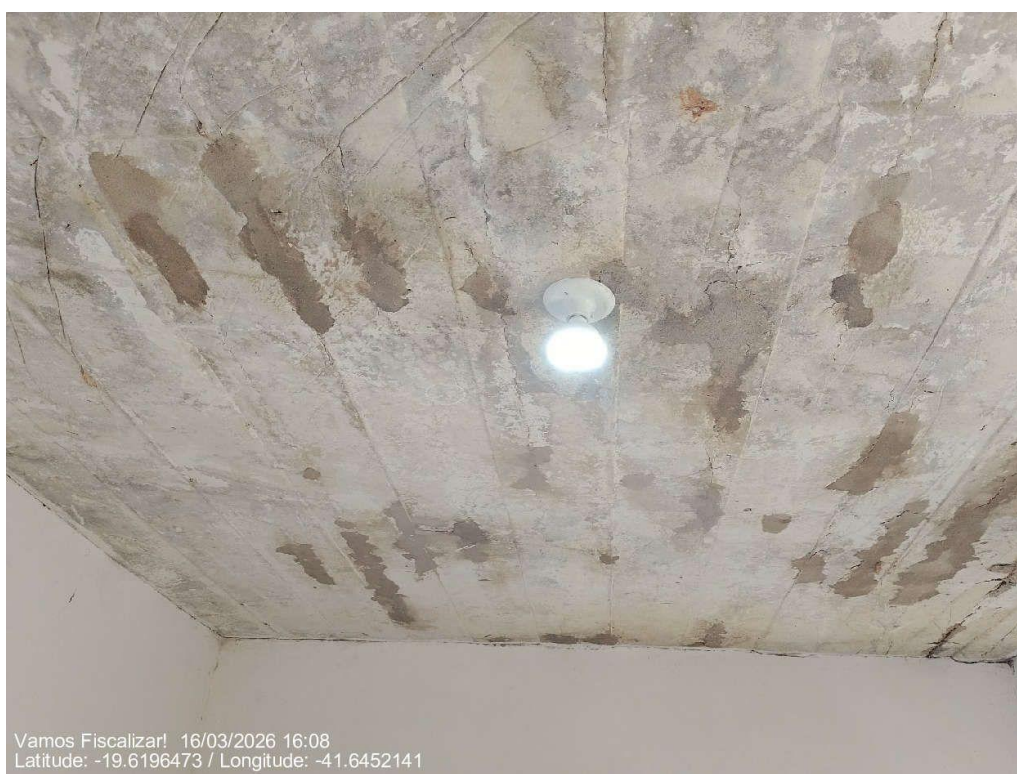
Iluminação noturna na casa de química
