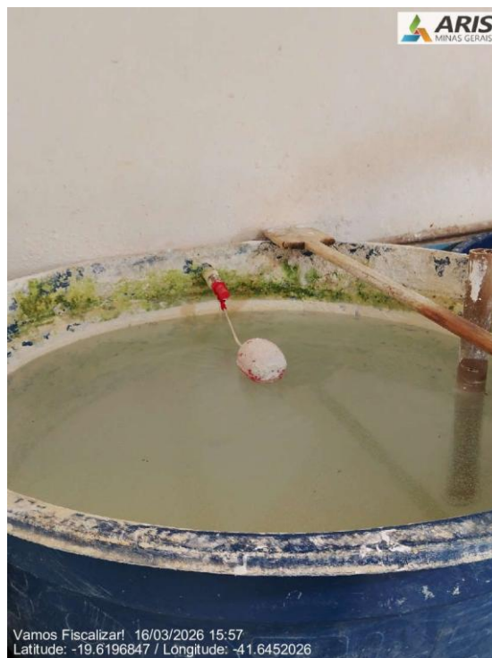
Caixa d'água onde a solução de CaO é preparada.
