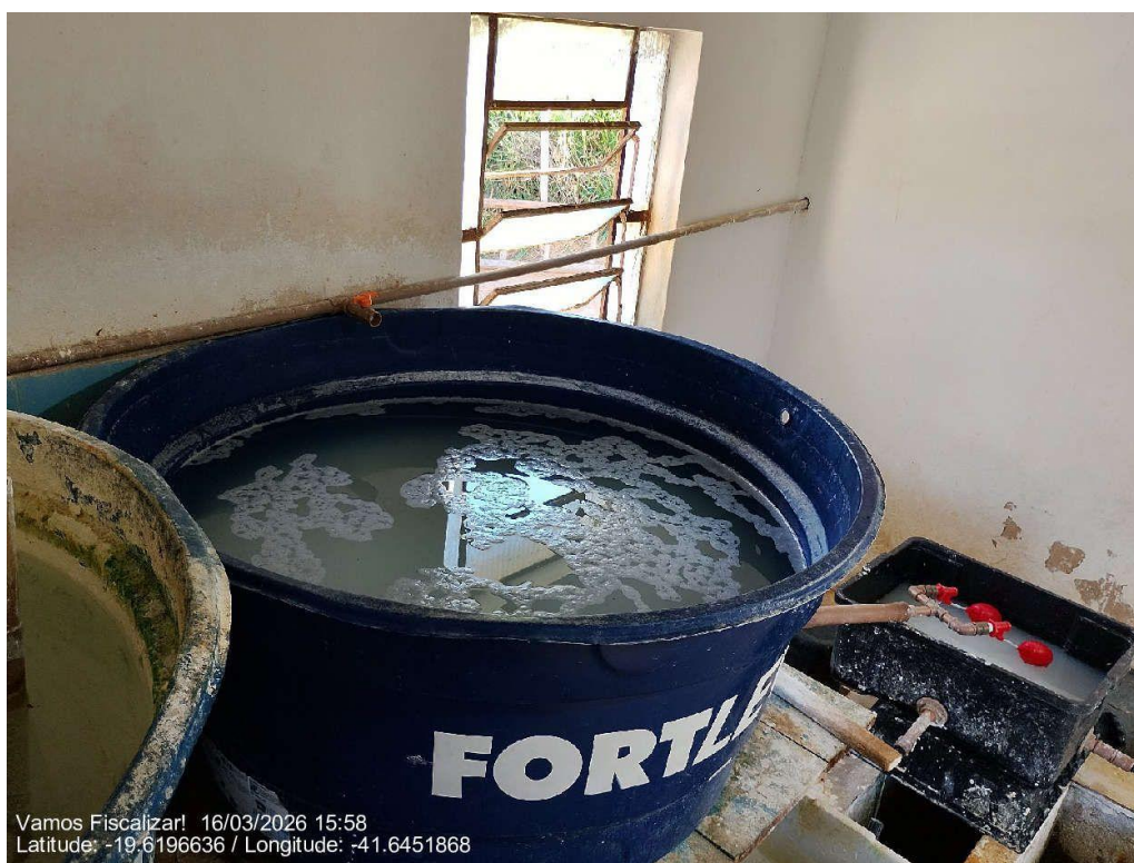
Preparo manual do sulfato para a ETA
