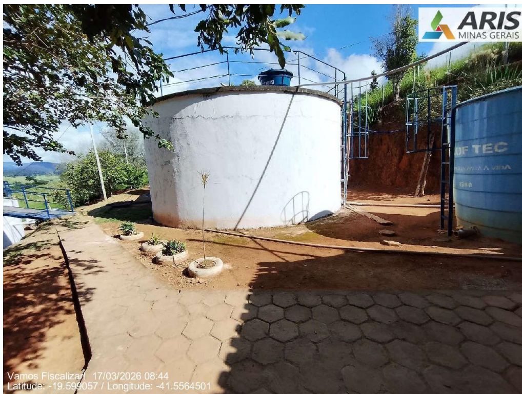
Área ao lado do tanque de contato (acima do reservatório)
