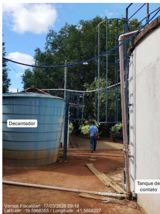
Escadas de acesso ao decantador 2 e ao tanque de contato
