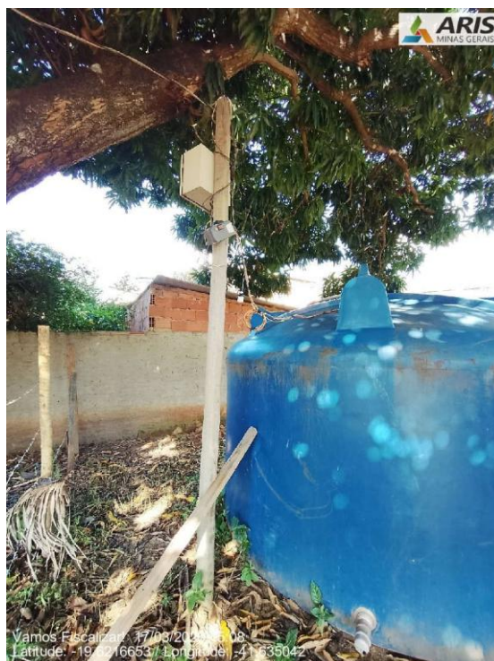
Quadro de comando está elevado e não há indícios de inundação na área.
