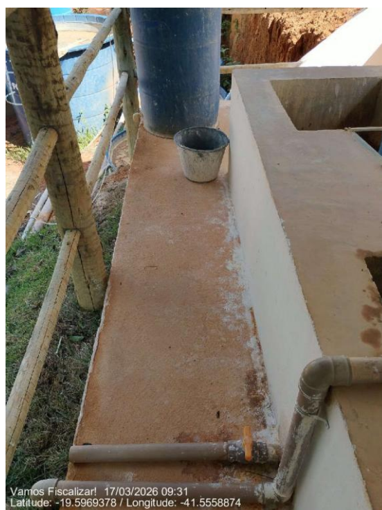
Área na entrada da água bruta
