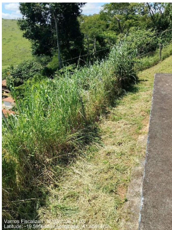
Capina realizada no entorno do reservatório
