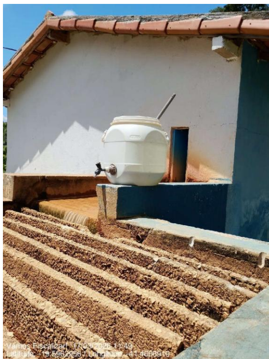
Preparo e dosagem da cal para correção do pH
