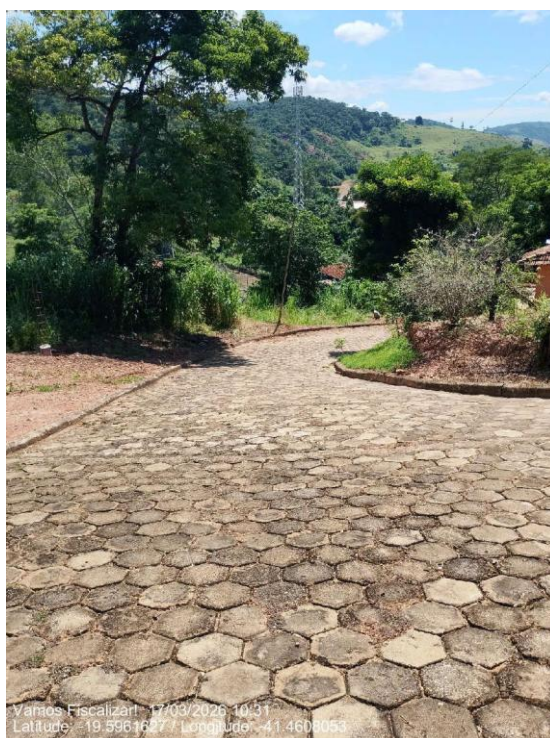
Acessos adequados à ETA
