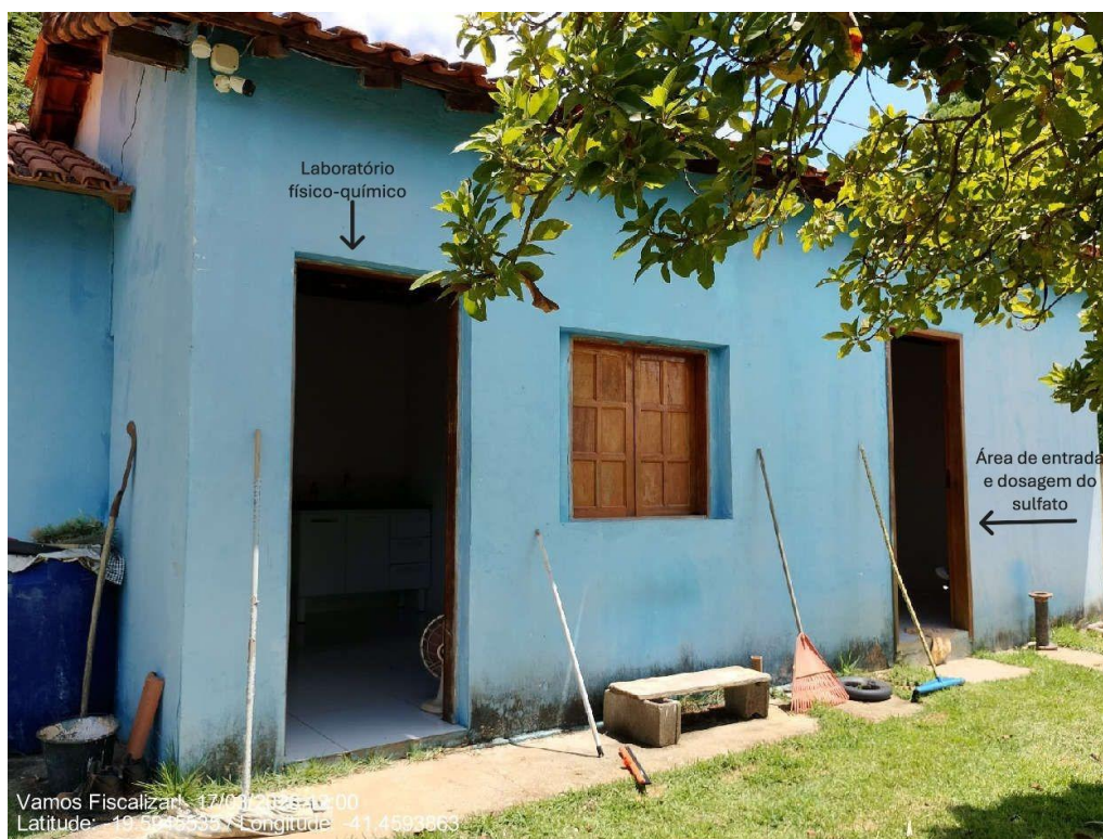
Laboratório físico-químico da ETA Assaraí
