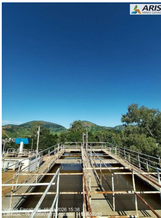
Decantador composto por 2 câmaras em operação (Retangular)
