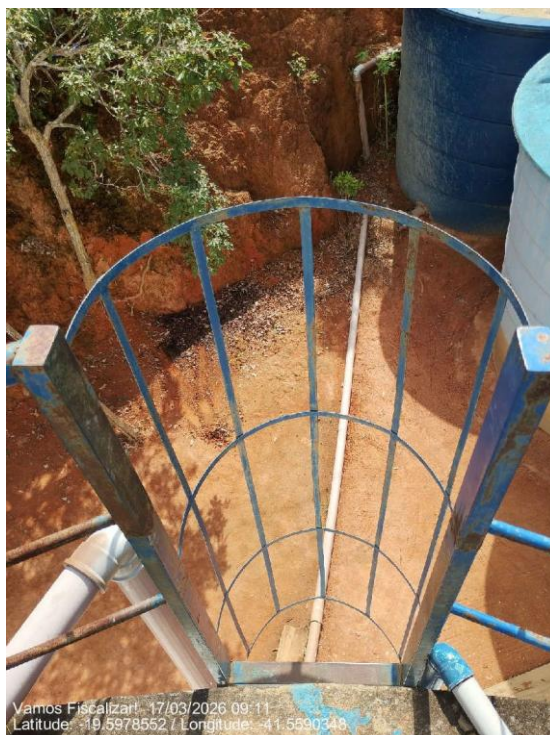
Escada com guarda-corpo
