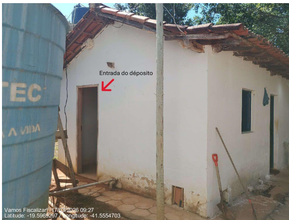
Entrada do depósito de produtos químicos
