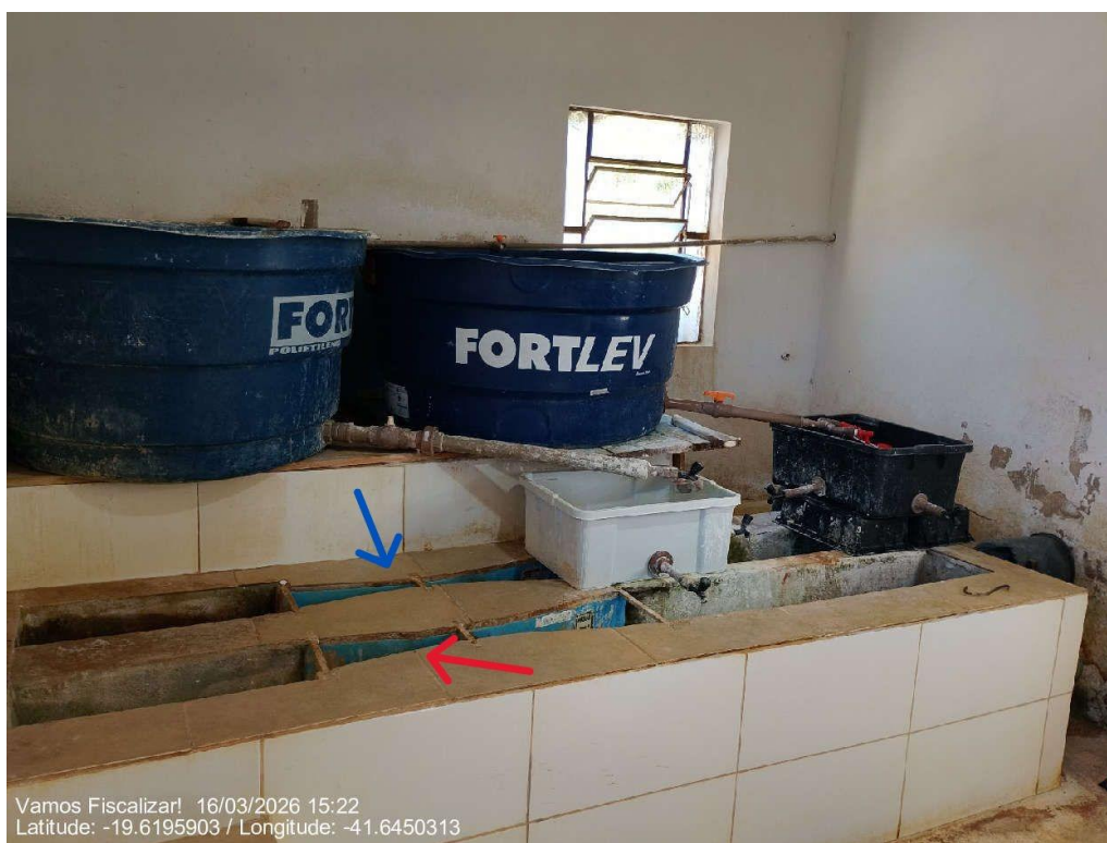
Calha parsall do tratamento físico circular (seta vermelha) e retangular (seta azul)
