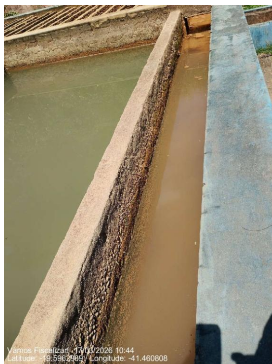
Canal de entrada do decantador
