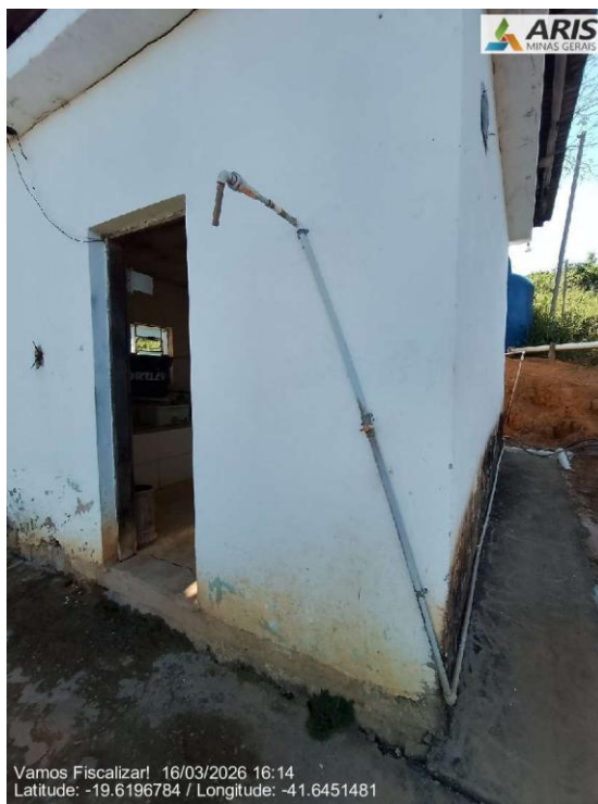
Tubulação onde anteriormente existia um chuveiro de emergência
