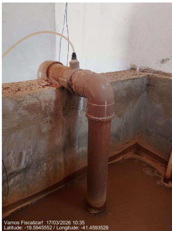
Dosagem de sulfato de alumínio na entrada do tratamento
