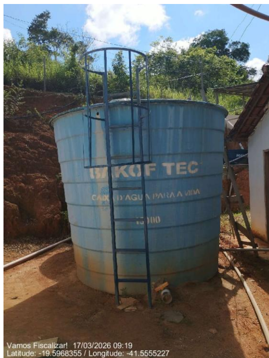
Escada no decantador 2 em bom estado de conservação
