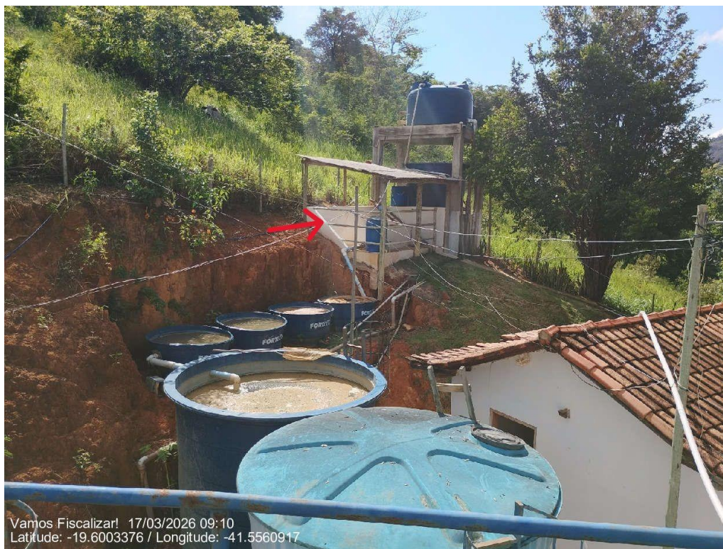
Guarda corpo em madeira em boas condições na estrutura de entrada da água bruta
