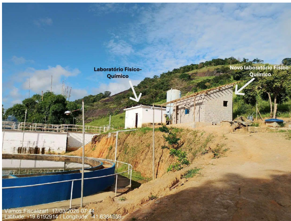
Laboratório físico-químico das ETA Pocrane em operação e a nova unidade em construção
