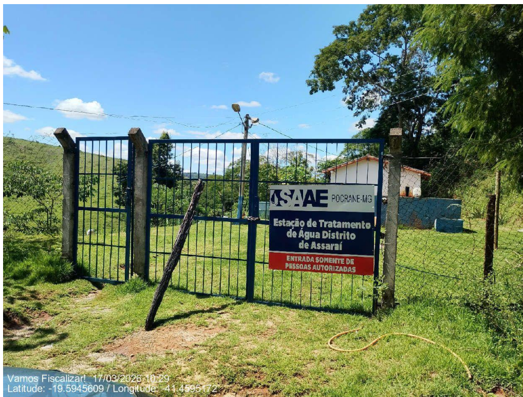
Placa de identificação da ETA
