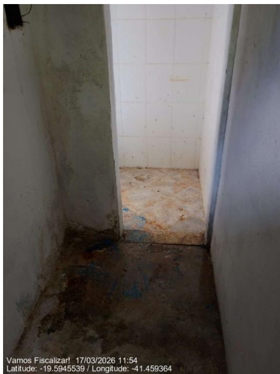
Porta de acesso ao depósito
