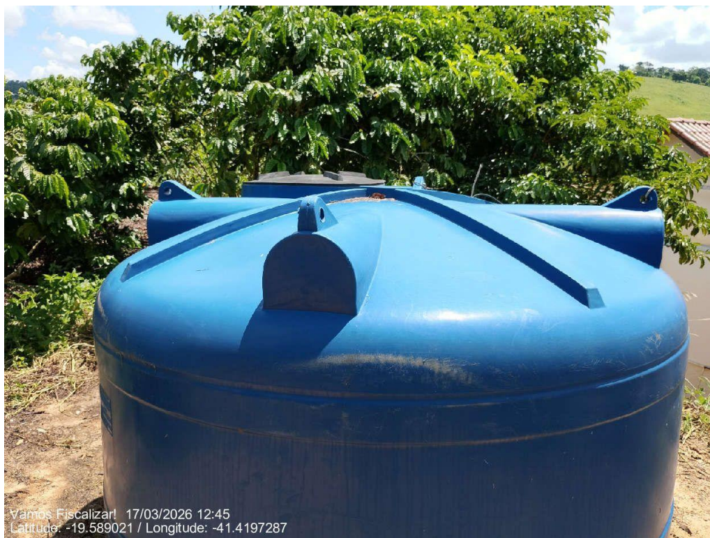
Reservatório com altura inferior a 2 metros.
