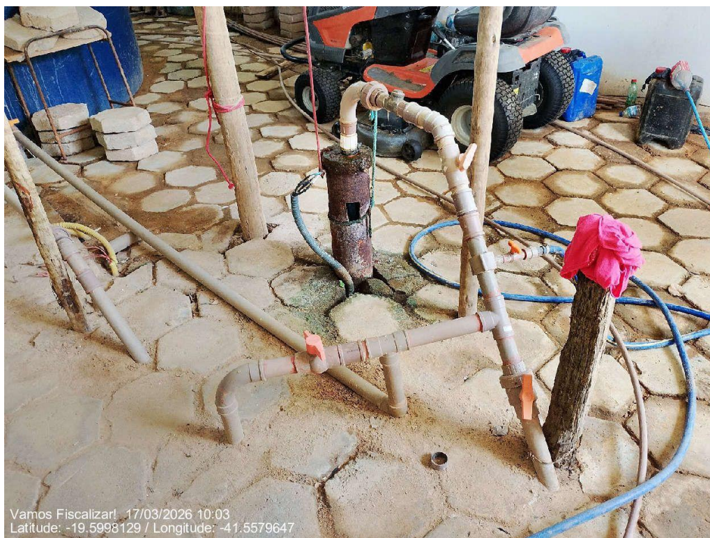
Conservação da área.
