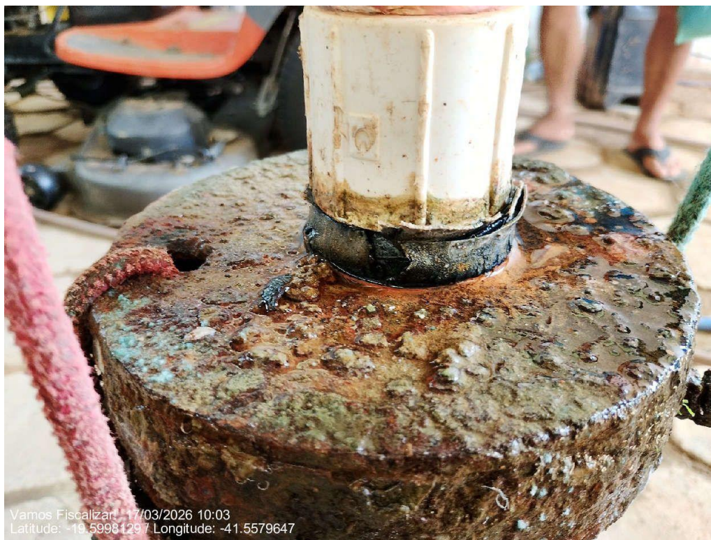
Ausência de vedação.
