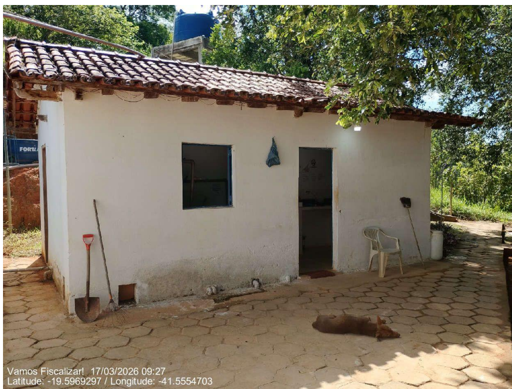
Entorno da ETA
