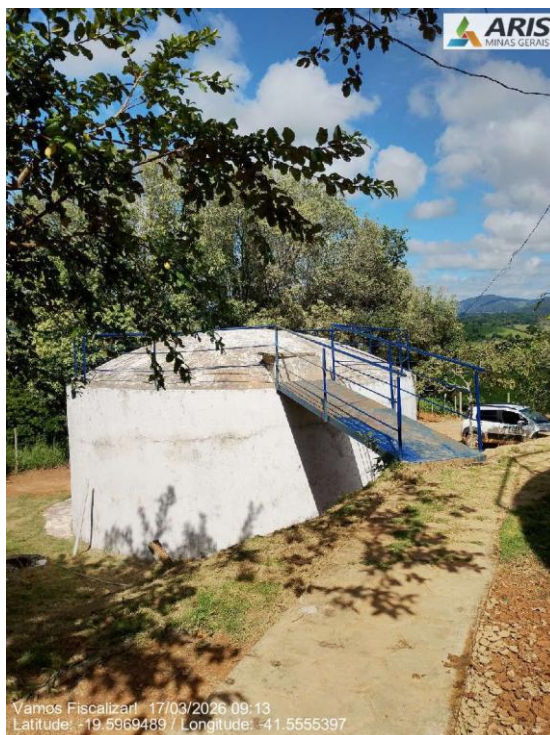
Guarda-corpo no acesso à cobertura do reservatório
