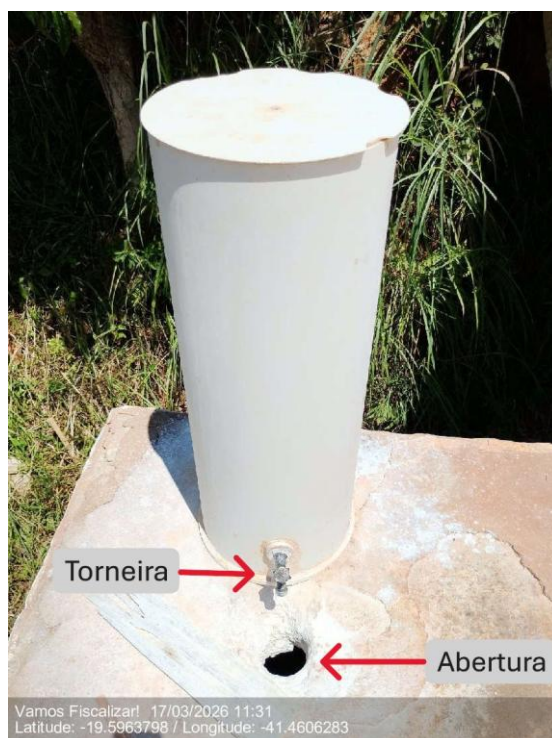
Destaque para torneira e abertura para aplicação do cloro
