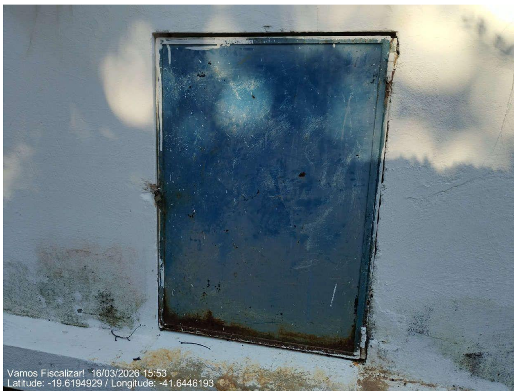
Tampa de inspeção da estrutura de reservação I, câmara 2 (reservatório de distribuição).
