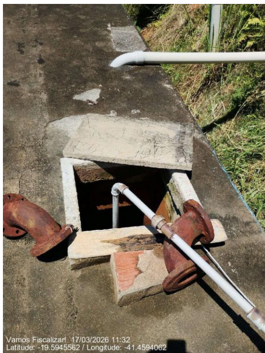
Tampa de inspeção de concreto em boas condições
