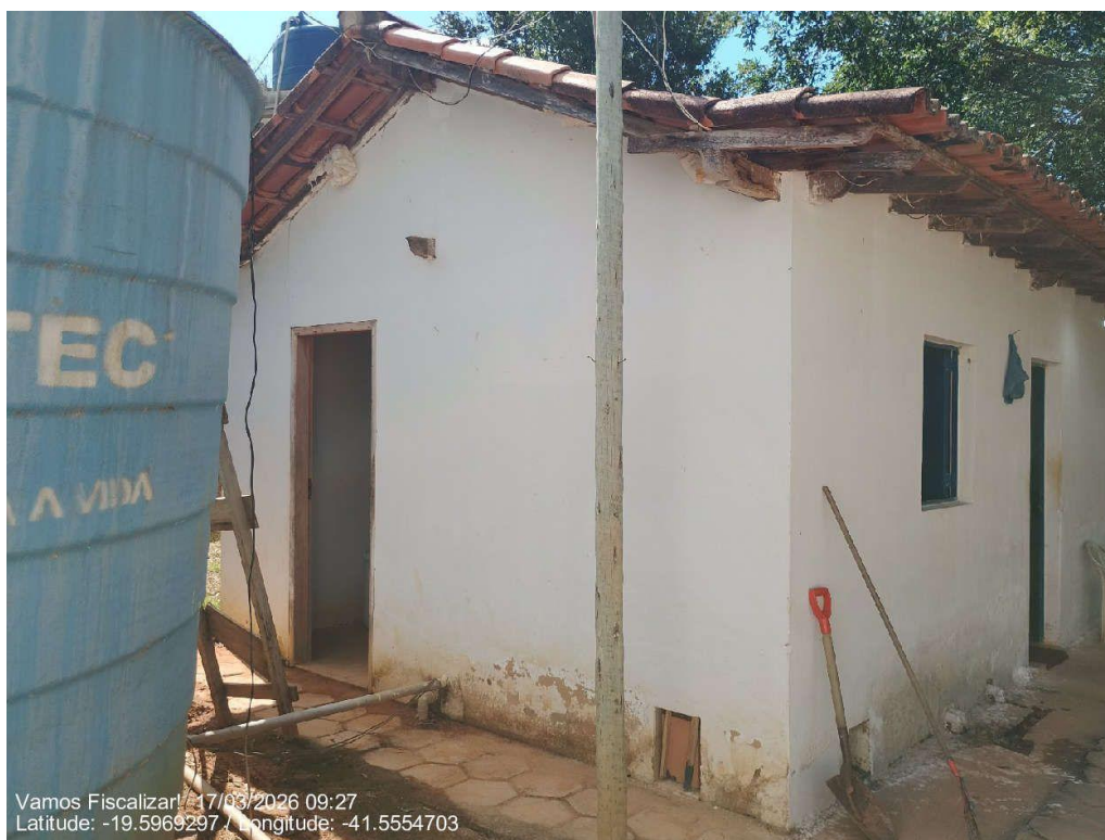
Estruturas em bom estado de conservação
