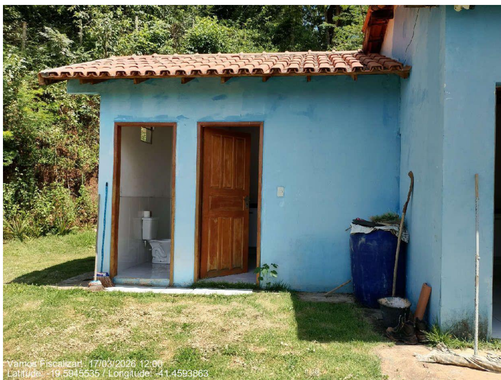
Laboratório físico-químico da ETA Assaraí (banheiros)
