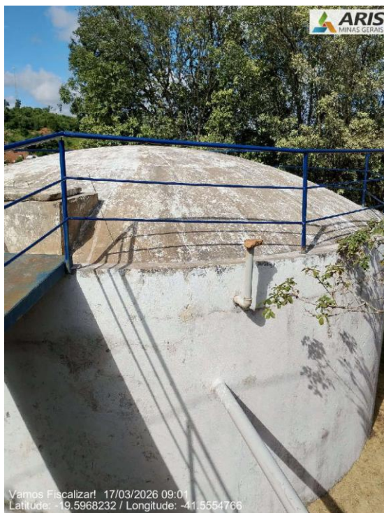
Reservatório em bom estado de conservação
