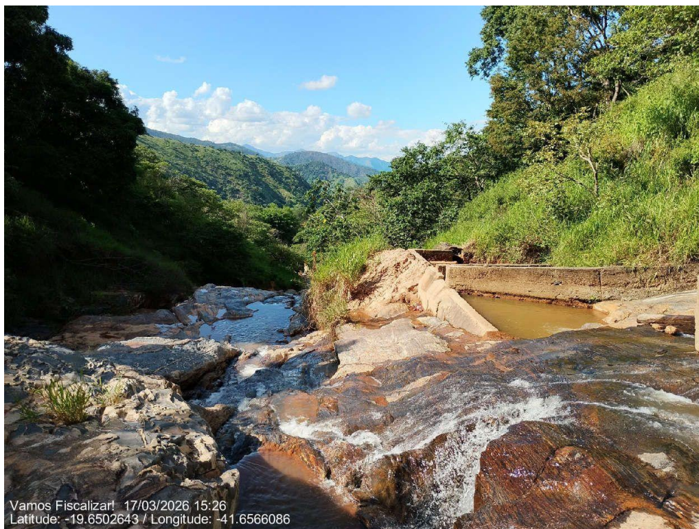
Captação Superficial Cachoeira da Geenita.
