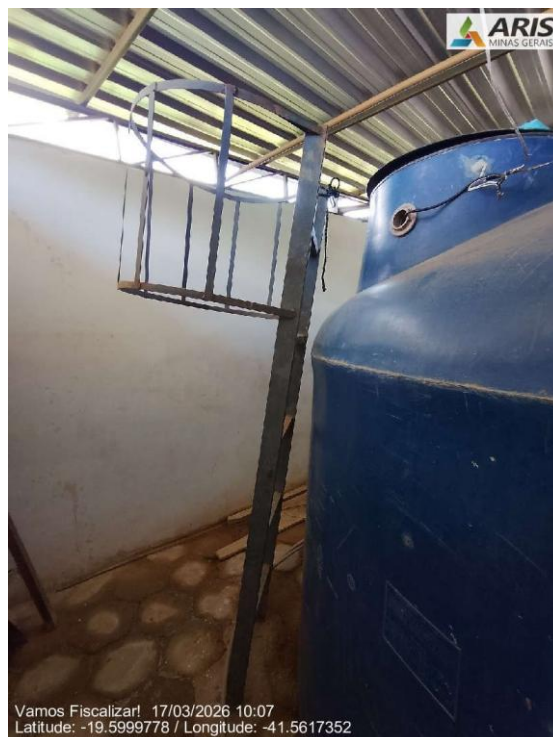
Possui escada de acesso à tampa da caixa d'água.
