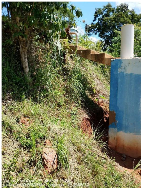
Escada de acesso da ETA à cobertura do reservatório
