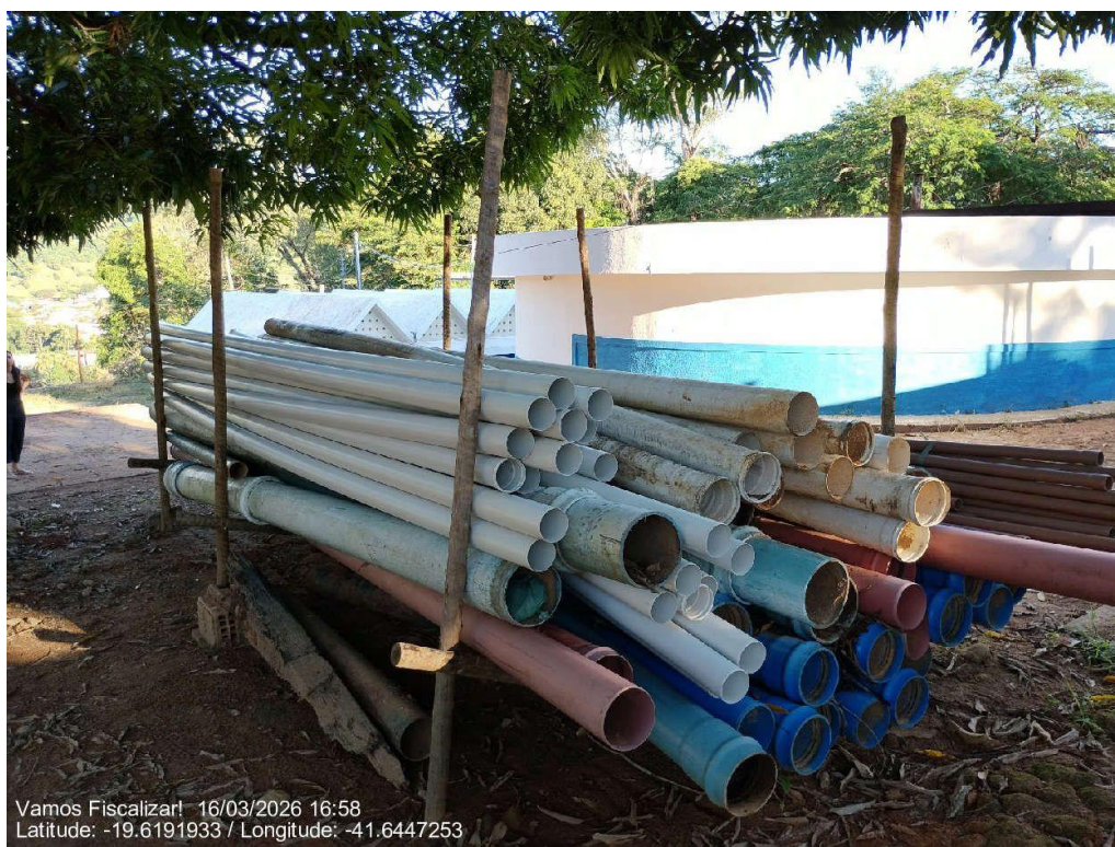
Tubulações armazenamento na área da ETA Sede
