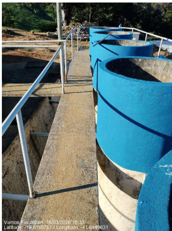
Guarda-corpo nos filtros (circular)
