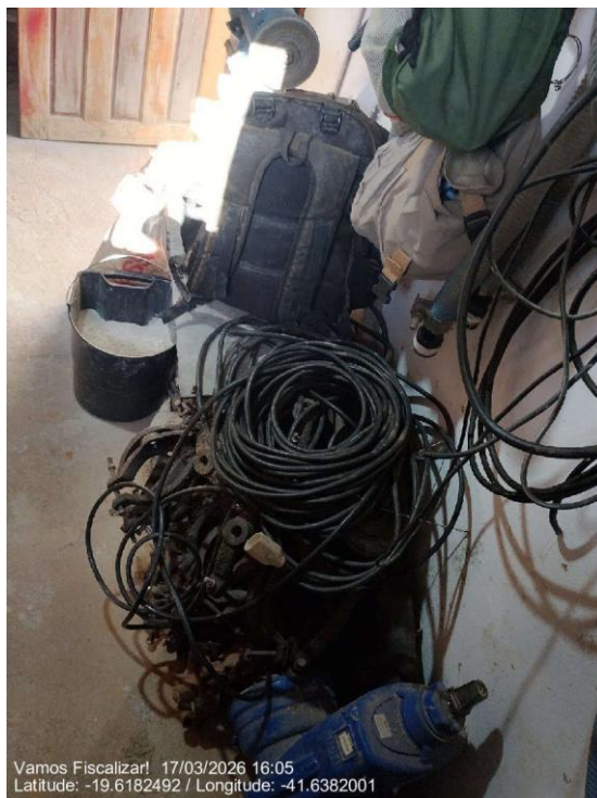
Materiais dispostos no corredor de circulação
