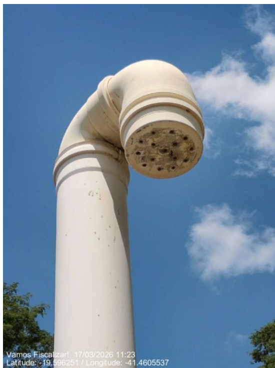
Proteção da abertura da primeira tubulação
