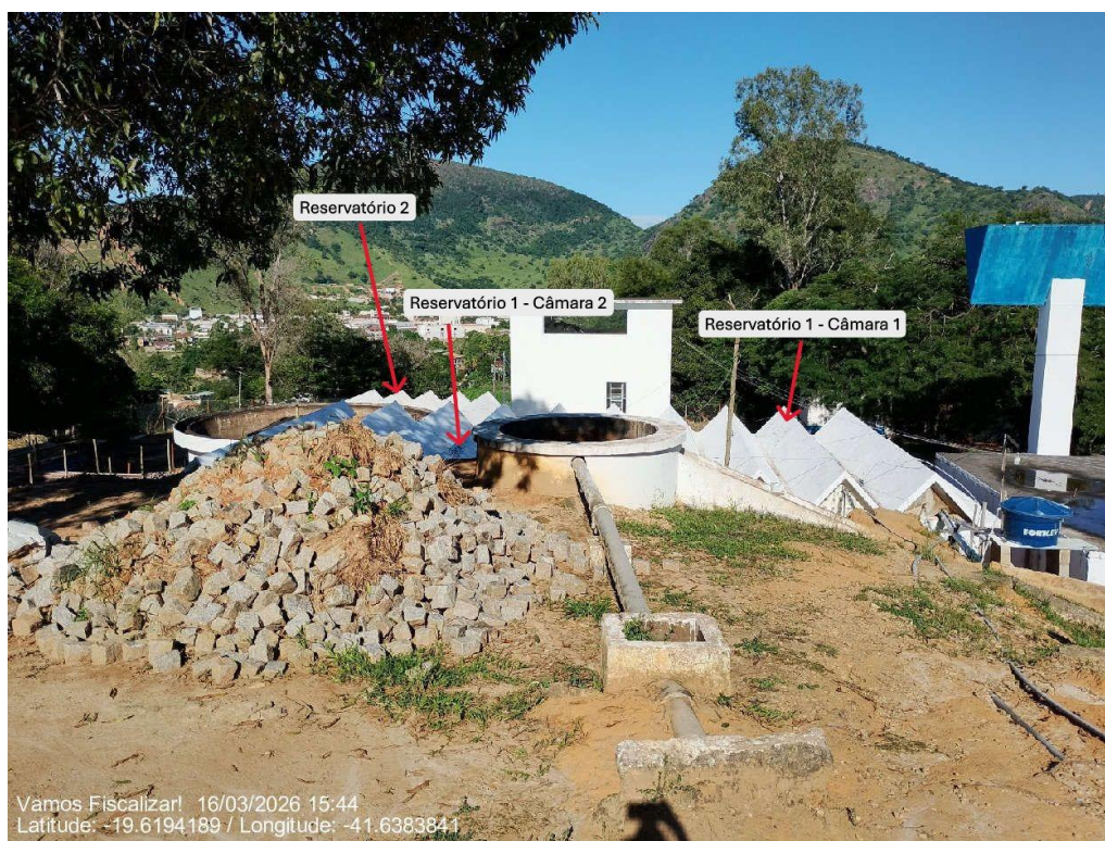
Localização dos reservatórios na ETA.
