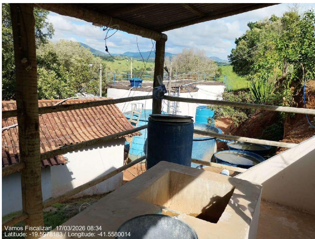
Vista Geral da ETA Barra da Figueira
