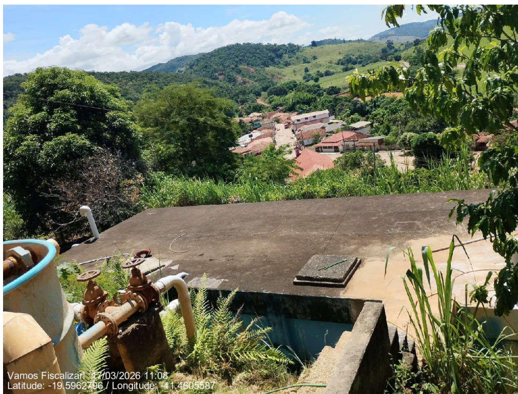
Reservatório ETA Assaraí
