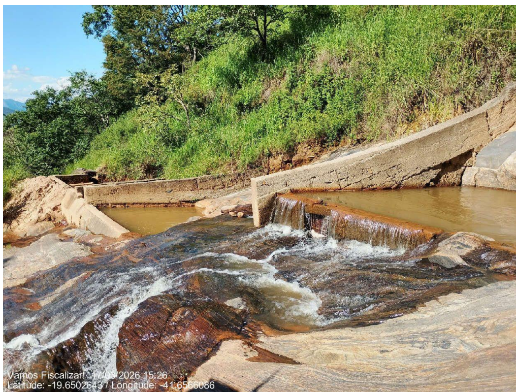
Captação Superficial Cachoeira da Geenita.
