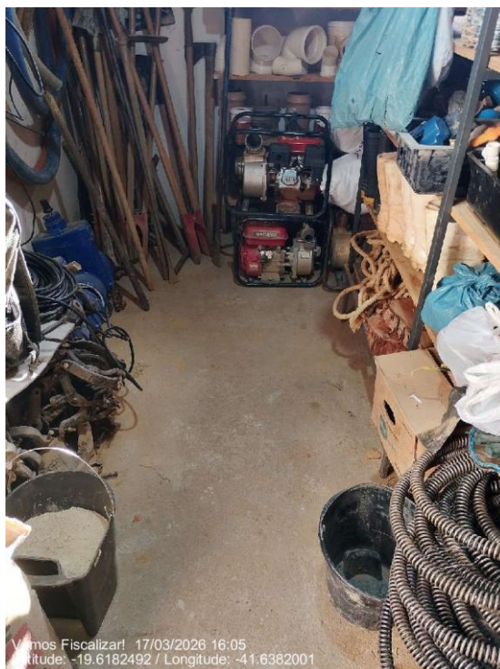
Materiais dispostos no corredor de circulação
