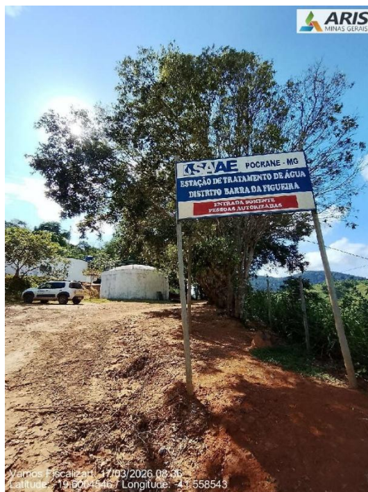
Placa de identificação não apresenta a informação da capacidade dos reservatórios
