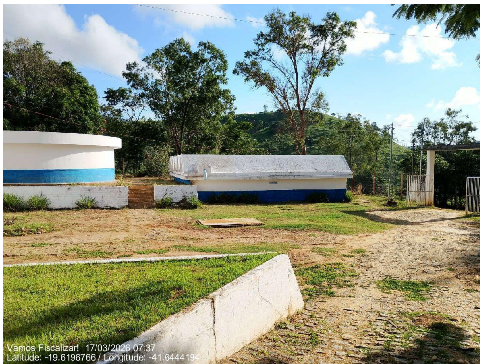
Ausência de dispositivo de indicador de nível de água.
