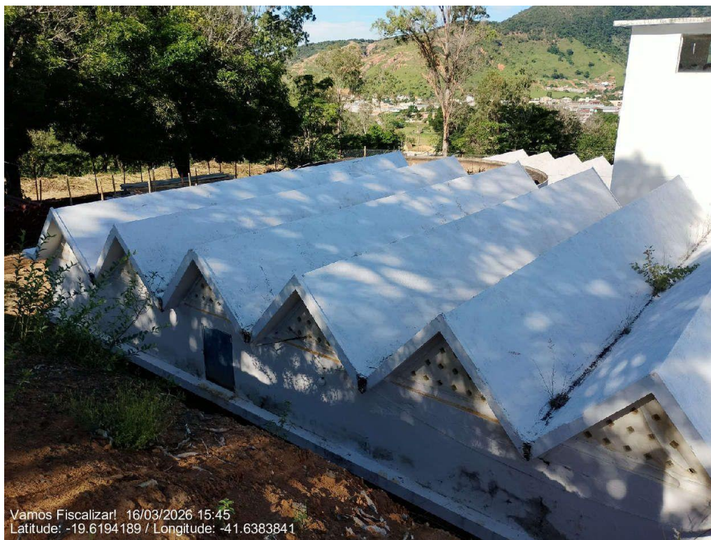
Estrutura de reservação I - câmara 2 (reservatório de distribuição).
