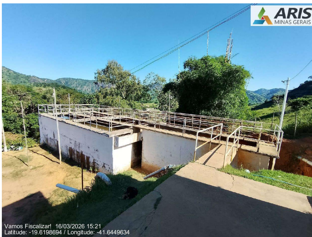
Tratamento físico (floculador e decantador) retangular
