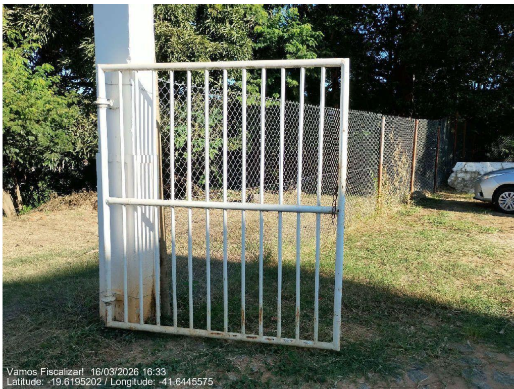
Portão da entrada
