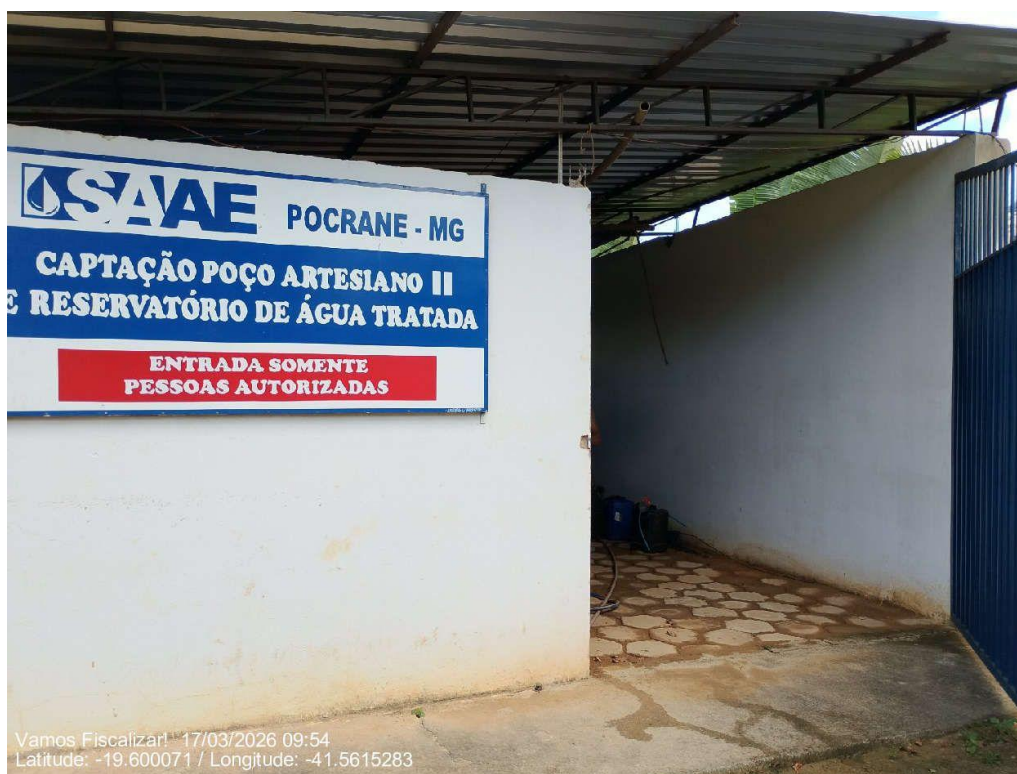
Cercamento da captação.
