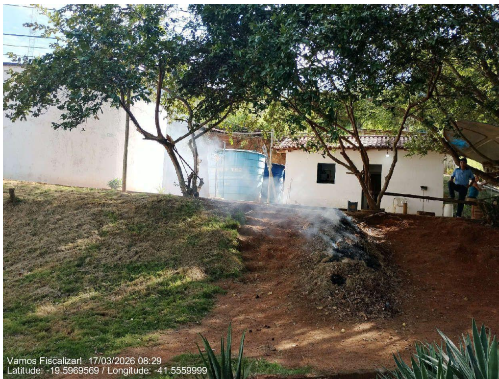
Vista Geral da ETA Barra da Figueira
