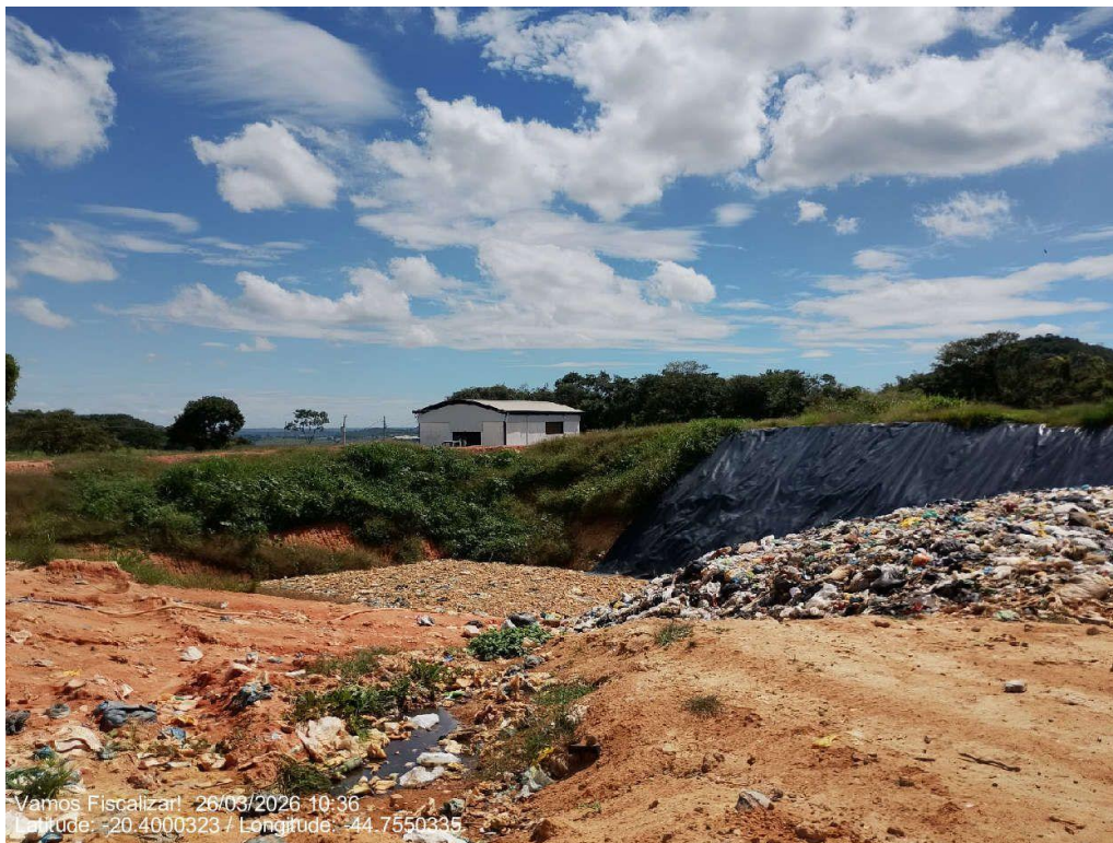
Aterro Sanitário Municipal.
