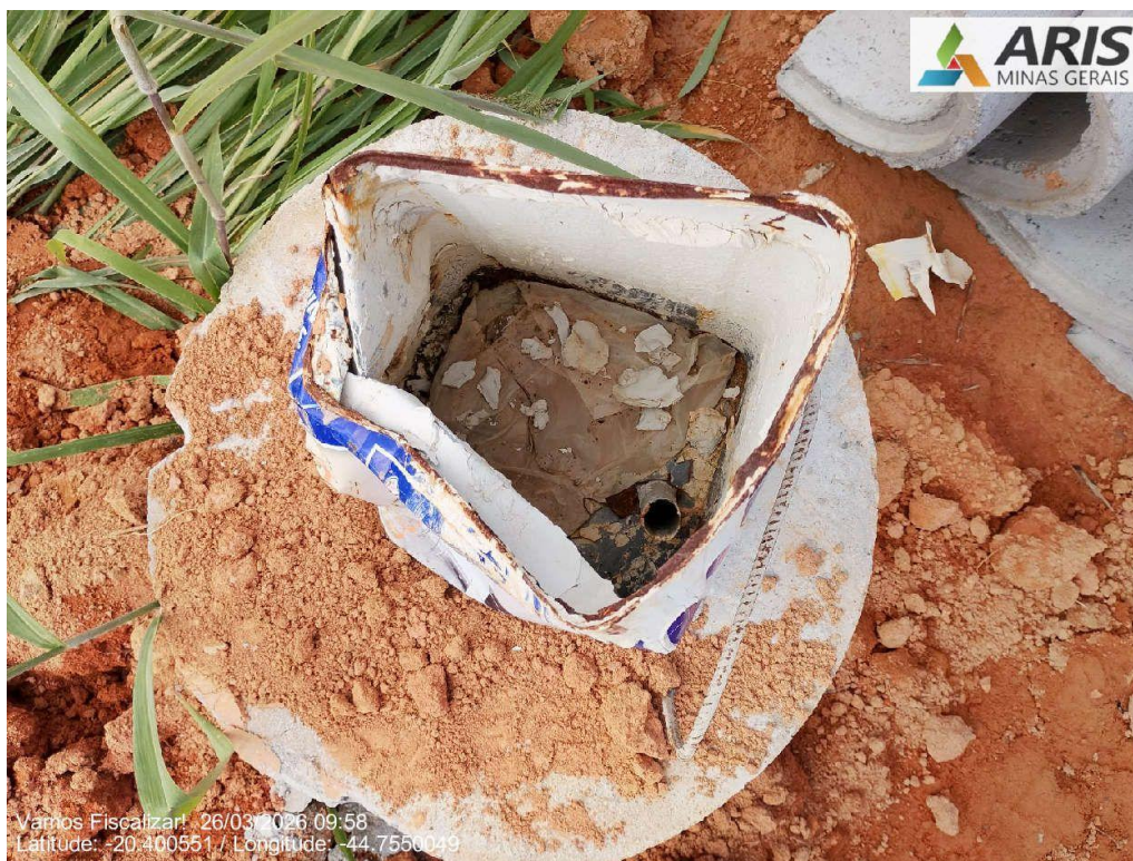
Vista superior do dreno de gás localizado na célula 01.
