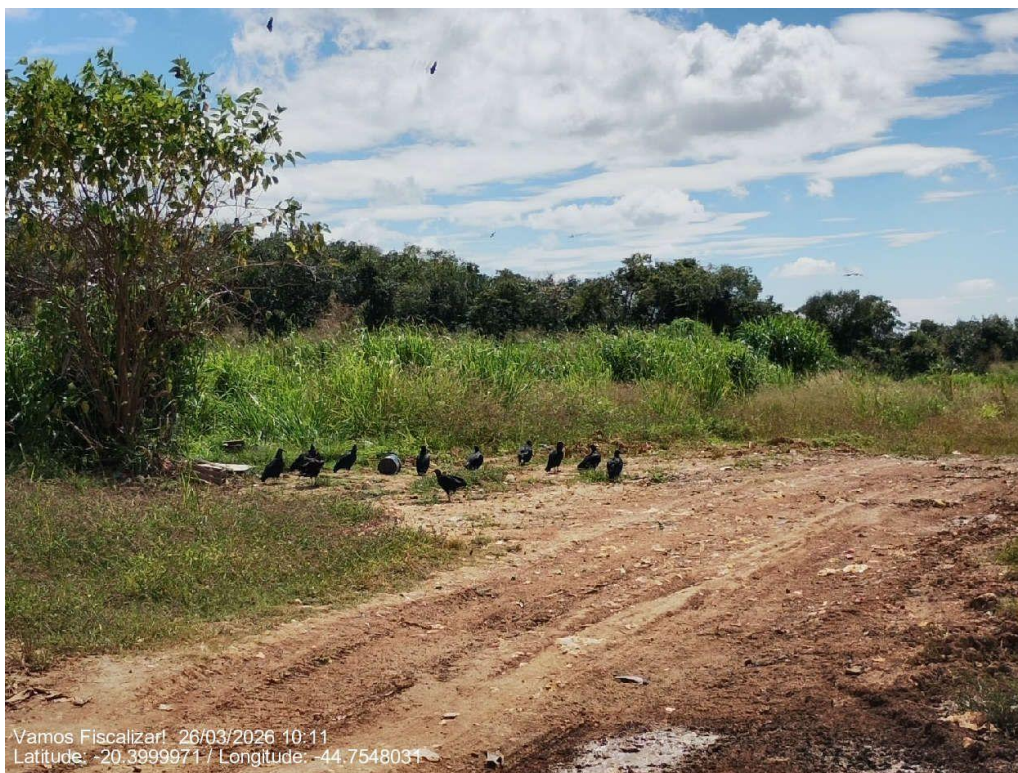
Presença de animais dentro da área de operação do aterro.
