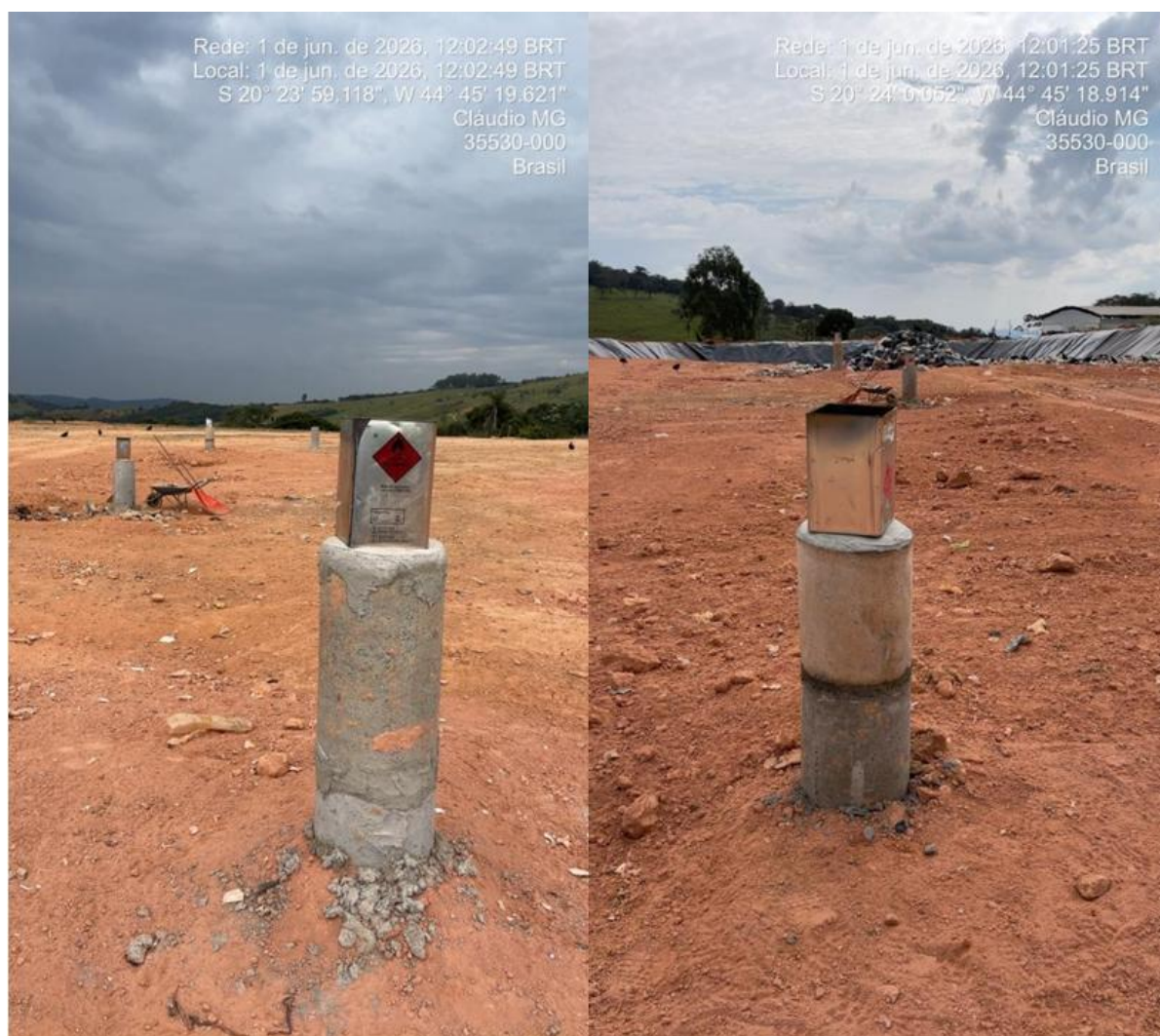
Sistema flare instalado nos drenos verticais (imagem enviada durante RMA).
