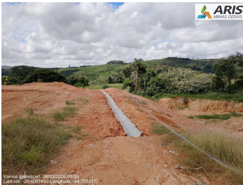
Início da instalação da drenagem pluvial.
