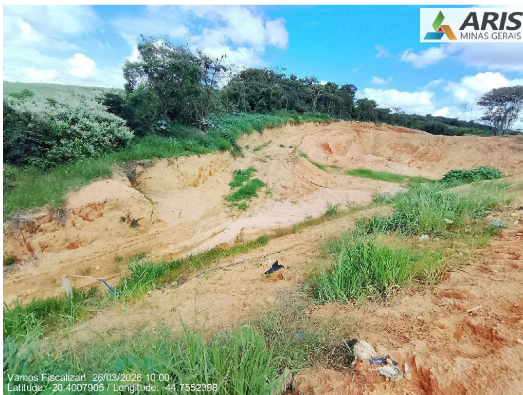
Vegetação arbórea ao redor da instalação.
