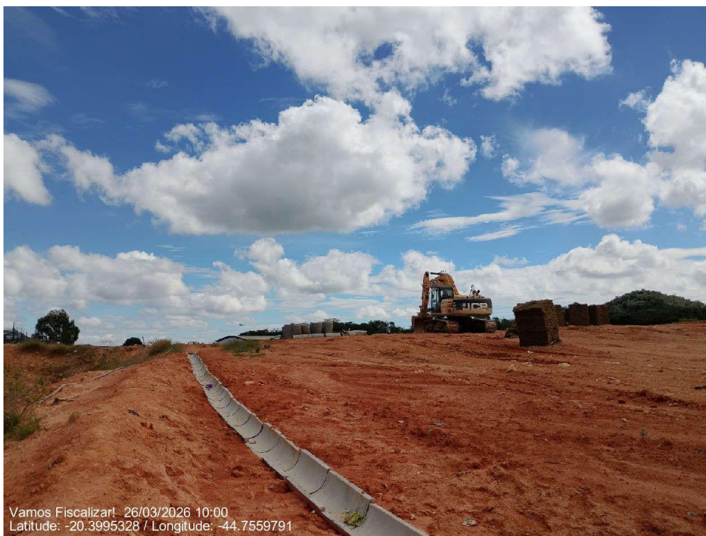
Aterro Sanitário Municipal.
