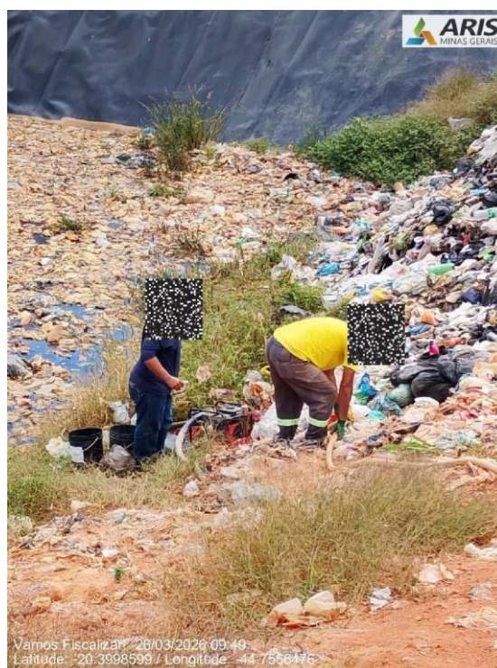
Operadores utilizando bomba para retirar o chorume que está acumulado, devido a problemas no sistema de drenagem.
