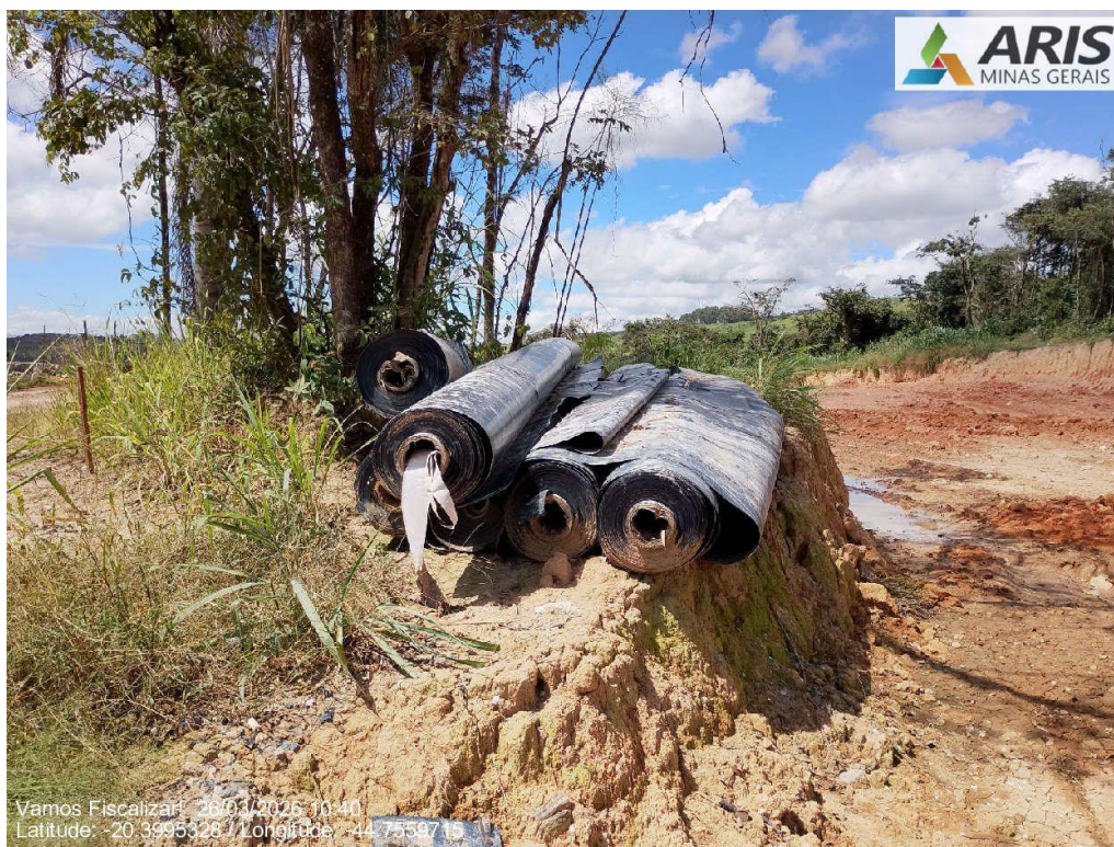
Geomembrana para complementar a impermeabilização da célula 02.
