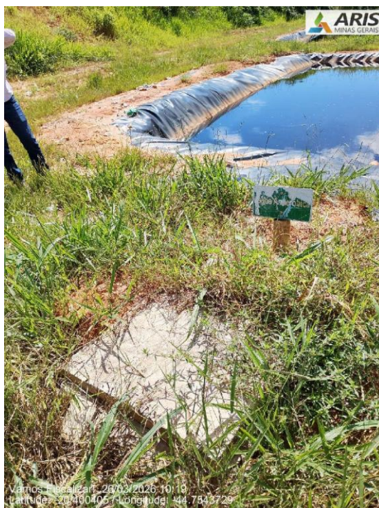
Caixa de passagem antes do lixiviado chegar no sistema de tratamento.
