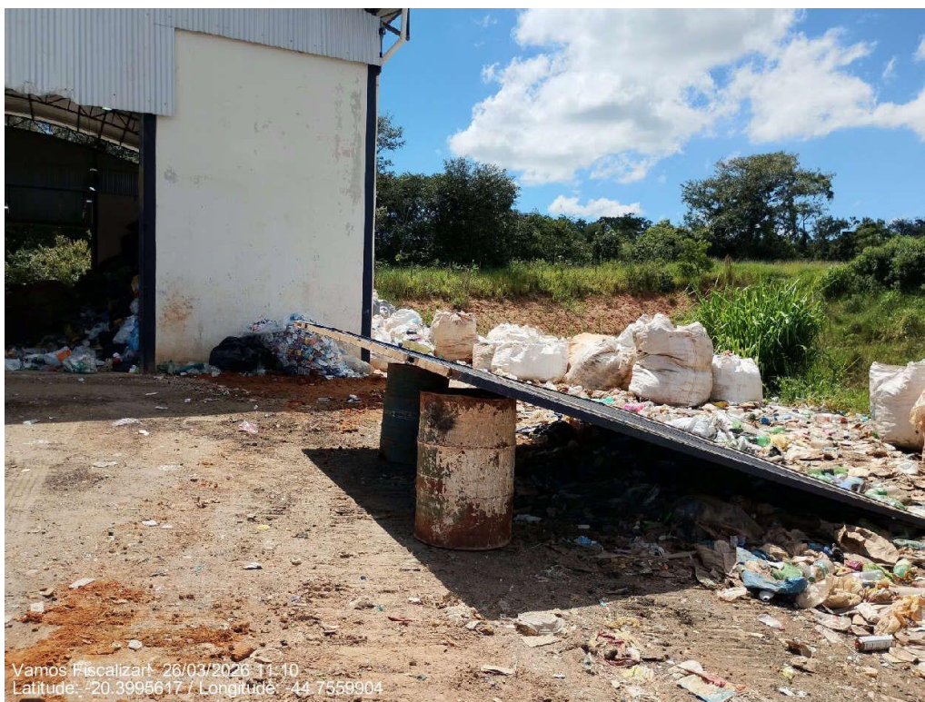
Portão de acesso retirado para manutenção.
