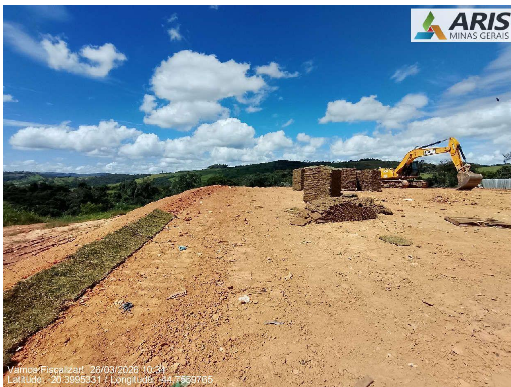
Início da cobertura final da célula 01 encerrada.
