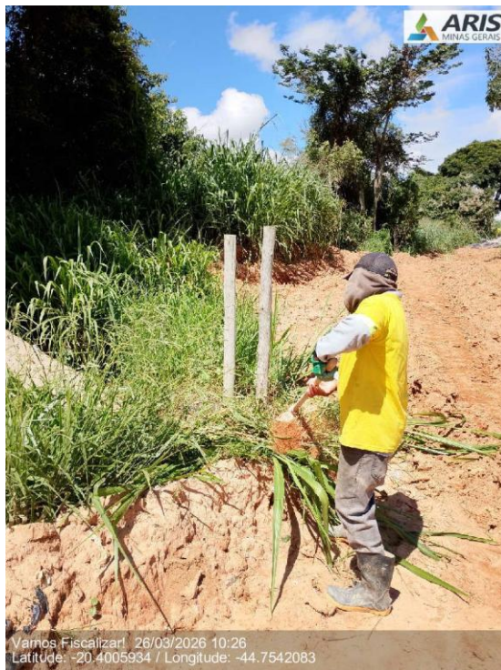
Localização do poço de monitoramento.
