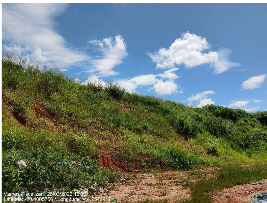
Área 2 antigo, aterro controlado.
