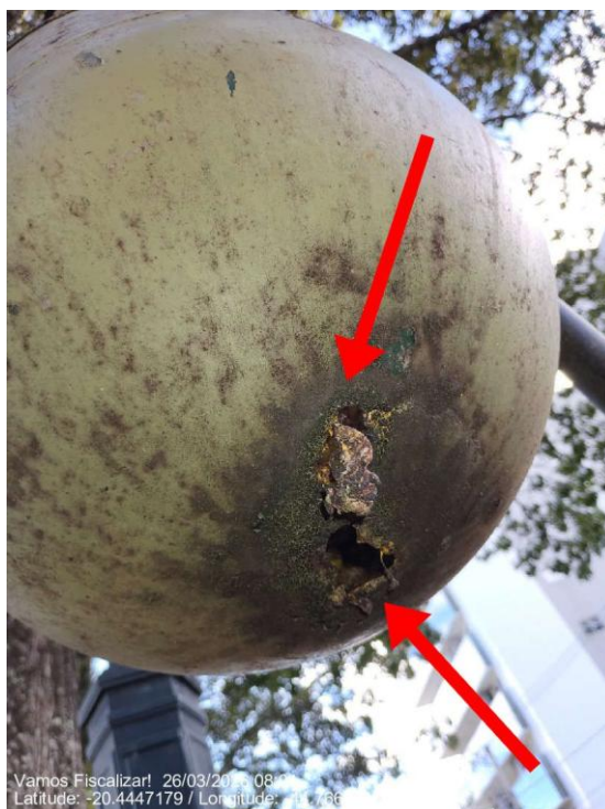
Fundo da lixeira em más condições.
