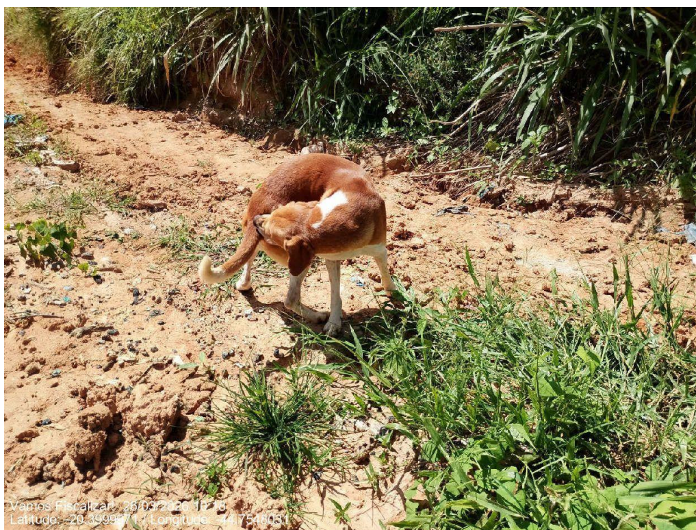
Presença de animais dentro da área de operação do aterro.
