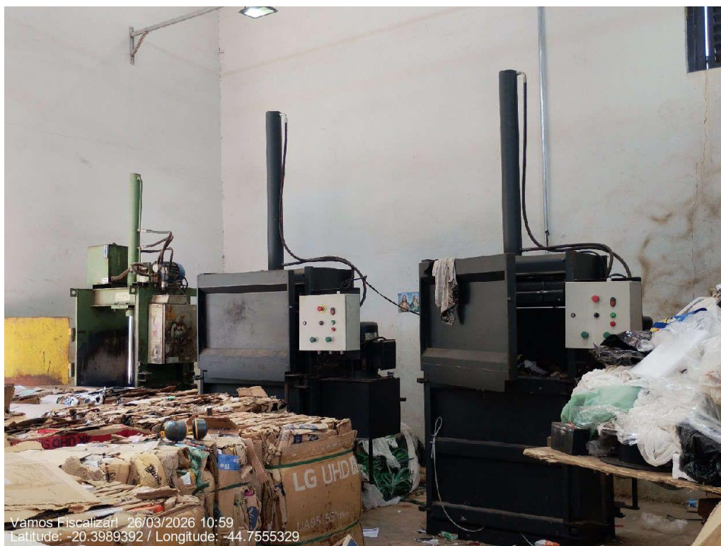
Prensas em boas condições de operação.
