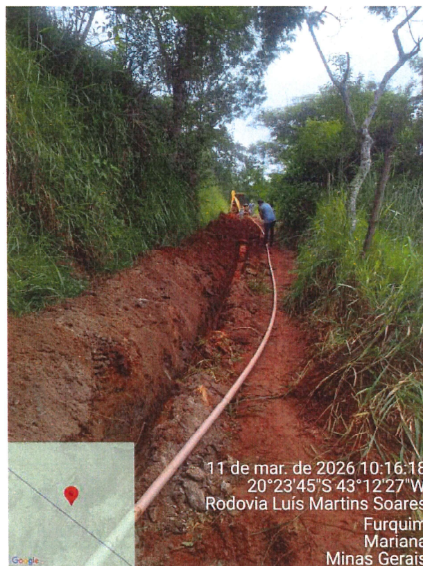
Fotos 3, 4, 5 e 6: Execução de serviço de instalação de rede adutora e de distribuição de água potável no Subdistrito de Margarida Viana
