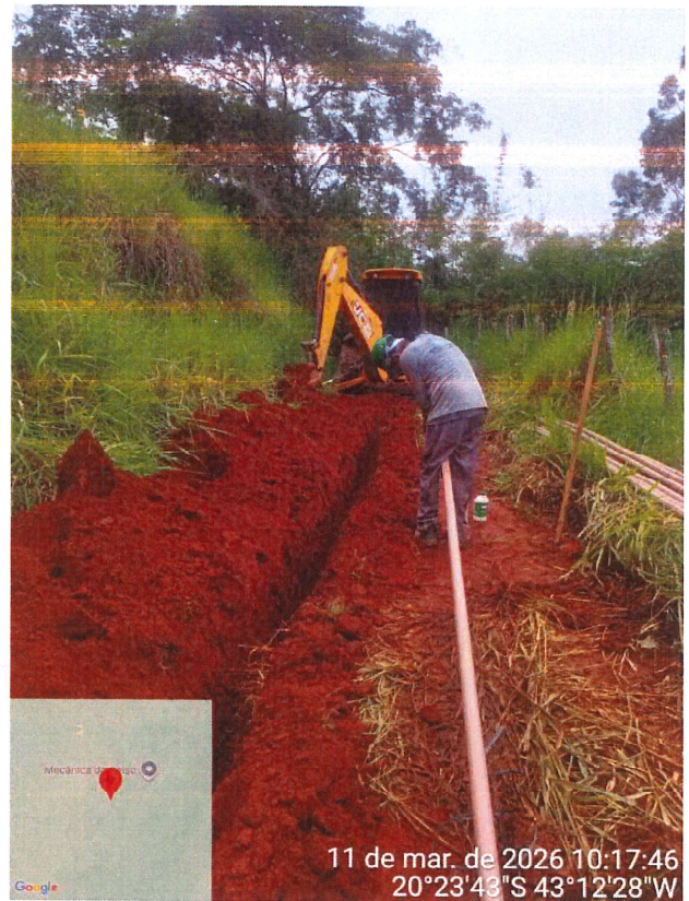
Fotos 7 e 8: Execução de serviço de instalação de rede adutora e de distribuição de água potável no Subdistrito de Margarida Viana
