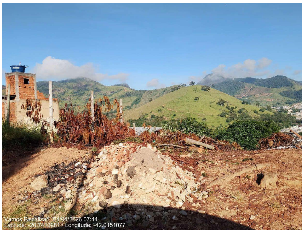
Ponto de disposição inadequada de RCC
