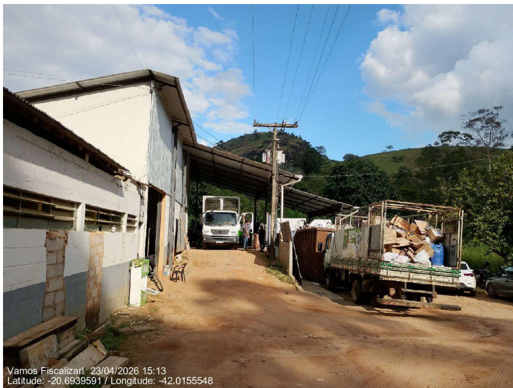
Vista geral da unidade
