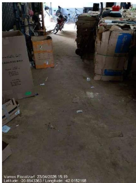
Piso impermeável na área de prensagem e depósito dos materiais
