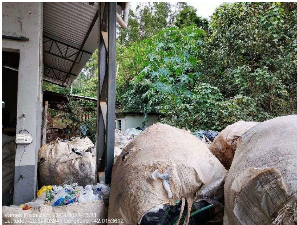
Bags com materiais separados dispostos em área sem cobertura
