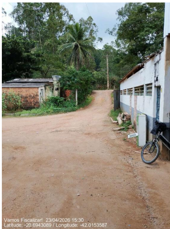
Acesso ao pátio de manobra da unidade
