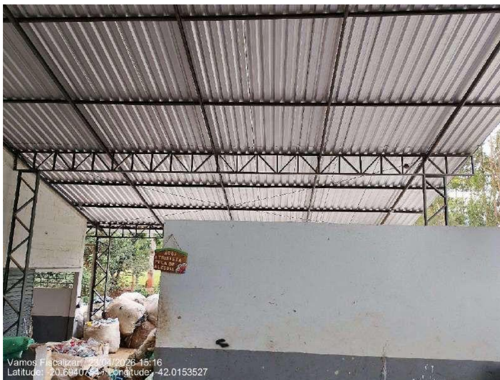
Cobertura na área de recebimento dos resíduos (entrada dos caminhões da coleta)
