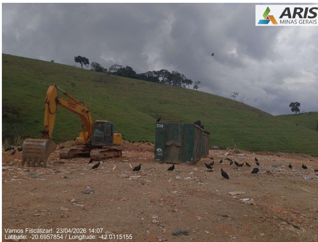
Retroescavadeira utilizada para colocar os resíduos dentro dos contêineres.
