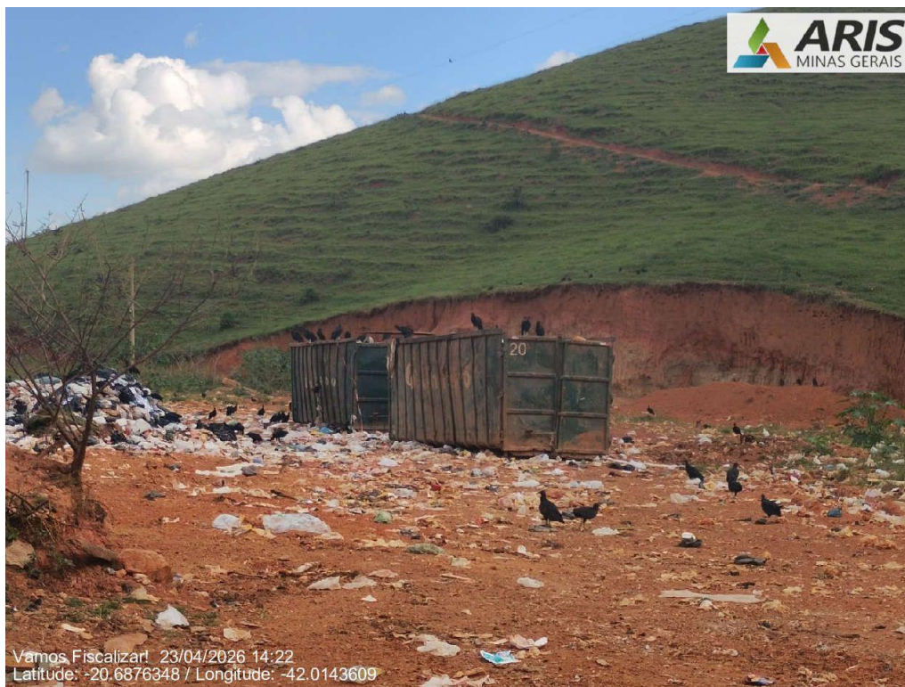
Local sem sistema de impermeabilização de base.
