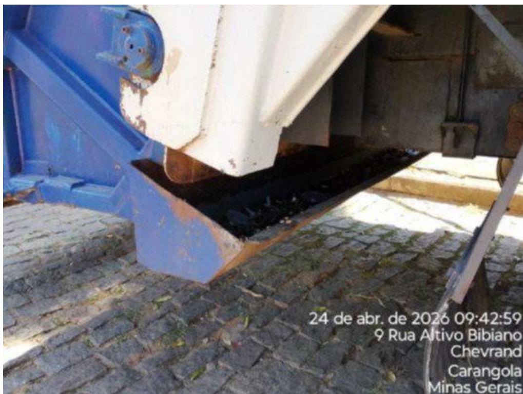
Caminhão possui canaleta de chorume.
