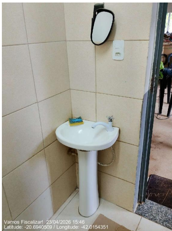
Interior dos banheiros masculino
