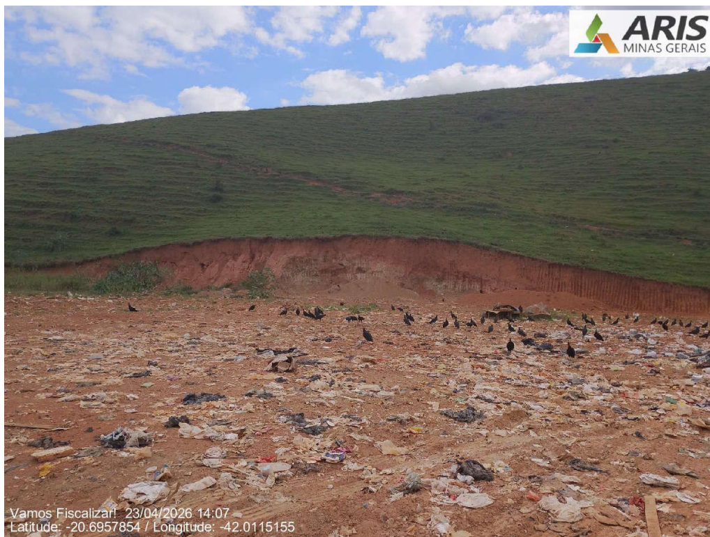
Área de transbordo é em local aberto, sem solo impermeabilizado, com a presença de muito animais
