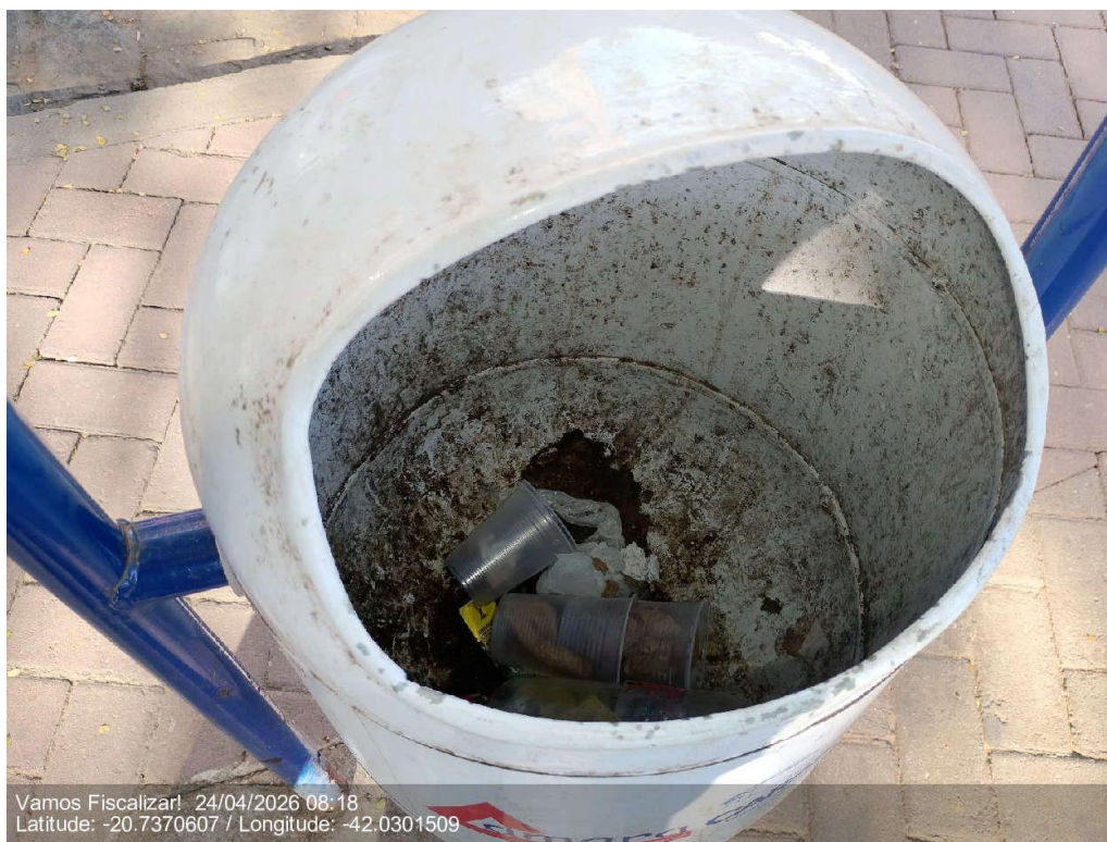
Lixeira em bom estado de conservação
