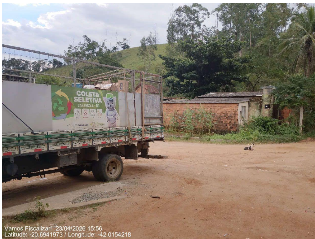
Pátio de manobra sem pavimentação
