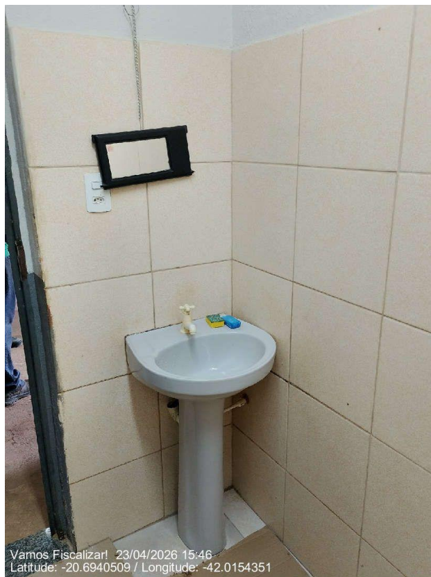
Interior dos banheiros feminino
