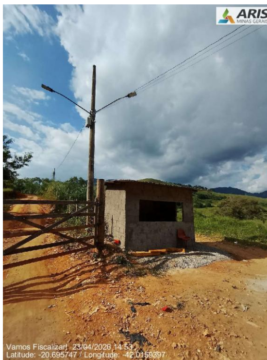
Portaria da área de transbordo em construção
