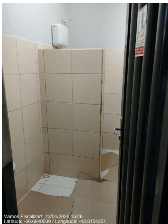
Interior dos banheiros feminino
