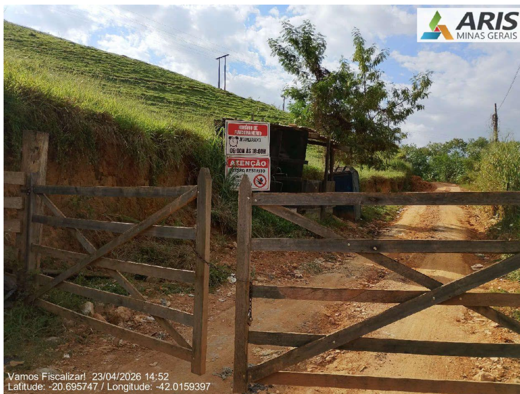
Acesso da área de transbordo.
