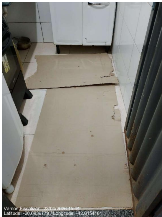
Área da cozinha
