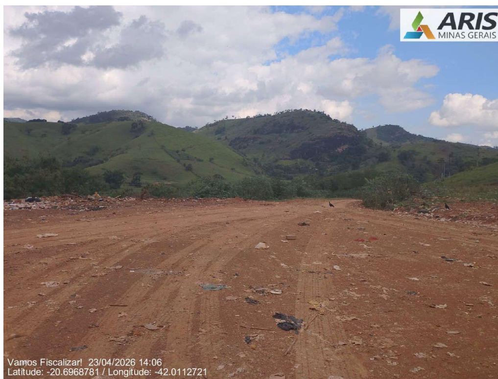
Acesso da área de transbordo.
