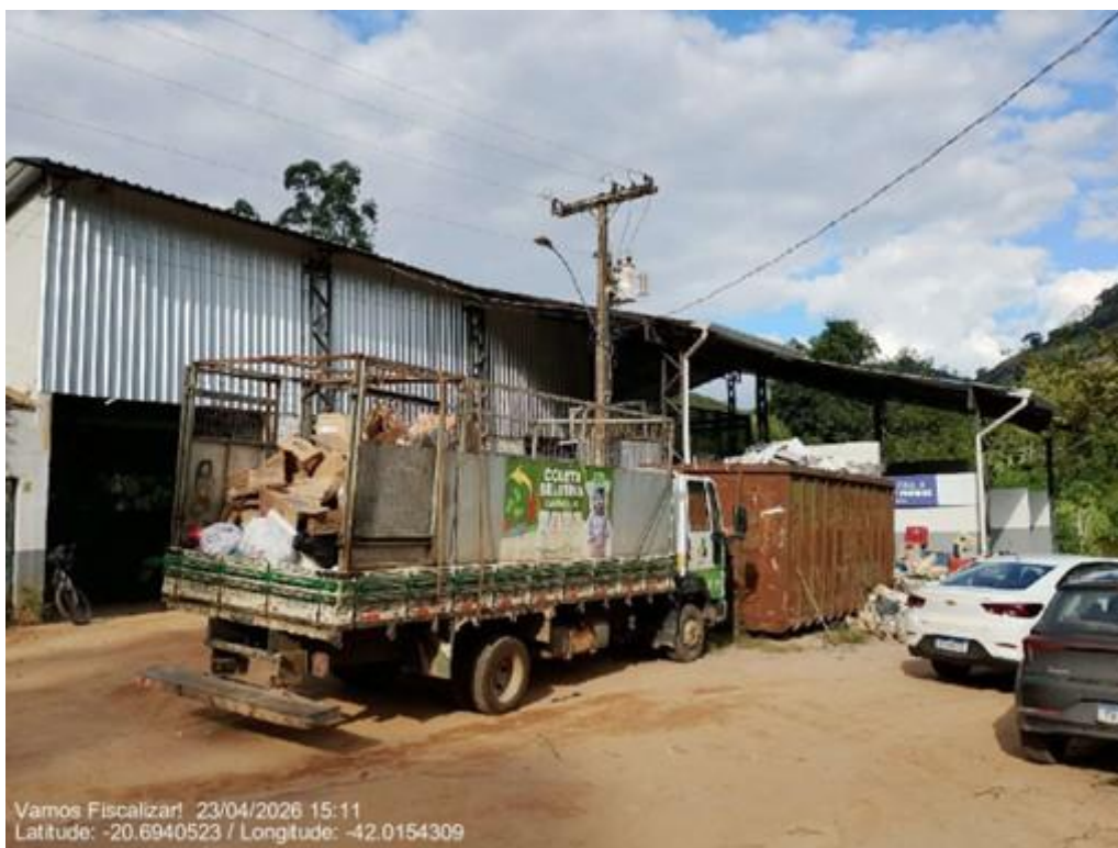
Vista geral da unidade de tratamento da coleta seletiva
