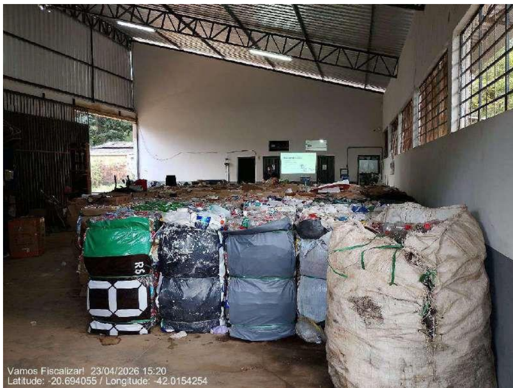
Cobertura na área de triagem dos resíduos
