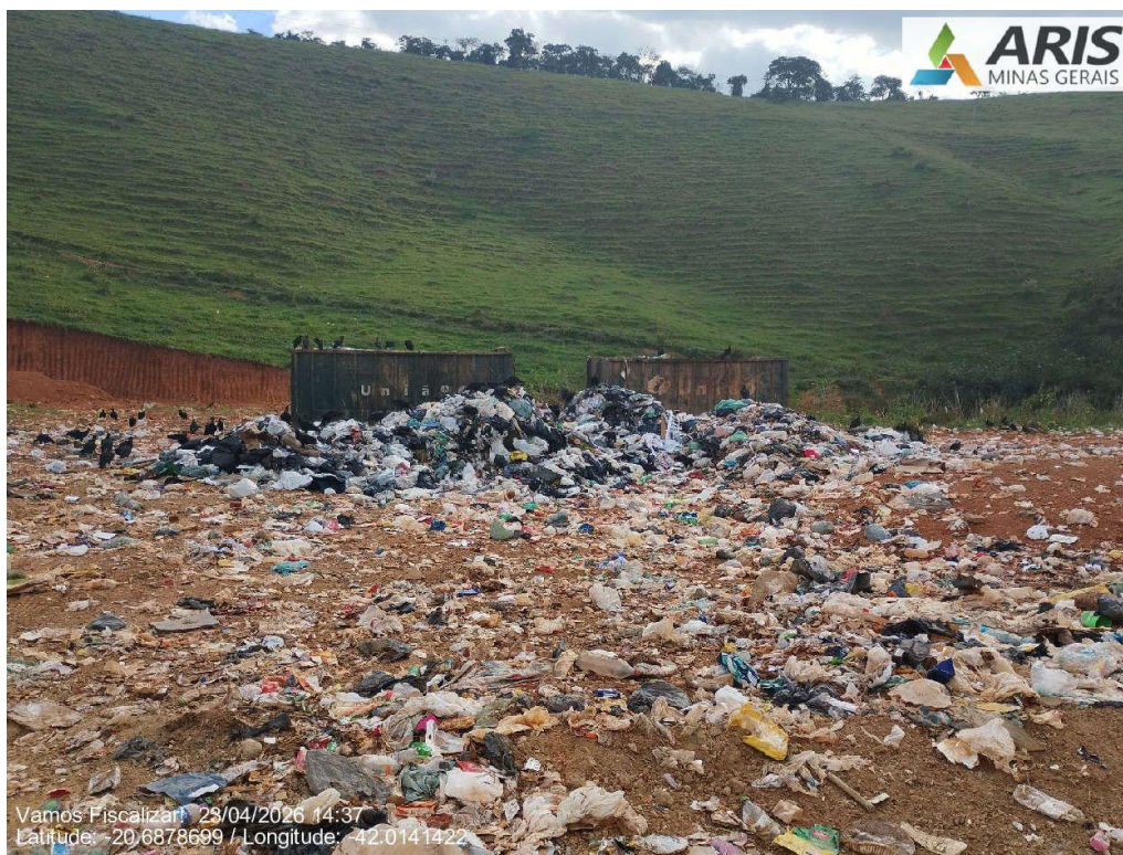
Local sem sistema de impermeabilização de base.
