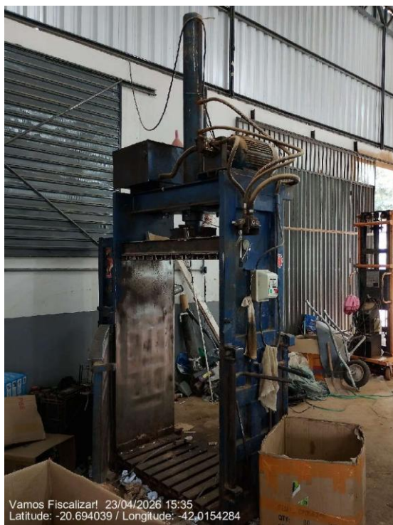
Prensa operando e em boas condições
