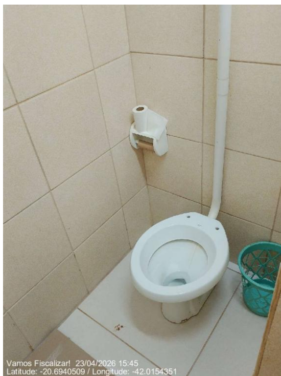
Interior dos banheiros masculino
