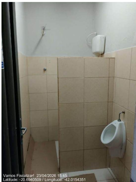
Interior dos banheiros masculino
