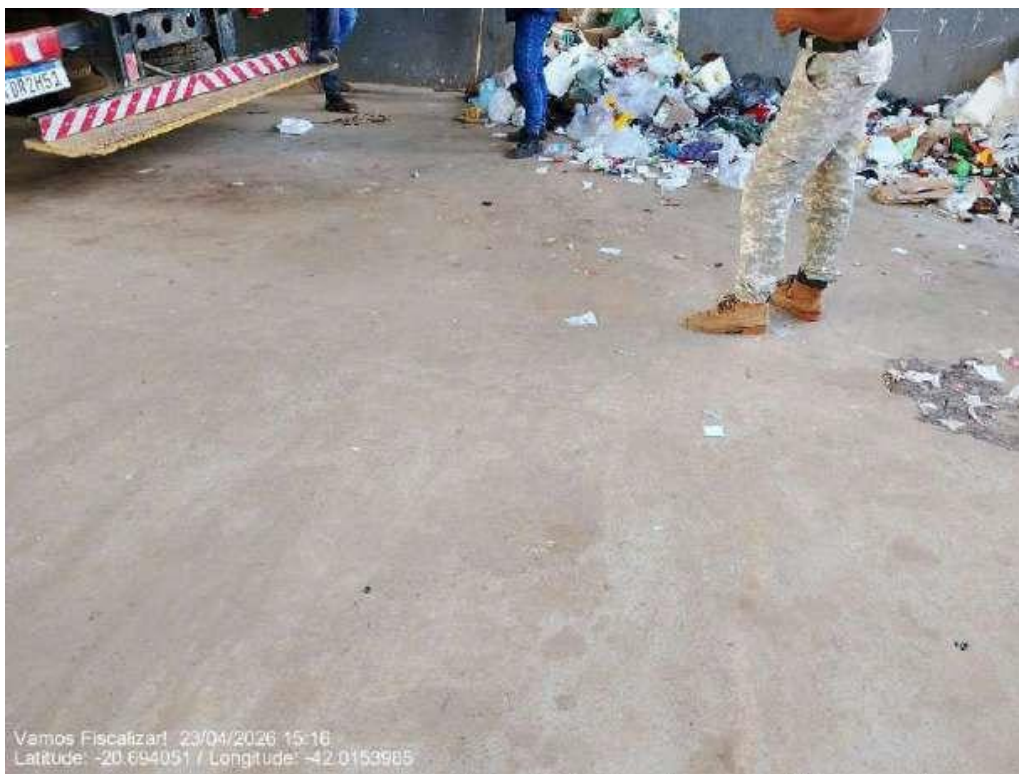
Piso impermeável na área de recebimento dos resíduos (entrada dos caminhões da coleta).
