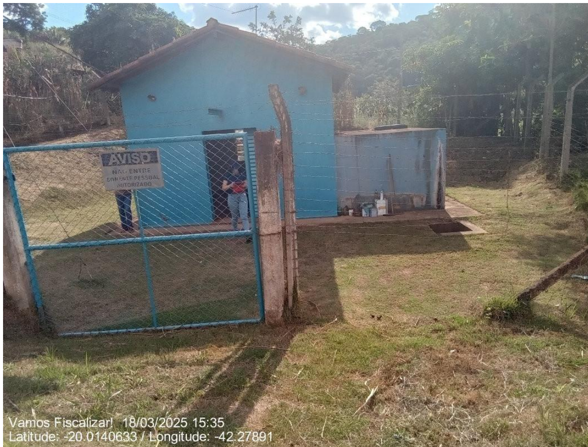
Cercamento da EEAB Principal Vermelho Novo.
