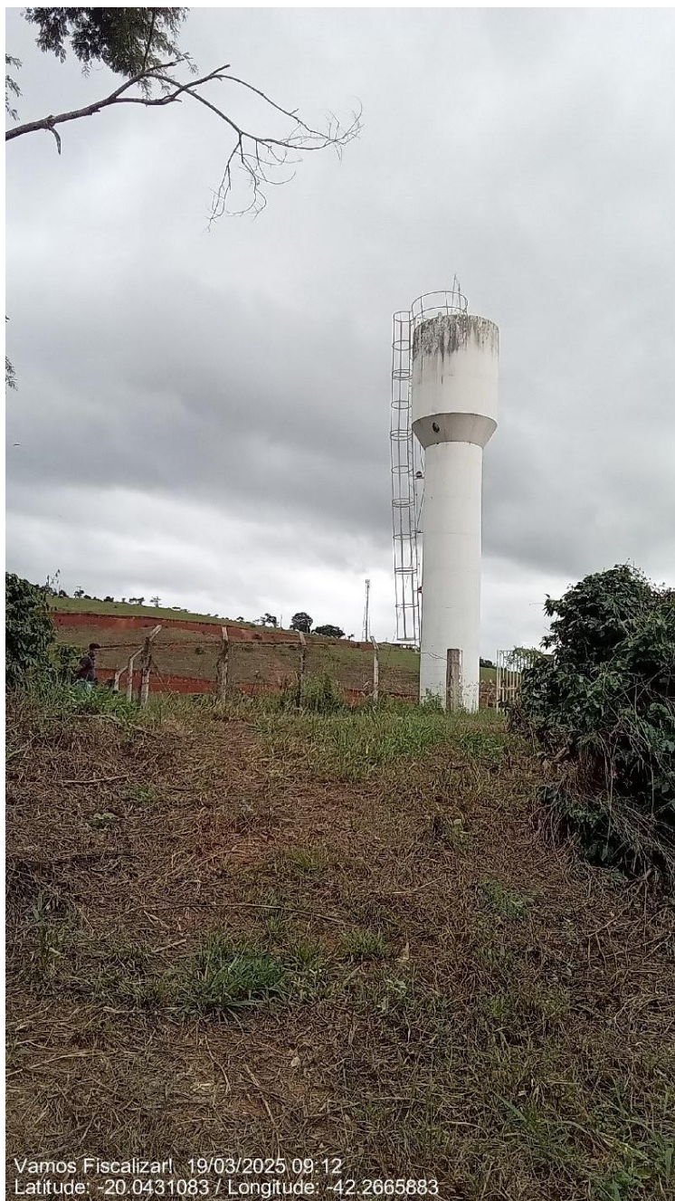
Acesso ao Reservatório Cidade Jardim II.
