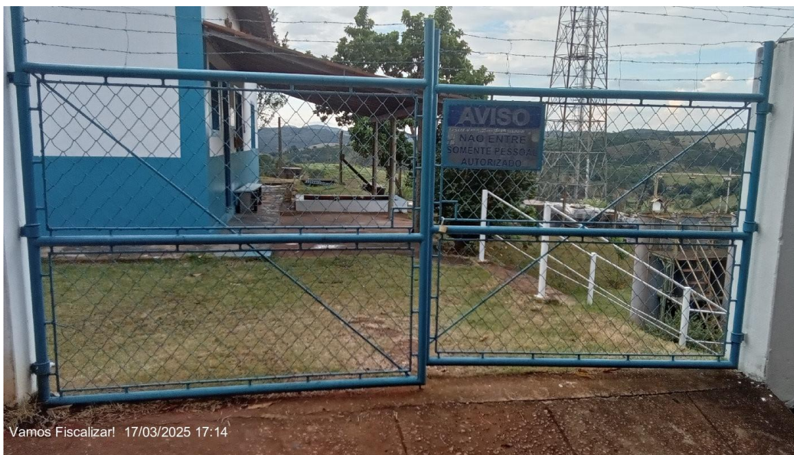
Acesso ETA Vermelho Novo.
