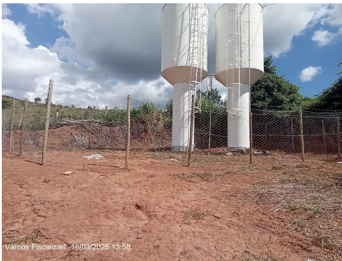
Ausência de placas de identificação e aviso.
