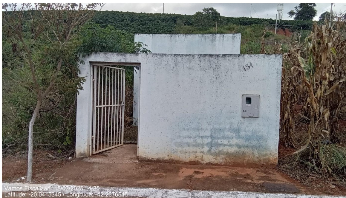
Reservatório Cidade Jardim II.
