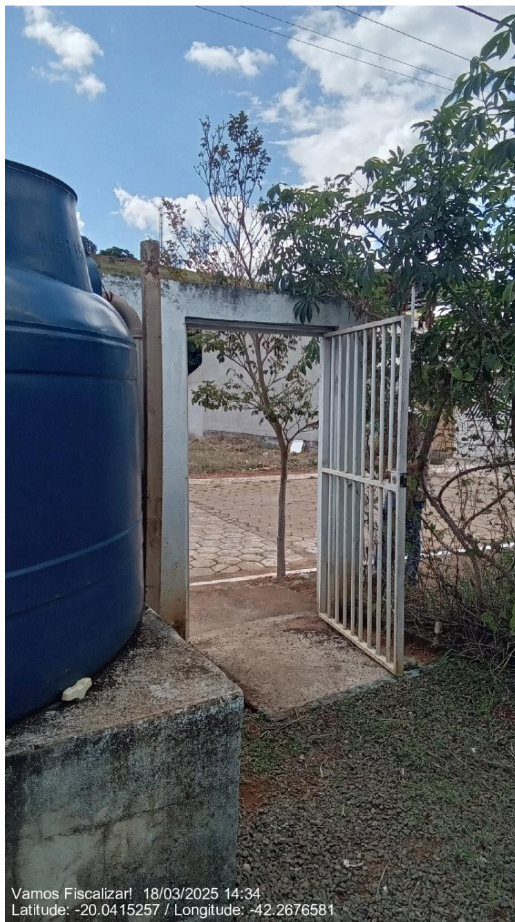
Acesso ao Reservatório Cidade Jardim II.
