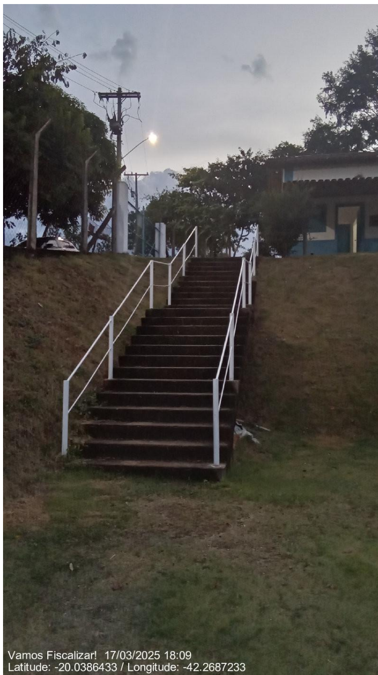
Escada e guarda-corpos.
