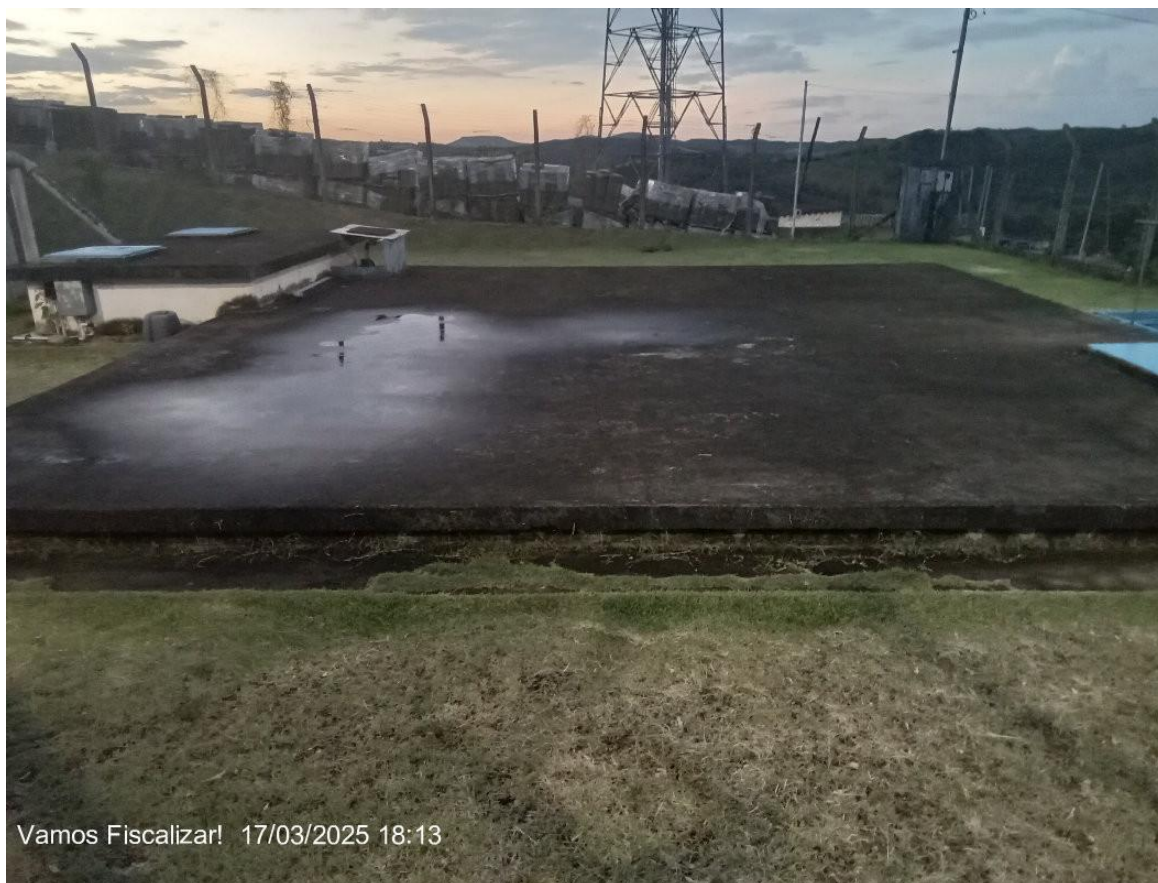
Cobertura do Reservatório Principal ETA.
