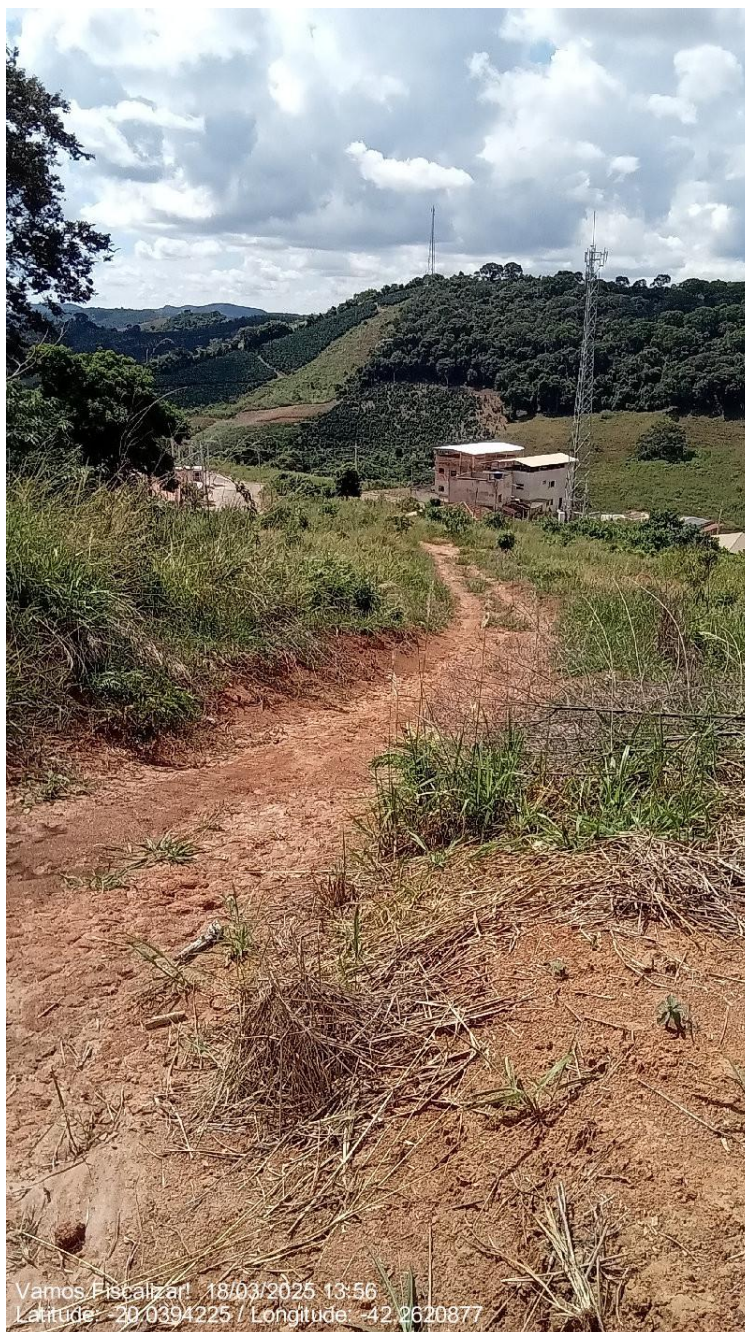
Acesso ao Reservatório Casas Populares.
