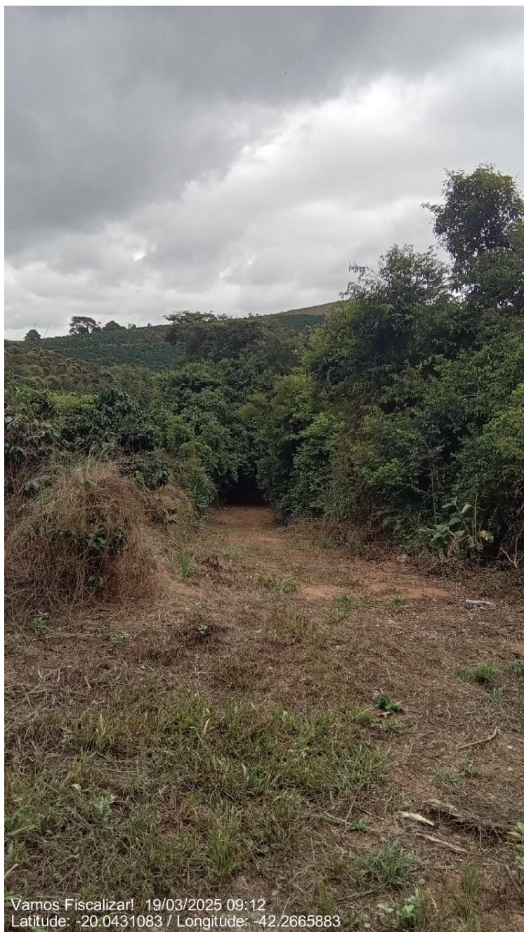
Acesso ao Reservatório Cidade Jardim II.
