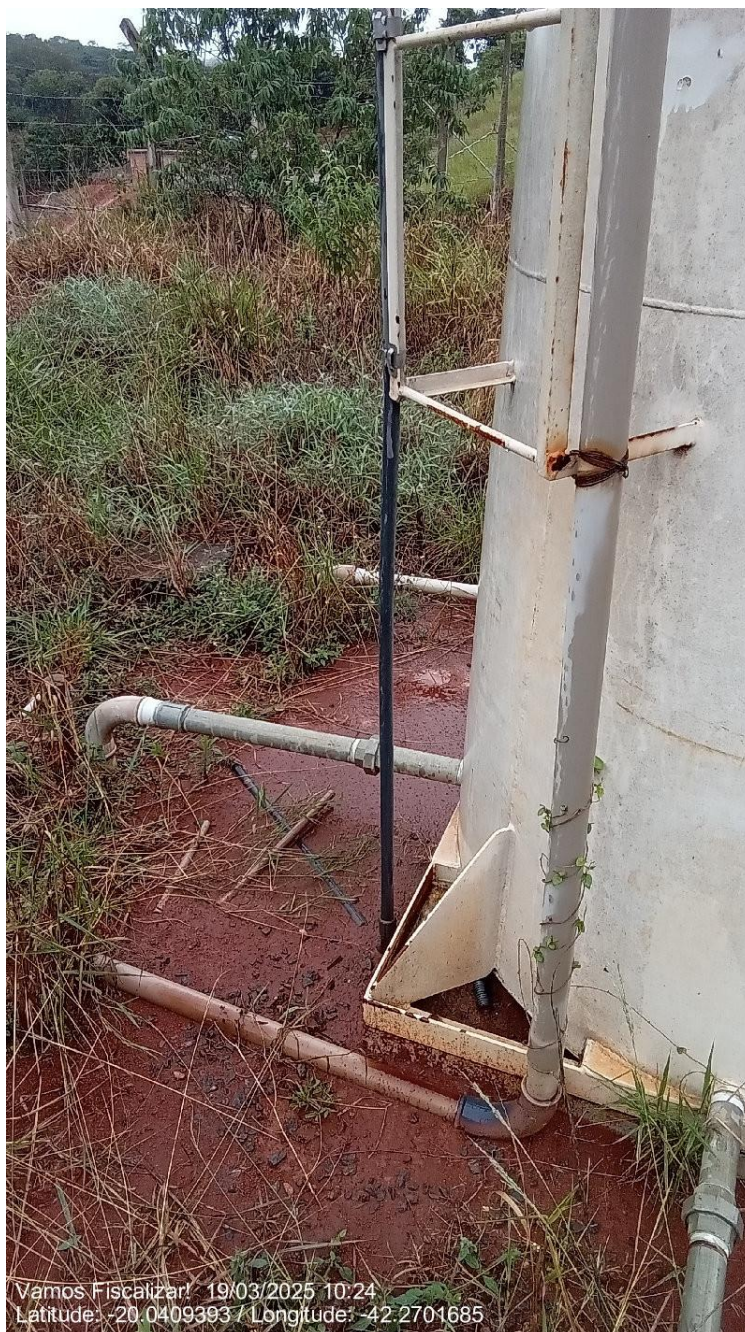
Tubulação do extravasor.
