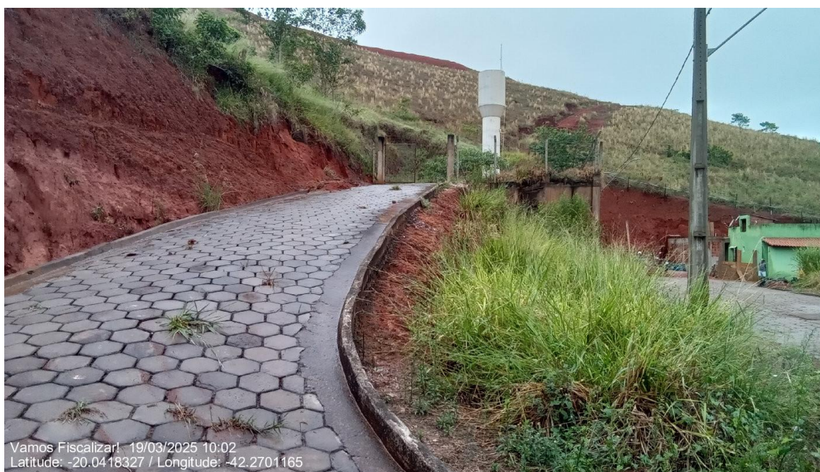
Acesso ao Reservatório Cidade Jardim I.
