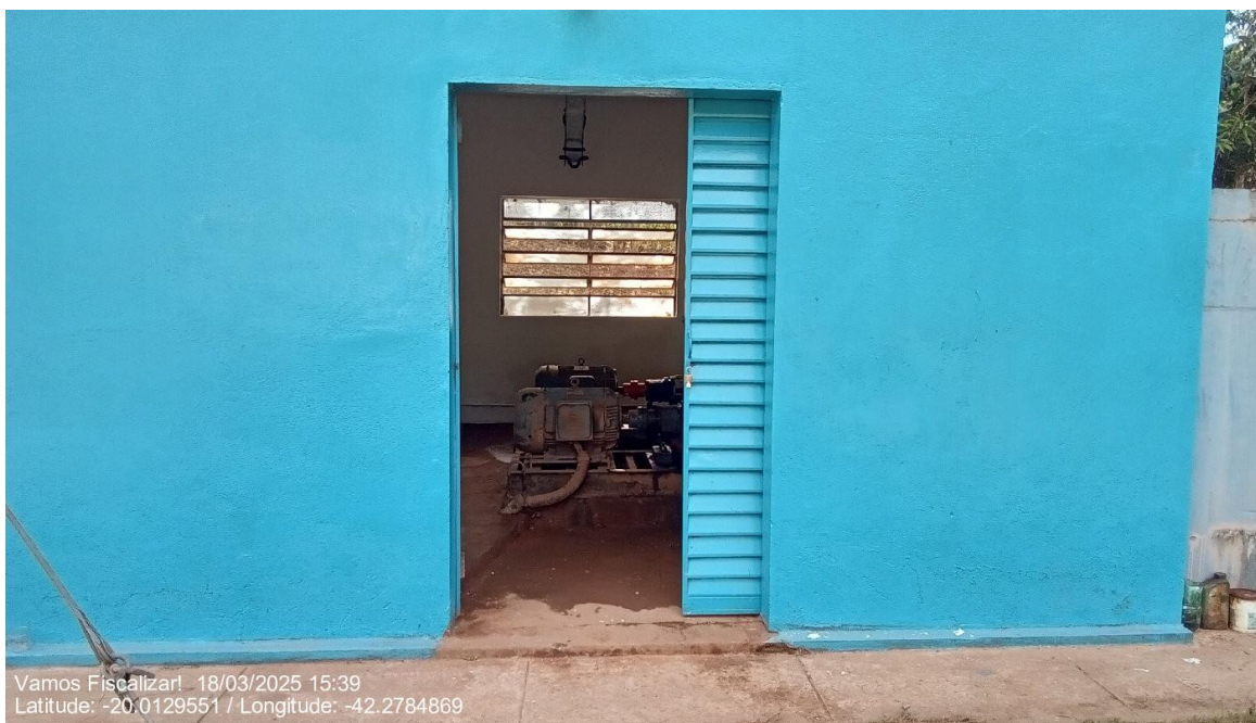
Acesso da EEAB Principal Vermelho Novo.
