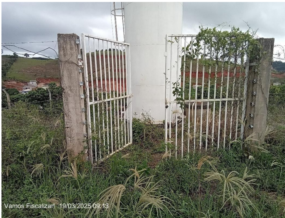
Portão de acesso com cadeado do Reservatório Cidade Jardim II.
