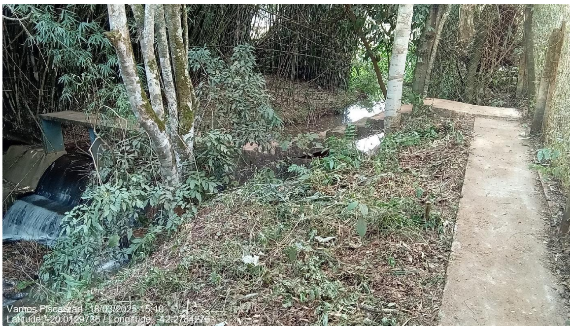
Passarela de acesso à barragem.
