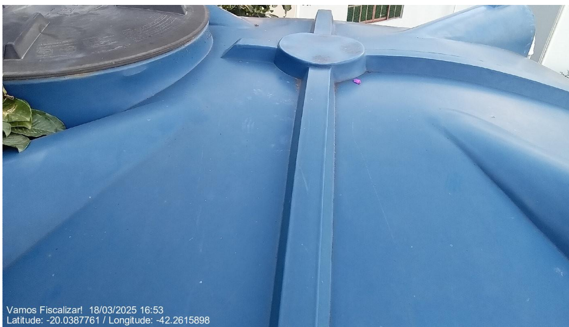
Tampa de inspeção.
