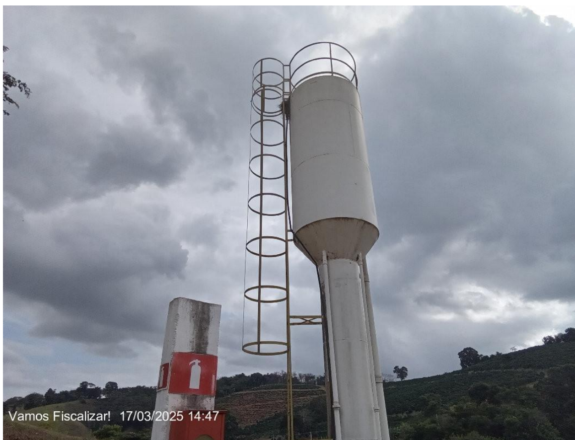
Imagem da escada de acesso ao reservatório
