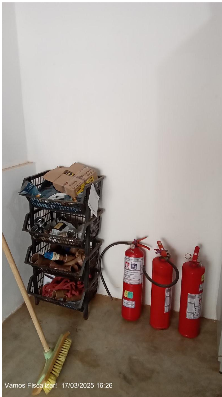
Limpeza e organização do almoxarifado de conexões.
