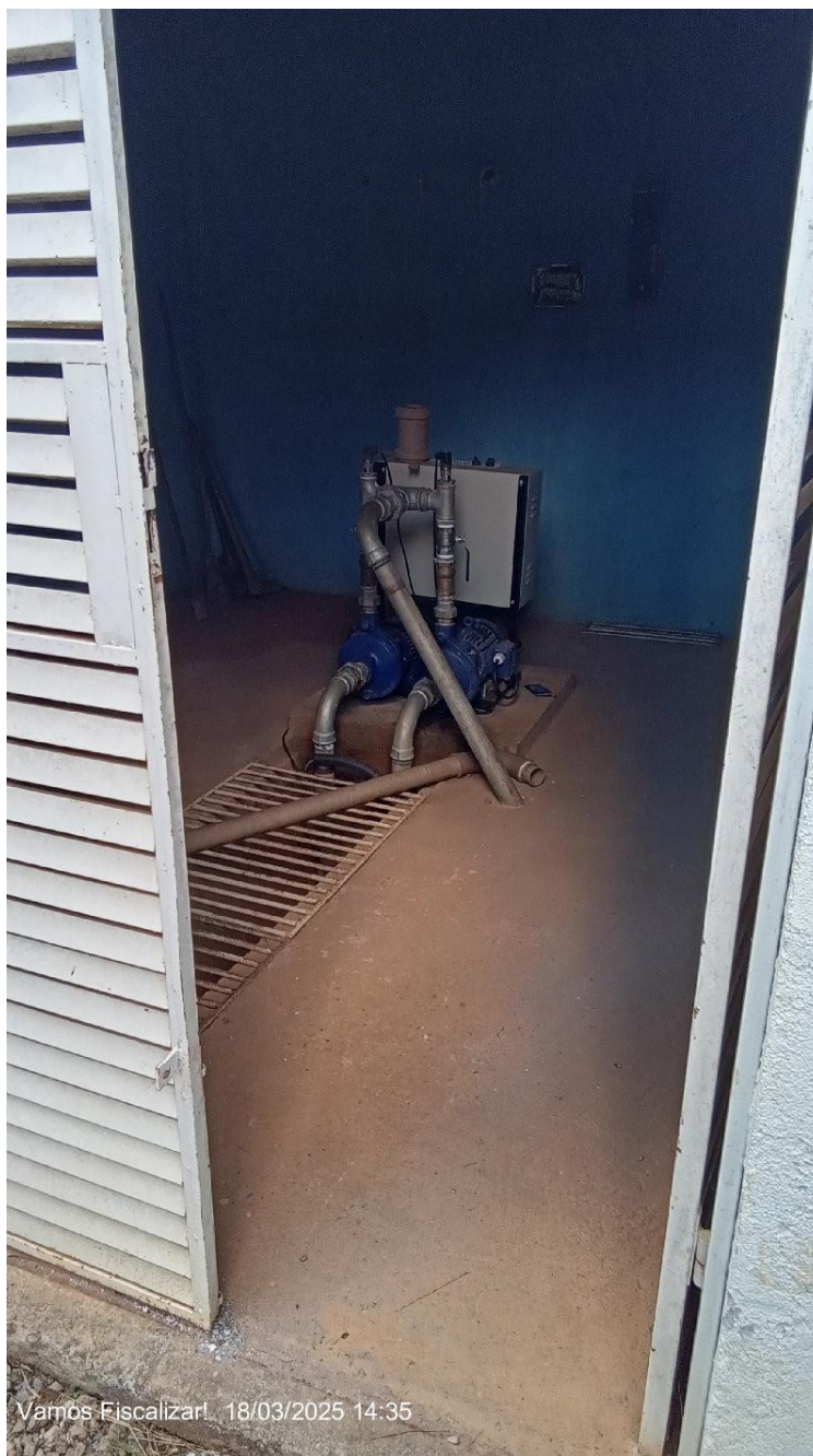
Acesso ao Reservatório Cidade Jardim II.
