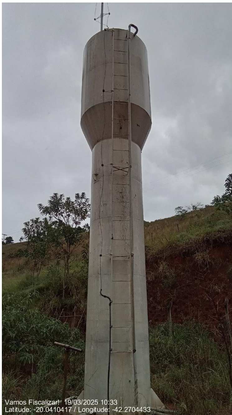
Estrutura aparente do Reservatório Cidade Jardim I.
