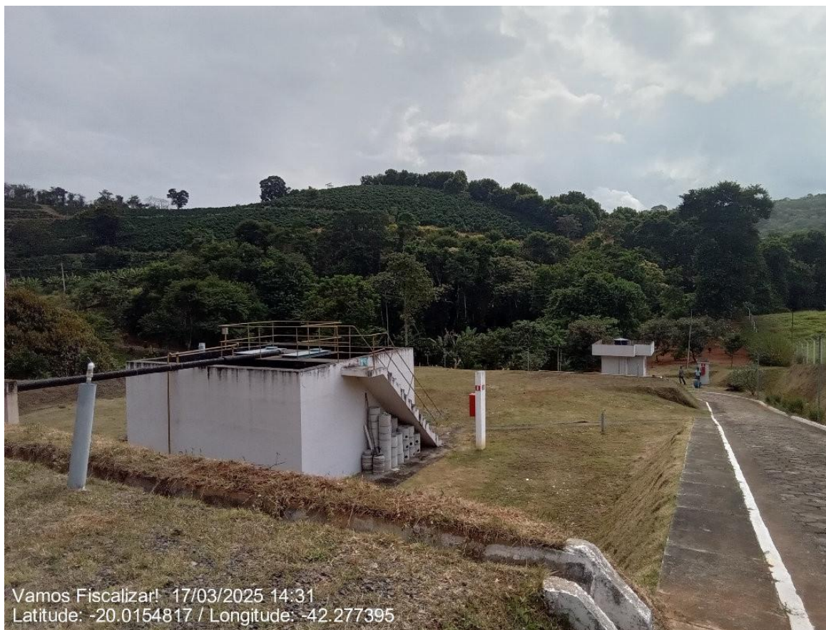
Acesso às unidades de tratamento.
