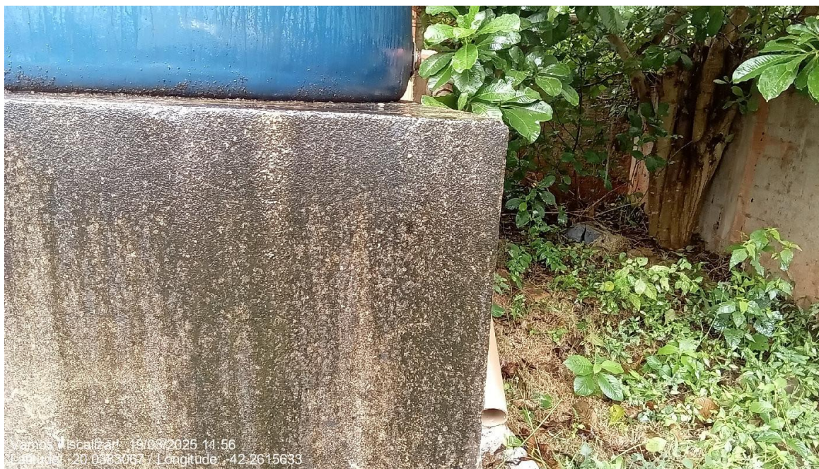
Tubo de descarga de fundo.
