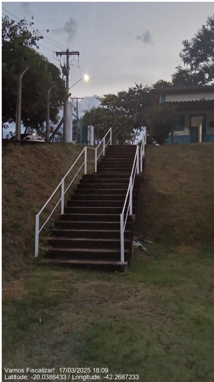
Escada e guarda-corpo.
