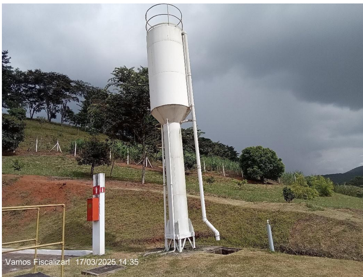
Imagem do reservatório.
