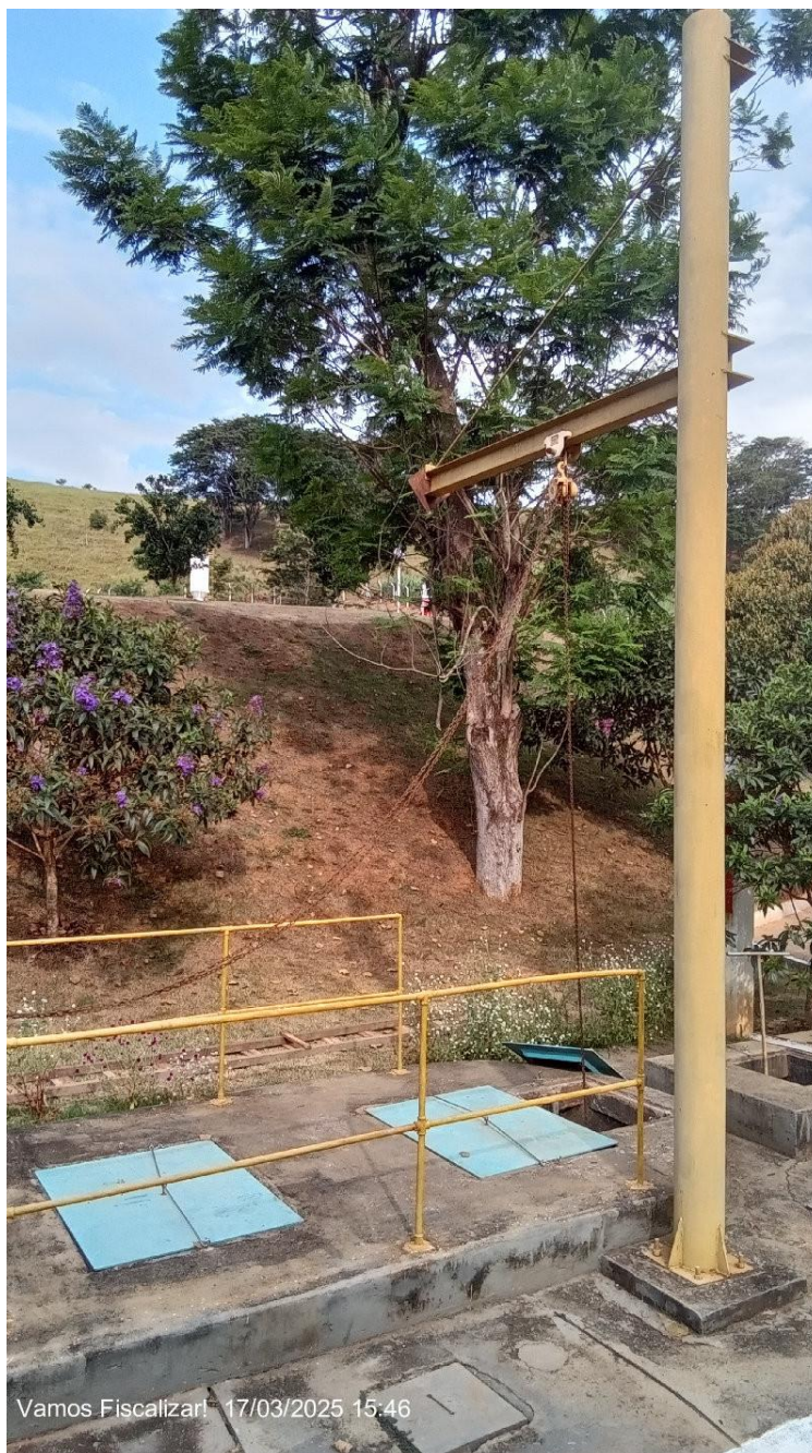
Estrutura para içamento dos equipamentos.
