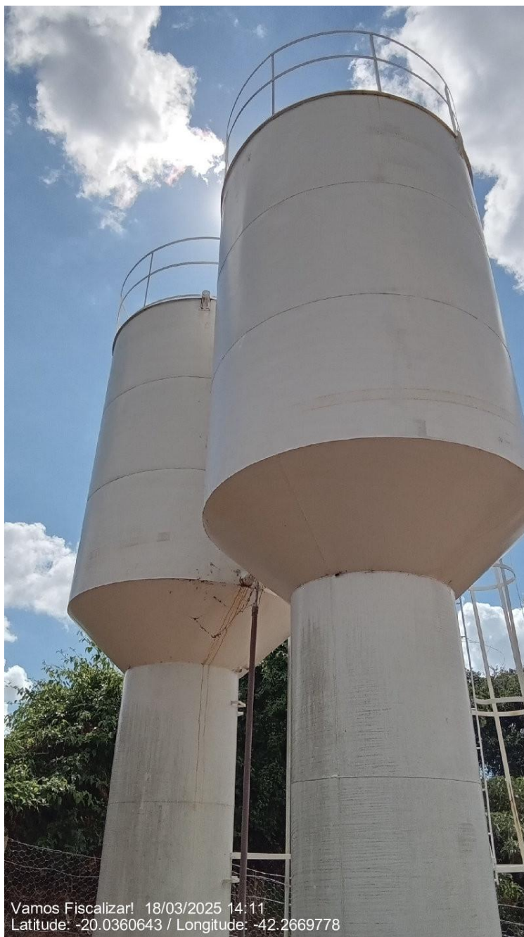
Reservatório com guarda-corpo.
