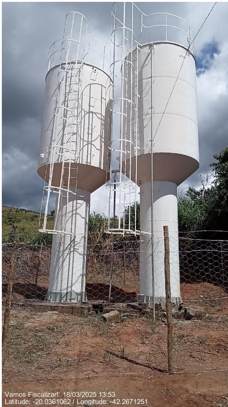
Reservatórios tipo taça.
