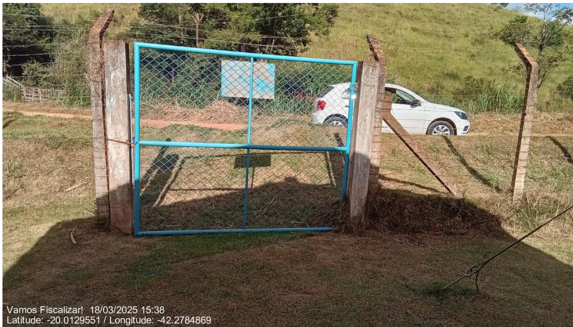
Acesso da EEAB Principal Vermelho Novo.
