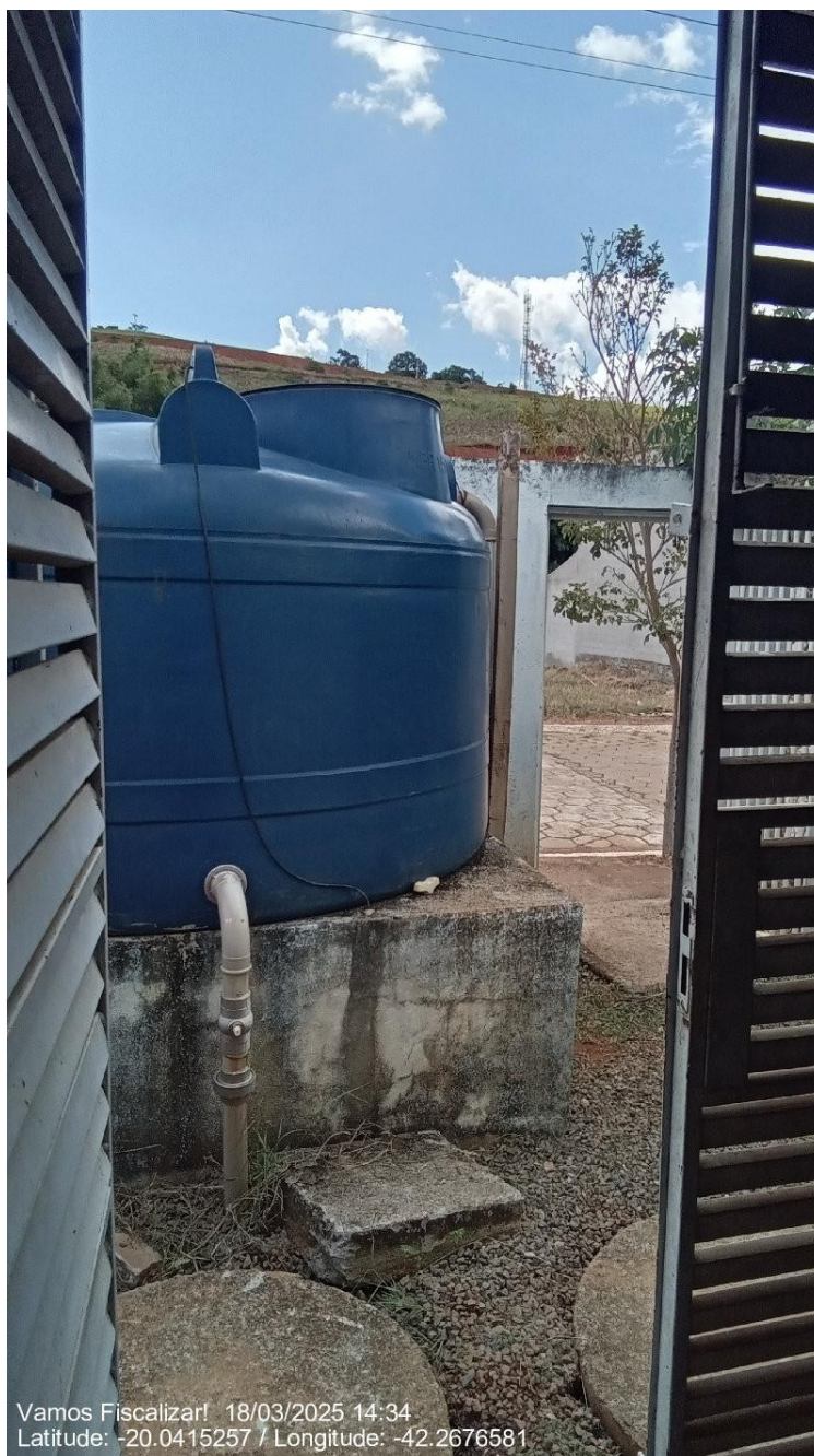
Acesso ao Reservatório Cidade Jardim II.
