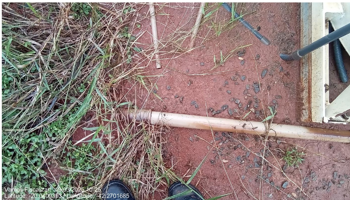
Tubulação do extravasor enterrada.
