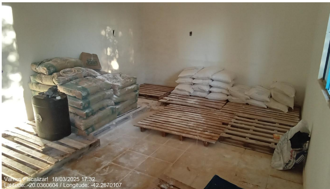
Armazenamento na casa de química.
