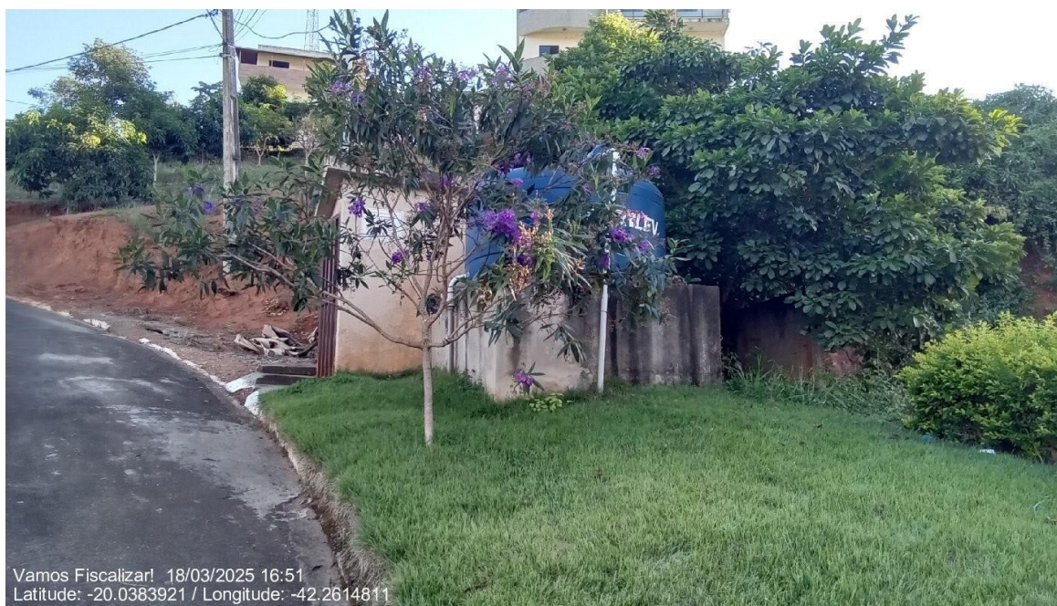
Acesso ao Reservatório ao lado da EEAT das Casas Populares.
