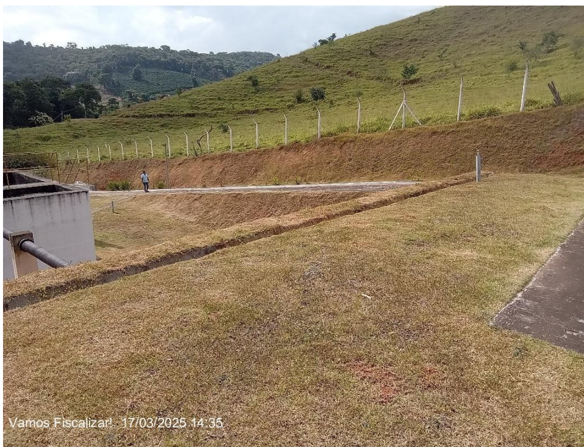
Imagem de acesso pavimentado até o reservatório.
