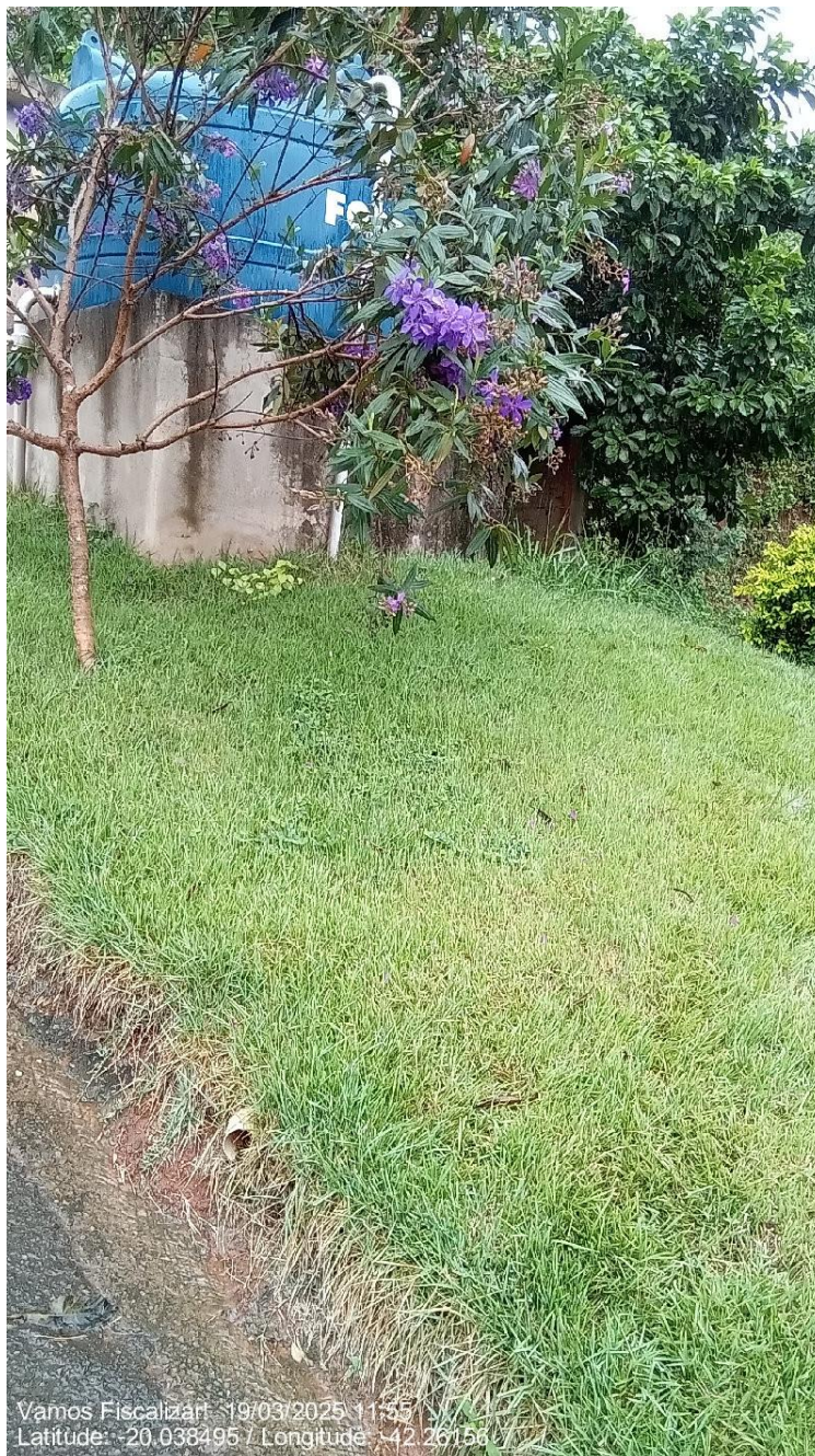
Presença de tubo extravasor.
