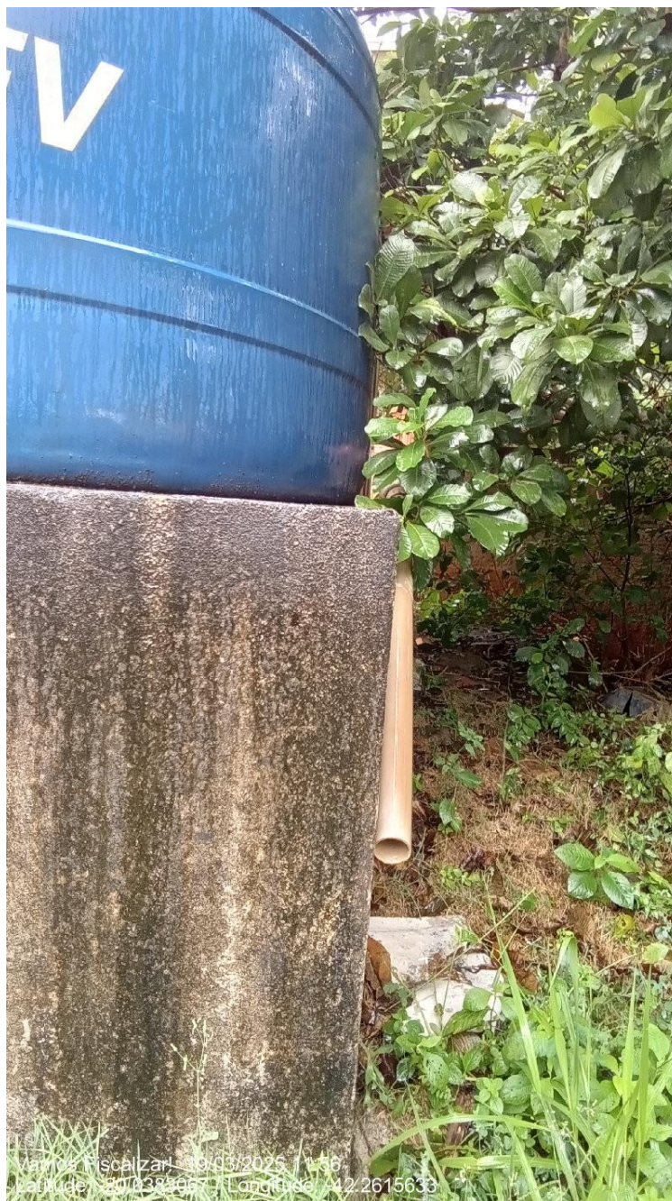
Tubo de descarga de fundo.
