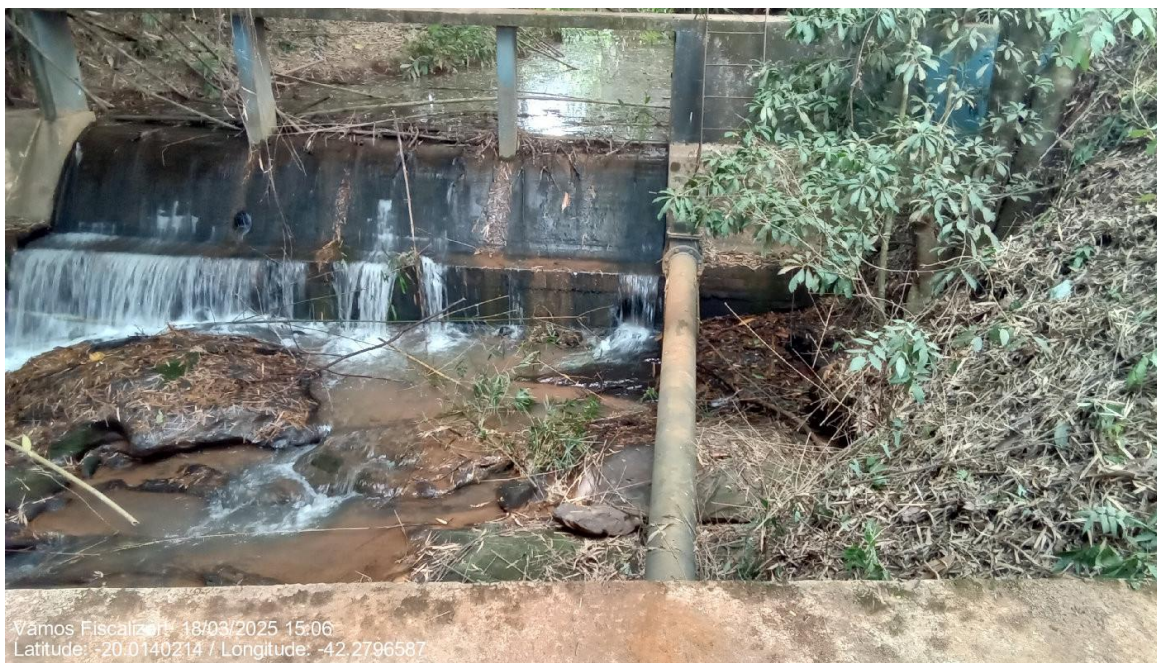
Tubulação de saída da barragem.
