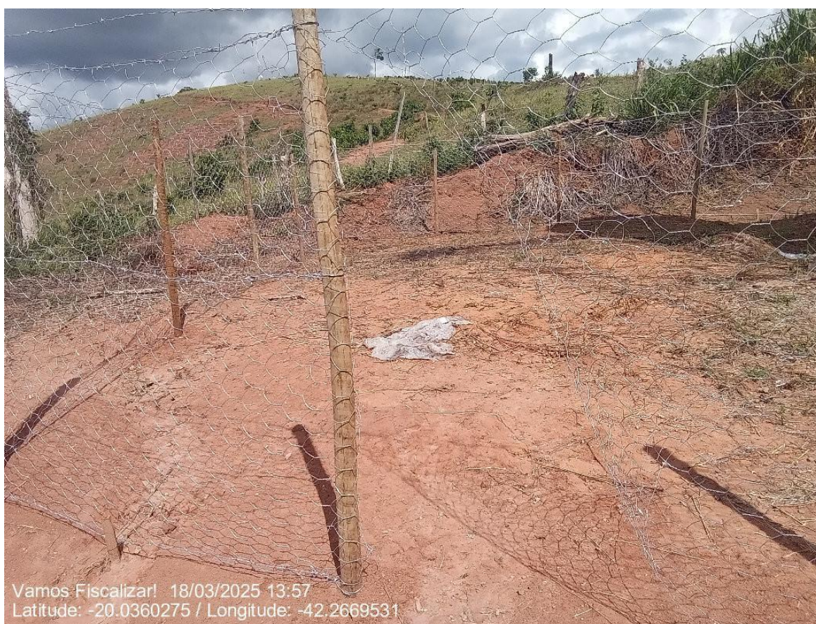
Entrada do Reservatório Casas Populares.
