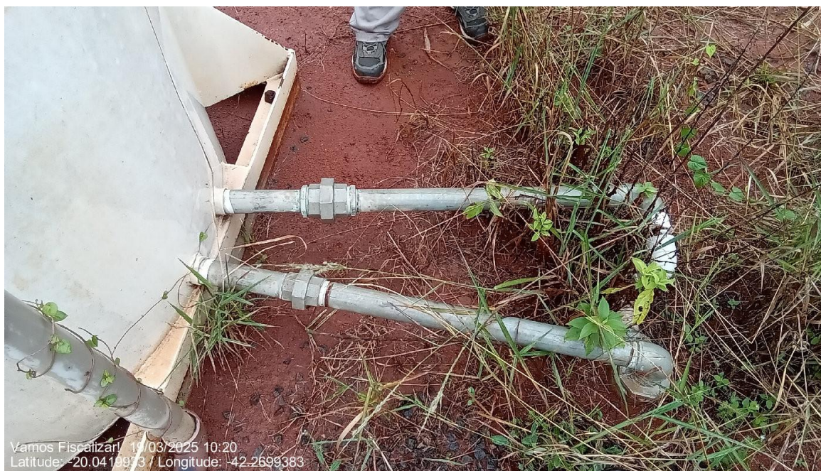
Tubulação de entrada.
