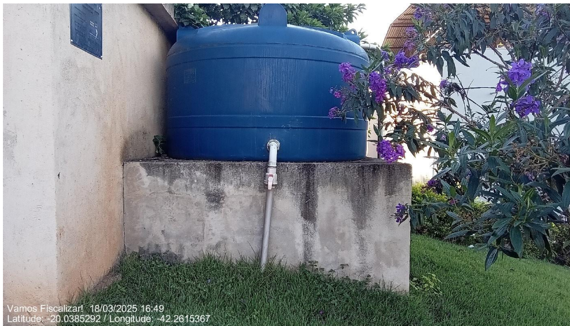
Reservatório ao lado da EEAT das Casas Populares.
