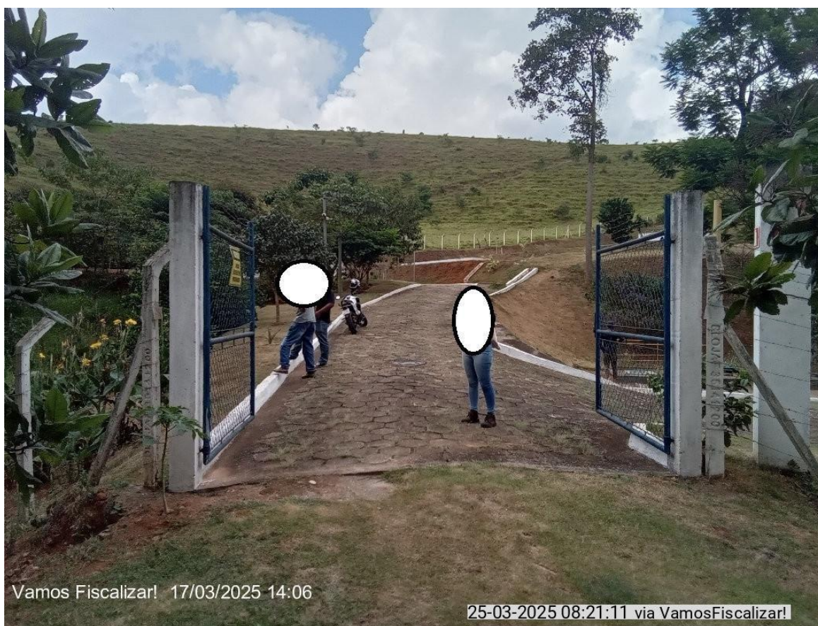
Imagem do acesso e portão da ETE.
