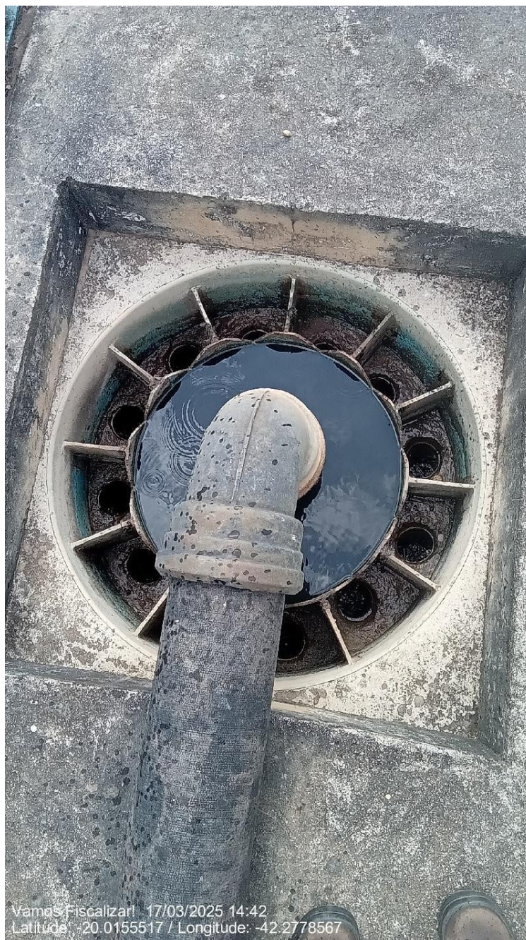
Canos ligados até o fundo do reator UASB.
