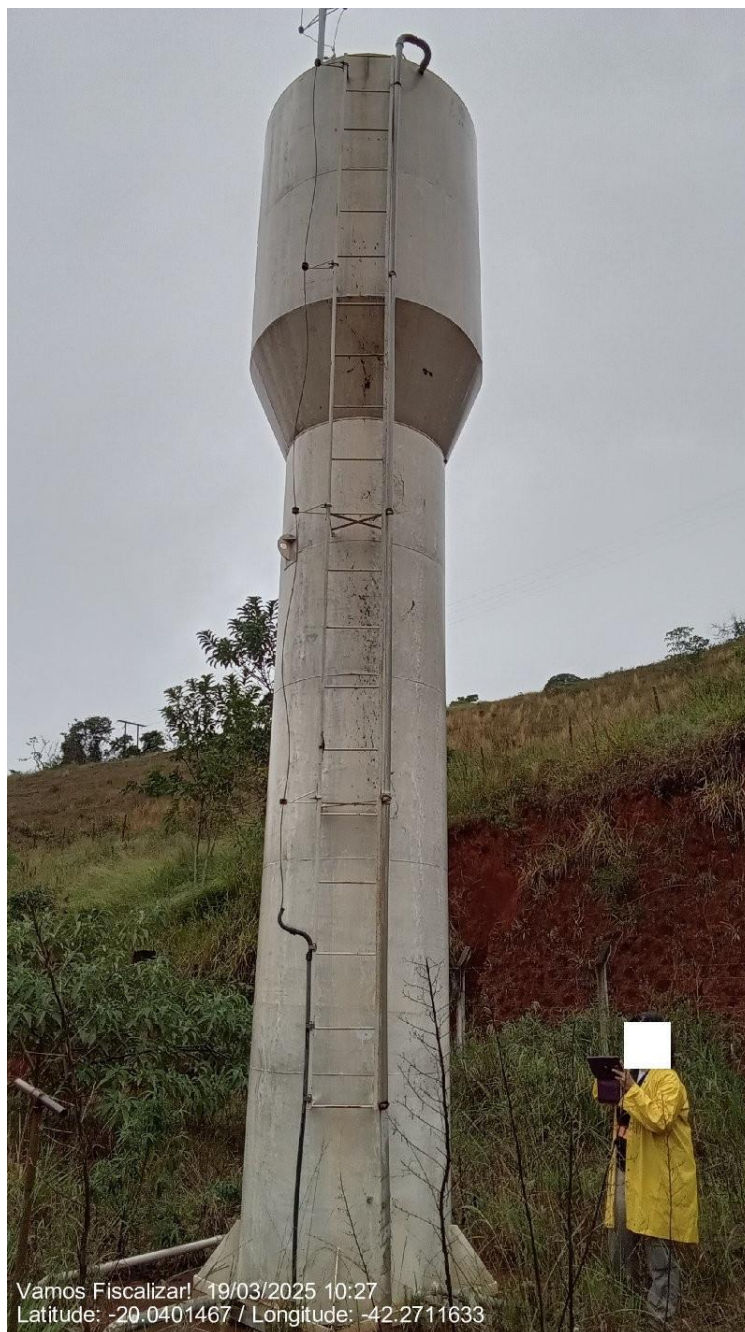
Cabo elétrico da bomba que é acionada automaticamente.
