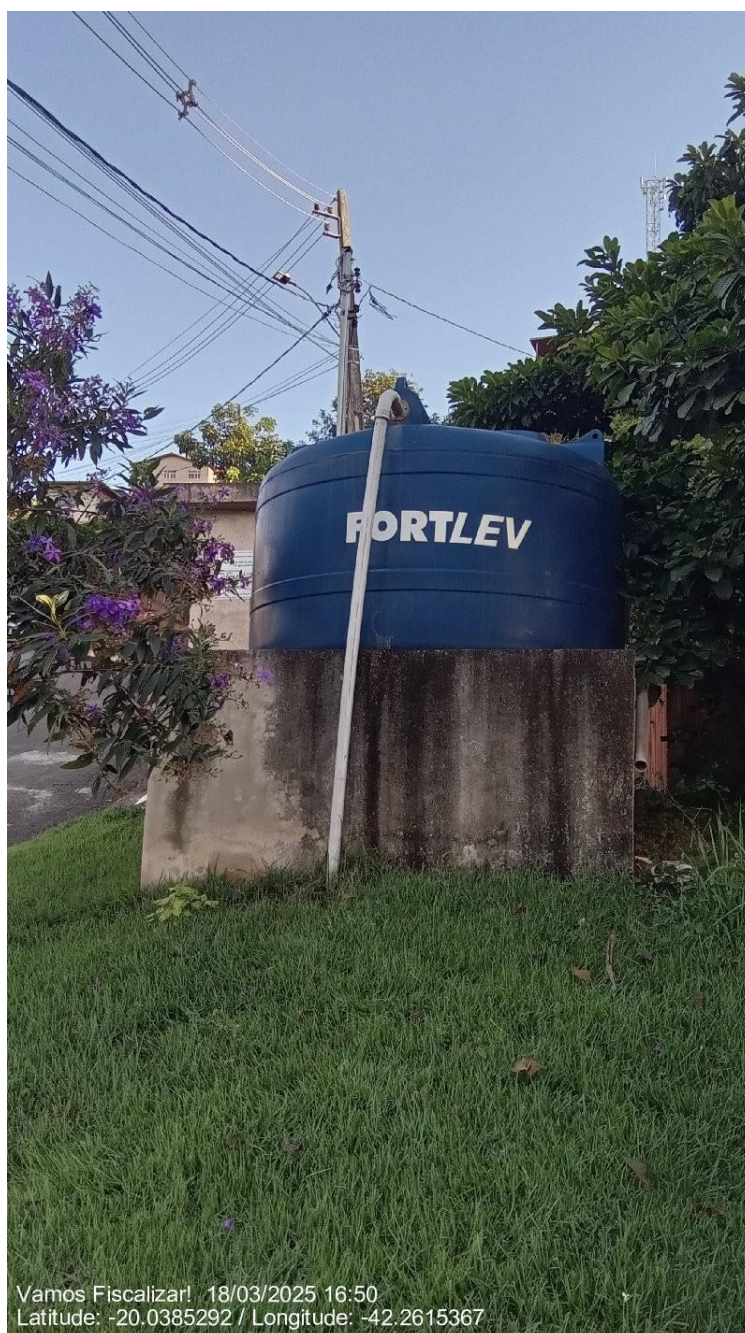
Reservatório ao lado da EEAT das Casas Populares.
