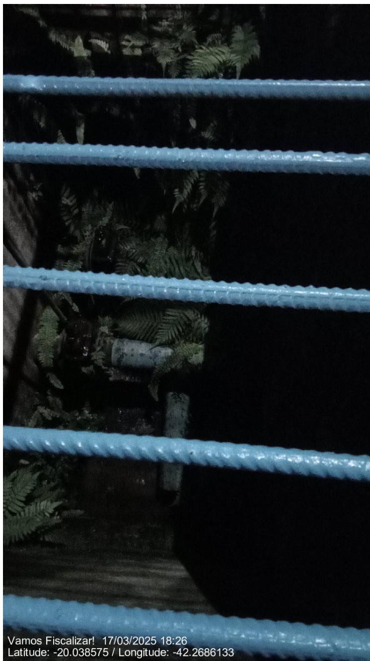
Tubo de descarga de fundo.
