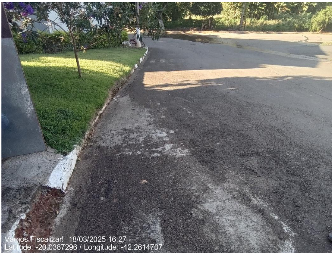
Acesso EEAT Casas Populares.
