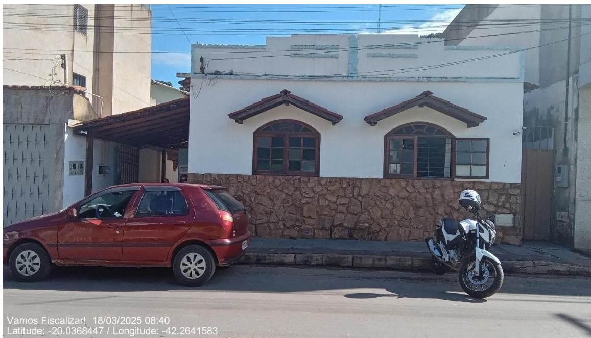
Ponto de atendimento ao usuário de água e esgoto.
