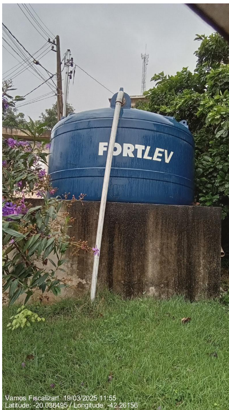
Tubulação do extravasor enterrada.
