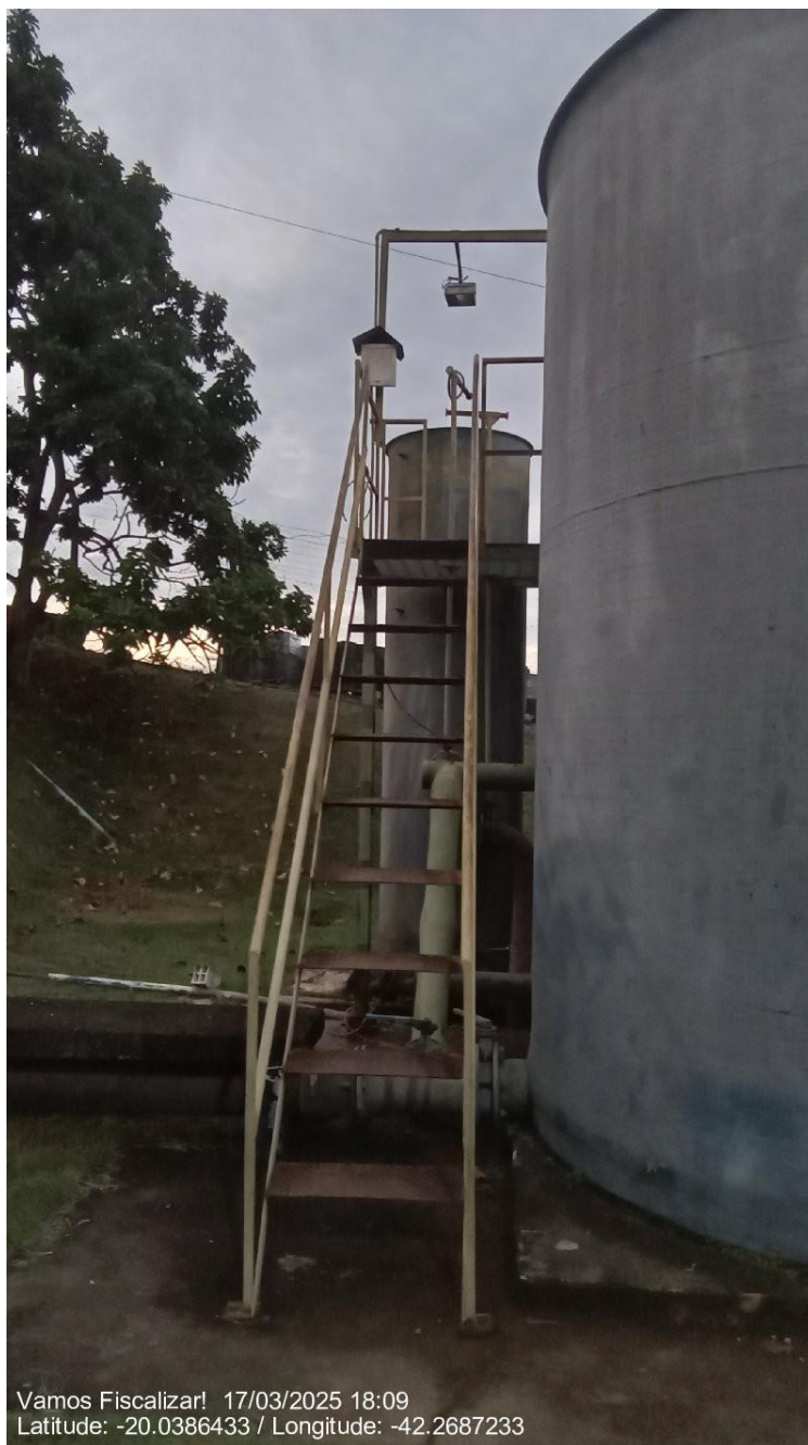
Escada e guarda-corpos.
