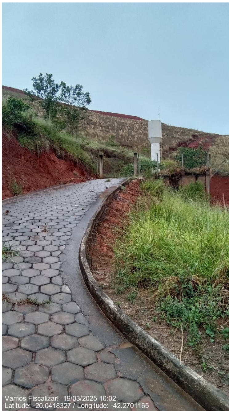
Acesso ao Reservatório Cidade Jardim I.
