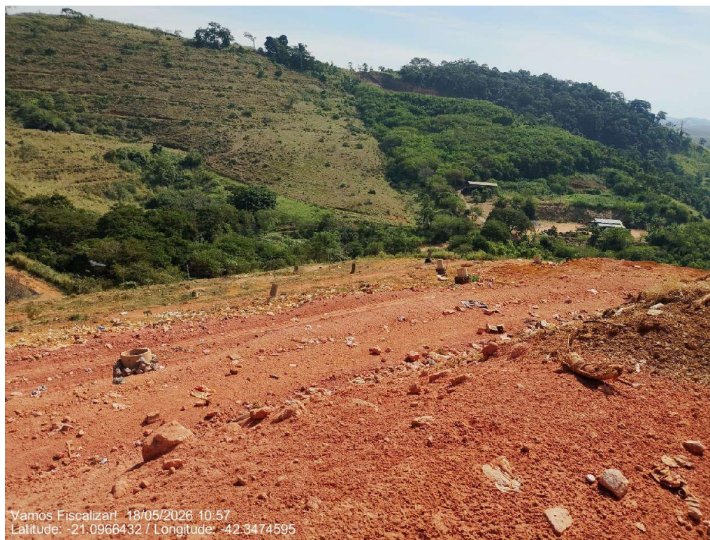
Via em solo compactado.
