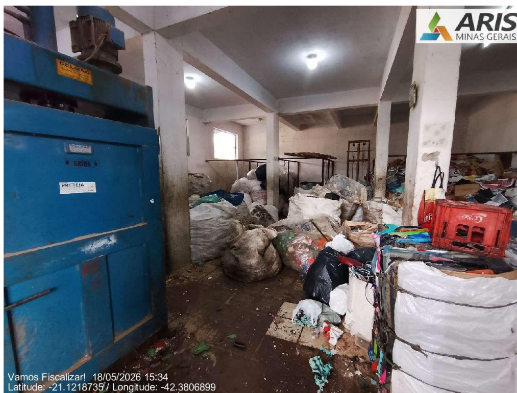
Baias de armazenamento dos materiais recicláveis.
