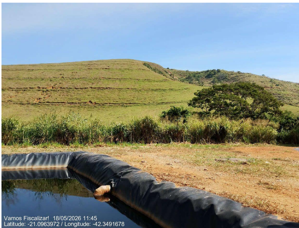
Cercamento na área da lagoa.
