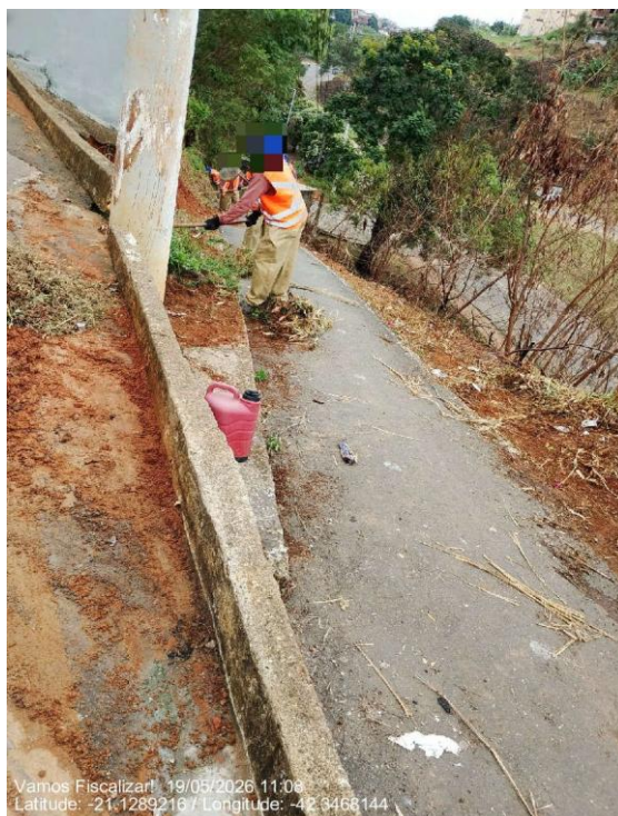
Serviço de capina e roçada.
