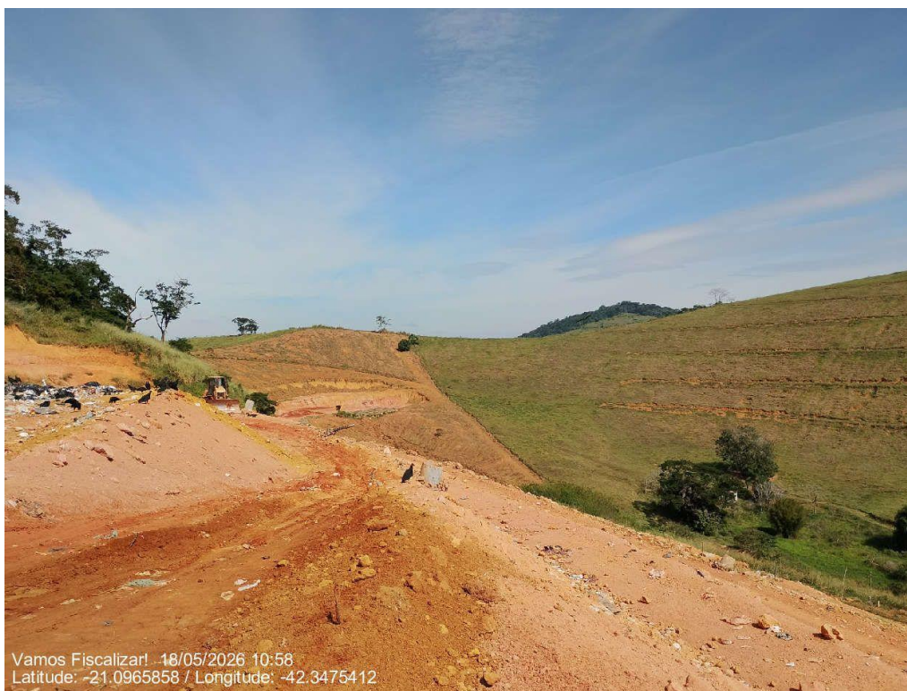
Cercamento ao redor da área.
