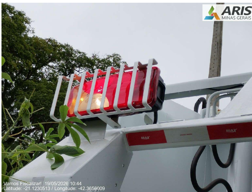
Iluminação dianteira em funcionamento.
