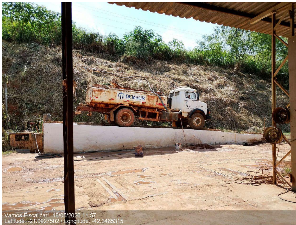
Caminhão pipa no aterro.
