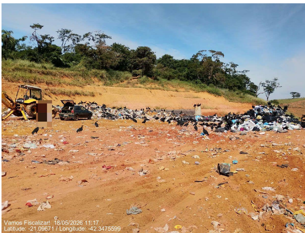
Presença de urubus no Aterro Sanitário.
