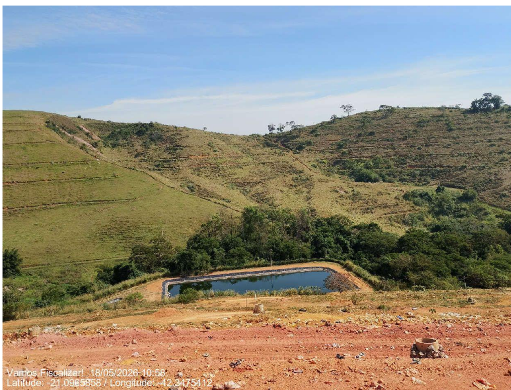
Cercamento ao redor da área.
