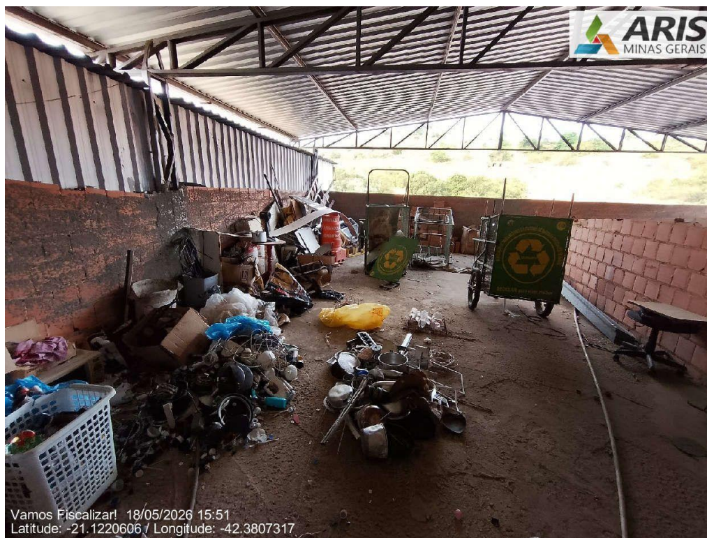
Parte superior do galpão da associação.
