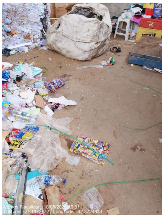
Área com piso impermeável, mas sem canaletas para drenagem de líquidos.
