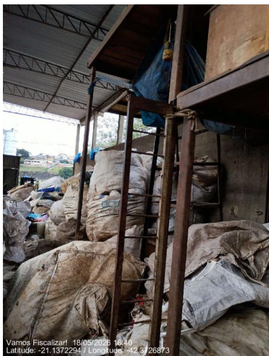
Escada de acesso à esteira mecanizada.
