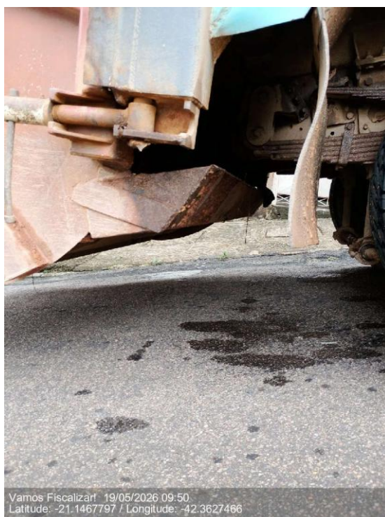
Vazamento na calha coletora de chorume.
