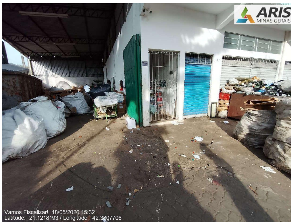
Entrada do galpão.
