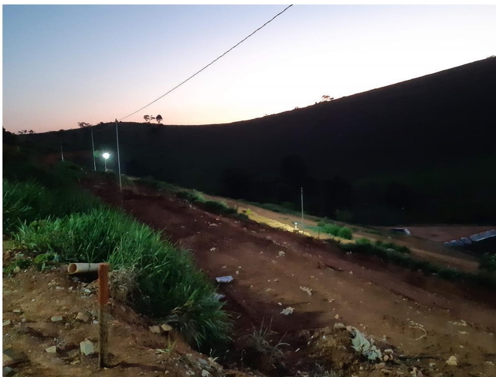
Iluminação noturna no aterro (RMA, 2026).
