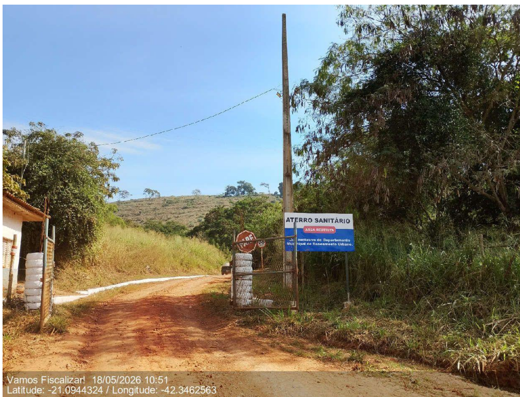
Entrada do aterro sanitário.
