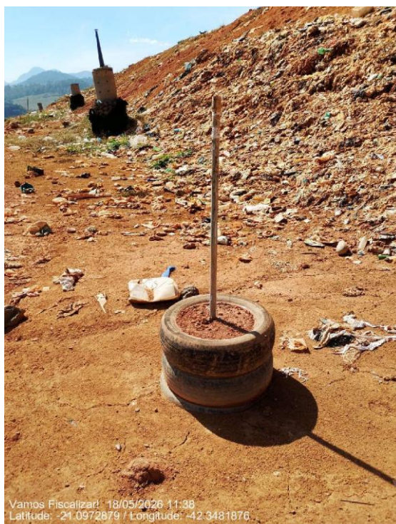
Piezômetro para nível de chorume e pressão de gás.
