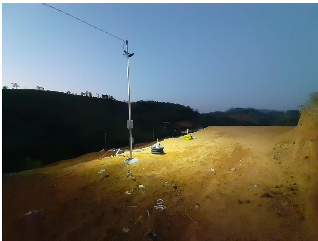
Iluminação noturna no aterro (RMA, 2026).
