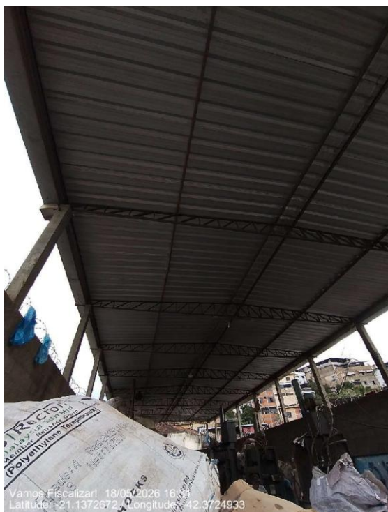
Área com cobertura.
