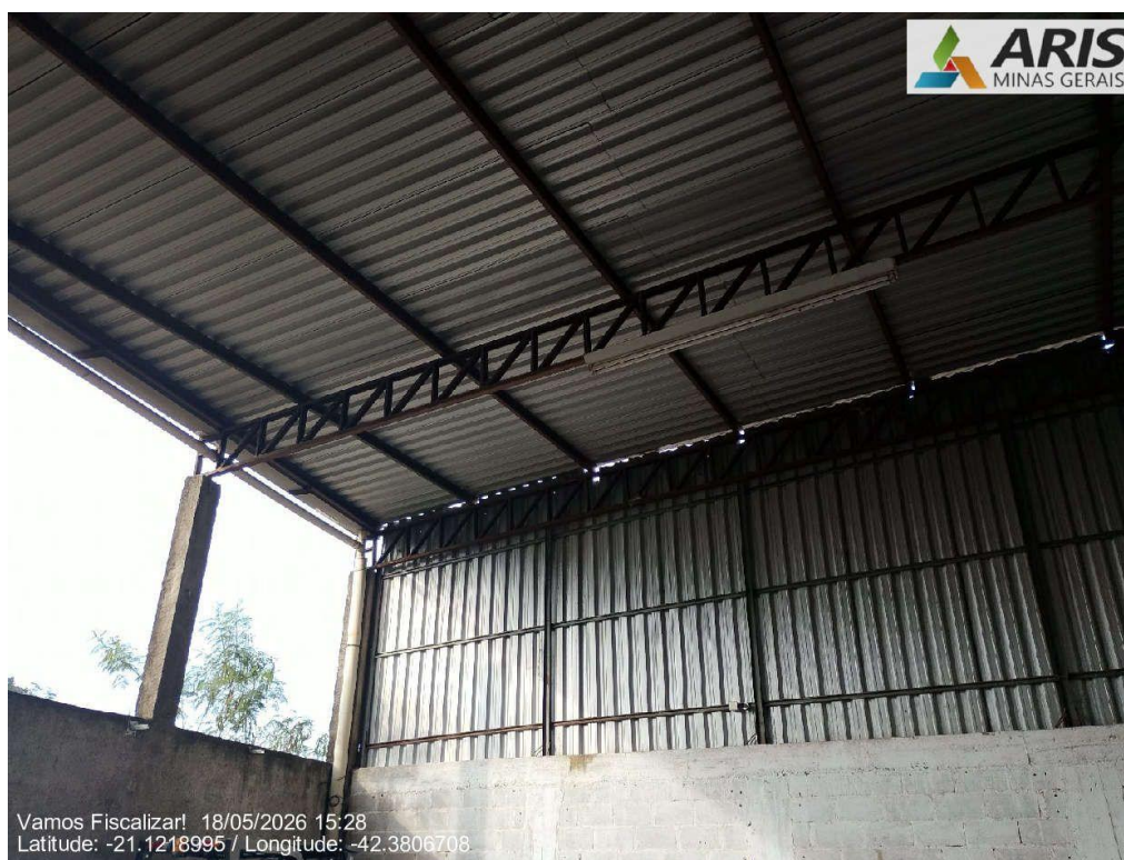
Cobertura do galpão.
