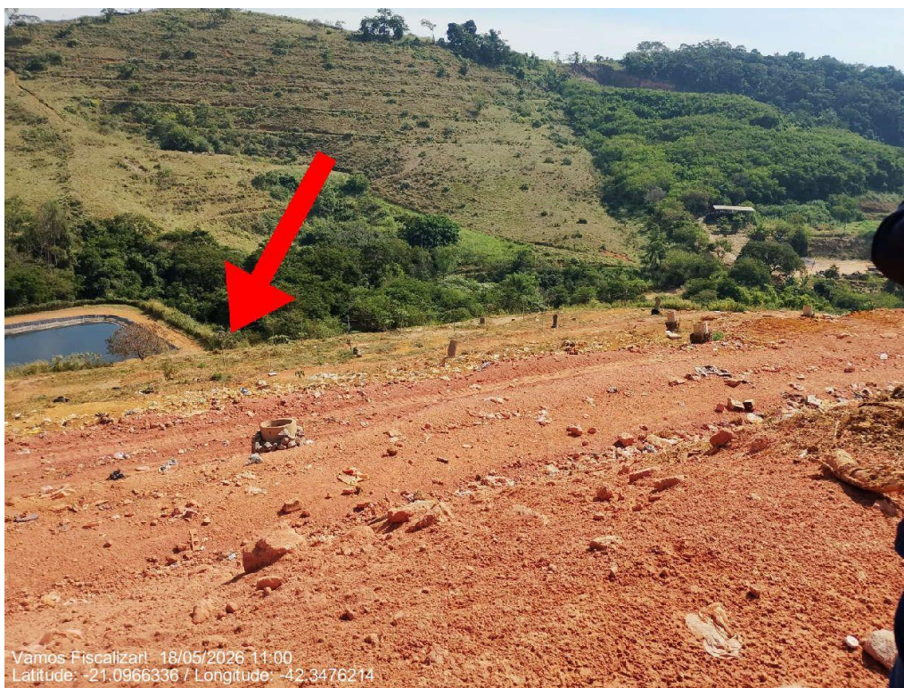
Postes na parte inferior da área do aterro.
