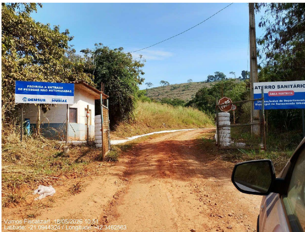
Entrada do aterro sanitário.
