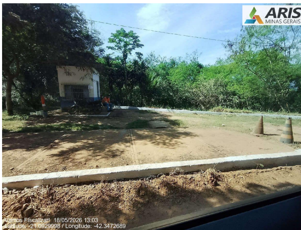
Área de pesagem com balança inoperante.
