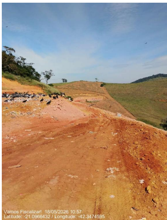
Via em solo compactado.
