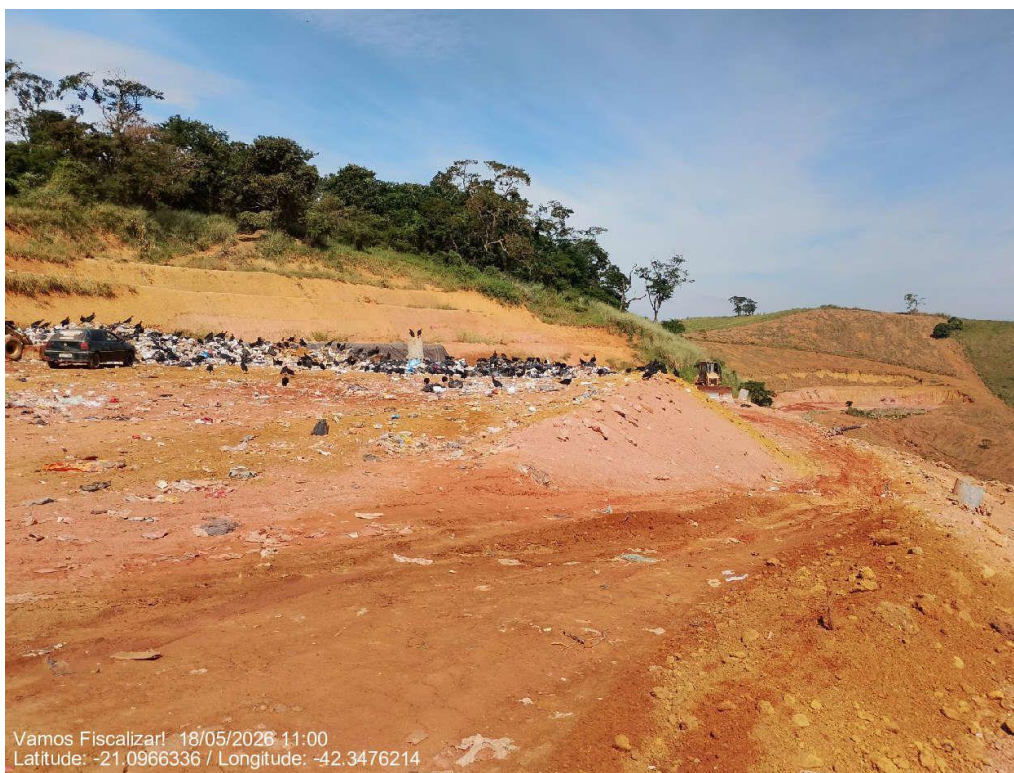
Ausência de iluminação na área operacional do aterro.
