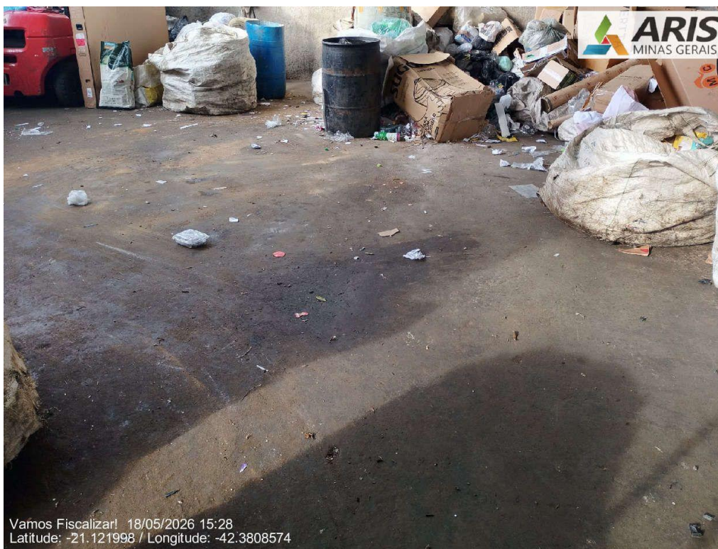
Piso impermeável em concreto.
