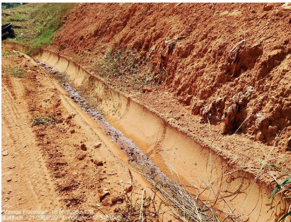
Canaleta de água pluvial.
