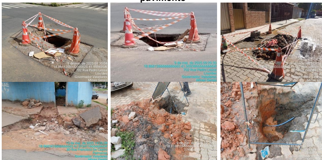
Figura 2 – Constatação de problemas no processo de recuperação do pavimento
