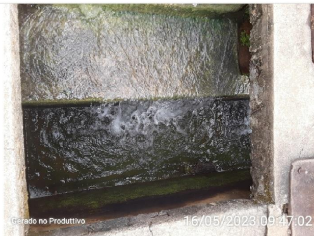
Passagem da água do decantador para os filtros
