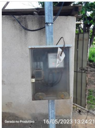
Padrão de entrada de energia do poço
