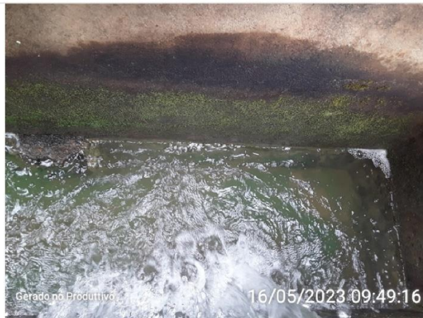
Limo na parede do decantador
