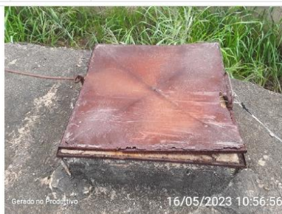
Tampa de inspeção oxidada
