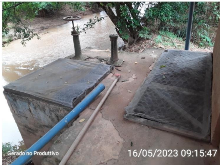
Proteção com tela no ponto de captação
