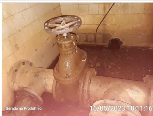
Vazamentos nas válvulas dos filtros
