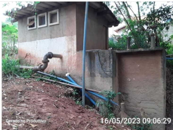
Estrutura da captação superficial e EEAB
