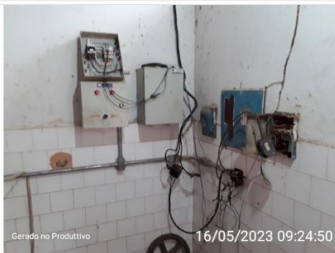
Quadros abertos e com fiação exposta
