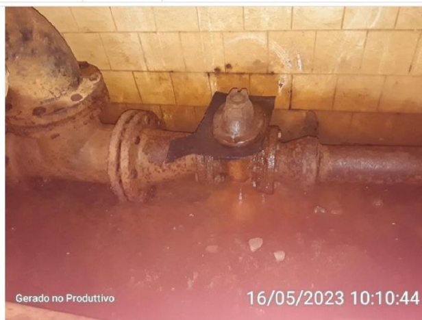
Vazamentos nas válvulas dos filtros
