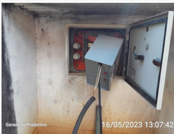
Quadro de comando mal fixado e fiação exposta
