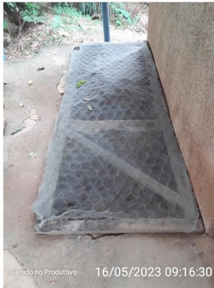
Proteção com tela no ponto de captação
