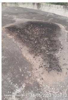
Indício de acúmulo de água na cobertura
