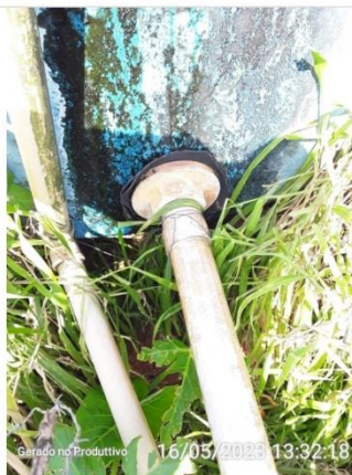
Vazamento no flange
