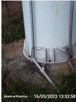
Registro de fechamento na saída do reservatório
