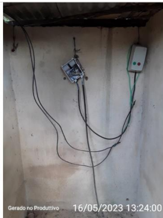
Cabos elétricos expostos no comando da captação
