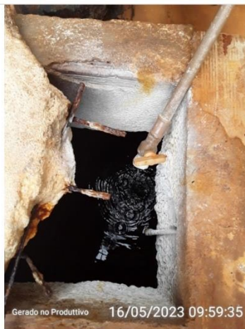
Dosagem do Cloro no tanque de contato
