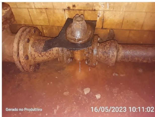
Paliativo para diminuir os vazamentos
