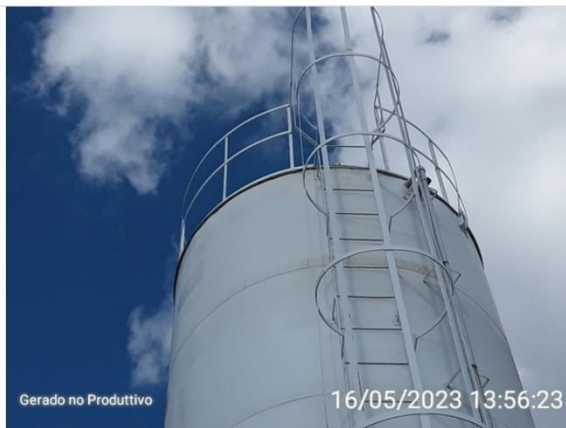
Proteção de guarda corpo na cobertura
