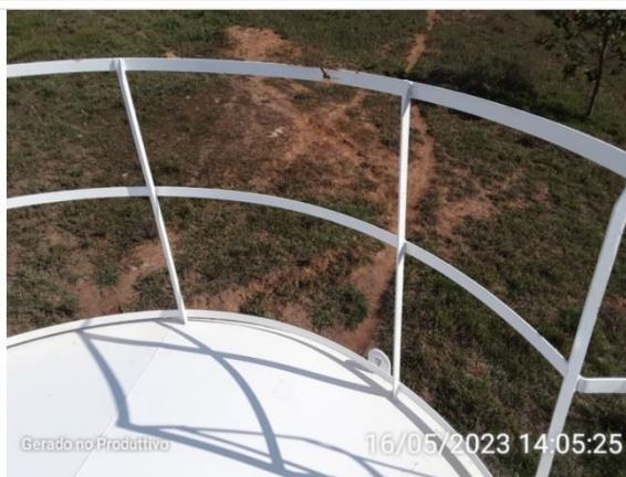
Guarda corpo na cobertura do reservatório
