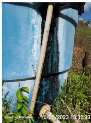
Vazamento aparente
