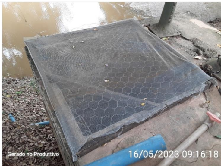
Proteção com tela no ponto de captação
