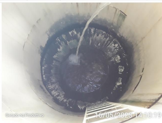
Necessidade de limpeza do reservatório
