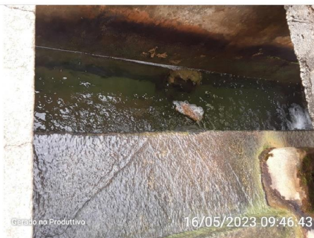
Passagem da água do decantador para os filtros
