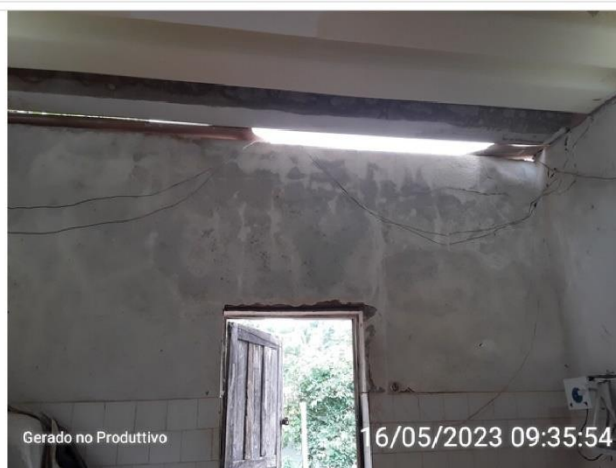
Telhado quebrado
