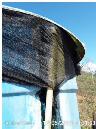
Vazamento aparente
