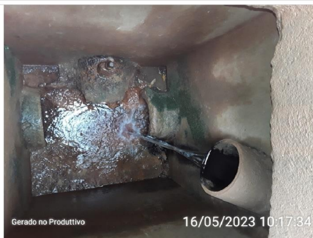
Vazamentos nas válvulas dos filtros
