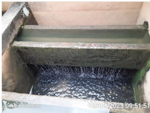
Presença de lodo na parede do filtros
