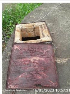
Tampa de inspeção oxidada
