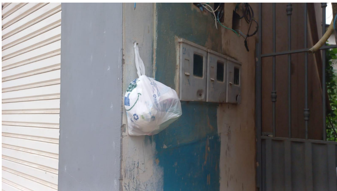
Acondicionamento em sacola plástica suspensa.
