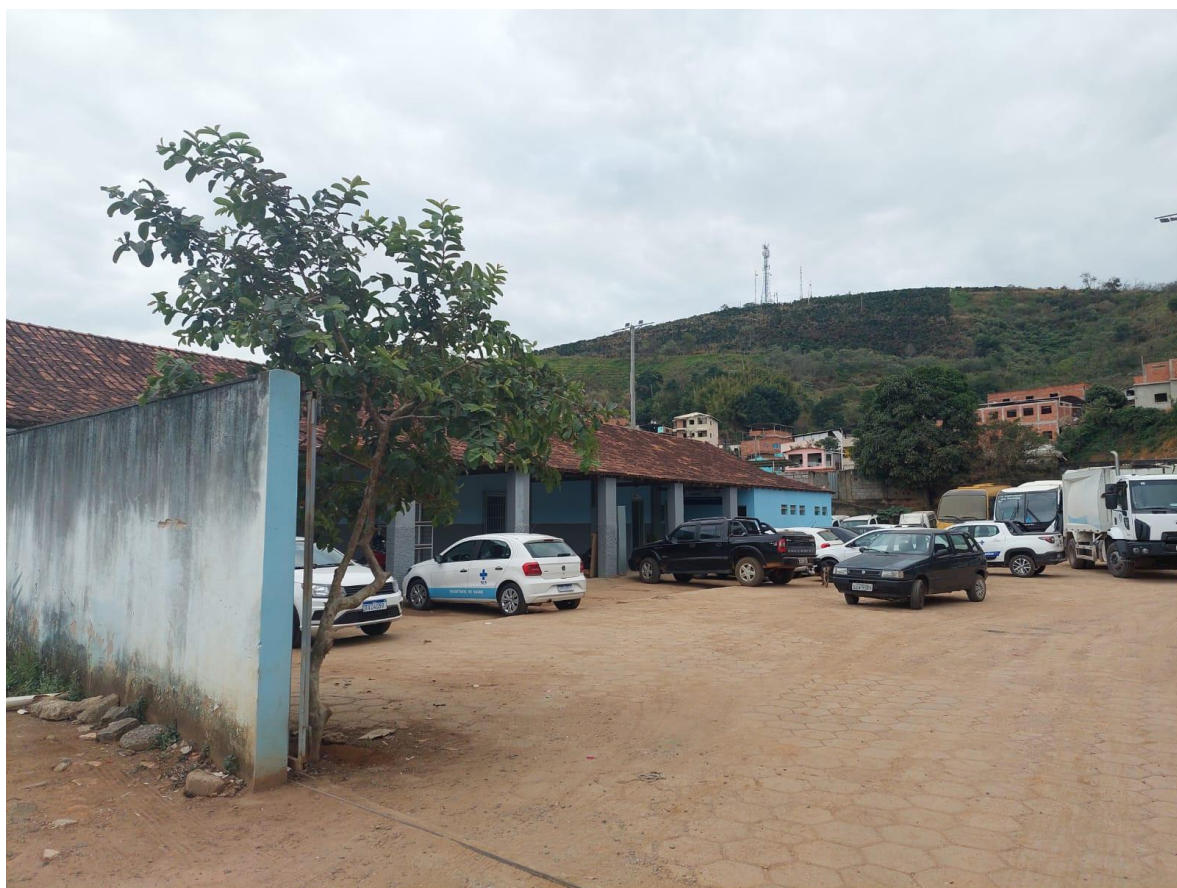
Sala de atendimento ao público no pátio da prefeitura municipal.
