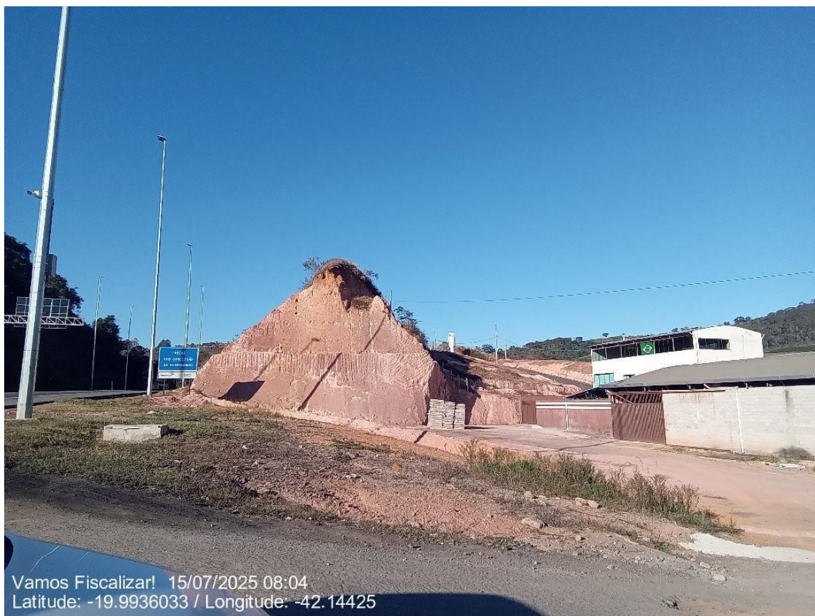
Área I - Antigo lixão próximo ao pedágio na entrada do município, que se encontra aterrado e com construções.
