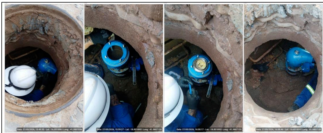
Figura 3. Manutenção ventosas da linha do trevo.
