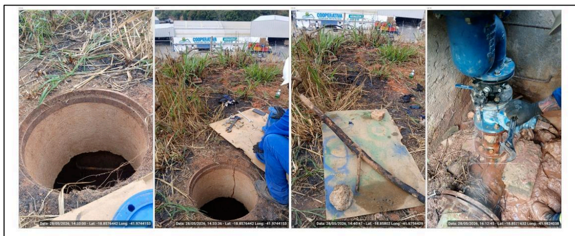
Figura 4. Manutenção ventosas da linha do trevo.
