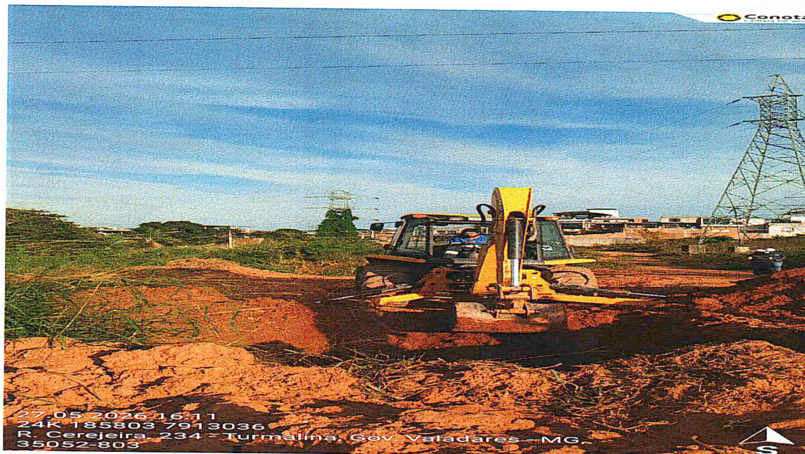
Foto 01: Detalhe das equipes de manutenção da concessionária atual atuando no reparo da adutora DN 250mm que nesse trecho caminha no pasto, próximo a rua Ângico-bairro Turmalina.
