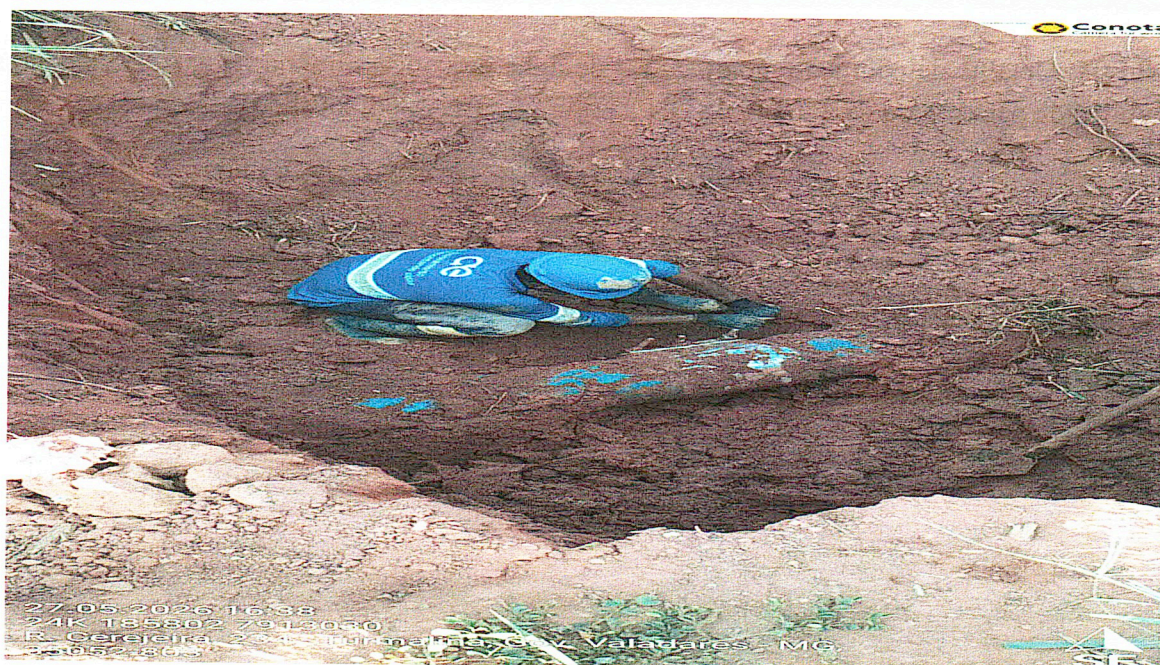
Foto 01: Detalhe das equipes de manutenção da concessionária atual atuando no reparo da adutora DN 250mm que nesse trecho caminha no pasto, próximo a rua Ângico-bairro Turmalina.
