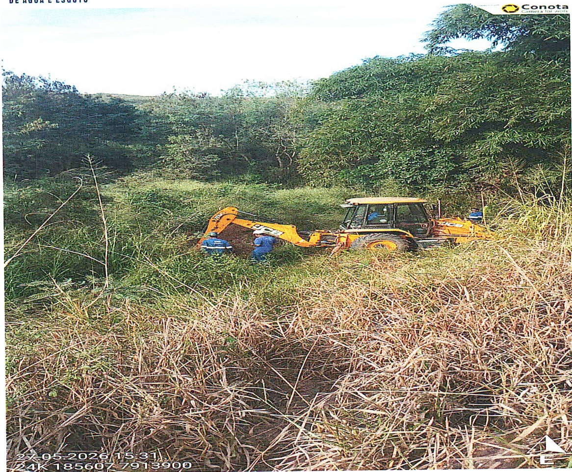
Foto 03: Detalhe da equipe de manutenção de água da concessionária Águas de Valadares, mobilizada para reparo da adutora de DN 250mm, no pasto, em local de difícil acesso.
