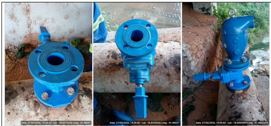
Figura 2. Instalação de ventosa na linha do jardim do trevo.
