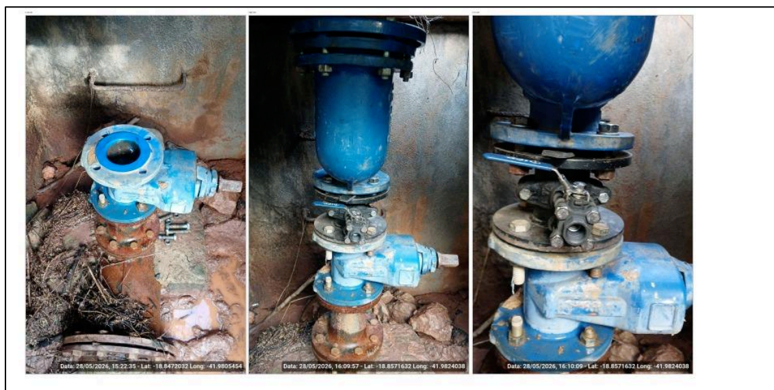
Figura 5. Manutenção ventosas da linha do trevo.
