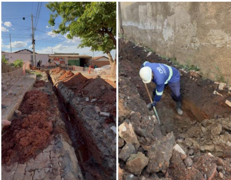
Figura 5: Execução das obras de extensão de rede de água no bairro Palmeiras.
