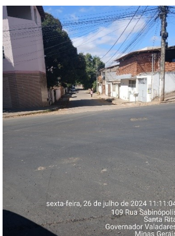
Figura 7 – PV coberto pelo recapeamento asfalto
