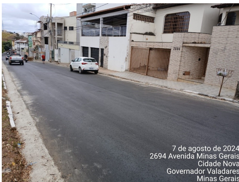
Figura 37 – PV coberto pelo recapeamento asfalto
