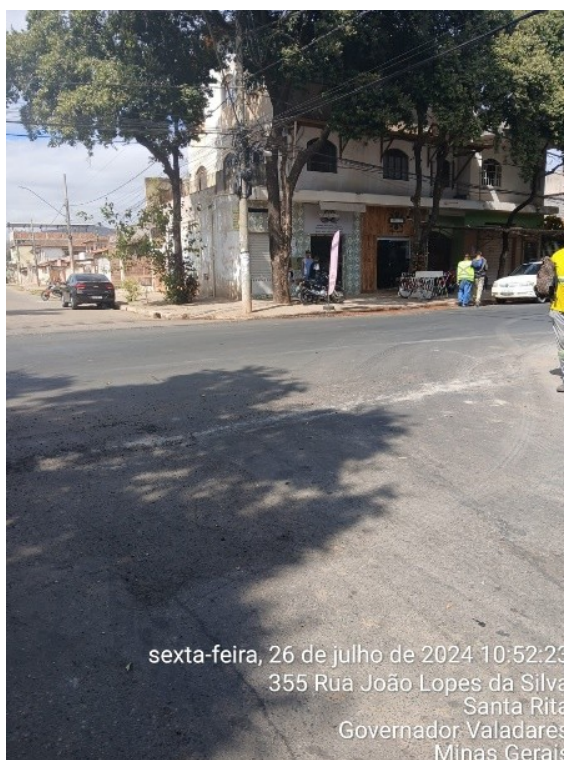
Figura 23 – PV s coberto pelo recapeamento asfalto
