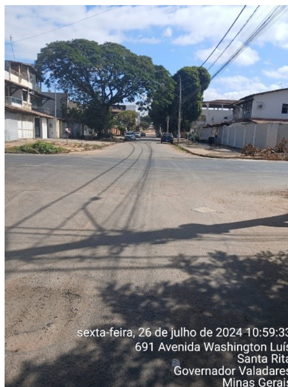
Figura 17 – PV s coberto pelo recapeamento asfalto
