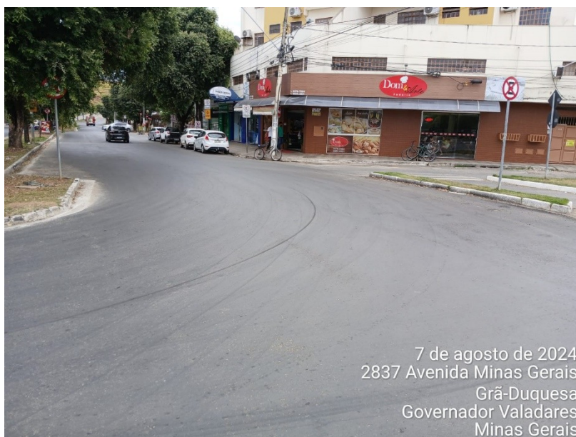
Figura 43 – PV coberto pelo recapeamento asfalto
