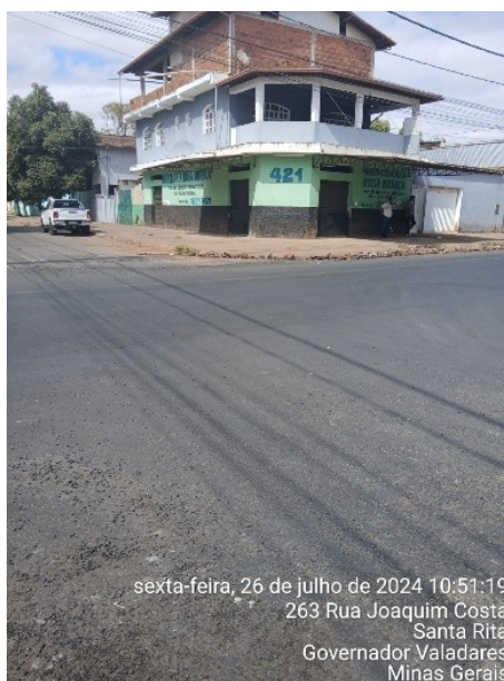
Figura 25 – PV coberto pelo recapeamento asfalto
