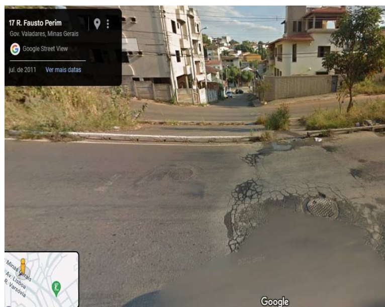
Figura 30 – PV aparente na via
