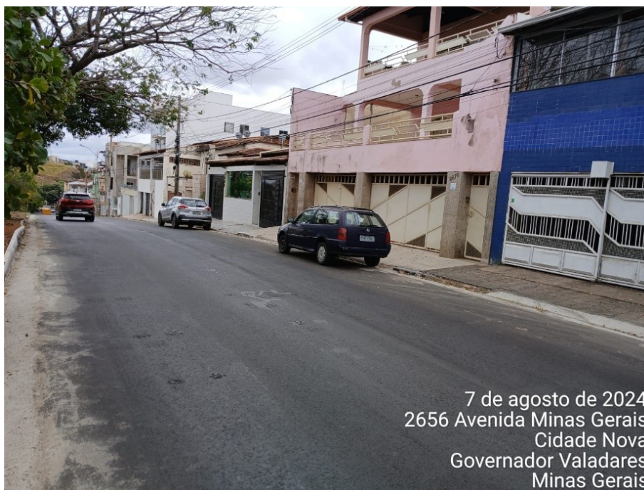
Figura 35 – PV coberto pelo recapeamento asfalto
