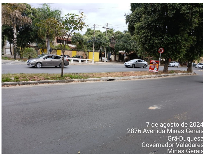
Figura 45 – PV coberto pelo recapeamento asfalto
