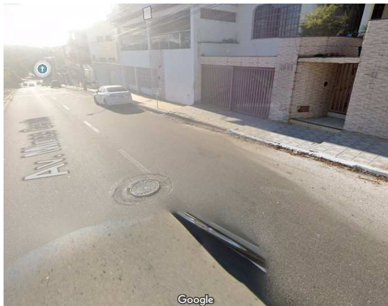
Figura 36 – PV aparente na via
