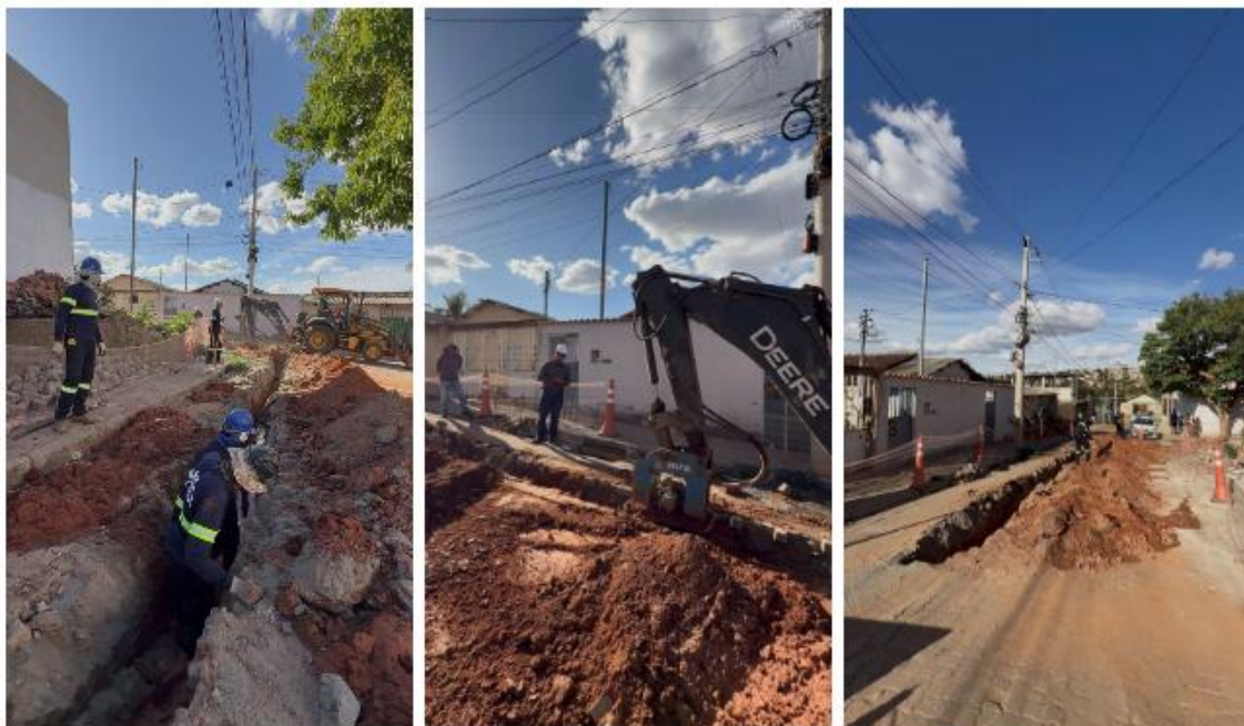
Figura 4: Execução das obras de extensão de rede de água no bairro Palmeiras.
