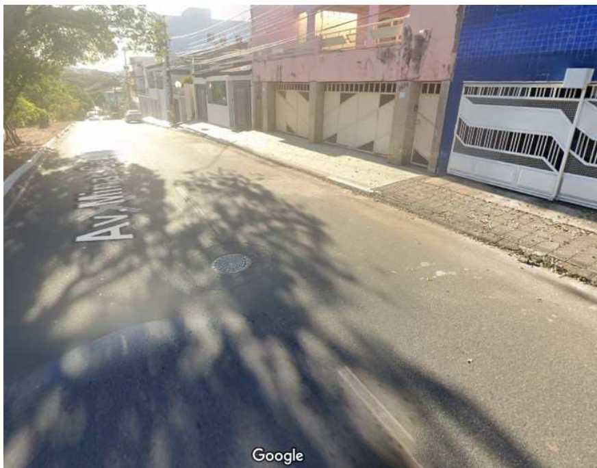
Figura 34 – PV aparente na via
