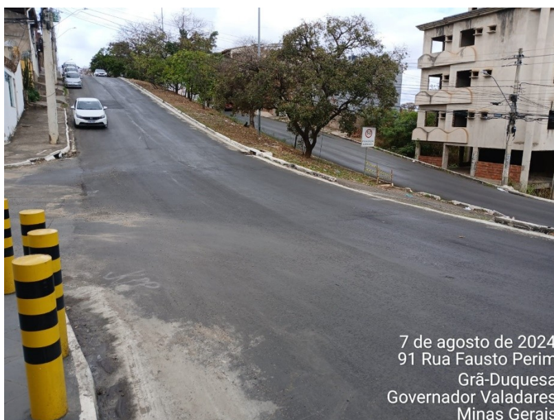
Figura 31 – PV coberto pelo recapeamento asfalto
