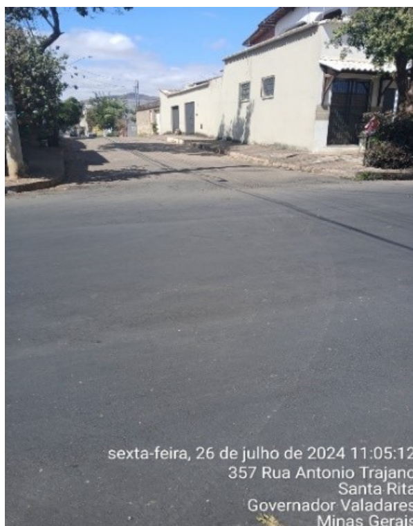
Figura 15 – PV s coberto pelo recapeamento asfalto
