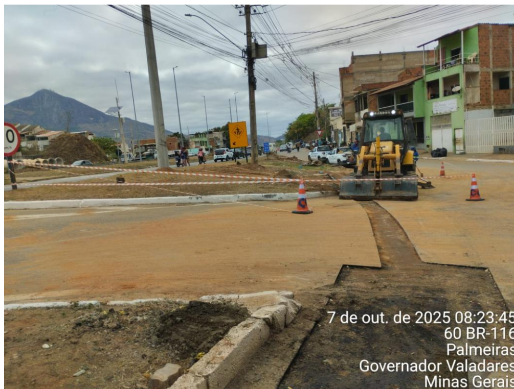
Figura 6: Finalização das obras de extensão de rede de água, em 7 de outubro de 2025.
