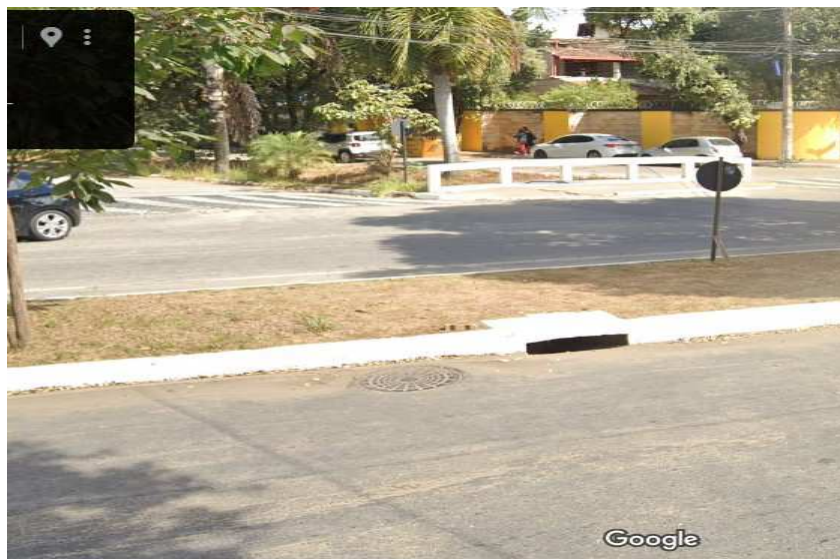
Figura 44 – PV aparente na via
