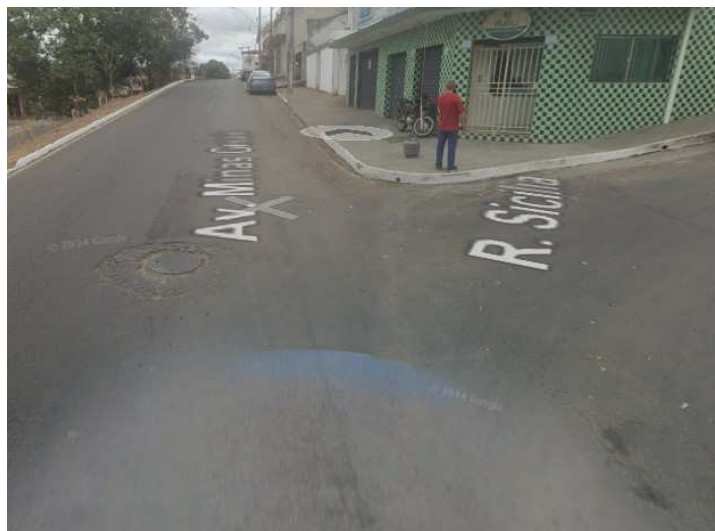
Figura 26 – PV aparente na via
