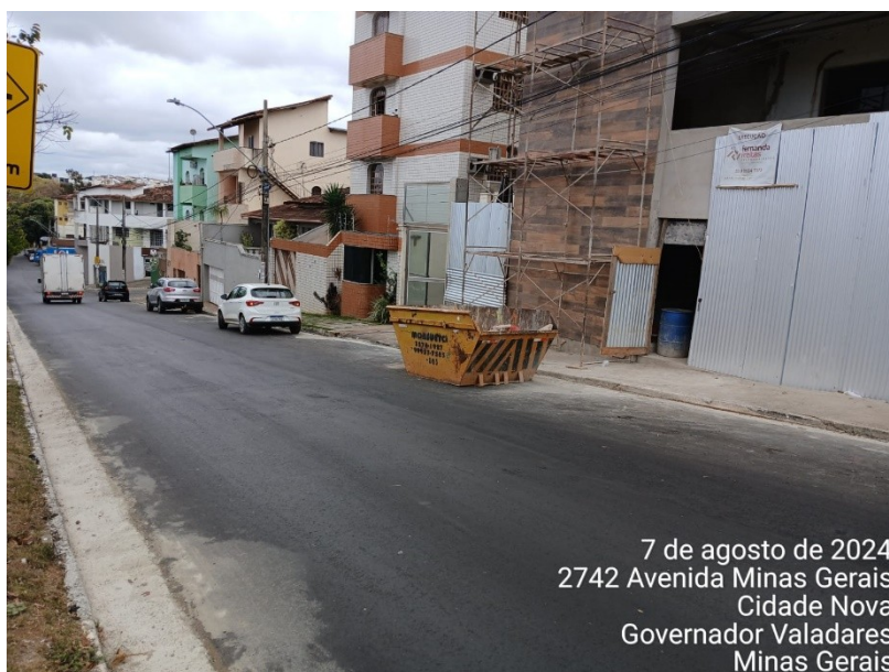
Figura 39 – PV coberto pelo recapeamento asfalto
