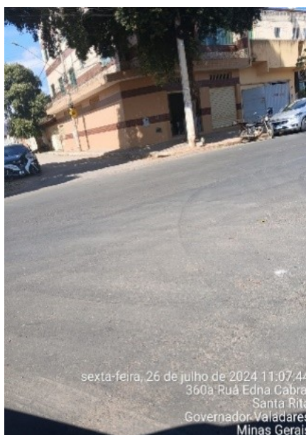
Figura 13 – PV s coberto pelo recapeamento asfalto
