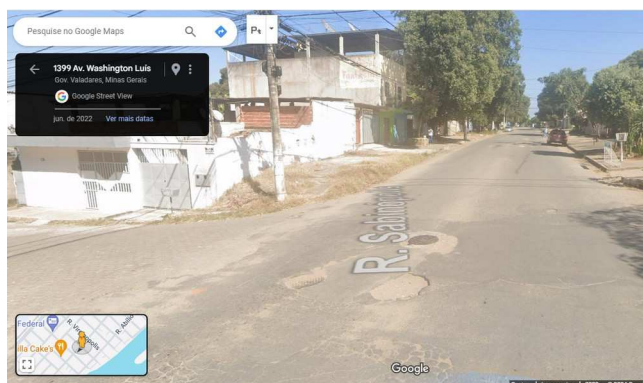
Figura 6 – PV aparente na via
