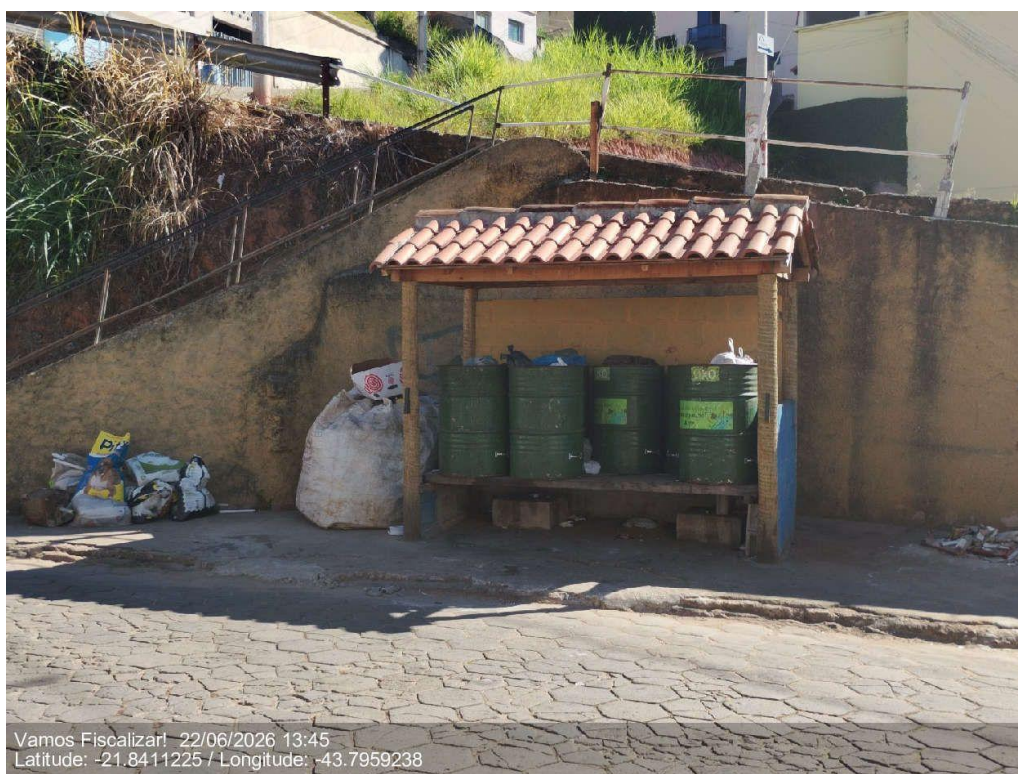
"Casinha" de disposição dos resíduos (Rua Geraldo Magela).
