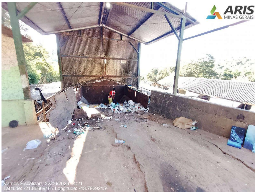
Área de recepção de resíduos.
