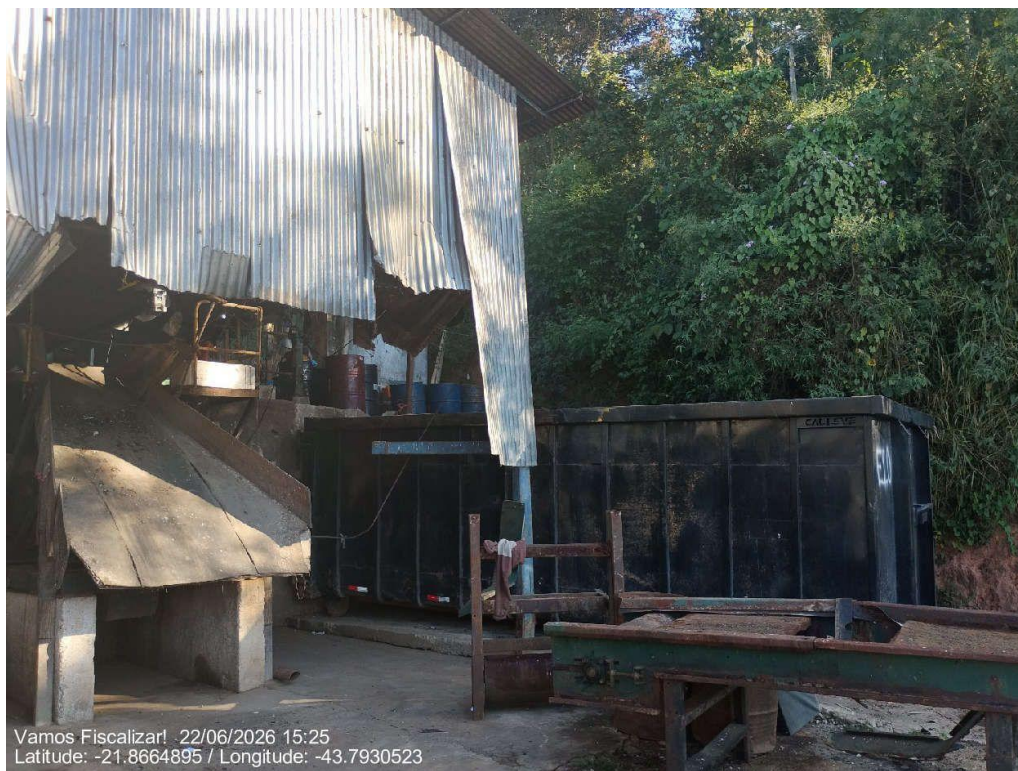
Vista geral da área do transbordo
