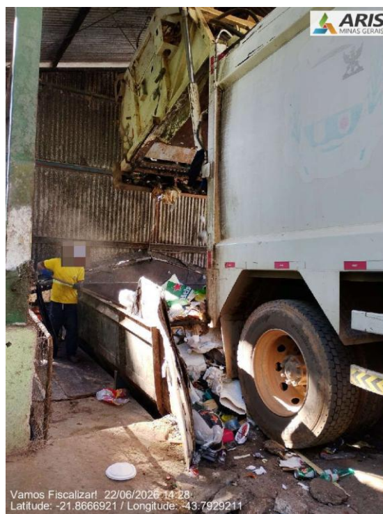
Caminhão descarregando o resíduo no funil de escoamento e situação de transbordamento.
