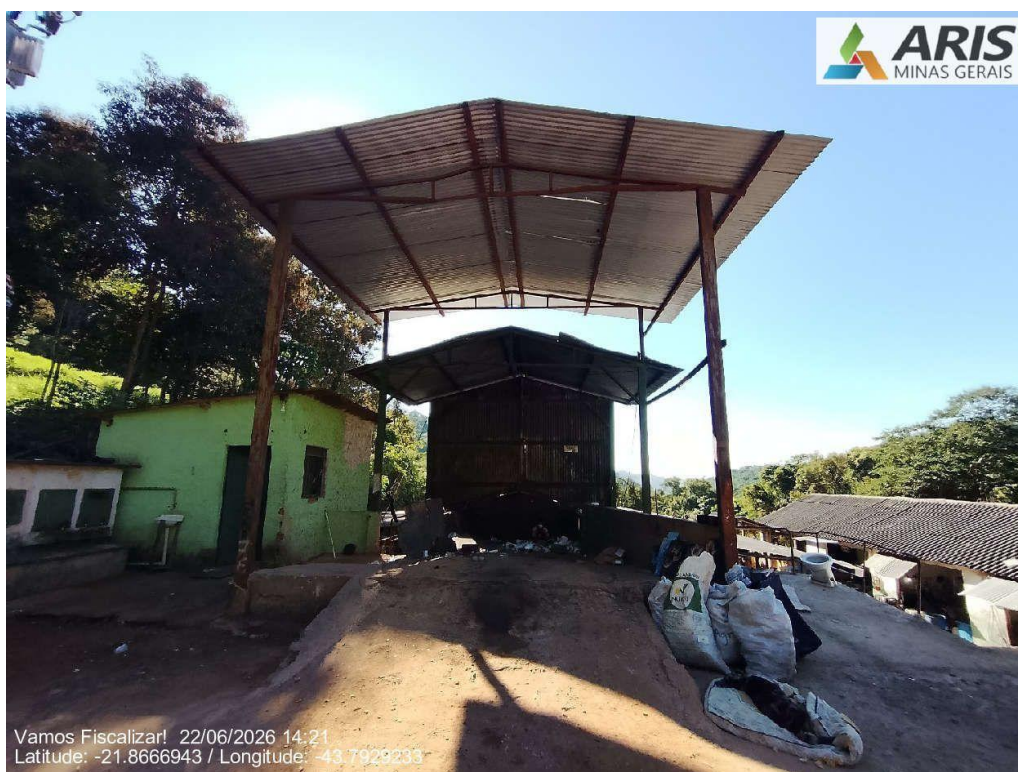
Vista geral da entrada do caminhão compactador
