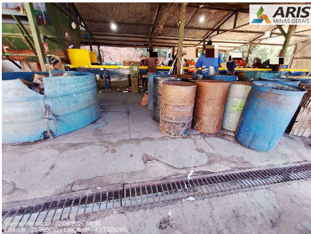
Piso impermeável na área de recepção e manejo dos resíduos.
