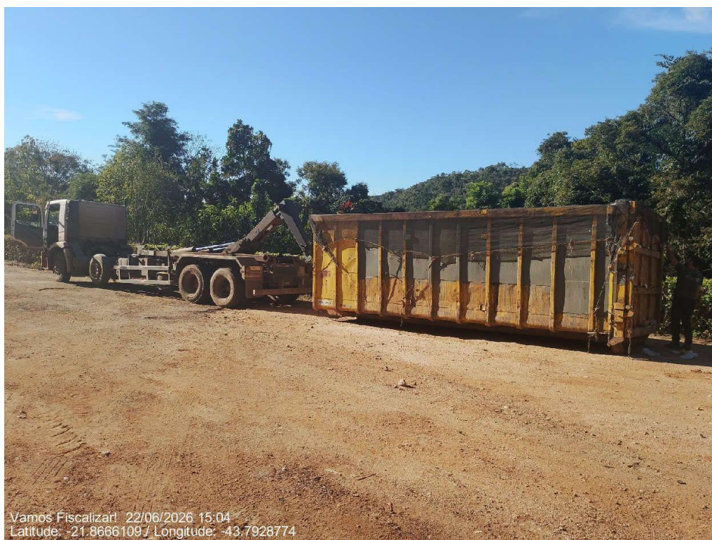
Transporte do contêiner de rejeito cheio (rede sobre contêiner)
