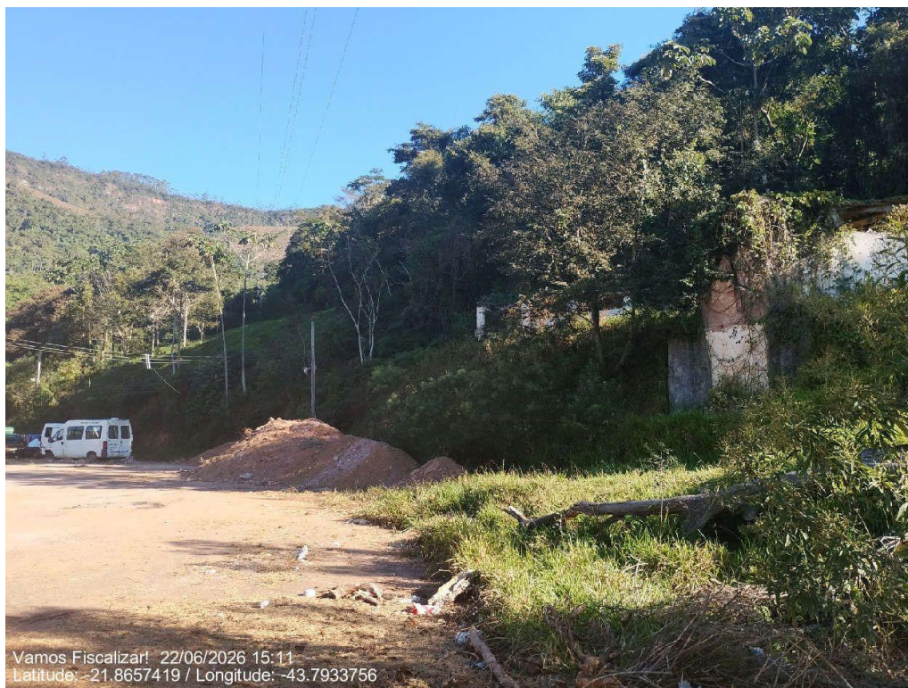
No entorno da área de transbordo
