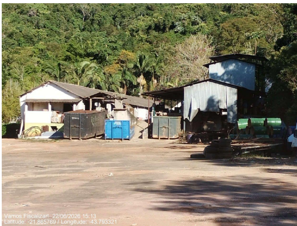
Vista geral da área de transbordo
