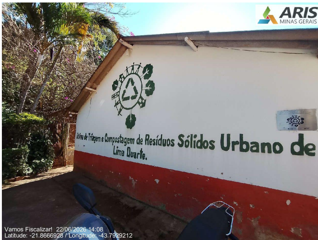
Fachada da UTR.
