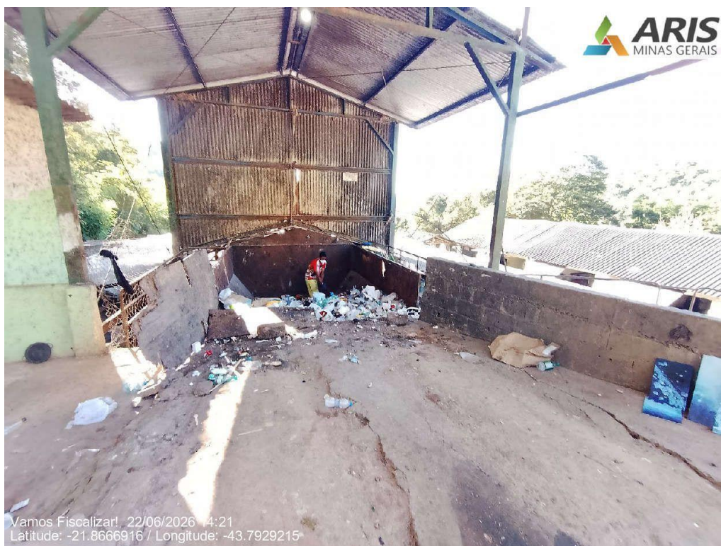
Chegada dos resíduos
