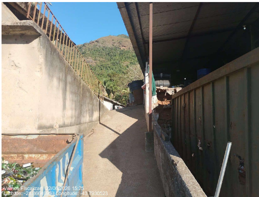
Vista geral da área do transbordo
