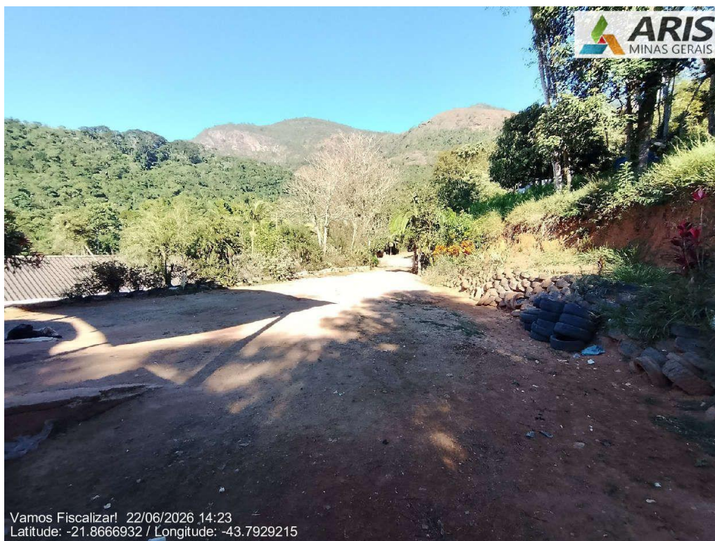
Pátio de manobras da UTR.
