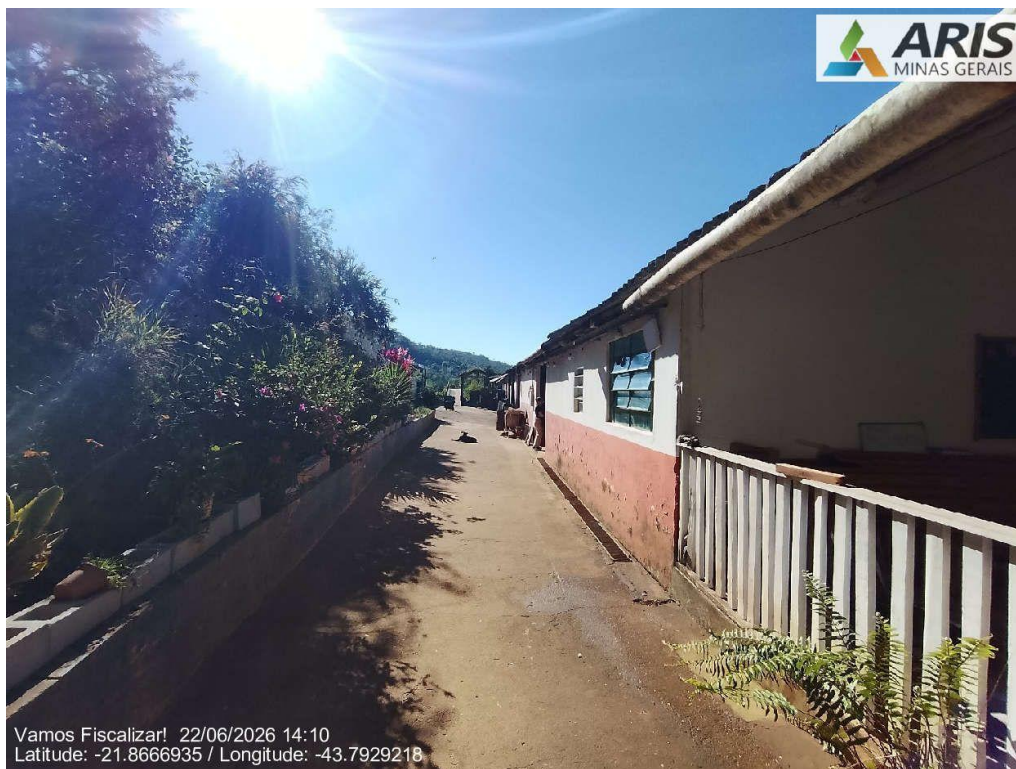
Acesso a área da UTR.
