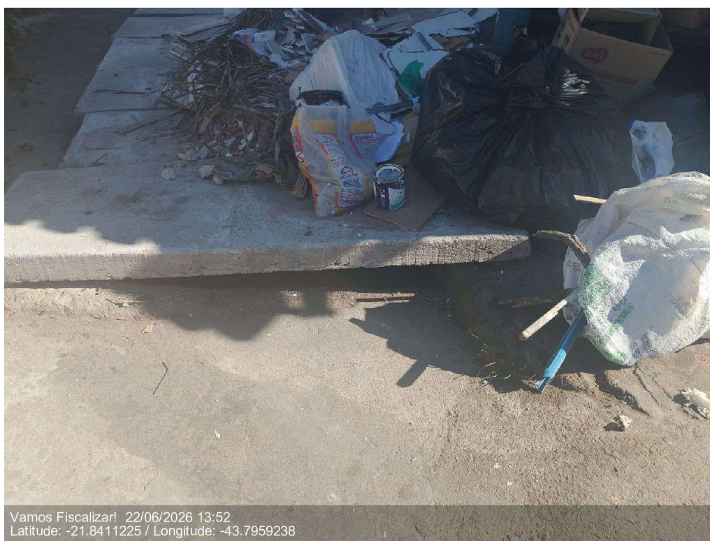
Disposição de resíduos em cima da estrutura de drenagem.
