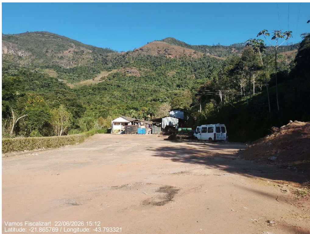
Vista geral da área de transbordo
