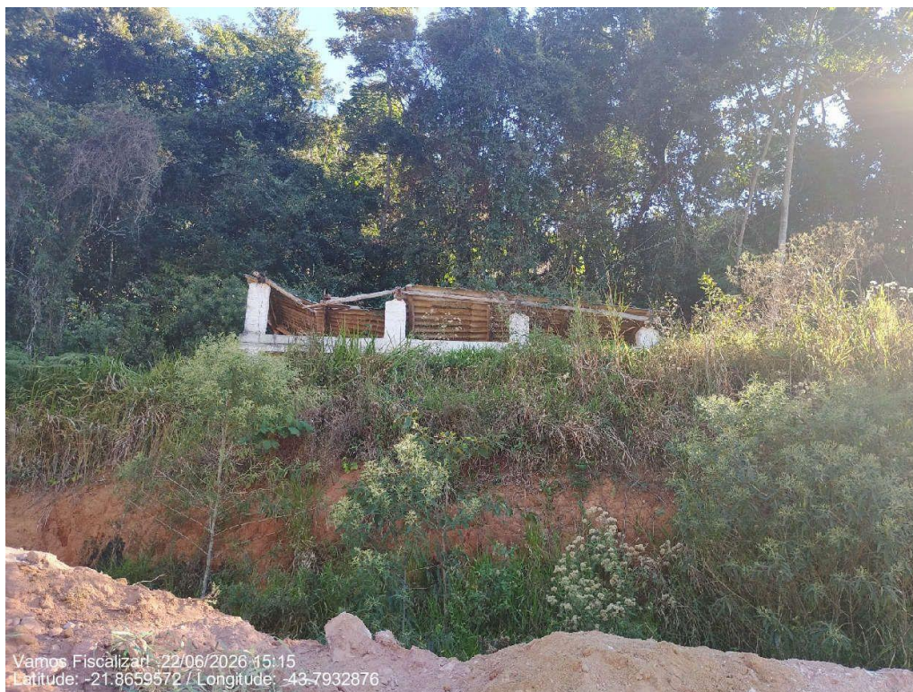
Área desativada de disposição de materiais perfurocortantes
