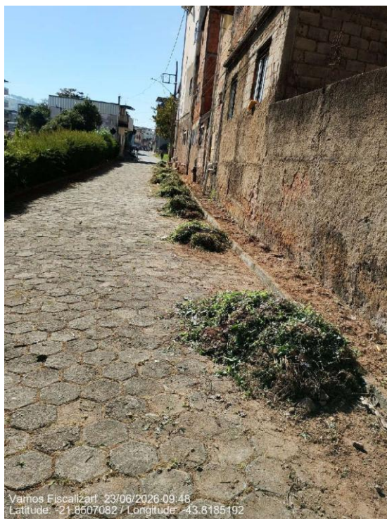
Pilha de resíduos vegetais da poda e capina
