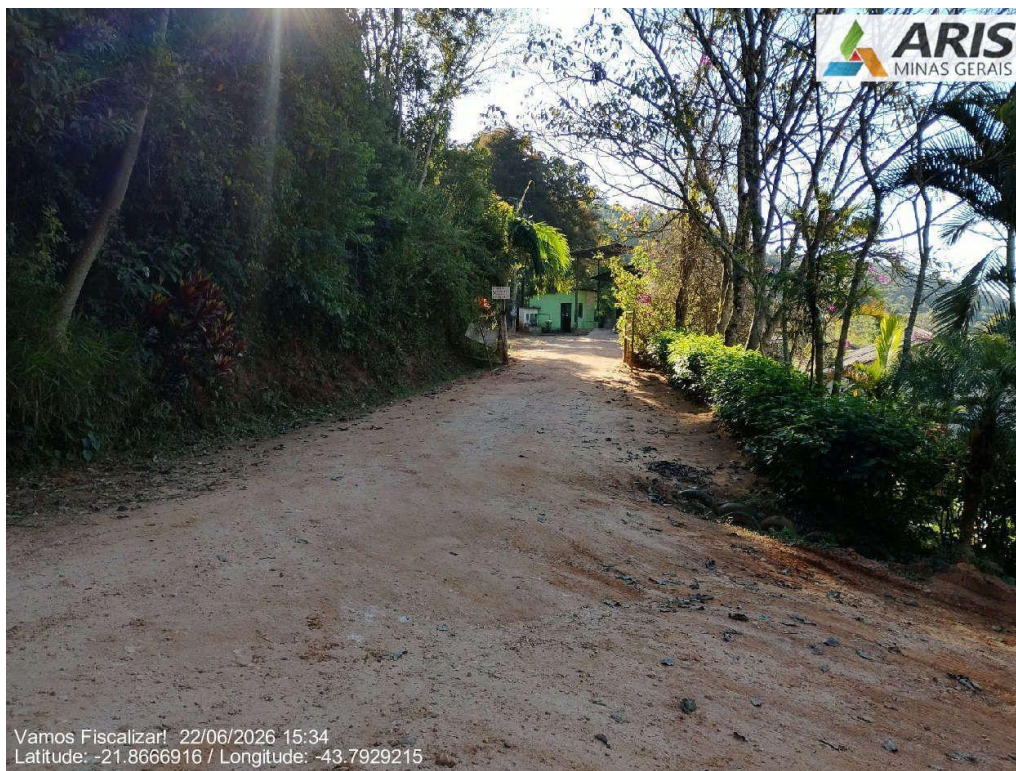
Acesso não pavimentado.
