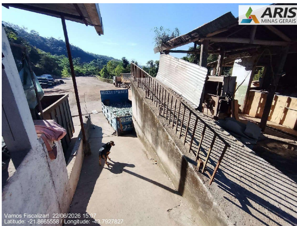
Rampa de acesso para descarte de vidro.
