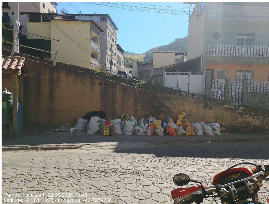
Descarte de RCC ao lado da "casinha".
