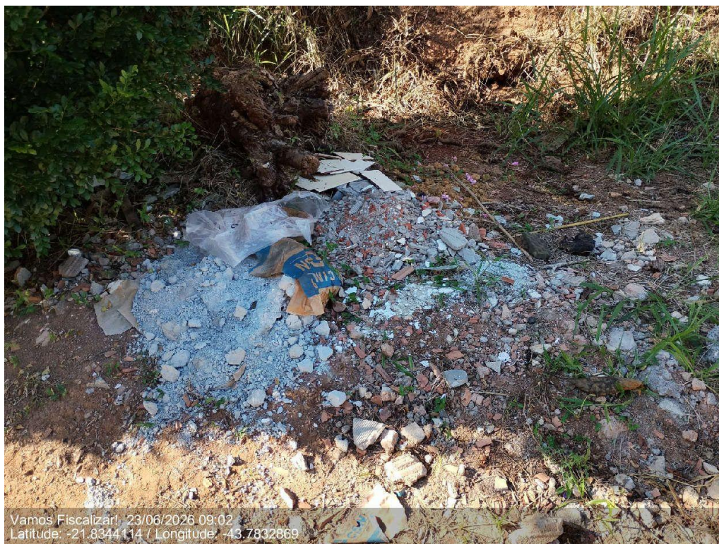
Descarte irregular de RCC em calçada.
