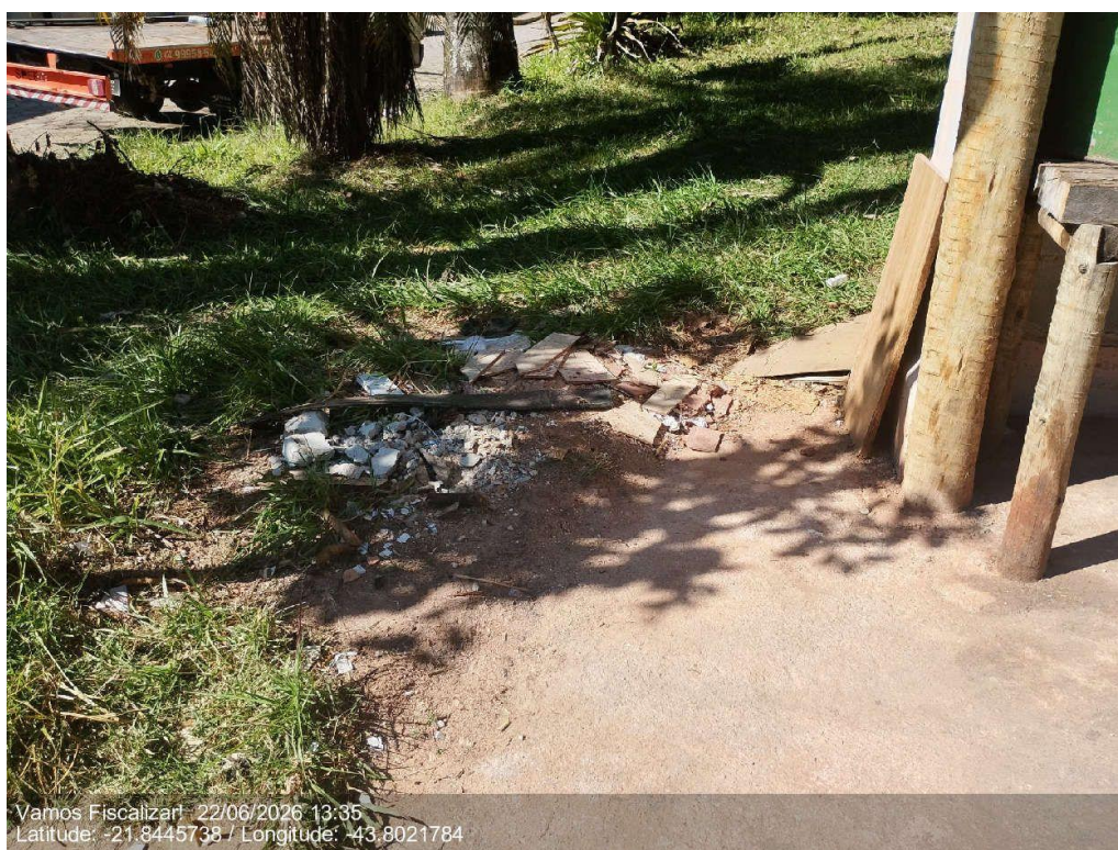
Disposição de resíduos de construção civil ao lado da "casinha".
