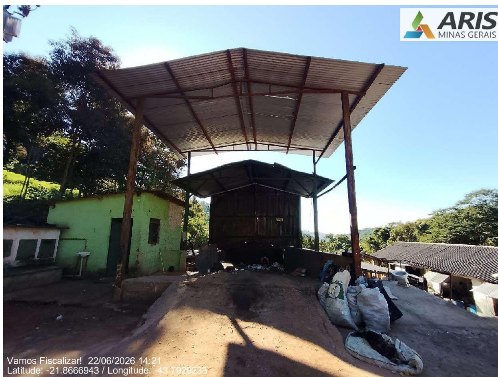
Área de recepção de resíduos.
