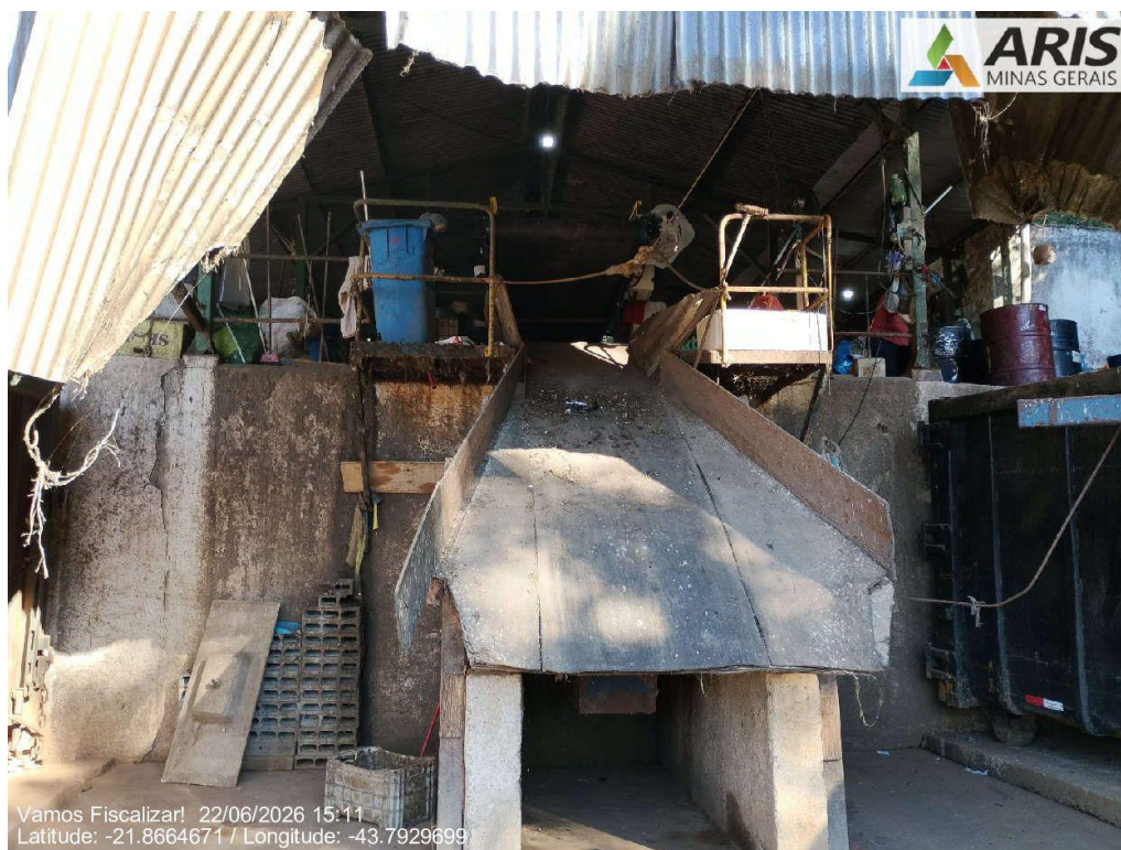
Final da mesa de triagem e rampa para jogar resíduos dentro do contêiner (local sem cobertura).
