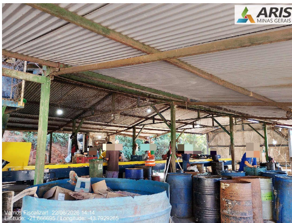
Cobertura do galpão na área da triagem.
