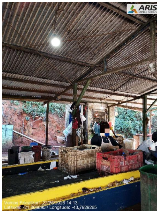
Cobertura do galpão na área da triagem.
