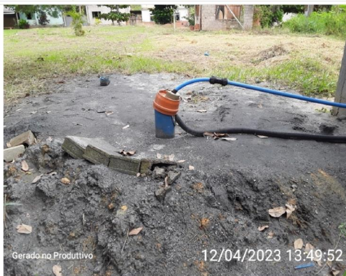
Ausência de laje sanitária
