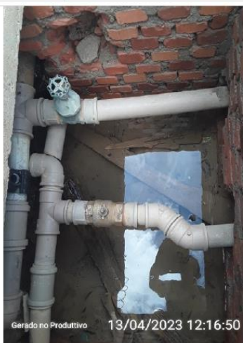
Registros nas saídas do reservatório
