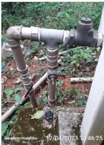
Válvula de fechamento na saída do reservatório
