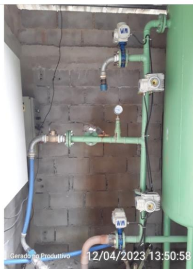
Válvulas do filtro de remoção do ferro
