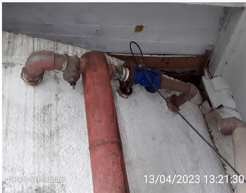
Válvula de controle de nível
