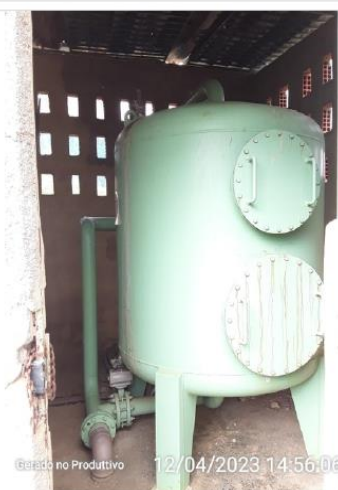
Filtro de remoção de ferro
