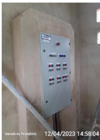
Painel elétrico do filtro e bombas de remoção do ferro.
