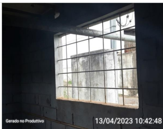
Abertura com grades para iluminação e ventilação
