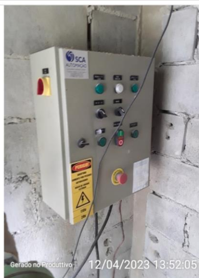
Parte elétrica do filtro de remoção
