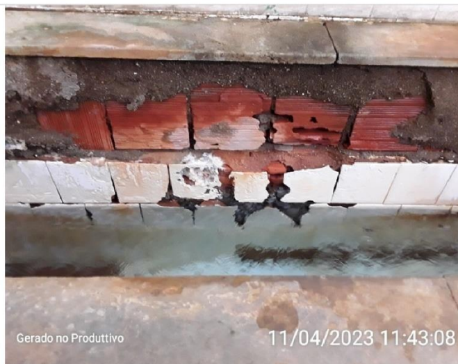
Ponto de infiltração
