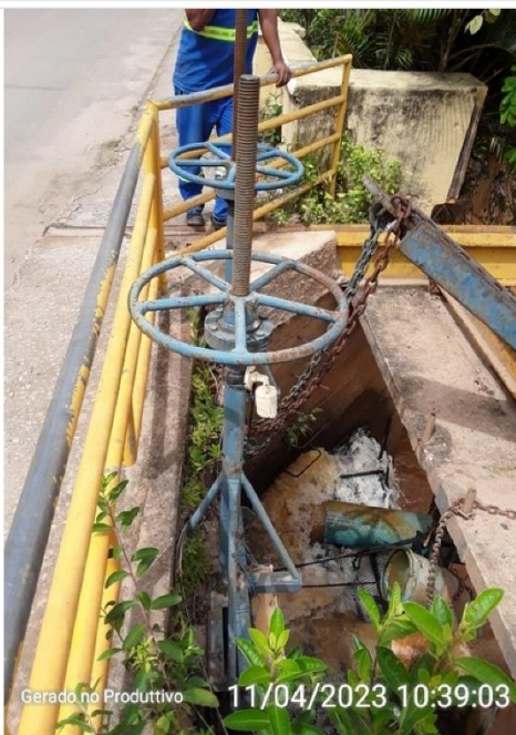
Registro para controle de vazão.
