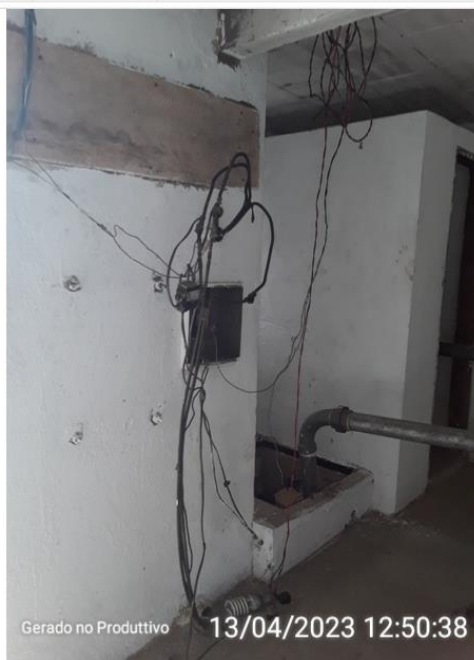
Parte elétrica emaranhados
