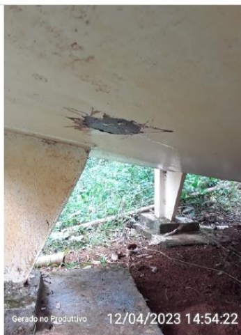
Ponto de vazamento ao fundo do reservatório
