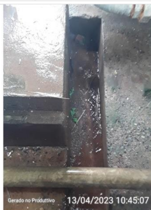
Sistema de drenagem no piso
