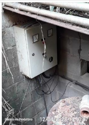
Quadro de comando na Elevatória
