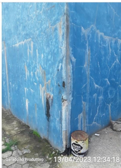
Ponto de infiltração na estrutura
