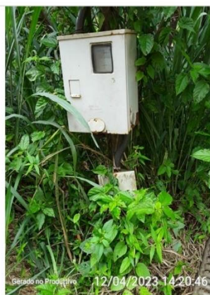
Vegetação tomando o padrão de entrada de energia
