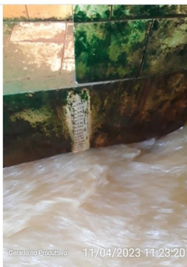
Régua de medição da Calha Parshall
