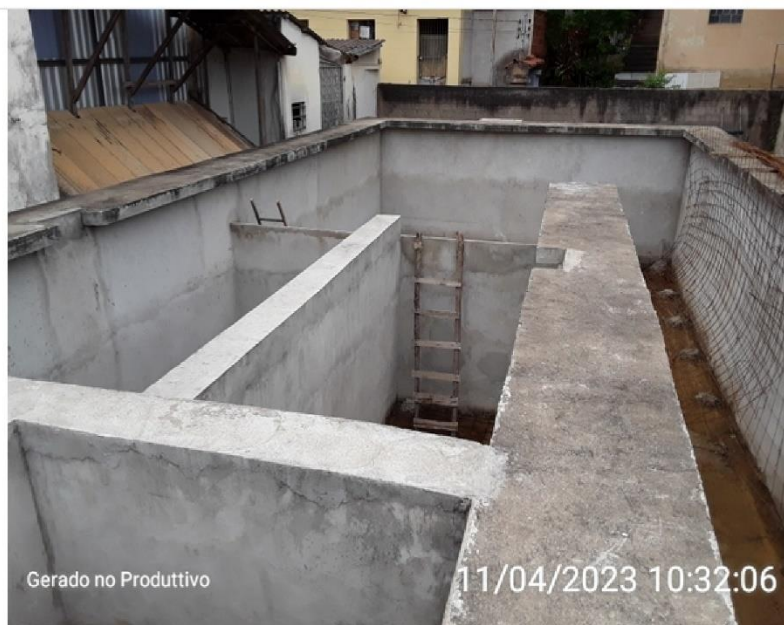
Vista superior do desarenador
