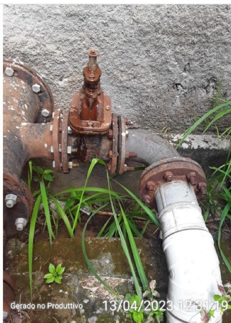
Válvula de saída e descarga
