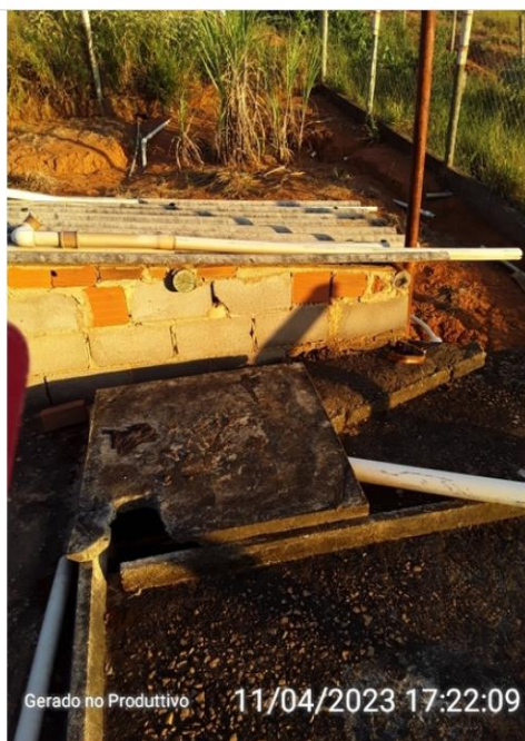
Tampa de inspeção
