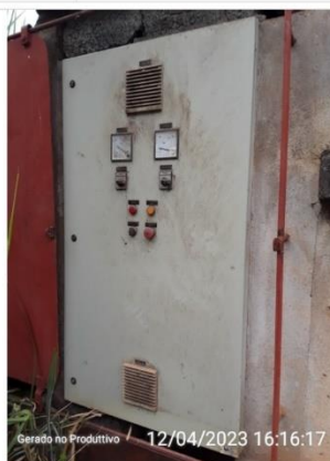
Quadro de comando superior em boa condição (externo)
