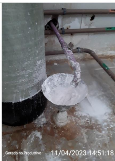
Dosadora de cloro no tanque de contato
