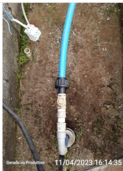
Registro para controle de vazão
