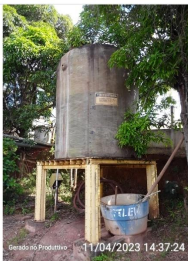
Deposito de Sulfato líquido
