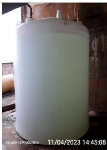
Reservação de água para preparação de cloro
