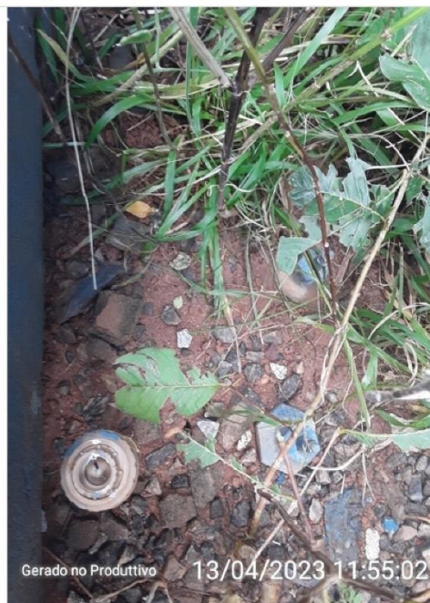
Válvula de fechamento na saída do reservatório
