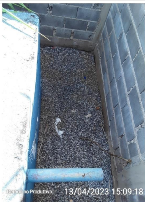
Sistema alternativo para descarga do tubo extravassor
