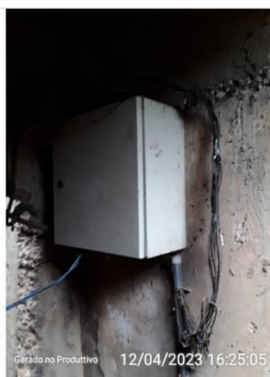
Quadro de comando superior em boa condição (externo)
