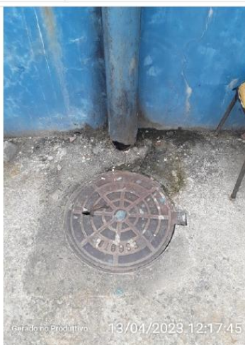
Caixa de captação da água escoada pela cobertura
