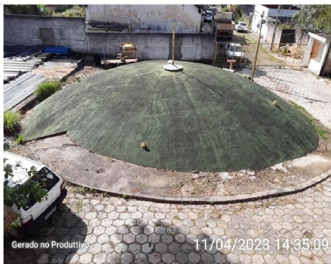
Reservatório principal de 600 m³ (função de tanque de contato)
