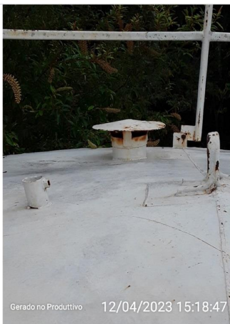
Ventilação do reservatório
