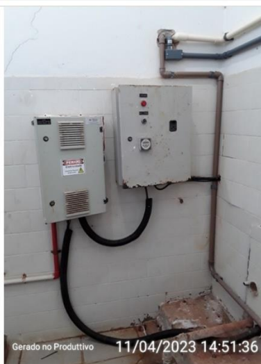
Quadro agitador do cloro
