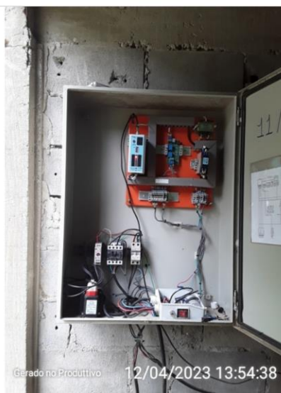
Parte elétrica da telemetria e disjuntores do poço
