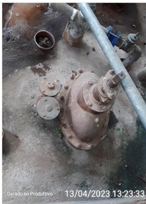
Válvula de descarga inutilizada
