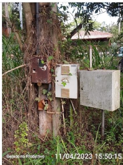
Quadros de comando do poço
