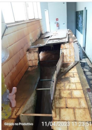
Ampla visão de Calha Parshall
