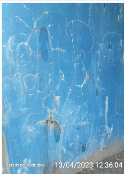
Ponto de infiltração na estrutura
