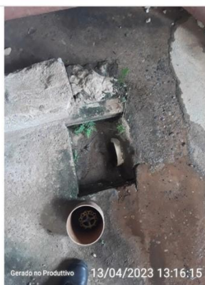
Drenagem no piso sem as grelhas
