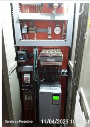
Quadro de comando bomba de limpeza do poço
