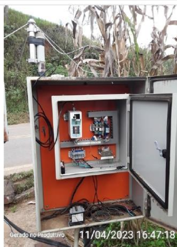
Quadro de telemetria (interno)
