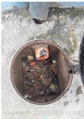
Caixa de captação da água escoada pela cobertura - interna
