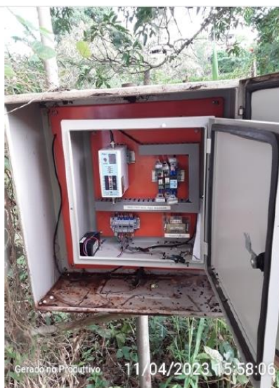
Quadro de telemetria (interno)
