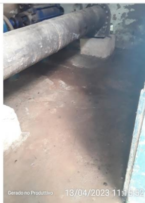
Água de vazamento empoeçada no piso da casa de bombas
