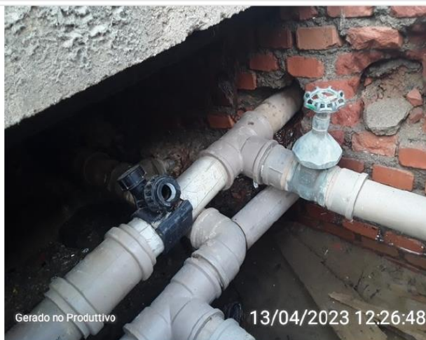
Vazamento aparente na tubulação
