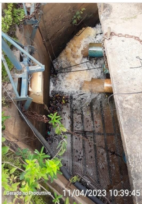
Grades no sistema de captação
