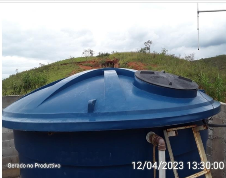
Tampa de inspeção
