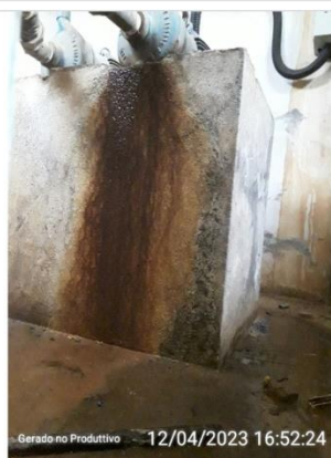
Vazamento aparente na estrutura de suporte das bombas.
