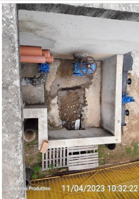
Entrada de água no desarenador
