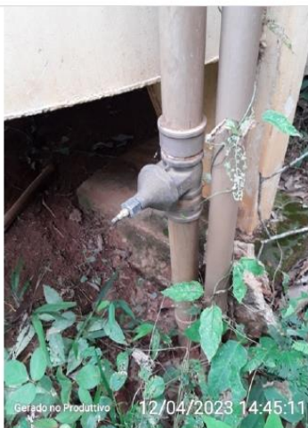
Válvula de fechamento na entrada do reservatório
