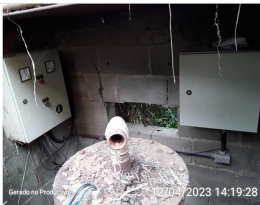
Cabos exposto na entrada dos quadros
