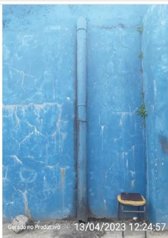
Tubo de escoamento de águas pluviais da cobertura
