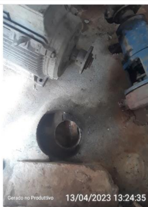
Drenagem no piso sem grelhas
