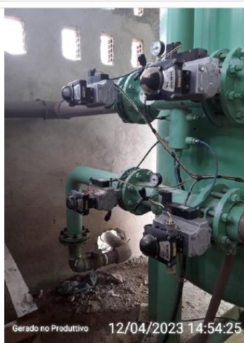
Válvulas de filtro de remoção
