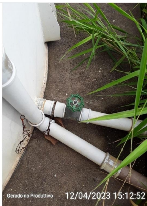
Válvula de fechamento na saída do reservatório
