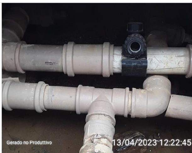
Conexões para descarga de fundo
