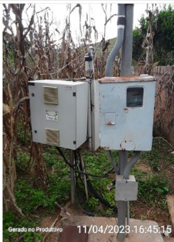
Quadros e padrão de entrada de energia
