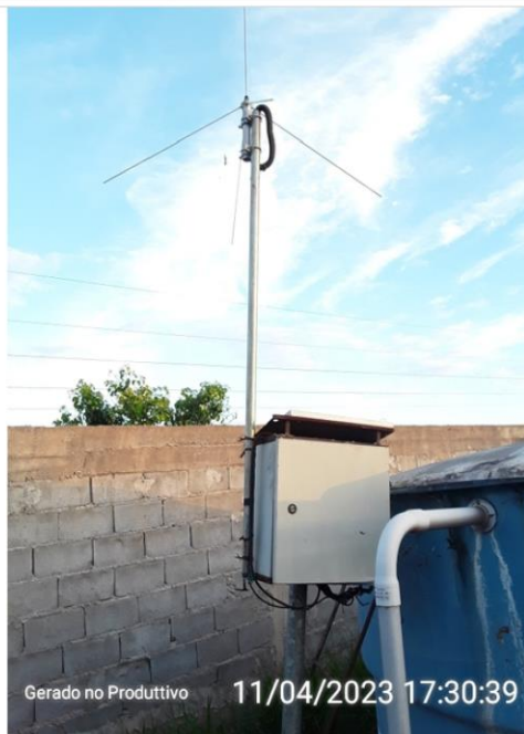
Equipamentos do sistema de telemetria
