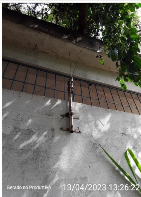
Antena de telemetria
