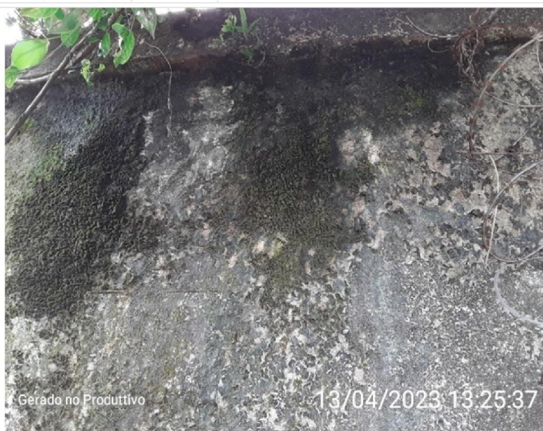
Infiltrações parte superior do reservatório
