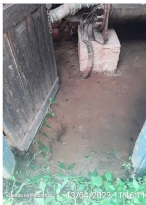
Água de vazamento empocada na entrada da casa de bombas
