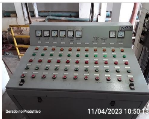
Painel de comando dos conjuntos motobomba
