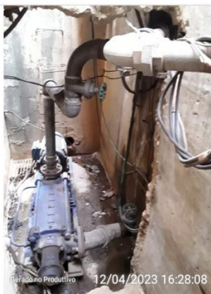
Tubulação na saída do bombeamento
