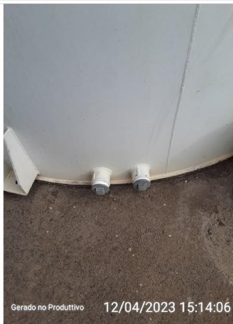
Ponto de descarga de fundo
