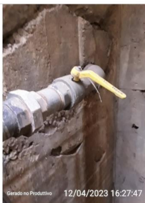
Registro na saída da elevatória
