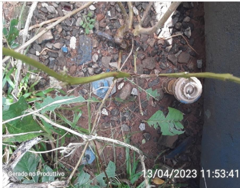
Válvula de fechamento na saída do reservatório
