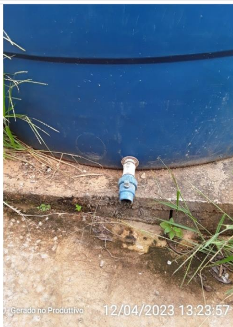
Tubo de descarga de fundo
