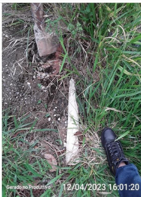
Saída do tubo extravasor para água pluvial
