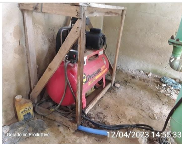
Pressurizador para realizar retrolavagem no filtro
