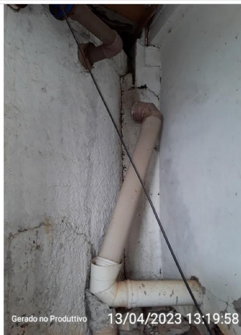
Tubo extravasor inutilizado
