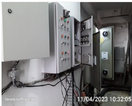
Quadro de comando das bombas submersas
