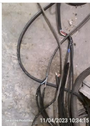
Fios elétricos expostos no chão
