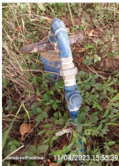
Registro para controle de vazão
