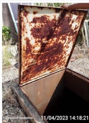
Tampa de inspeção com corrosão
