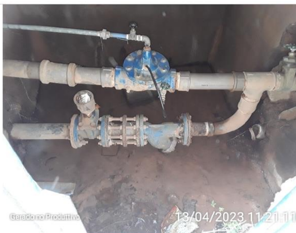
Válvula de fechamento com controle de nível
