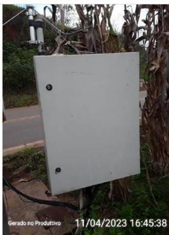
Quadro de telemetria (externo)
