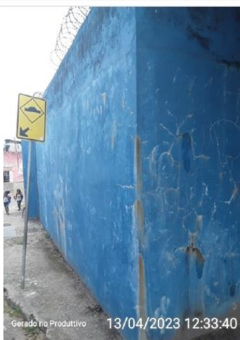
Ponto de infiltração na estrutura
