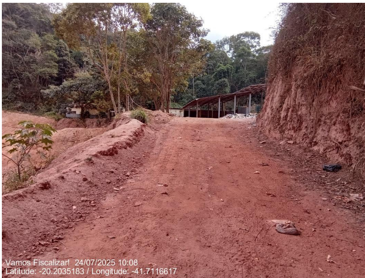
Rampa de acesso.
