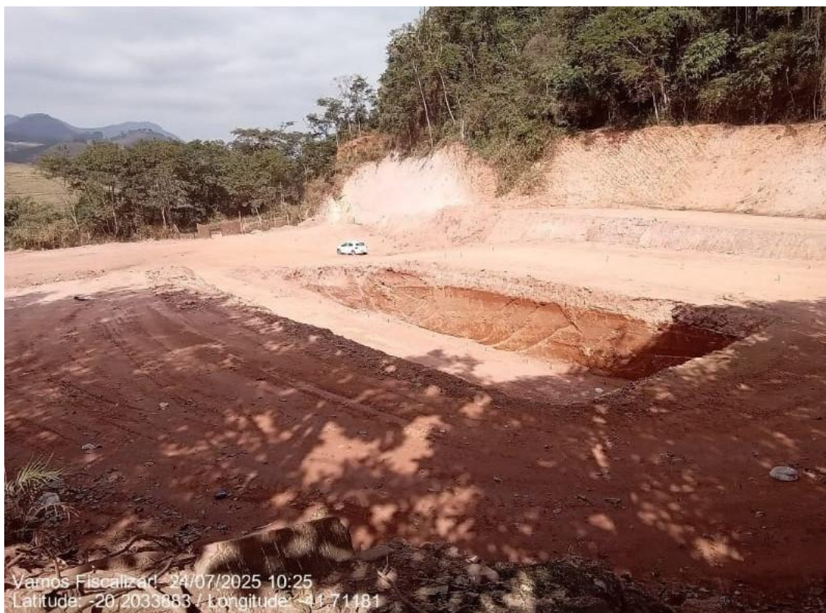
Construção de nova área para transbordo.
