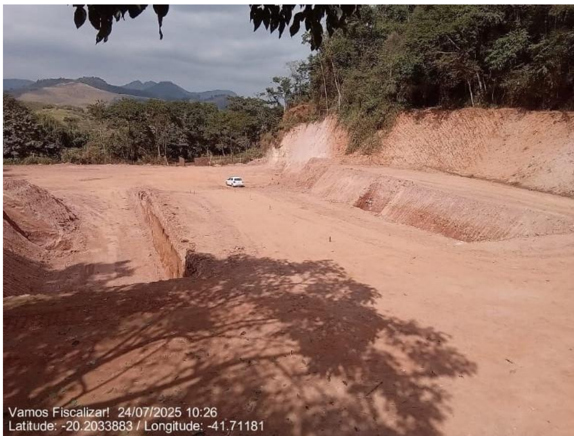
Construção de nova área para transbordo.
