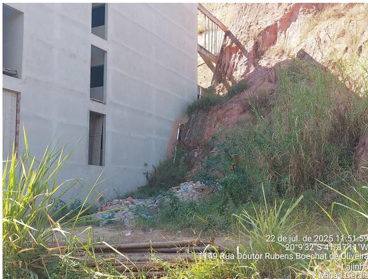
Ponto viciado de acúmulo de resíduos domiciliares.
