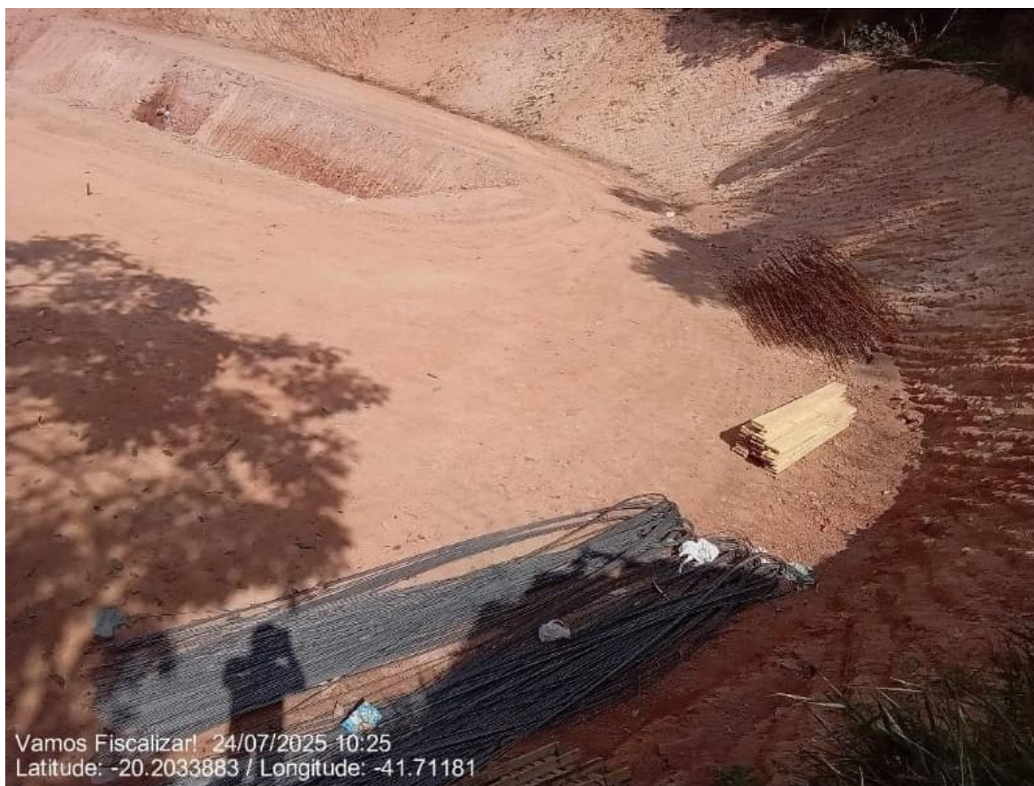
Construção de nova área para transbordo.
