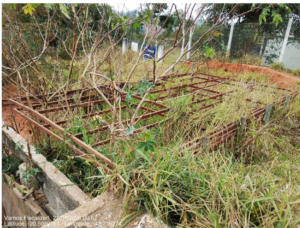
Antiga estrutura da cobertura.
