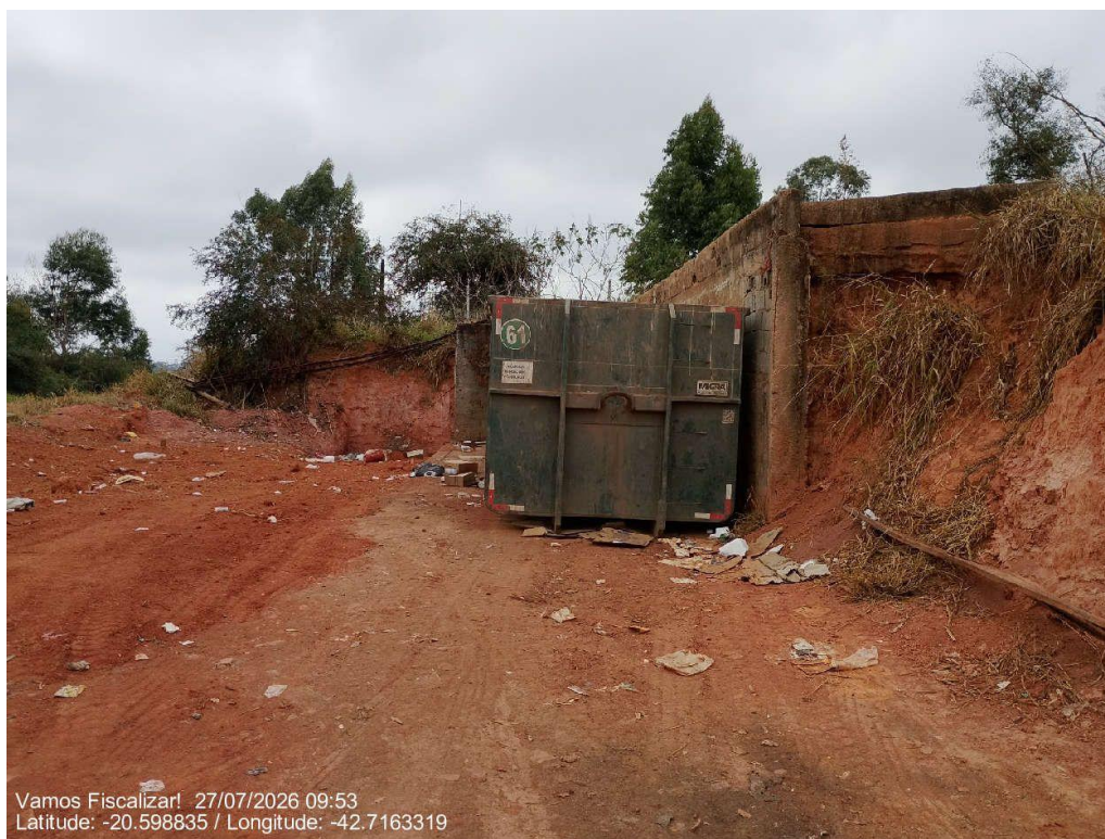
Ausência de equipamentos de segurança.
