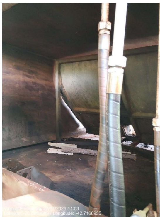
Limpeza do compactador.
