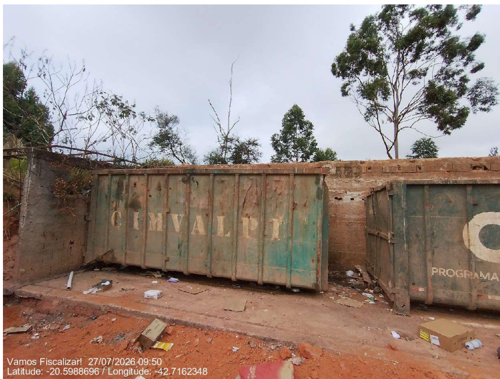
Ausência de cobertura na área de transbordo.
