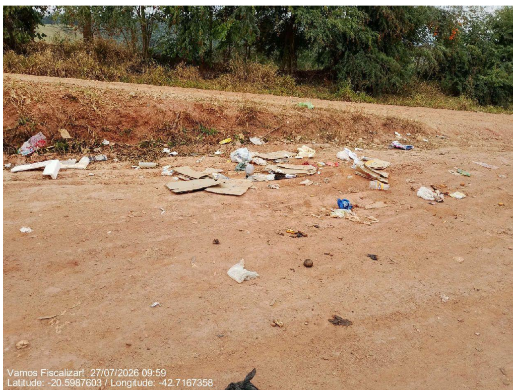
Resíduos na área de acesso aos contêineres
