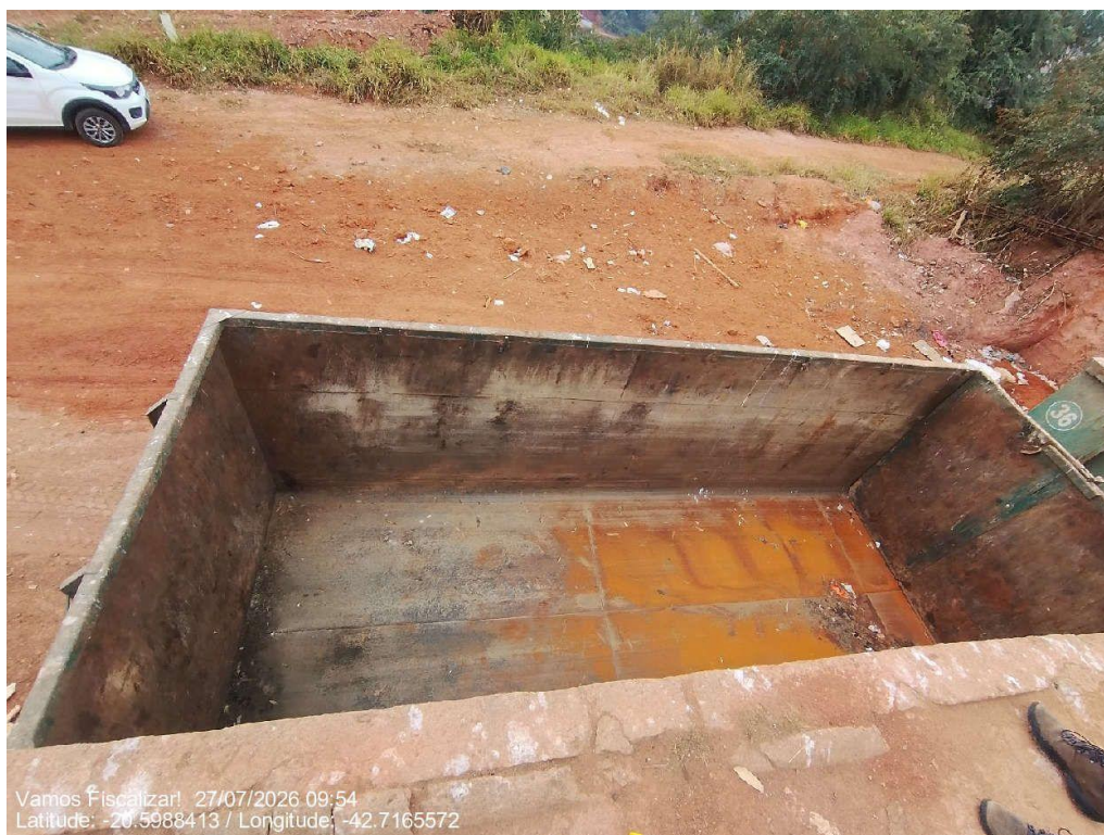
Ausência de cobertura.
