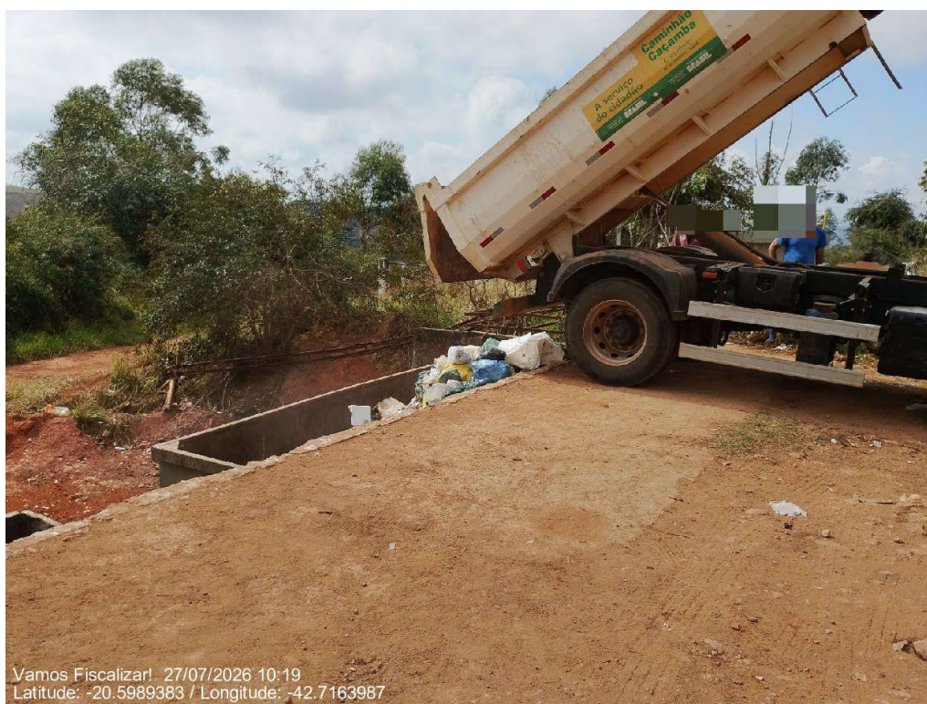
Destinação dos resíduos no container.
