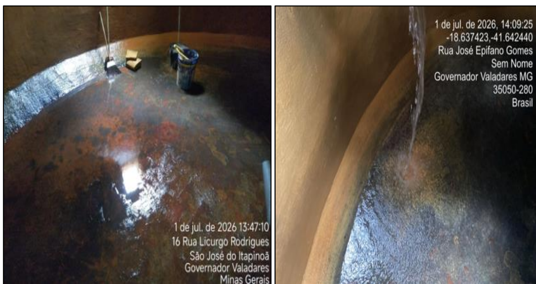
Figura 2. Limpeza do reservatório Distrito de Itapinoã.
