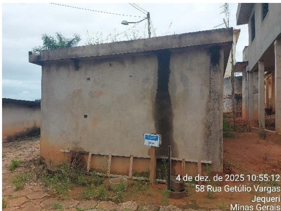
Figura 20 – Placa de Identificação da ETA próximo ao Reservatório
