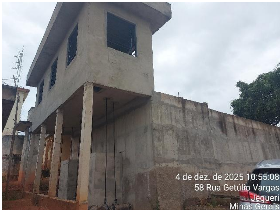
Figura 21 – Estrutura da Nova ETA (não está em operação)
