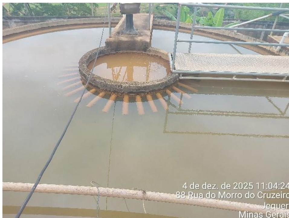
Figura 27 – Decantador
