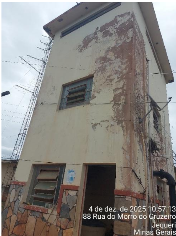
Figura 22 – Vista geral da área de tratamento da ETA
