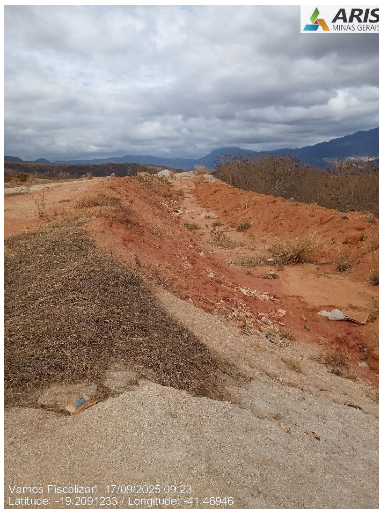
imagem da ausência de drenagem superficial
