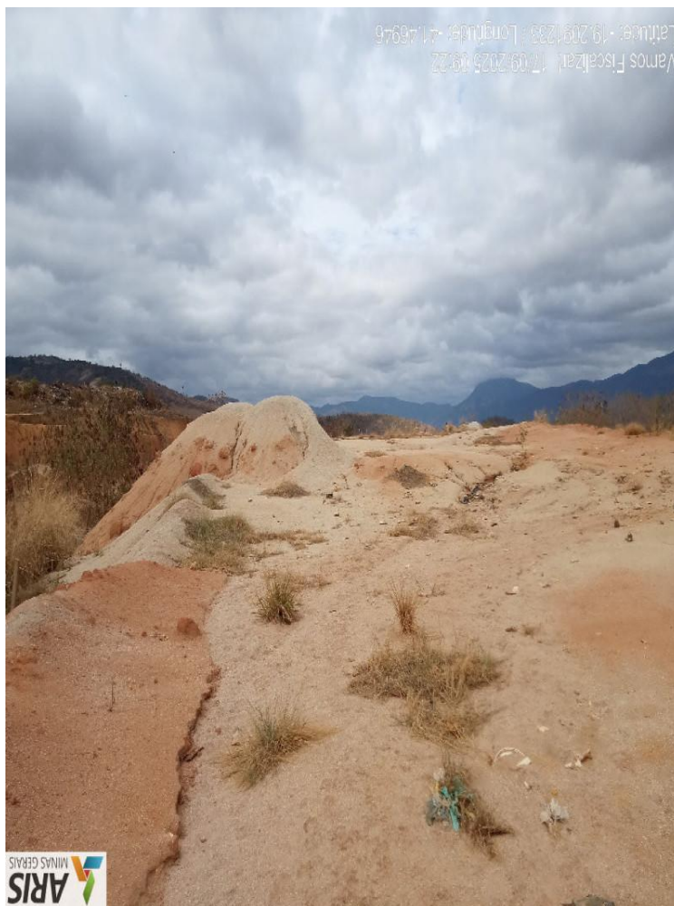
imagem da ausência de drenagem superficial
