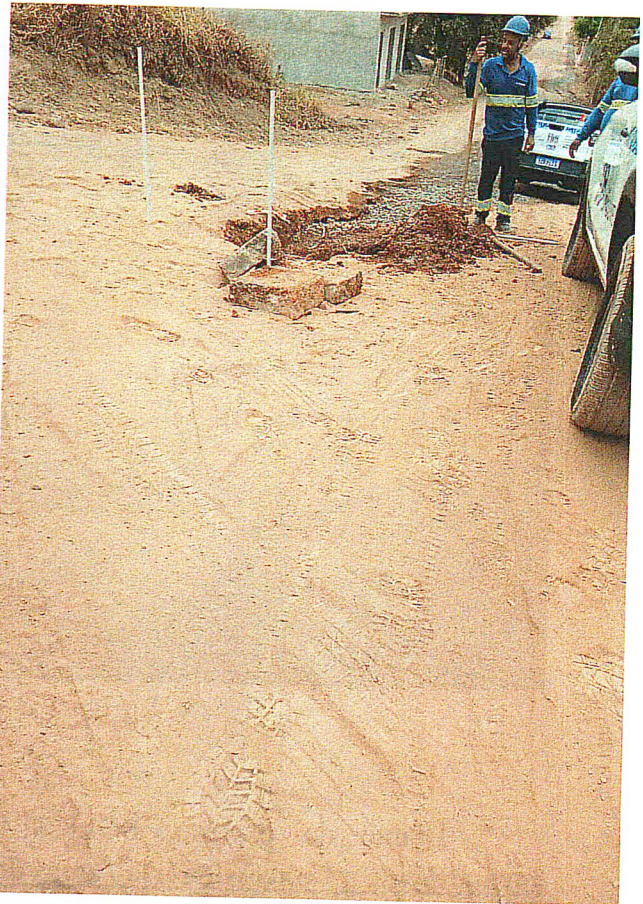
Figura 7 – Reparo na rede de distribuição
