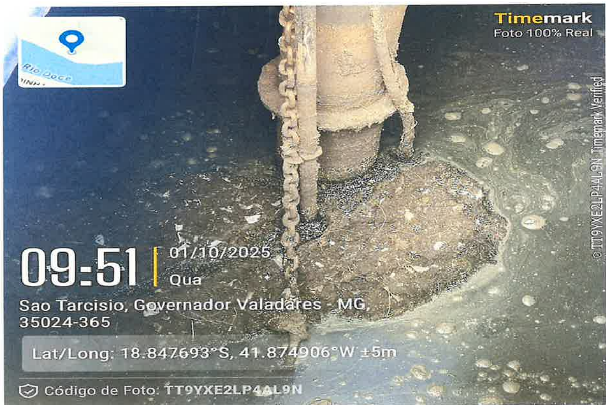
Foto 06: Detalhe da operação manual de remoção dos sólidos grosseiros, ação essa que deveria estar sendo feita mecanicamente pelo equipamento de TP.
