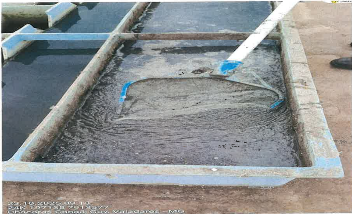
Foto 06: Detalhe da operação manual de remoção dos sólidos grosseiros, ação essa que deveria estar sendo feita mecanicamente pelo equipamento de TP.
