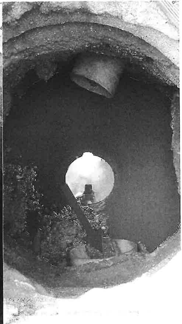
Figura 3 - Posição do extravassor
