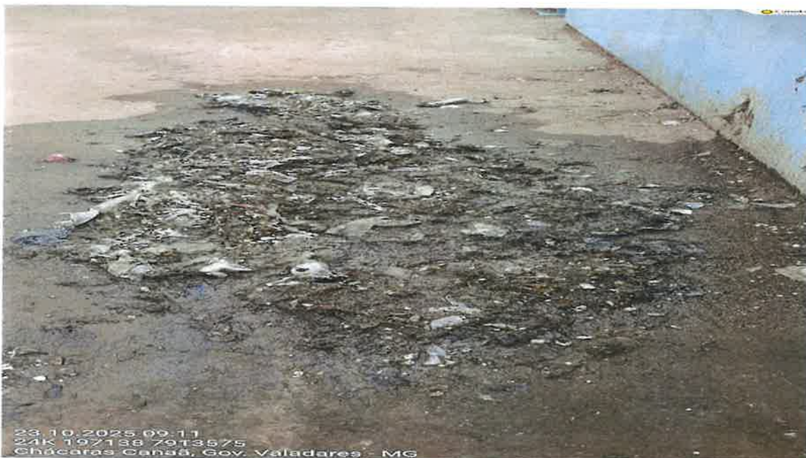
Foto 05: Detalhe dos sólidos grosseiros retirados manualmente das caixas divisoras de vazão, em razão da inoperabilidade do equipamento de tratamento preliminar.
