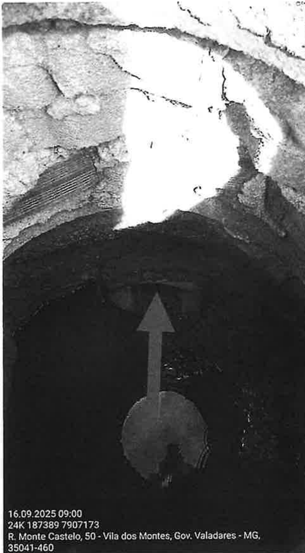
Figura 2 - Poço de visitas desobstruído
