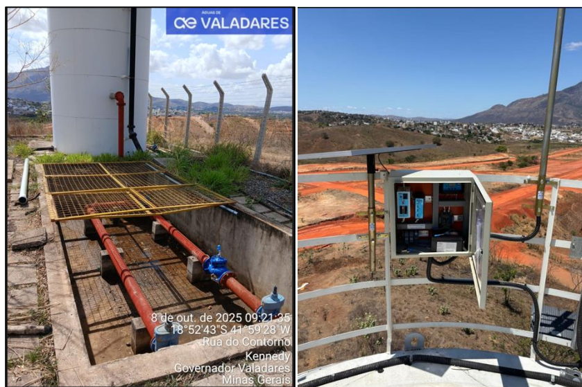
Instalação de novas válvulas de controle de nível e painel de telemetria
