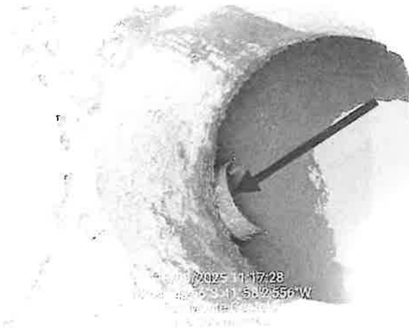
Figura 4 – Posição do extravasor
