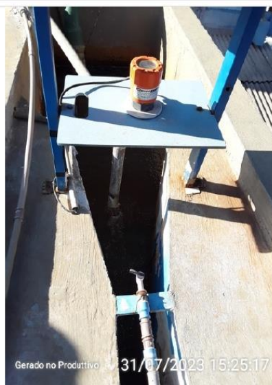
Calha parshall com medidor ultrassônico
