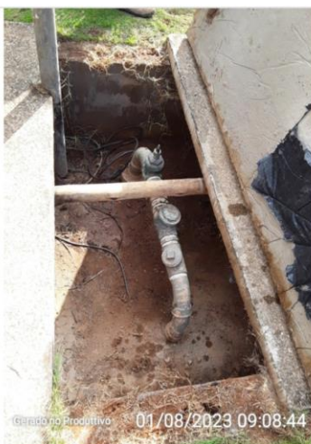
Poço Distrito de Granada 02 - Registro de válvula
