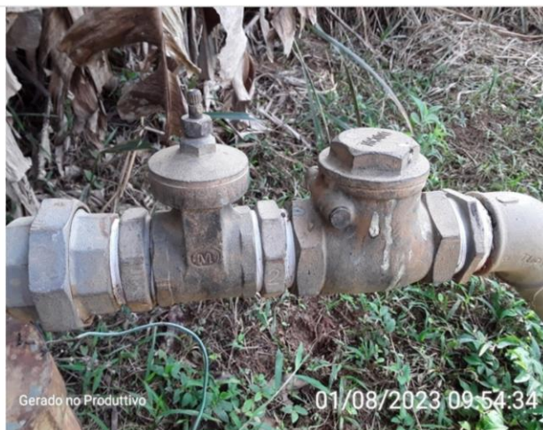
Registro e válvula do poço
