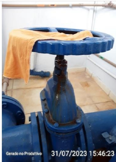
Vazamento aparente no registro
