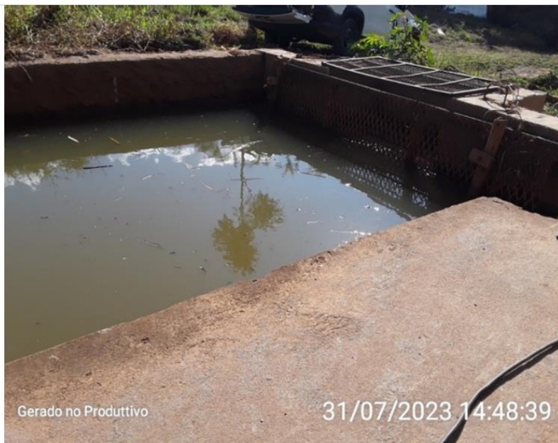
Captação superficial Rio Santana - Gradeamento
