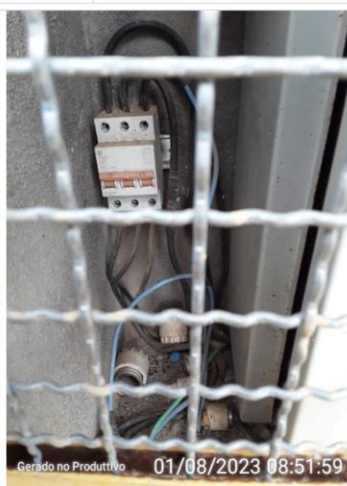
Disjuntor geral do quadro
