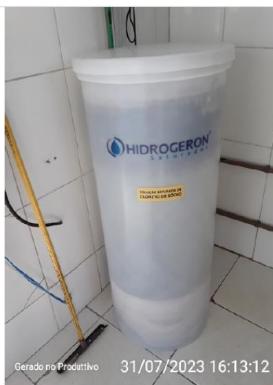
Tanque de saturação de cloreto de sódio
