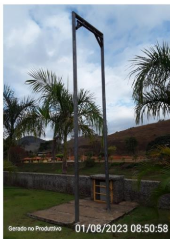
Estrutura de içamento para manutenção
