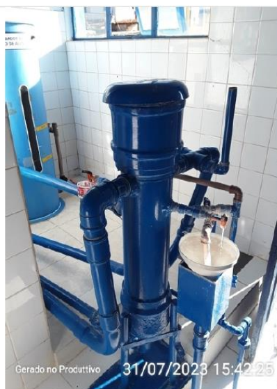
Misturador do Cal pra correção de PH e floculação
