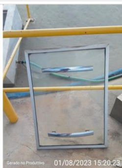
Tampa de inspeção do reservatório
