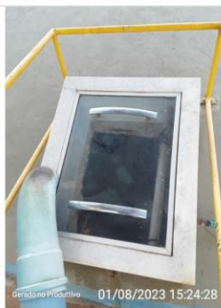
Tampa de inspeção do reservatório
