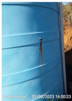
Presença de vazamento
