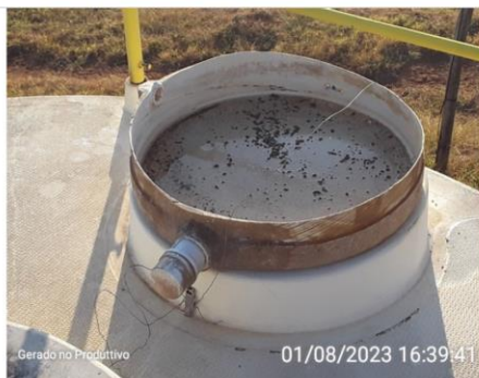
Tampa de inspeção inadequada
