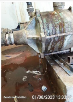
Vazamento aparente
