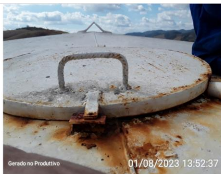
Tampa de inspeção
