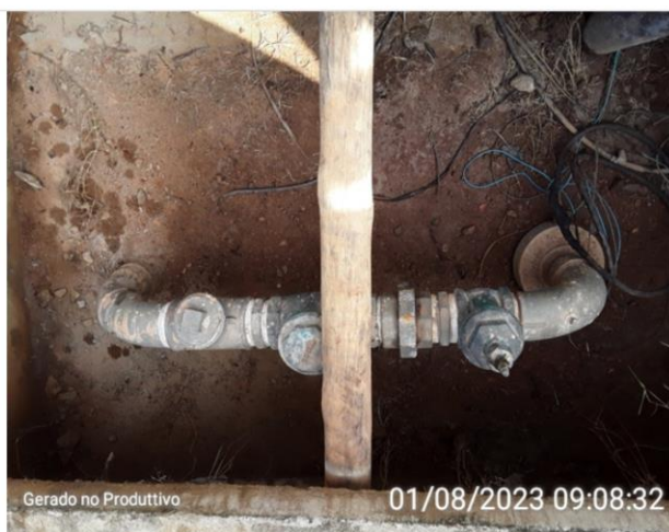
Poço Distrito de Granada 02 - Registro de válvula
