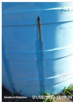
Presença de vazamento
