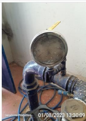
Aferidor de pressão estragado
