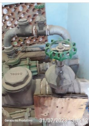
Registro com vazamento
