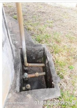
Caixa de descarga
