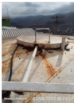
Tampa de inspeção com oxidação
