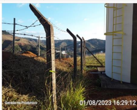
Cercamento em mourão de concreto e arame
