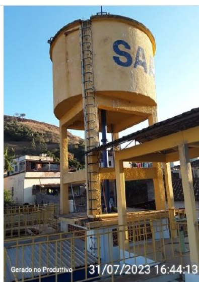
ETA - Reservatório lavagem de filtros
