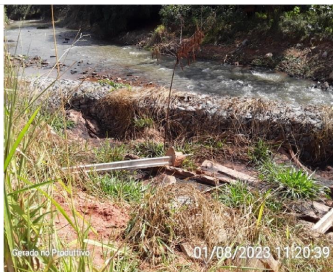
Proteção com muro de gabião
