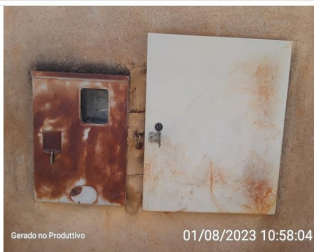
Quadro de comando e padrão de energia - externa
