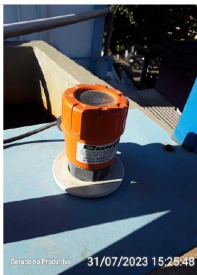
Medidor ultrassônico
