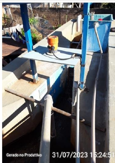
Calha parshall com medidor ultrassônico
