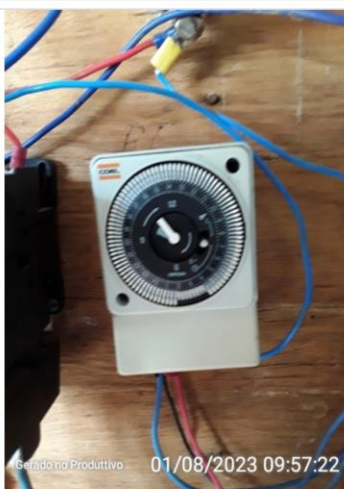
Programador de funcionamento de bomba
