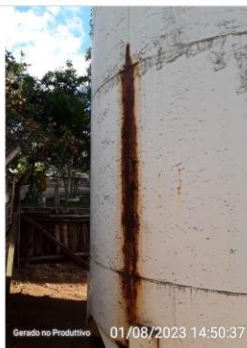
Ponto de oxidação com vazamento
