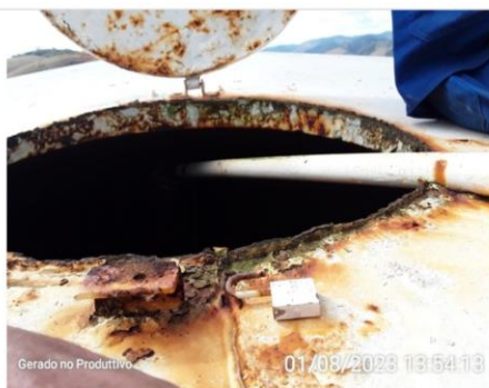
Ponto de oxidação na tampa
