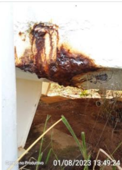
Ponto de oxidação com vazamento
