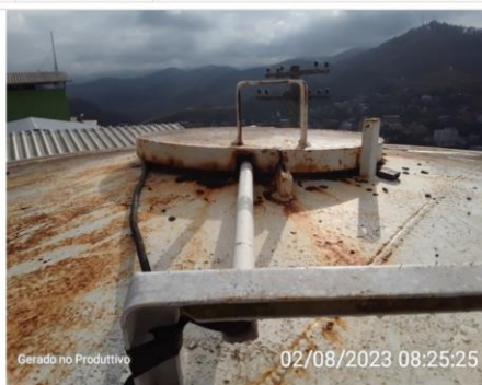
Tampa de inspeção com oxidação
