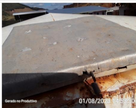
Tampa de inspeção
