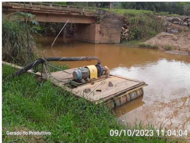
Captação superficial e em balsa
