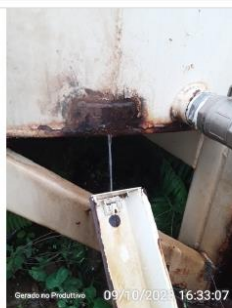
Vazamento e oxidação
