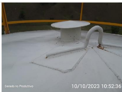
Ventilação do reservatório
