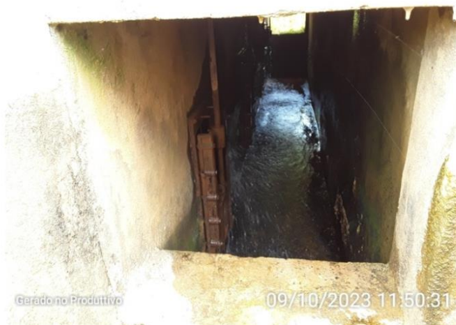
Vazamentos nas válvulas dos filtros
