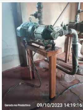
Vazamentos aparentes
