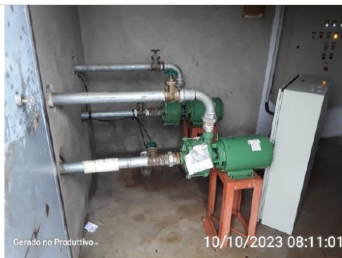
Bombas da elevatória
