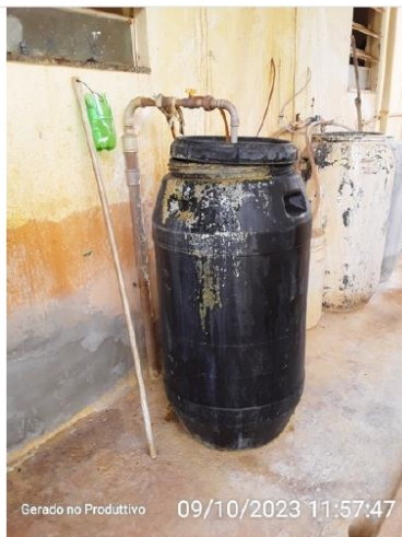
Tanque de armazenamento do coagulante
