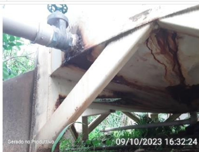
Vazamento e oxidação
