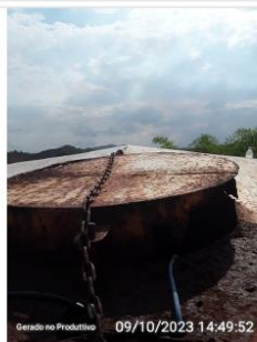
Tampa de inspeção
