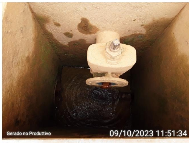
Vazamento na descarga do decantador
