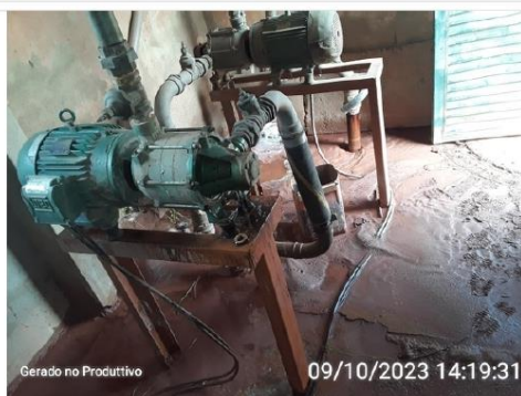
Vazamentos aparentes
