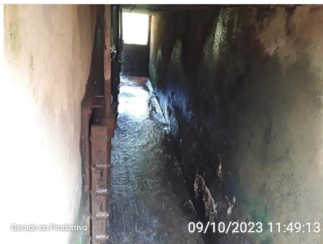
Vazamentos nas descargas dos filtros
