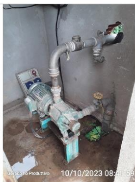
Bomba da elevatória
