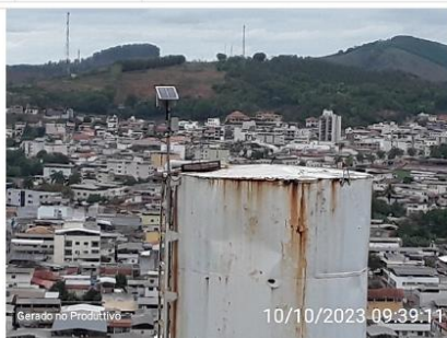
Tampa de inspeção oxidada
