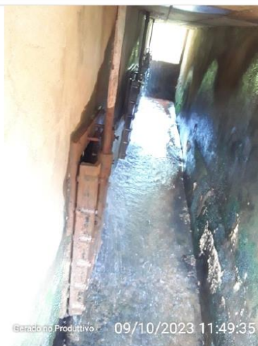
Vazamentos nas descargas dos filtros
