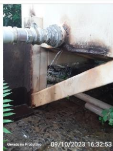
Vazamento e oxidação
