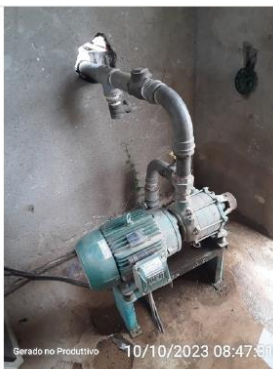
Bomba da elevatória
