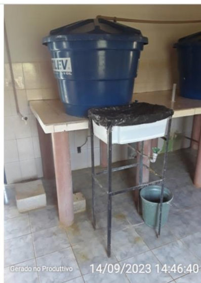
Reservatório de sulfato preparado
