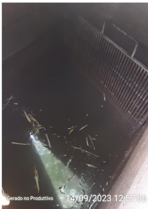
Gradeamento no interior da caixa de passagem
