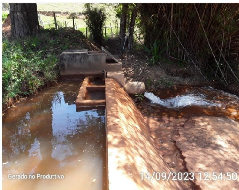
Captação na barragem de nível
