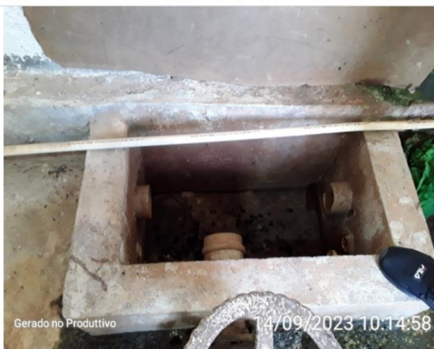
Descarga de fundo do reservatório
