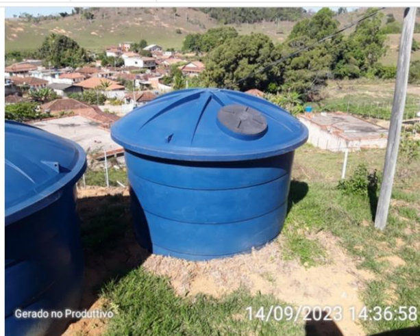
Ausência de ventilação
