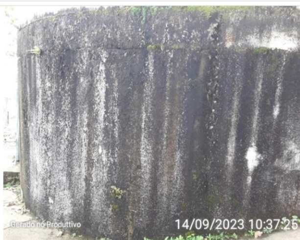
Marcas de vazamentos
