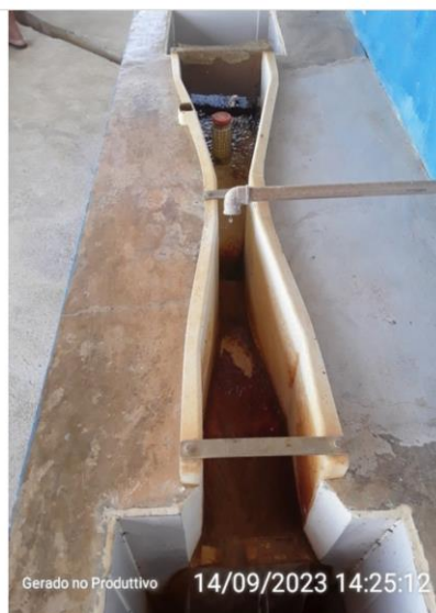
Calha parshall om régua graduada
