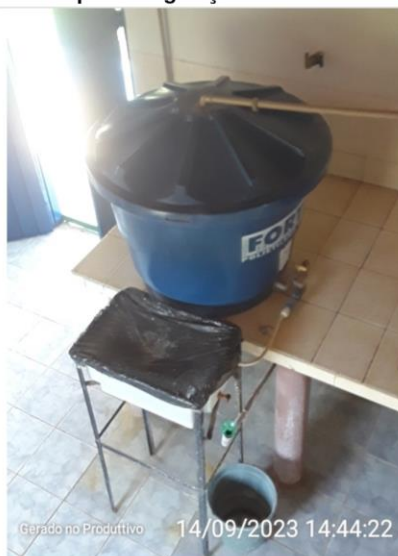
Reservatório de sulfato preparado
