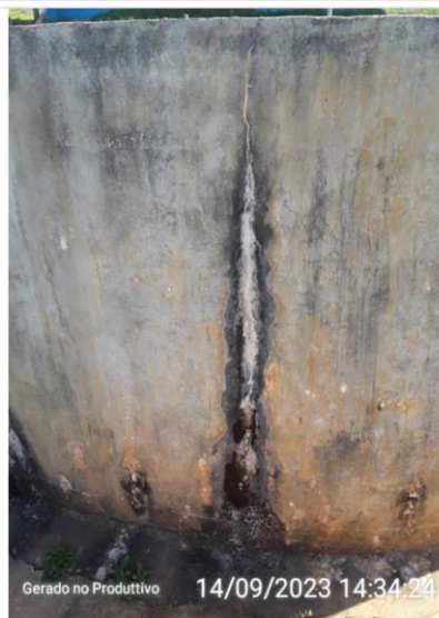
Vazamento aparente
