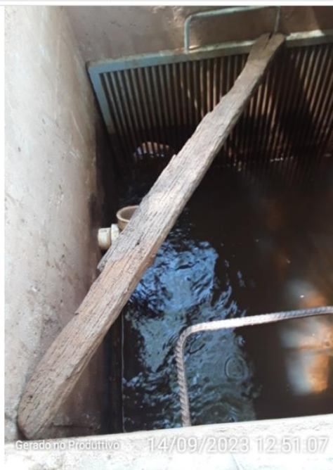
Gradeamento na caixa de passagem da captação
