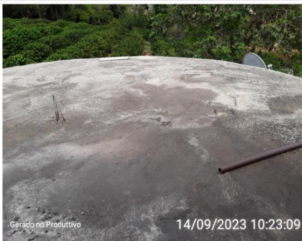
Cobertura sem guarda corpo - Reservatório II
