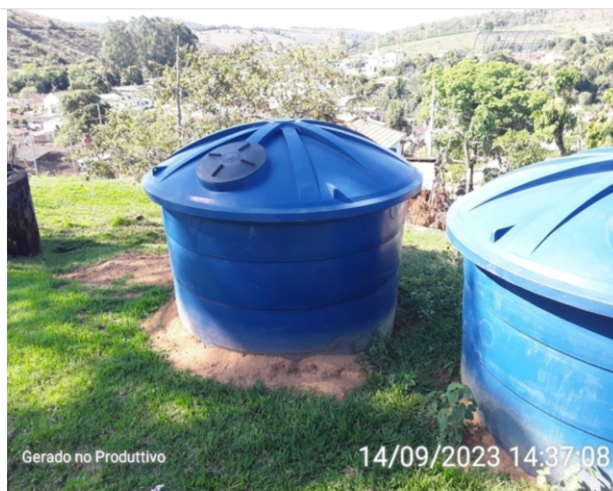
Ausência de ventilação
