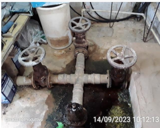
Válvulas que interligam os reservatórios
