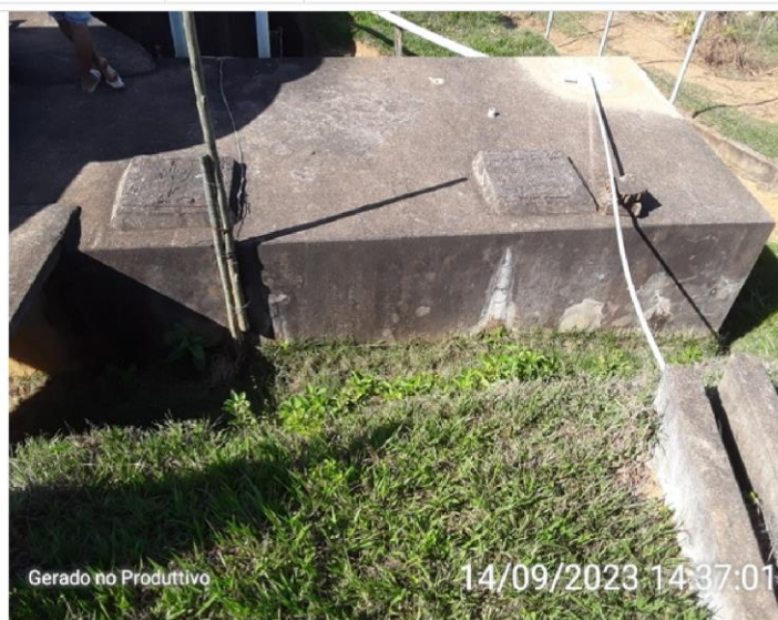
Tanque de contato
