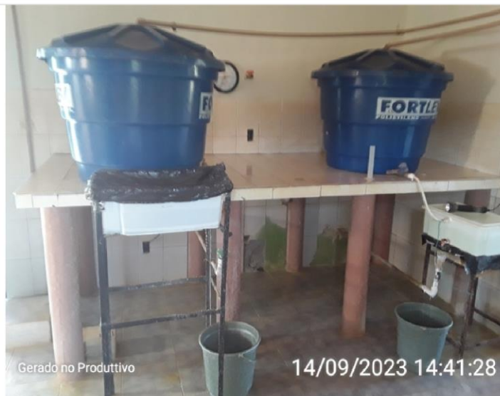
Reservatório de sulfato e cloro
