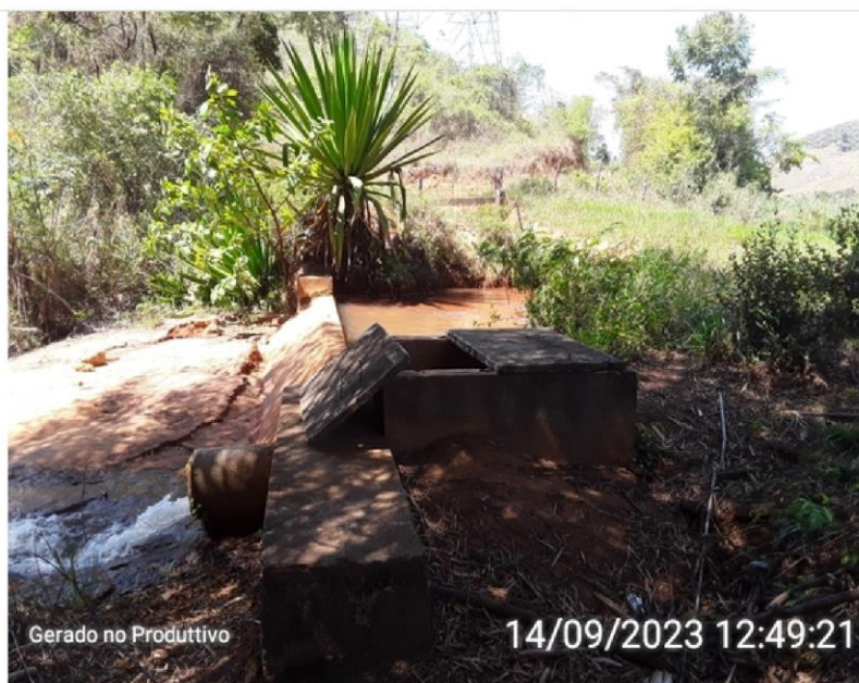
Barragem de nível para captação
