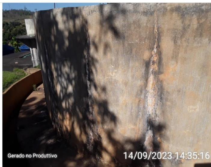
Vazamento aparente
