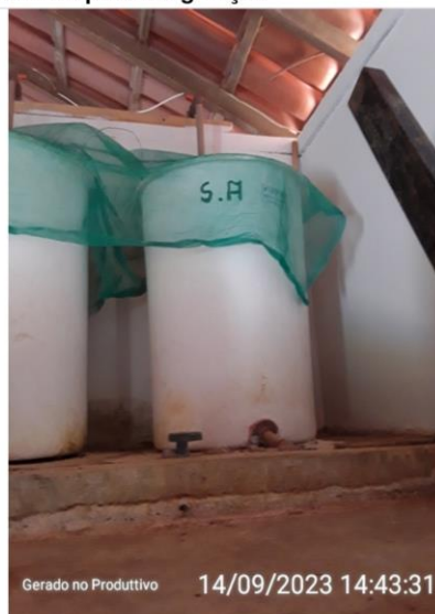
Tanque de preparo de sulfato
