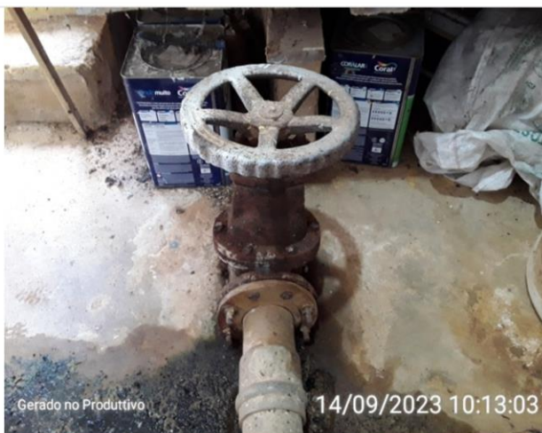
Válvula de entrada - Reservatório III
