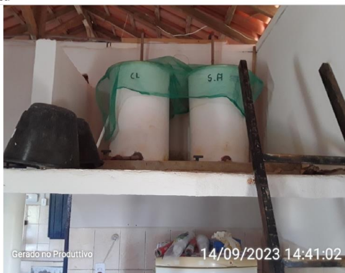
Tanque de preparo de sulfato e cloro
