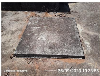
Caixa de descarga
