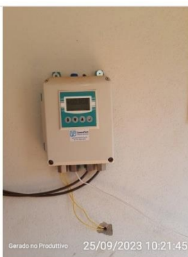
Medidor de vazão
