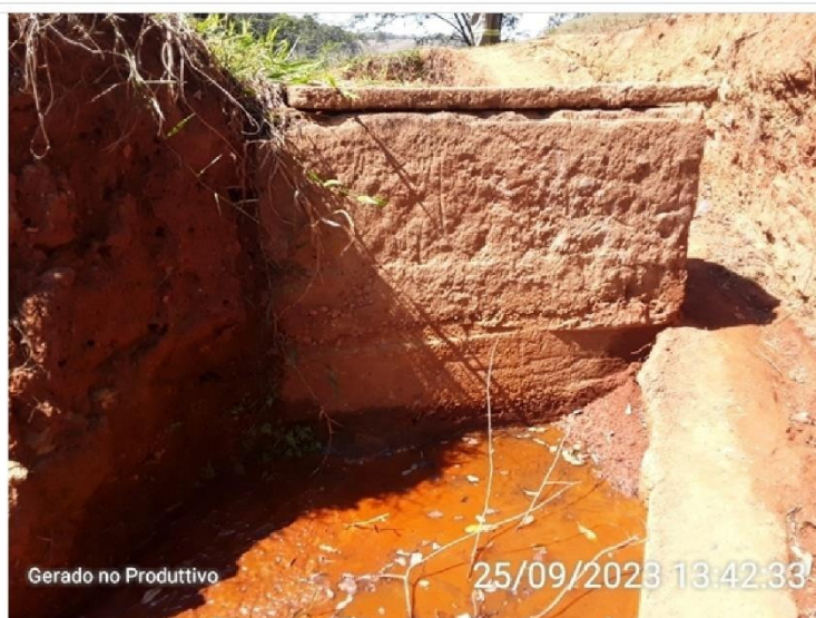
Caixa do desarenador
