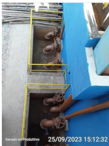
Válvulas de descarga dos decantadores
