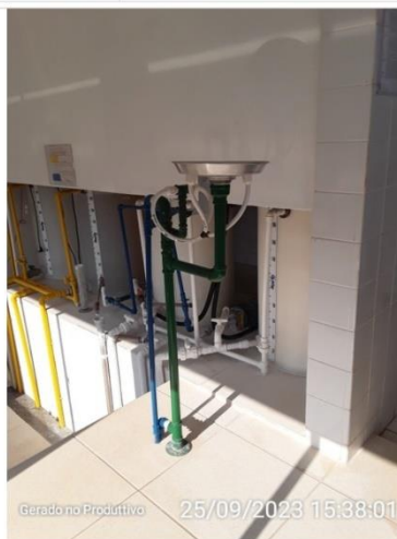
Lava olhos próximo ao tanque de dosagem do cal
