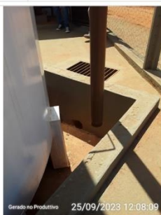
Caixa de descarga
