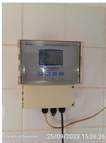
Medidor de vazão ultrassônico
