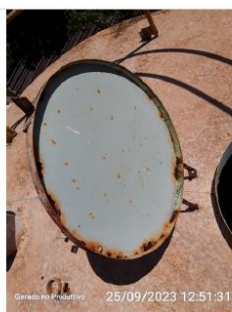
Tampa com corrosão
