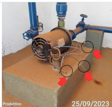
Fios elétricos sem isolamento
