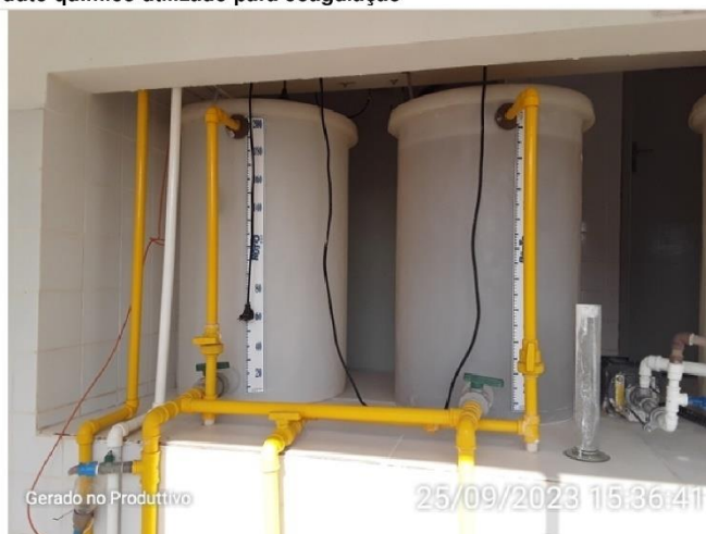
Tanques de dosagem
