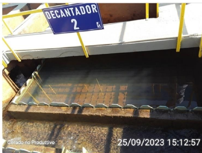
Passagem da água decantada para os filtros
