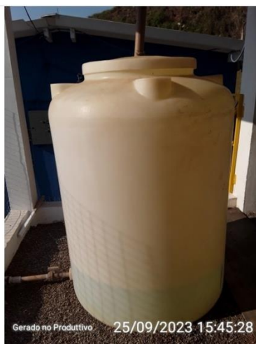
Tanque de diluição - Flúor
