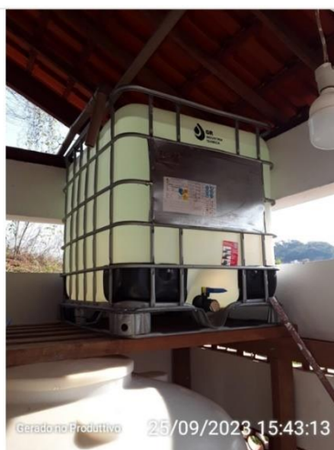
Tanque de armazenagem - Flúor
