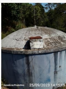
Tampa de inspeção
