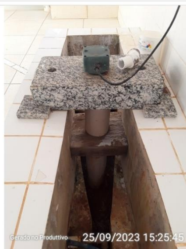
Sensor do medidor ultrassônico
