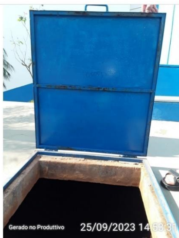
Tampa de inspeção - Tanque de contato I
