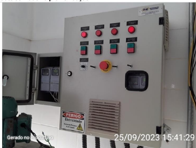
Quadro de comando e dosadoras automáticas
