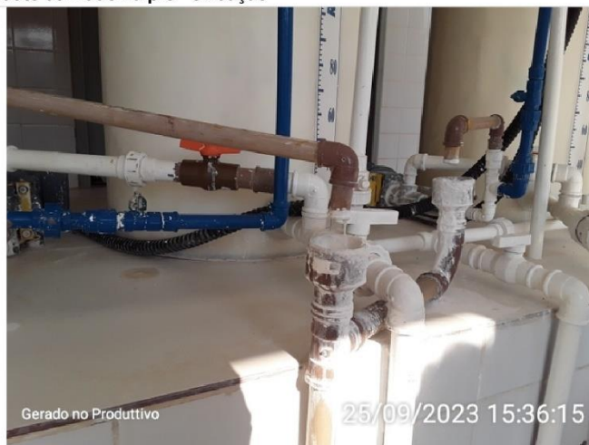
Dosagem do Cal hidratada
