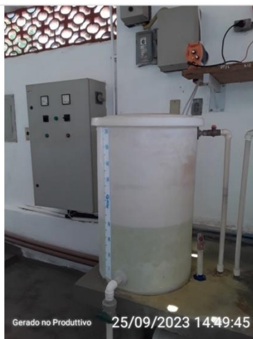
Tanque de dosagem - Cloro
