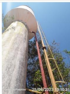
Tubo de descarga de fundo
