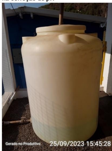
Tanque de diluição - Flúor
