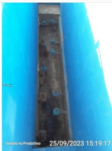
Válvulas de descarga dos floculadores
