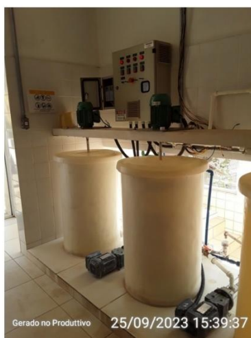
Tanques de diluição - Cal hidratada
