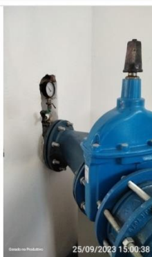
Local de instalação do manômetro
