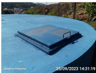
Tampa de inspeção
