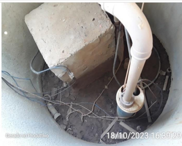
Ausência de laje sanitária
