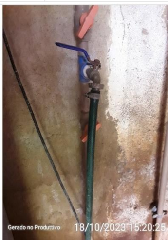
Ponto de coleta locado após cloração
