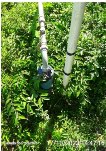
Ausência de laje sanitária
