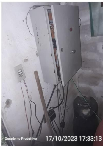
Fiação/disjuntor exposto na entrada do quadro
