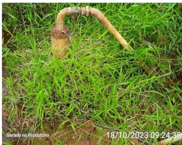
Ausência de laje sanitária
