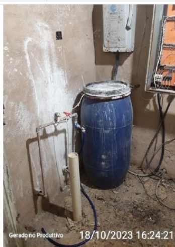
Sistema de desinfecção sem bomba dosadora
