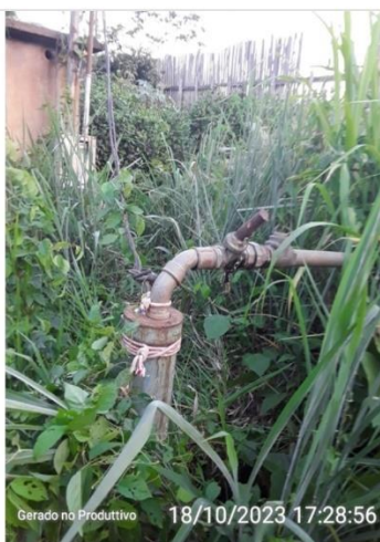
Poço de Captação subterrânea
