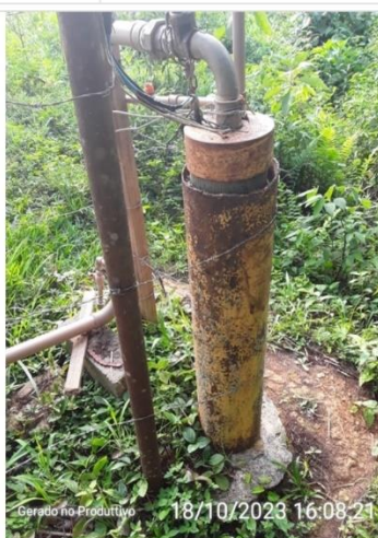
Ausência de laje sanitária
