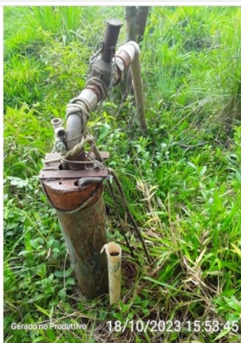
Ausência de laje sanitária
