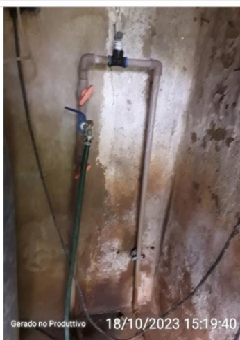
Vazamento aparente na desinfecção
