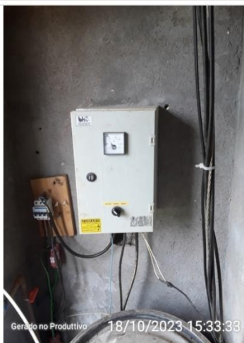
Fiação com emenda e disjuntores exposto
