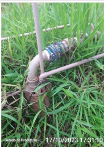
Ausência de laje sanitária
