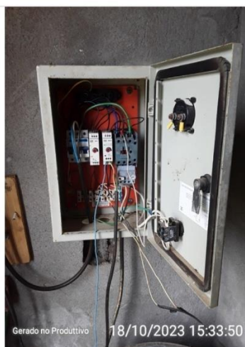
Fiação desorganizada interna ao quadro
