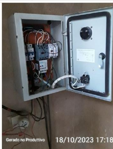
Fiação desorganizada interna ao quadro
