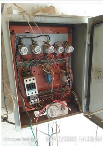
Fiação desorganizada interna ao quadro
