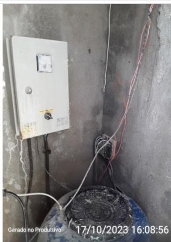
Fiação exposta junto aos quadros
