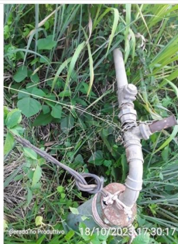
Ausência de laje sanitária
