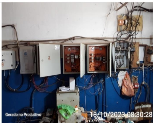
Fiação expostas - Quadros poços
