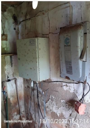
Fiação/disjuntor exposto e pontos de oxidação no quadro
