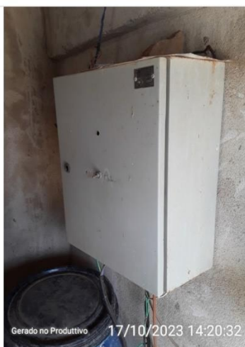
Fiação exposta na entrada do quadro
