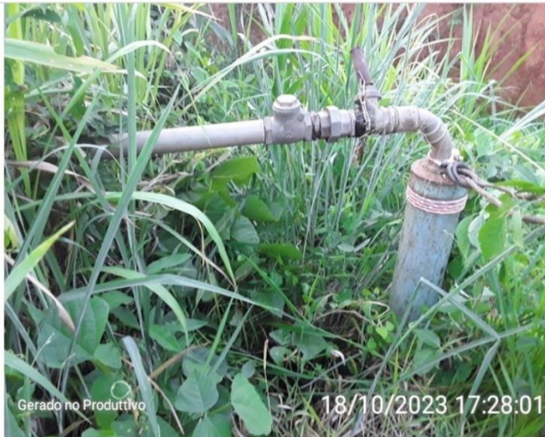
Poço de Captação subterrânea
