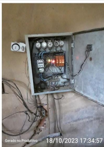
Fiação interna do quadro desorganizados
