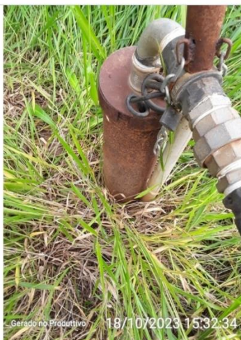
Ausência de laje sanitária
