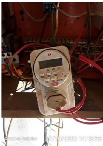
Programador de tempo de funcionamento
