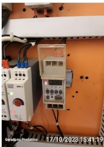
Programador de funcionamento.
