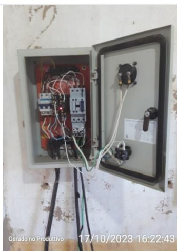
Fiação desorganizada interno ao quadro
