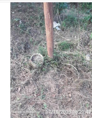
Ausência de laje sanitária
