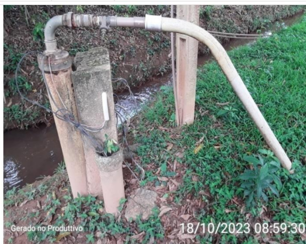
Ausência de laje sanitária
