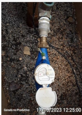
Aferidor de vazão
