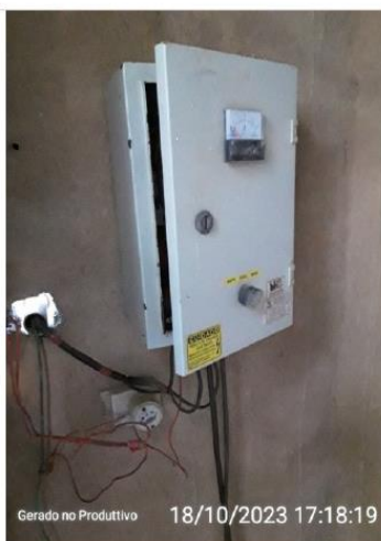
Fiação com emenda exposta
