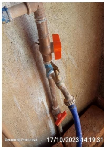
Ponto de coleta após cloração
