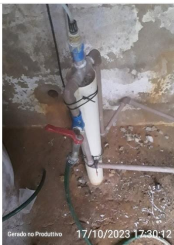
Ponto de coleta após filtração
