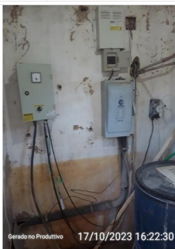
Fiação exposta na entrada dos quadros
