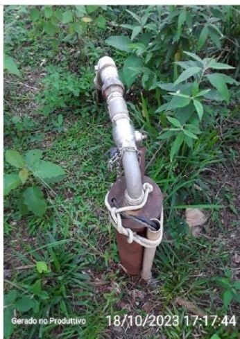
Ausência de laje sanitária
