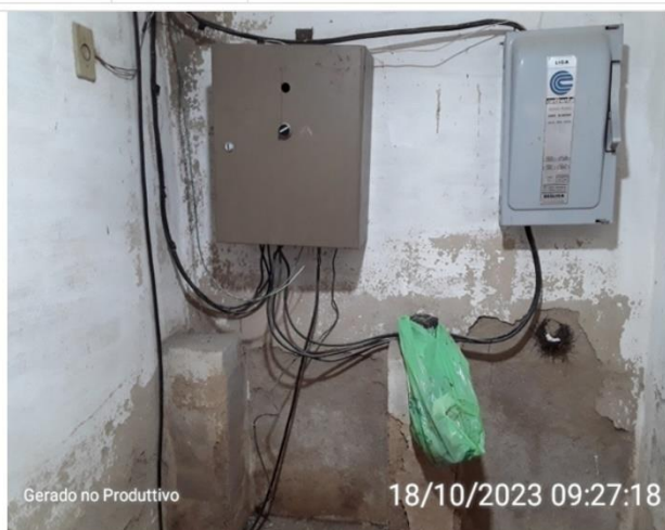
Fiação exposta na entrada dos quadros
