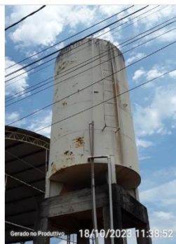
Pontos de oxidação no reservatório
