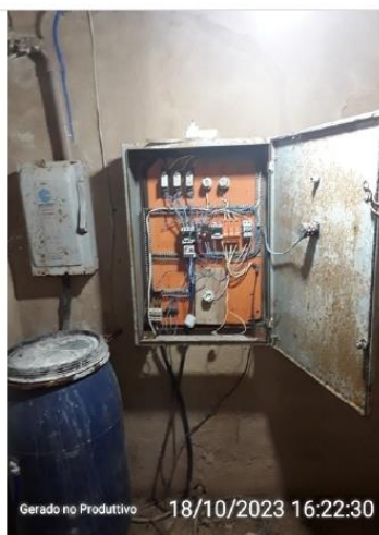
Fiação exposta e bagunçada
