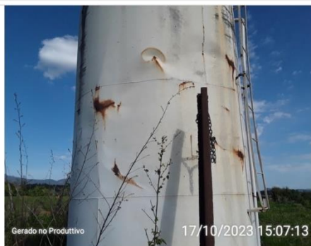
Estrutura amassada e oxidada
