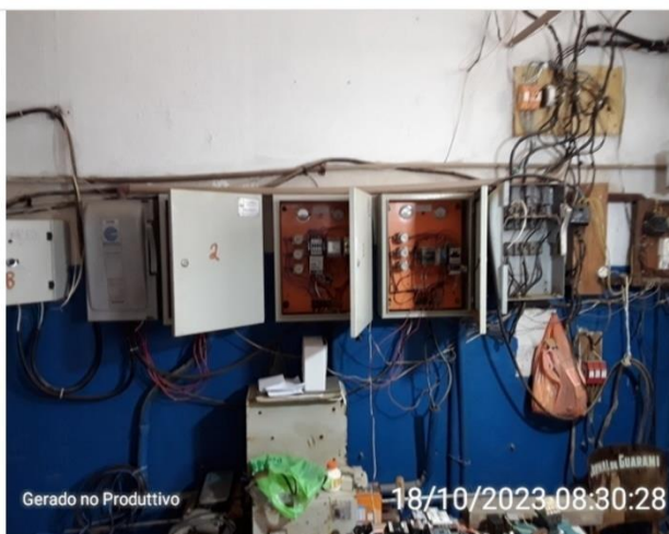
Quadros dos poços - fiação exposta
