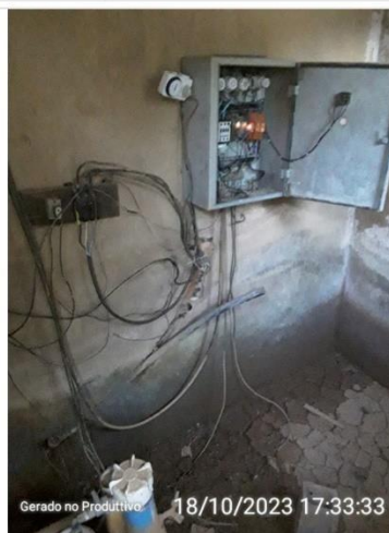
Fiação exposta na entrada dos quadros
