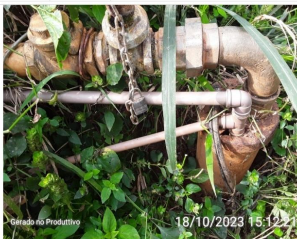
Ausência de laje sanitária
