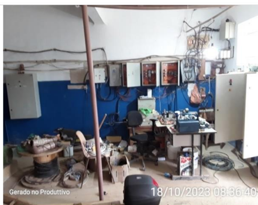
Quadros de comando dos poços e bombas
