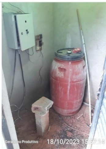
Reservatório de cloro para desinfecção
