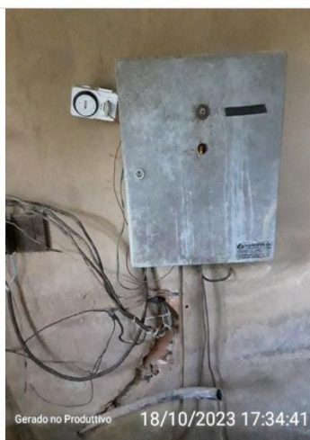
Fiação exposta na entrada dos quadros
